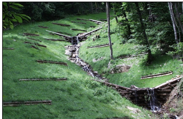
Figura 21-6 - Aplicação integrada de paliçadas ao projeto paisagístico de recomposição ambiental (VERTICAL GREEN, 2022)
