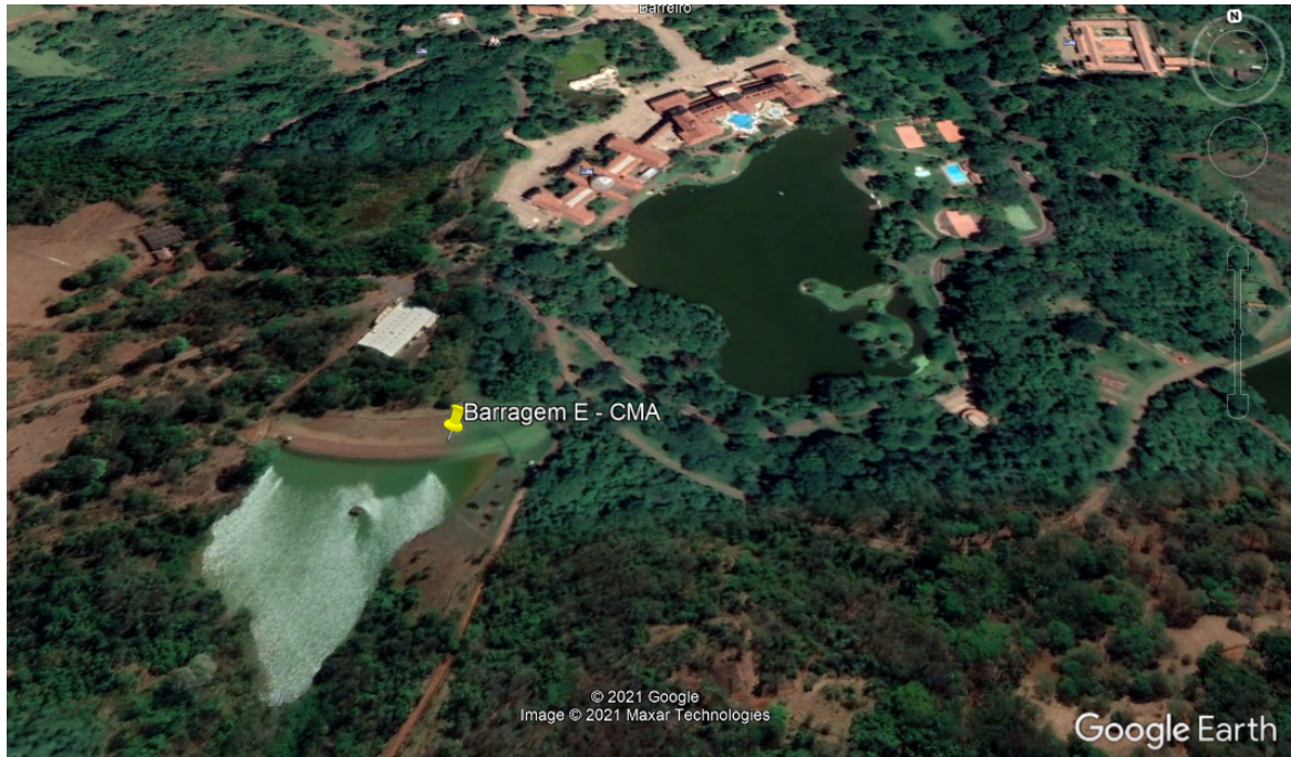
Figura 1 - Vista geral aérea da Barragem E
