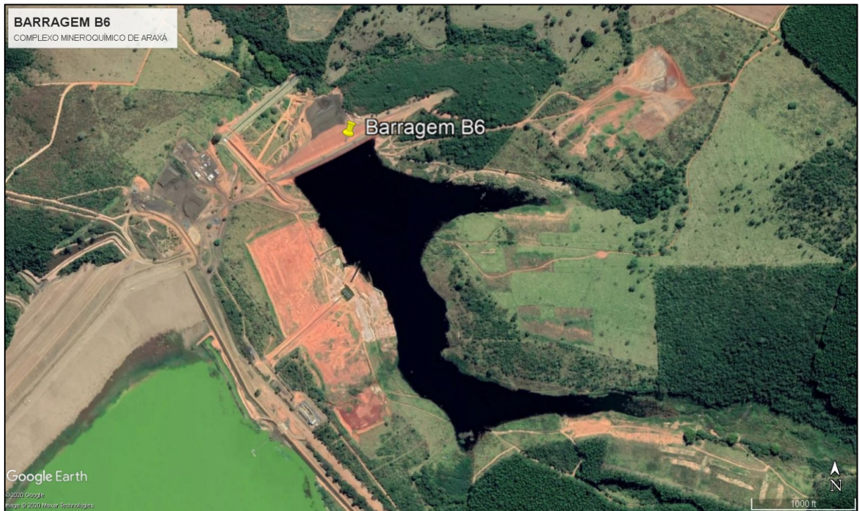
Figura 1 - Vista geral aérea da Barragem B6
