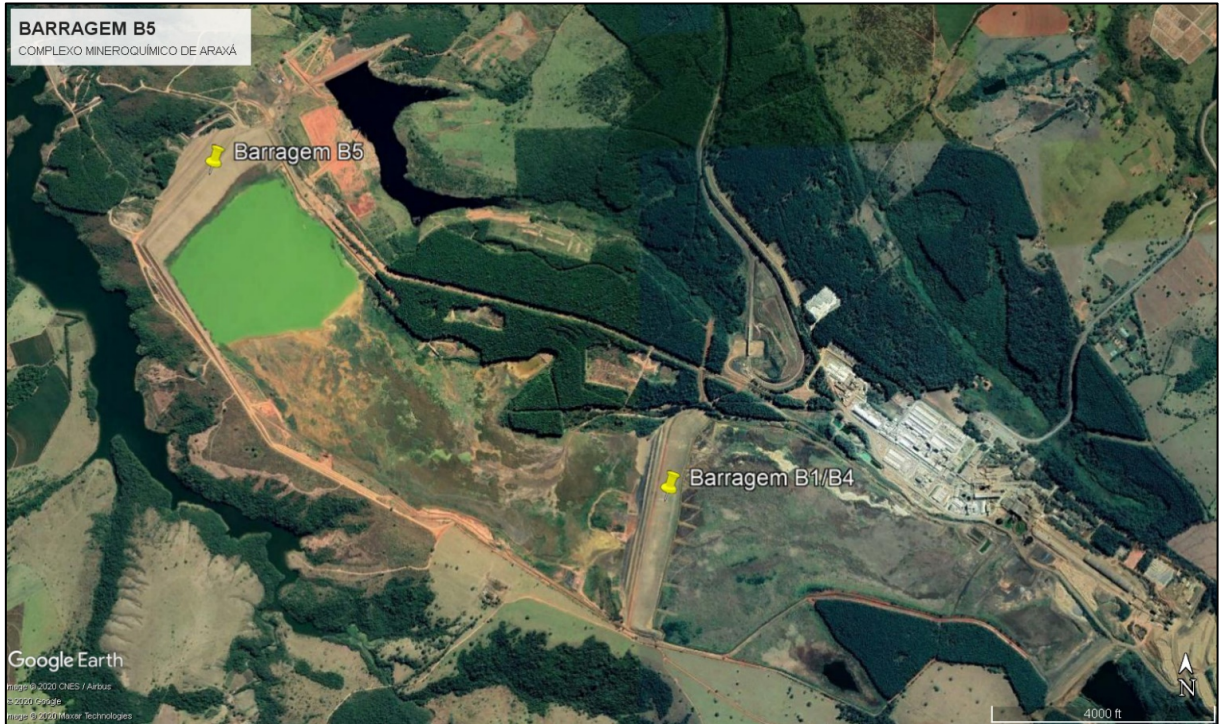
Figura 1 - Vista geral aérea da Barragem B5
