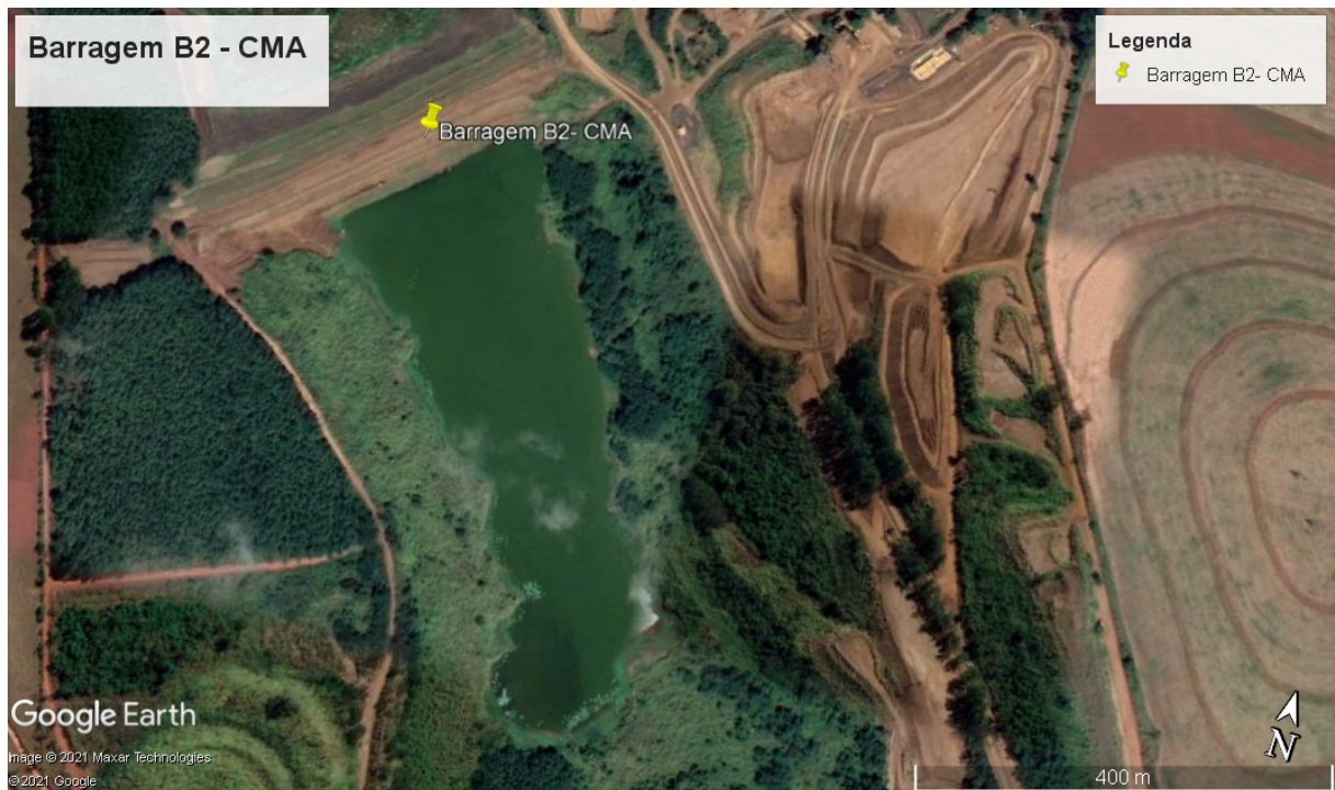
Figura 1 – Vista geral aérea da Barragem B2 localizada a montante da Barragem B1B4
