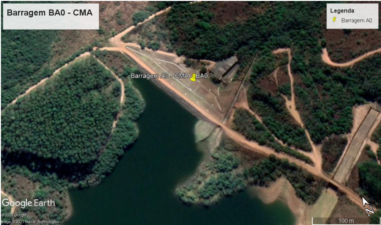
Figura 1 – Vista geral aérea da Barragem A0 (Google Earth, 2020).
