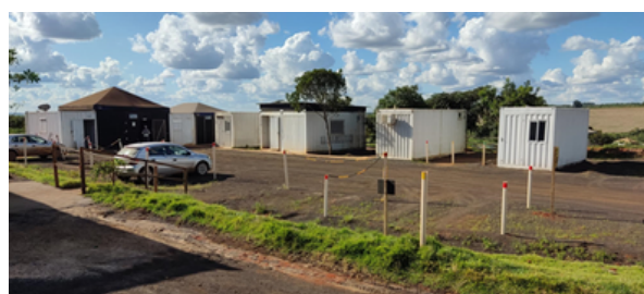
Figura 11. Containers voltados para o setor administrativo e fiscalização do canteiro comum ao barramento B6 e B5
