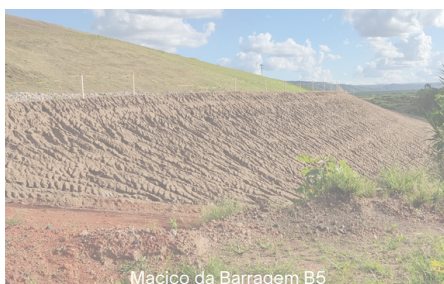
Maciço da Barragem B5
