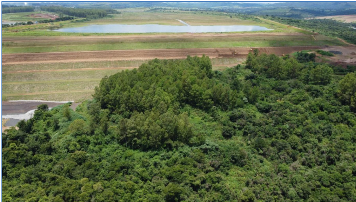
Foto 3.1 – Aspecto geral da área de intervenção na barragem B5.
