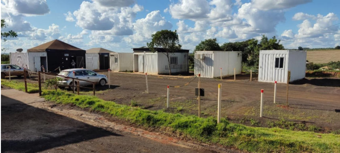
Figura 8-3: Infraestrutura operacional da barragem B5
