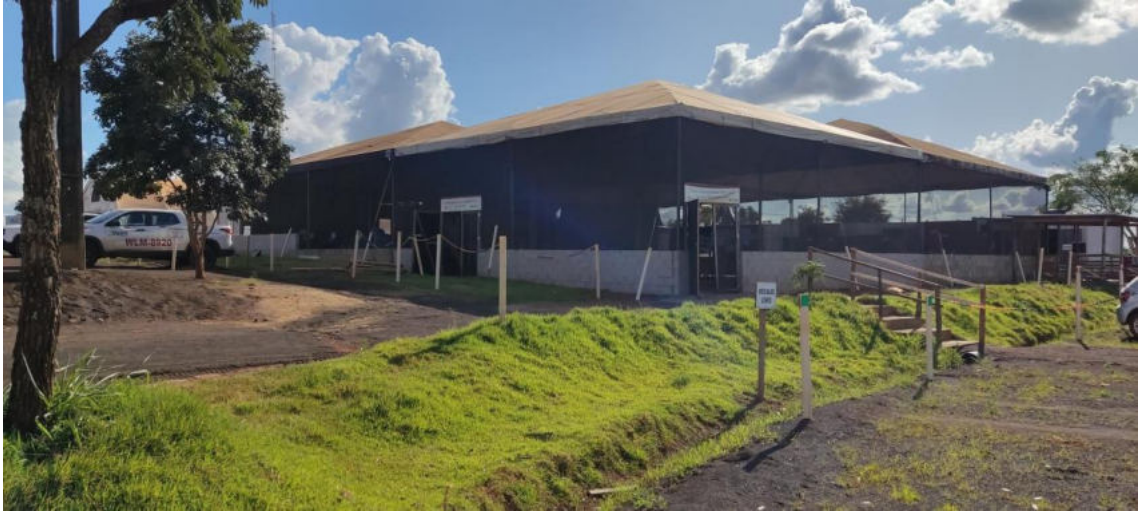
Figura 4-10: Tenda de 8m x 8m prevista do canteiro comum à barragem B6 e B5
