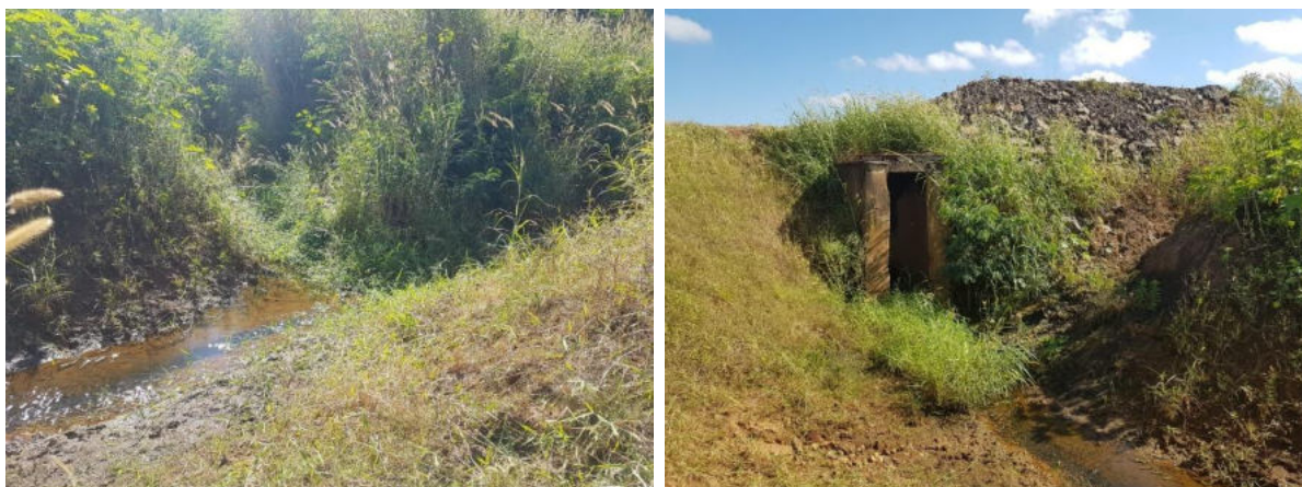
Foto 4.1: Canais superficiais em B1B4 (esquerda) e vertedouro (direita)
