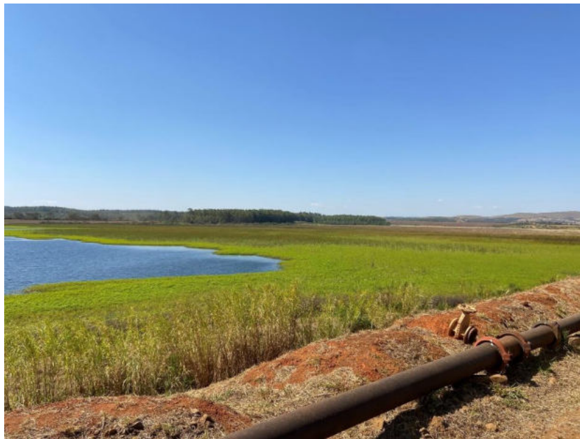
Figura 8-1: Reservatório da barragem B5
