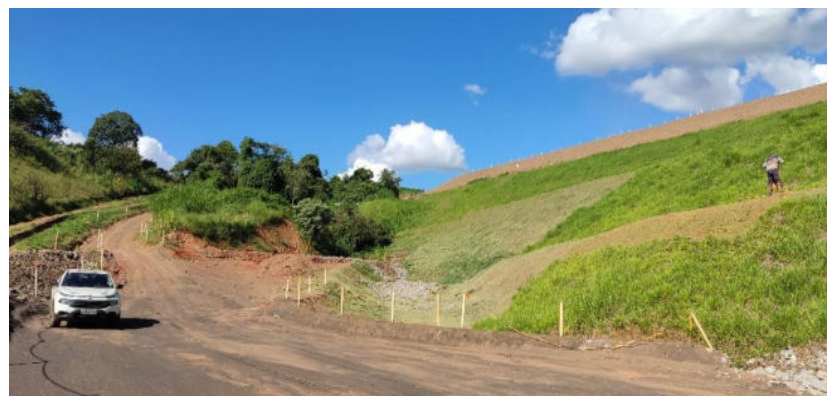
Figura 8-2 : Maciço da barragem B5
