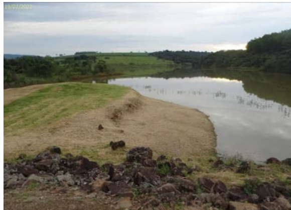
Figura 6-58: Ponto H02 – A02. Área de barragem
