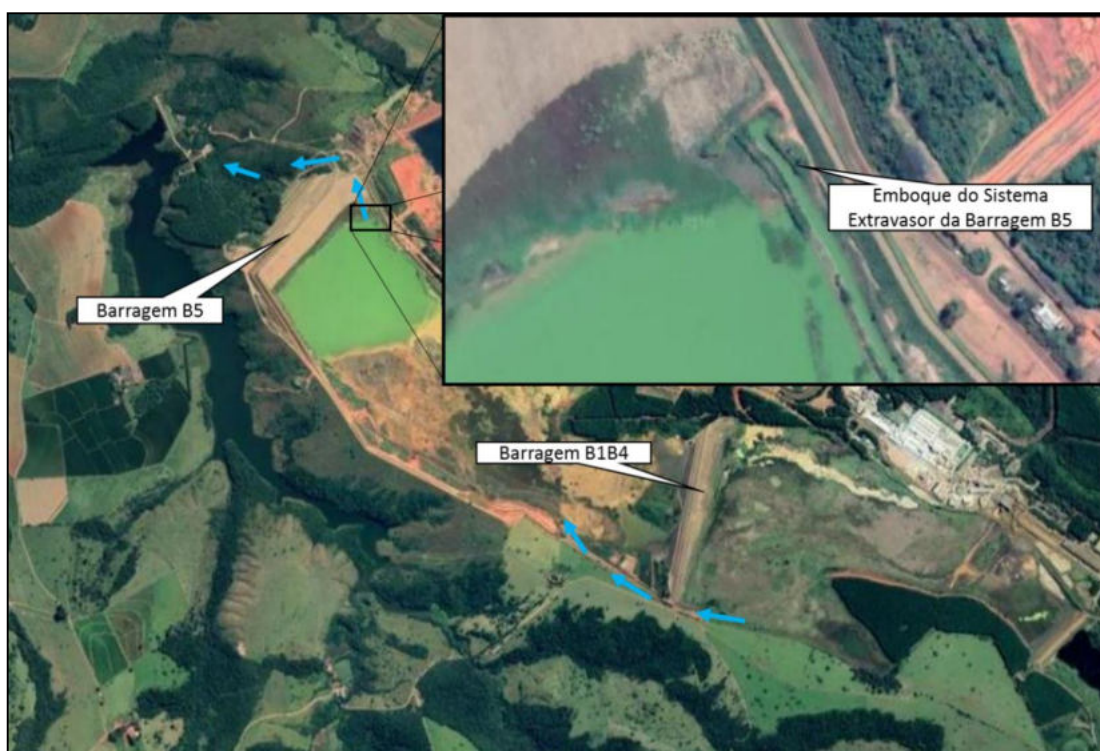
Figura 8-29 - Localização do extravasor da Barragem B5.
