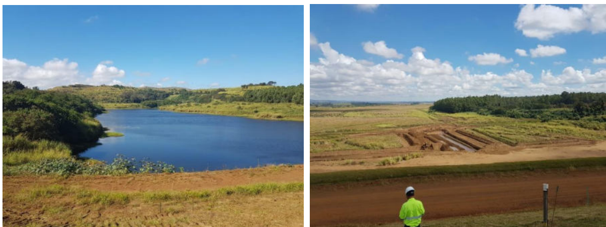
Foto 3.1: Foto do lago da barragem B2 (esquerda) e jusante da barragem B1B4 (direita).
