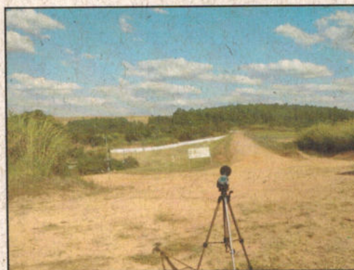
Ponto 17 – Barragem A0
