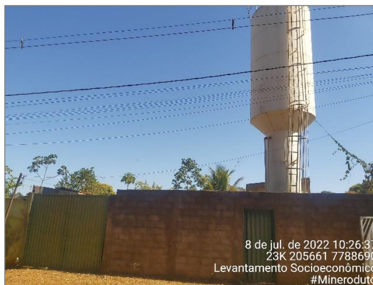
Foto 6.118 – Poço artesiano em Delta.
