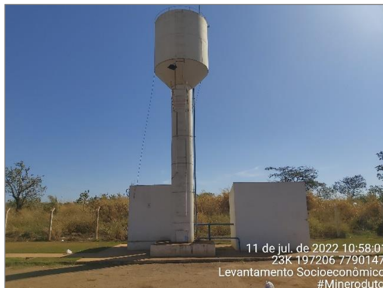
Foto 6.113 – Poço artesiano no Distrito Industrial III.
