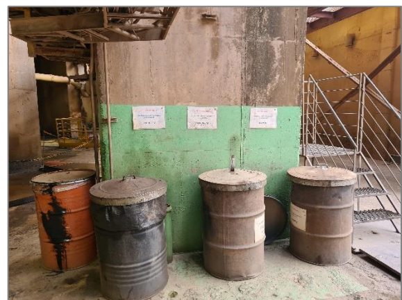
Foto 6.28 – Outras bombonas de armazenamento.
