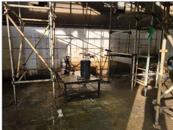
Foto 6.29 – Área de lavagem de peças, com canaletas de coleta de efluentes.
