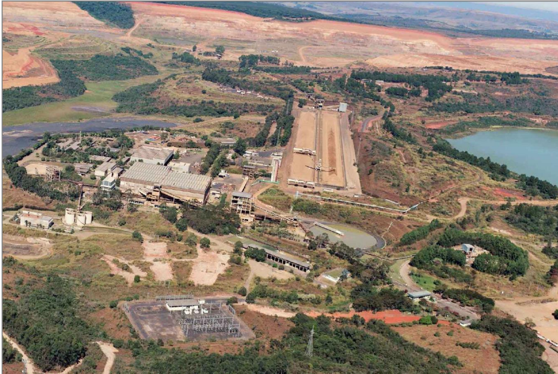
Foto 5.3 – Vista aérea da planta de concentração de minério do CMT.
