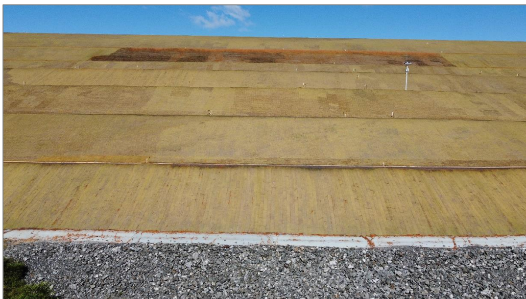
Foto 6.56 – Barramento da BL-1 na área de intervenção.
