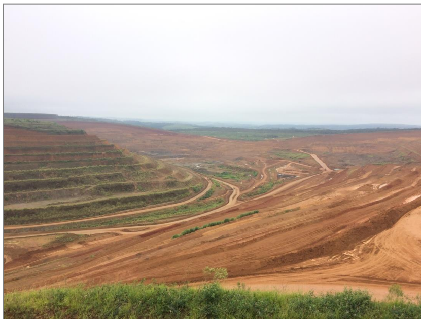
Foto 5.1 – Aspecto geral da lavra atual, em meia encosta.
