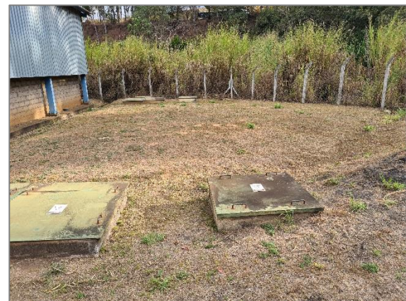
Foto 6.39 – Caixas de contenção.
