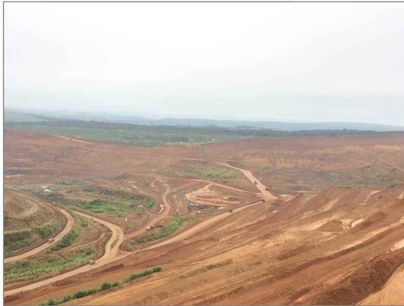
Foto 5.2 – Detalhe da frente de lavra.
