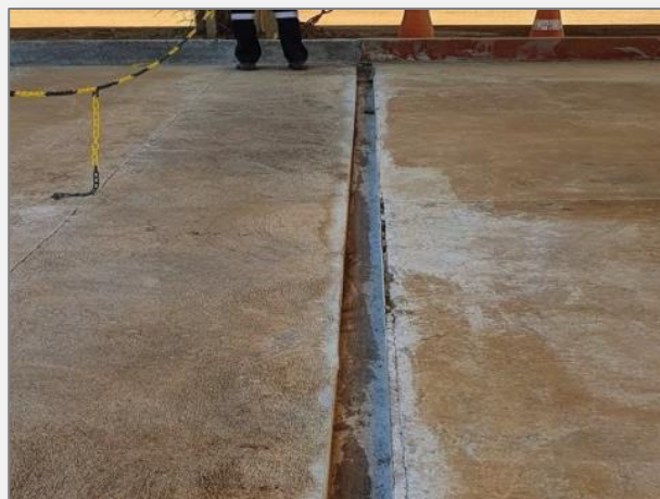
Canaletas no entorno do Posto, interligadas ao sistema SAO.
