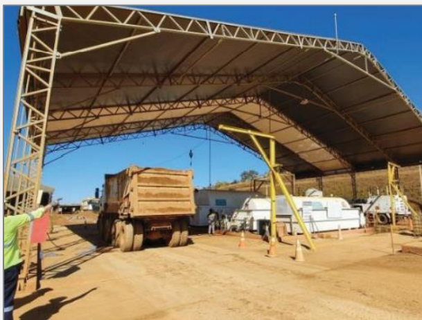
Vista externa do Posto de abastecimento.
