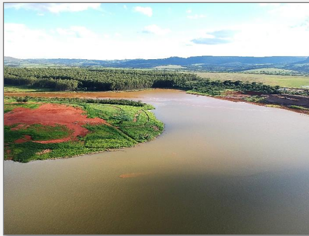
Vista aérea da Barragem B6.
