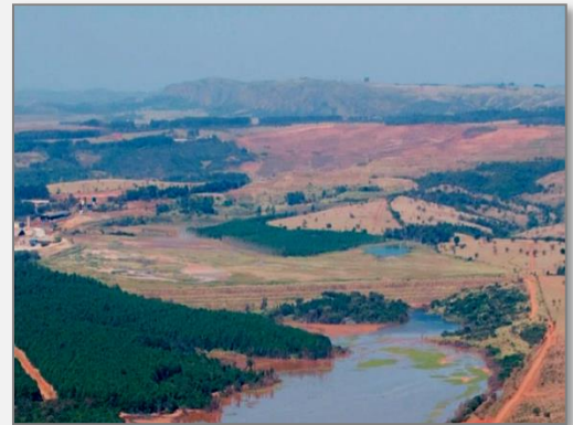
Vista área da Barragem B1/B4.
