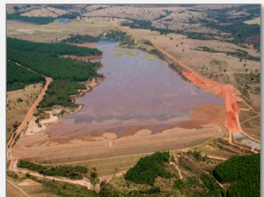
Vista aérea da Barragem B5.
