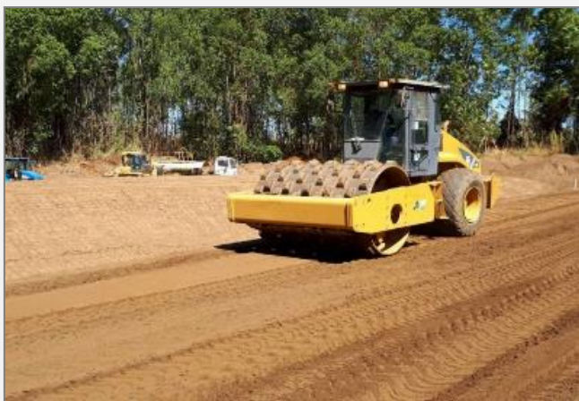
Compactação com pé de carneiro.
