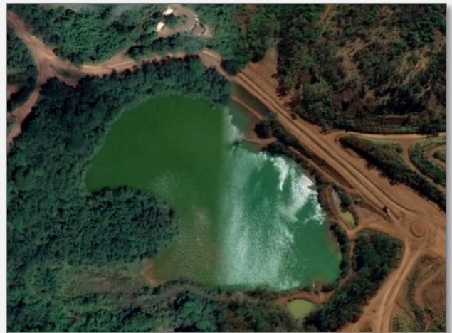
Vista aérea da Barragem F.
