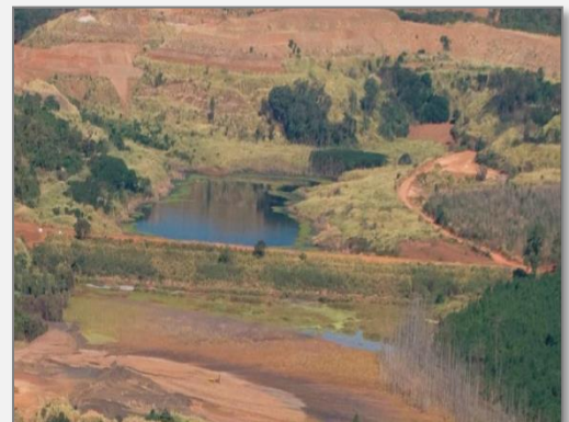
Vista aérea da Barragem B2.
