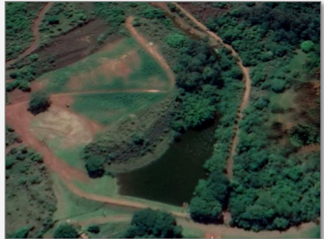
Vista aérea da Barragem A.
