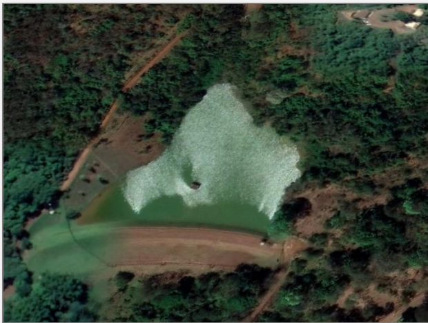
Vista aérea da Barragem E.
