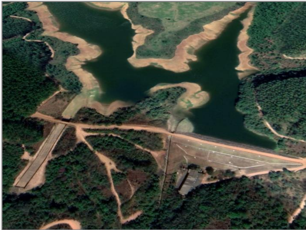
Vista aérea da Barragem A0.
