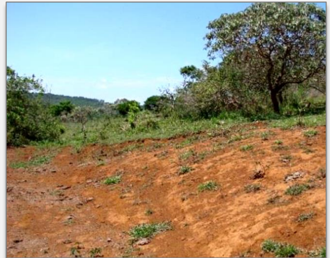
Erosão laminar em área de antiga praça de sondagem.
