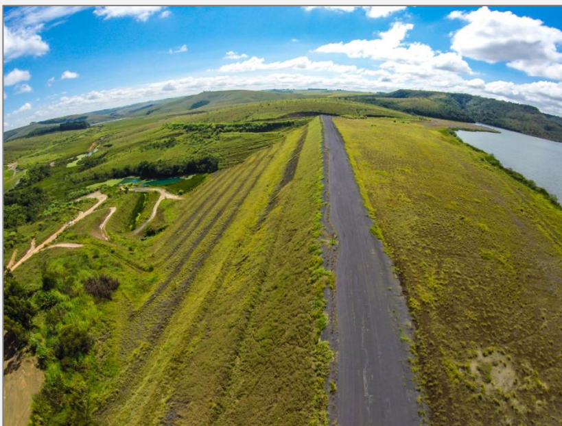
Vista do barramento da BR.
