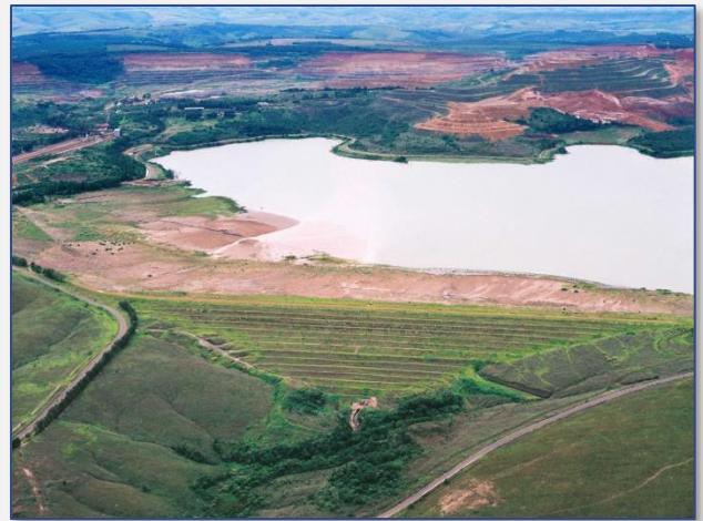
Vista aérea da Barragem BL-1.
