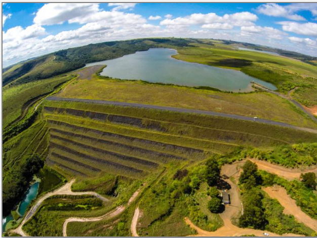
Vista aérea da Barragem BR.
