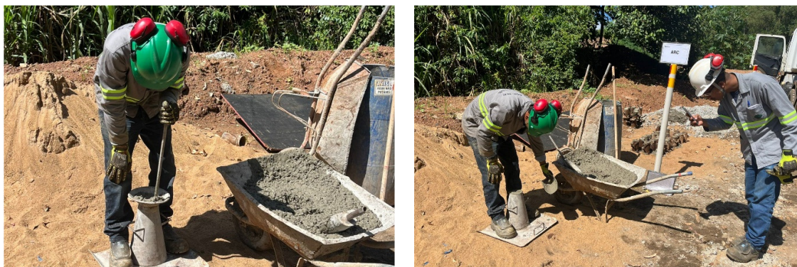
Figura 64 – Controle de qualidade realizado pela fiscalização – Ensaio de “Slump Test” realizado em concreto.
