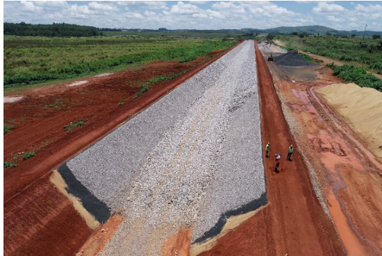
Figura 42 – Aplicação de enrocamento no piso.
