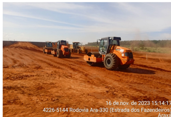
Figura 46 – Compactação de aterro a 95% PN.
