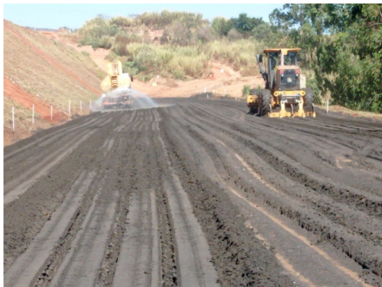
Figura 55 – Carga, transporte, aplicação e compactação de magnetita.
