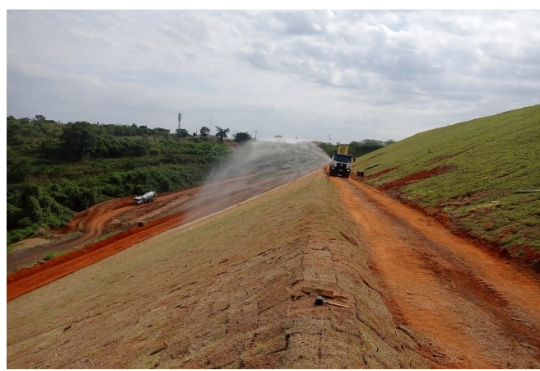
Figura 62 – Plantio de grama próximo ao modulo 65 e em taludes expostos.
