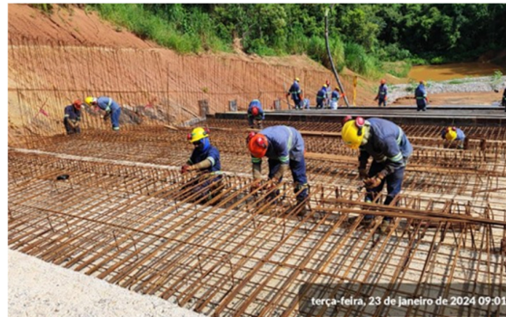
Figura 17 – Montagem de armação nas paredes – módulo 50. Montagem de armação em piso – módulo 18.
