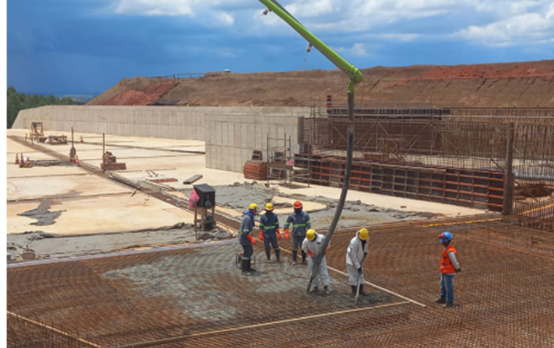
Figura 10 – Concretagem de paredes do canal rápido, módulos 57 e 58. Concretagem do piso transição 1 do maciço.
