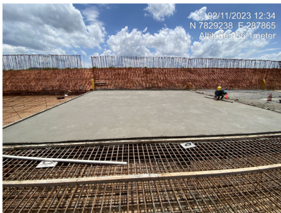
Figura 9 – Concreto aplicado no primeiro pano do piso do módulo 73 e concretagem do terceiro pano do piso do módulo 73.
