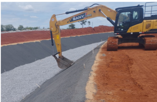
Figura 32 – Conformação de brita 0 e brita 3 nas paredes do canal.
