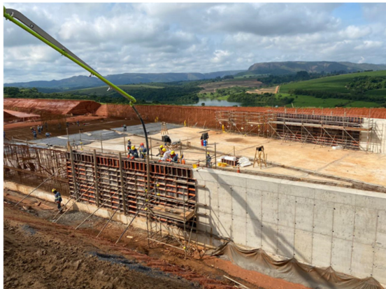
Figura 11 – Concretagem de paredes no módulo 73.
