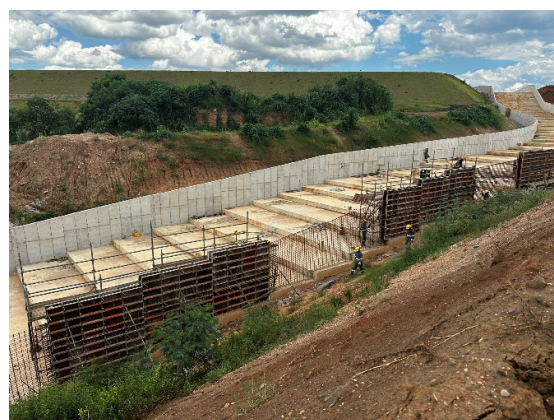
Figura 15 – Instalação de formas para concretagem nos módulos 45, 47 e 49.
