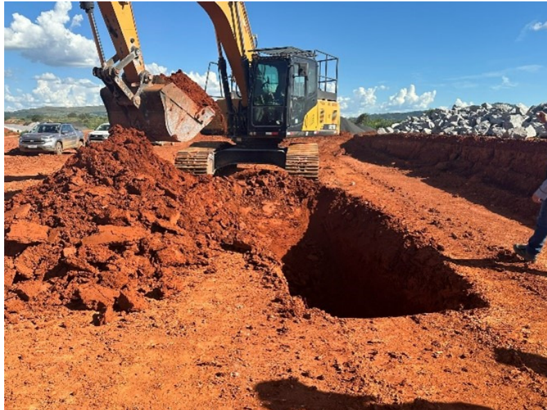
Figura 45 – Execução de sondagem para análise de material a ser utilizado no aterro.
