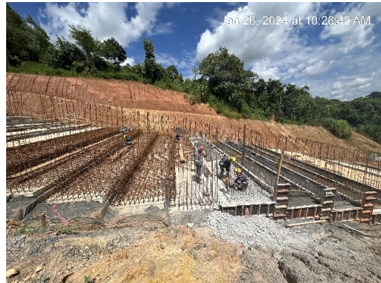
Figura 18 – Aplicação de armação módulo 17.
