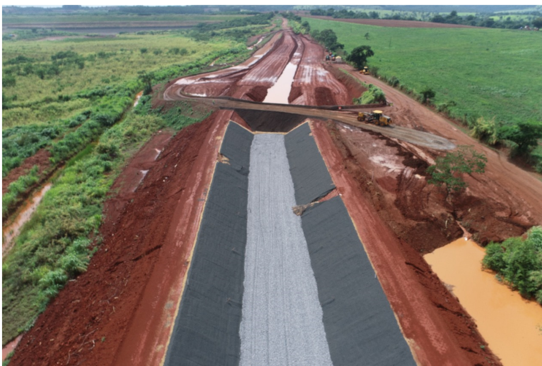
Figura 36 – Avanço da transição (Areia, brita 0 e brita 3) no canal periférico – Estaca 46.
