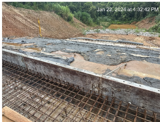
Figura 19 – Ferragem aplicada módulos 17 e cura úmida do concreto módulo 16.
