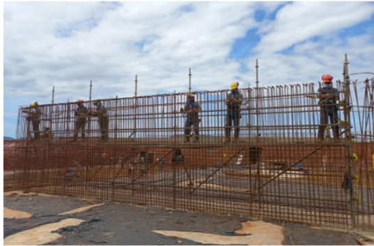
Figura 7 – Montagem de armação módulo 74.
