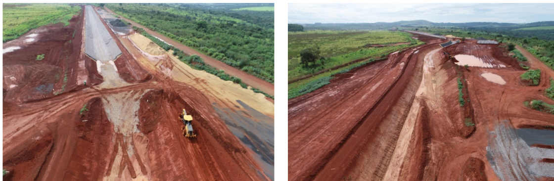
Figura 51 – Execução de aterro – Estaca 43.
