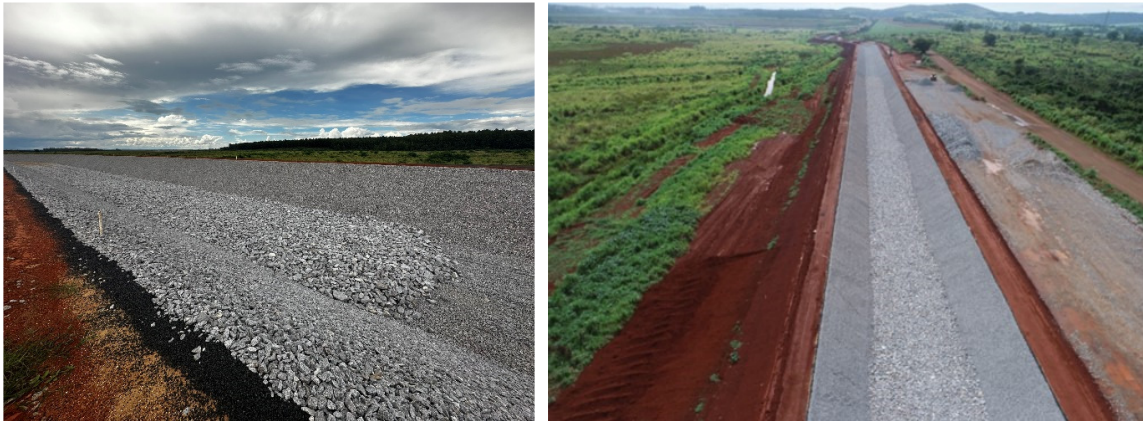
Figura 40 – Aplicação de enrocamento no piso e paredes do canal periférico.
