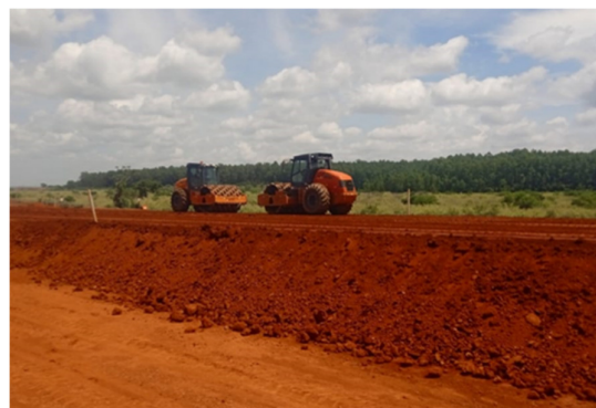
Figura 47 – Compactação de aterro a 95% PN.
