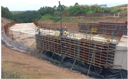
Figura 10 – Concretagem de paredes do canal rápido, módulos 57 e 58. Concretagem do piso transição 1 do maciço.
