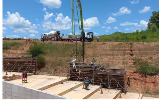
Figura 16 – Formas prontas para aplicação de concreto e concretagem no módulo 47.
