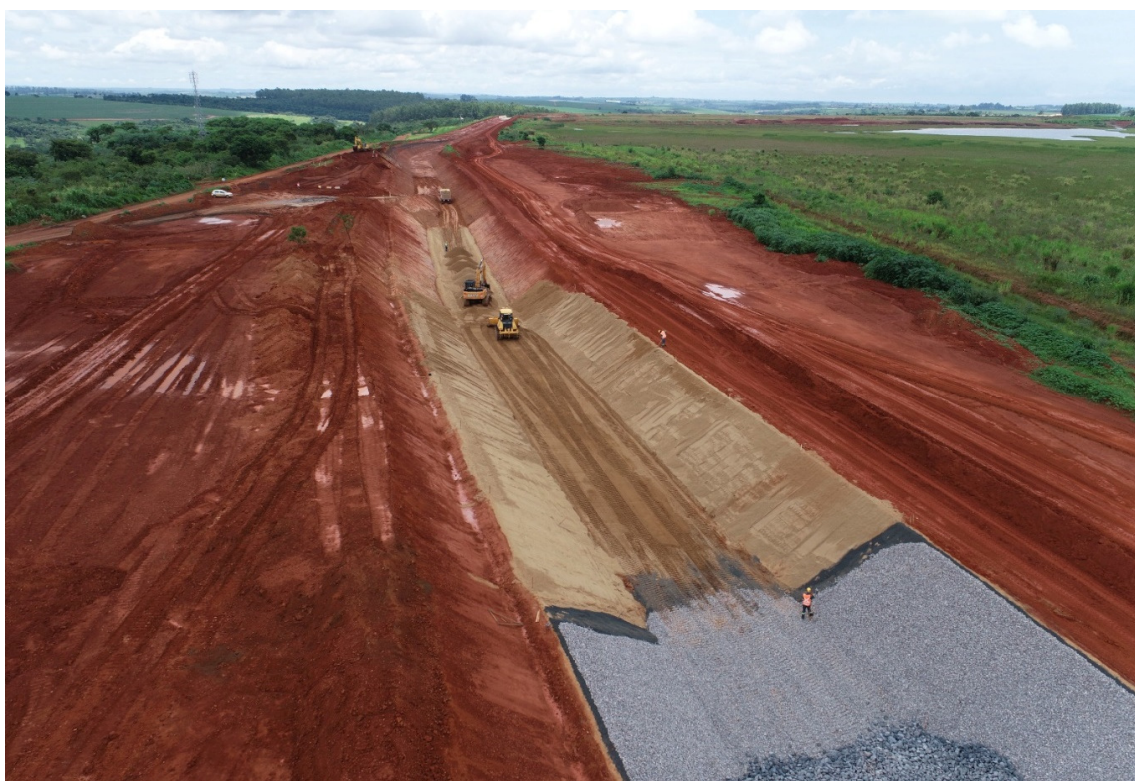
Figura 34 – Espalhamento de adensamento de areia no piso do canal periférico.
