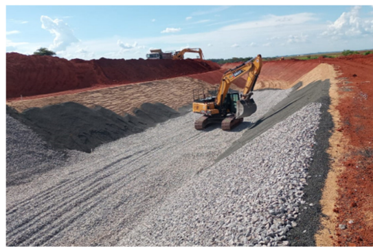
5 de dez. de 2023 09:06:48 Figura 33 – Aplicação, espalhamento e conformação de Brita 0, brita 3 e enrocamento nas paredes do canal.
