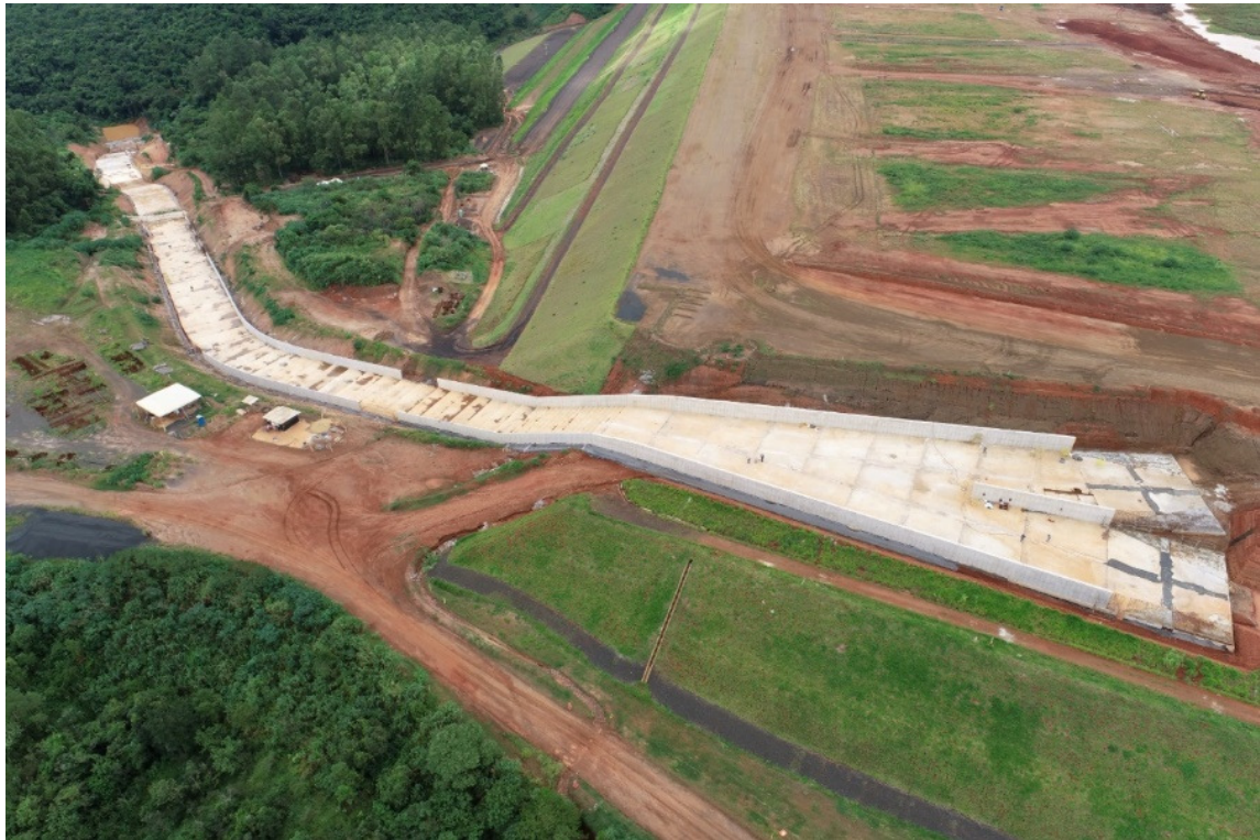
Figura 28 – Vista geral do canal rápido – janeiro/2024.
