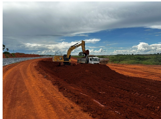
Figura 44 – Escavação e carregamento de argila na área de empréstimo para aterro
