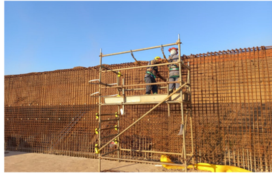
Figura 7 – Montagem de armação módulo 74.
