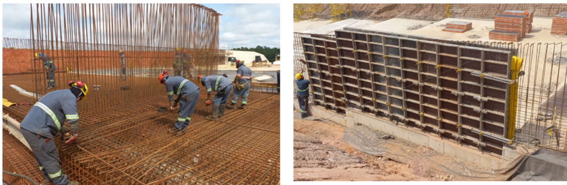
Figura 6 – Montagem de armação – parede central módulo 73. Montagem de forma de parede lado esquerdo canal rápido.
