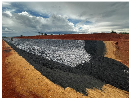
Figura 37 – Trecho com aplicação de transição (esquerda – brita 3 / direita – enrocamento).
