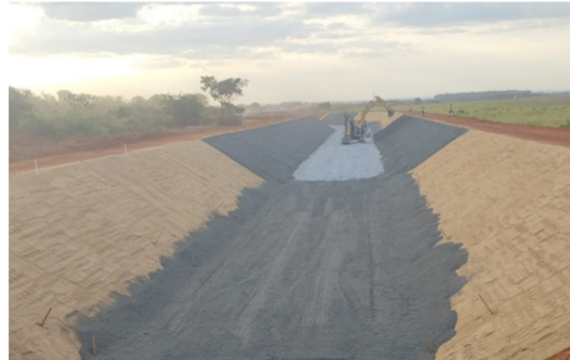
Figura 30 – Espalhamento e adensamento das transições (Areia, Brita 0 e Brita 3).
