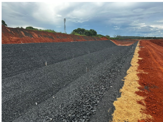
Figura 37 – Trecho com aplicação de transição (esquerda – brita 3 / direita – enrocamento).
