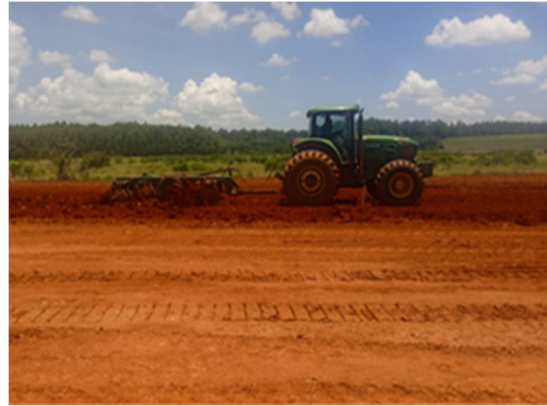
Figura 48 – Execução de camada de aterro – camada lançada de 25 cm.
