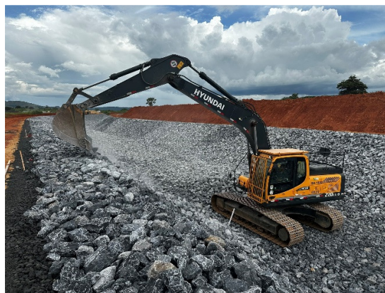
Figura 39 – Aplicação de enrocamento em paredes do canal periférico.
