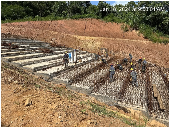
Figura 18 – Aplicação de armação módulo 17.
