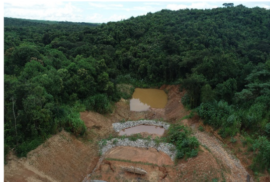
Figura 61 – Escavação, concretagem da laje de piso do canal rápido e proteção com enrocamento no deságue do canal provisório.
