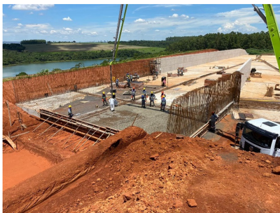
Figura 14 – Concretagem de piso Transição 1 do maciço.
