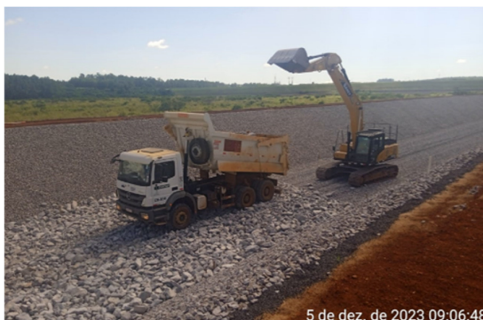
5 de dez. de 2023 09:06:48 Figura 33 – Aplicação, espalhamento e conformação de Brita 0, brita 3 e enrocamento nas paredes do canal.
