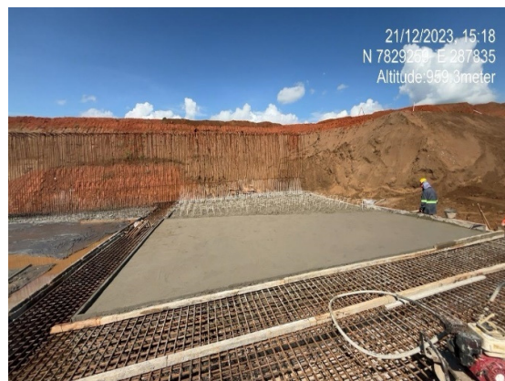
Figura 14 – Concretagem de piso Transição 1 do maciço.
