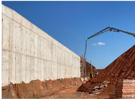
Figura 11 – Concretagem de paredes no módulo 73.
