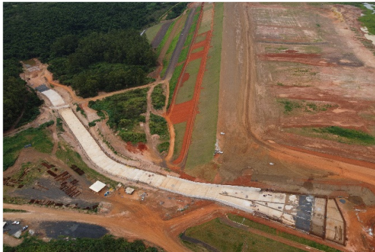
Figura 61 – Escavação, concretagem da laje de piso do canal rápido e proteção com enrocamento no deságue do canal provisório.
