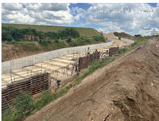
Figura 15 – Instalação de formas para concretagem nos módulos 45, 47 e 49.
