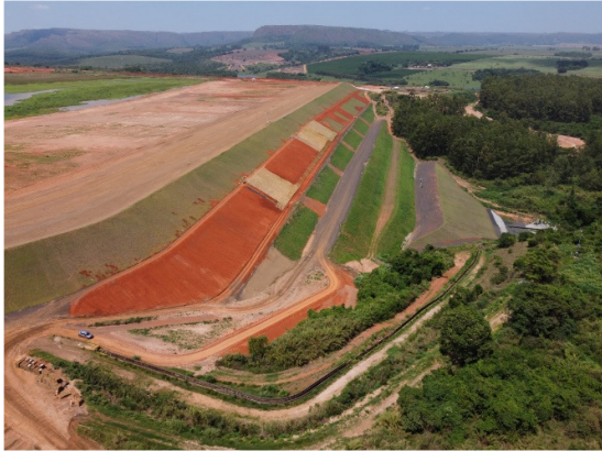
Figura 52 – Conclusão da atividade de regularização das bermas.
