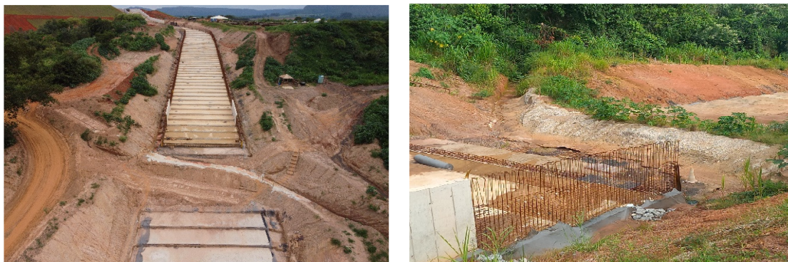
Figura 59 – Leira de proteção e abertura lateral para escoamento do fluxo.
