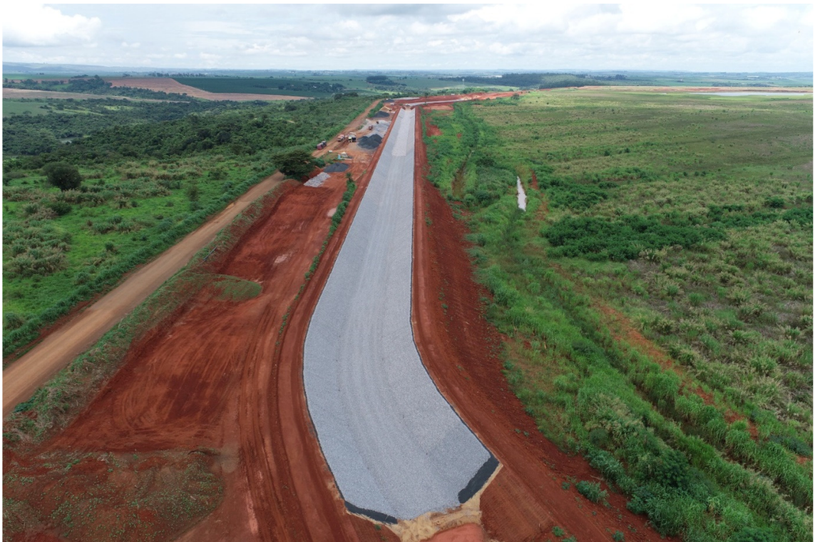
Figura 41 – Vista geral canal periférico – Trecho com transição e início de aplicação de enrocamento.
