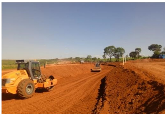
Figura 46 – Compactação de aterro a 95% PN.
