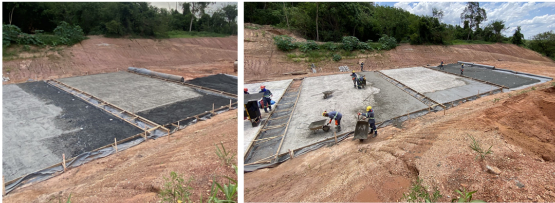
Figura 5 – Aplicação de concreto magro nos módulos 20 a 24.
