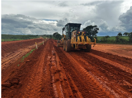
Figura 48 – Execução de camada de aterro – camada lançada de 25 cm.
