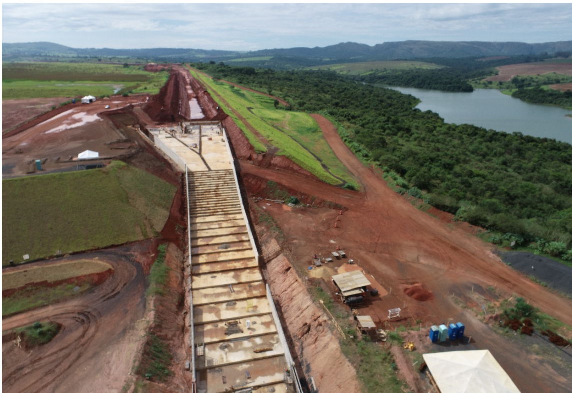
Figura 25 – Vista geral canal rápido – módulos 57 a 74.
