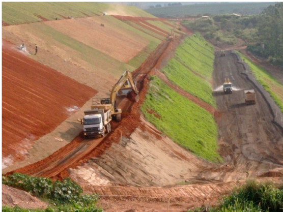
Figura 53 – Execução de revestimento de argila em leiras de proteção.
