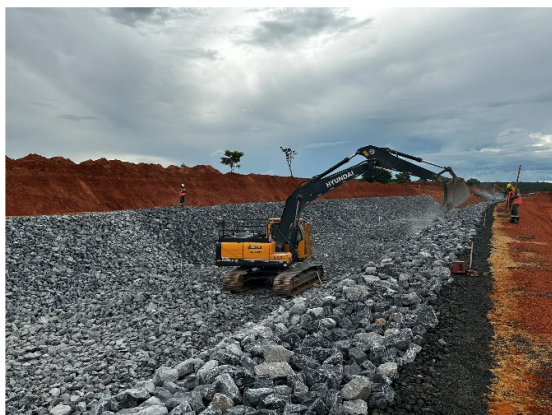
Figura 39 – Aplicação de enrocamento em paredes do canal periférico.
