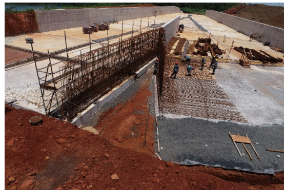
Figura 8 – Concreto magro aplicado e início de montagem de armação – Transição 2.
