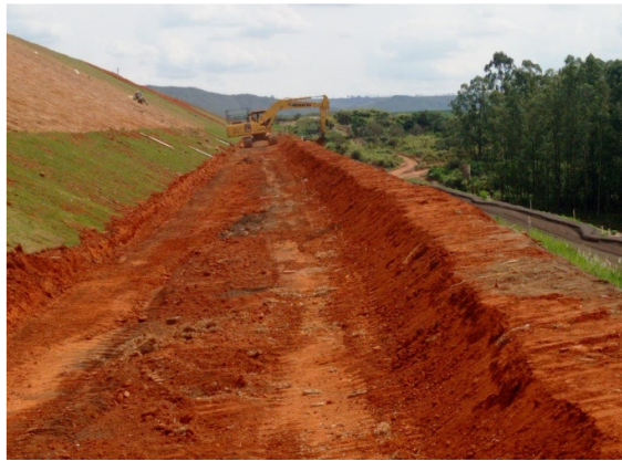
Figura 53 – Execução de revestimento de argila em leiras de proteção.
