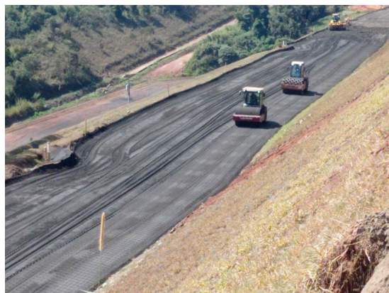
Figura 55 – Carga, transporte, aplicação e compactação de magnetita.
