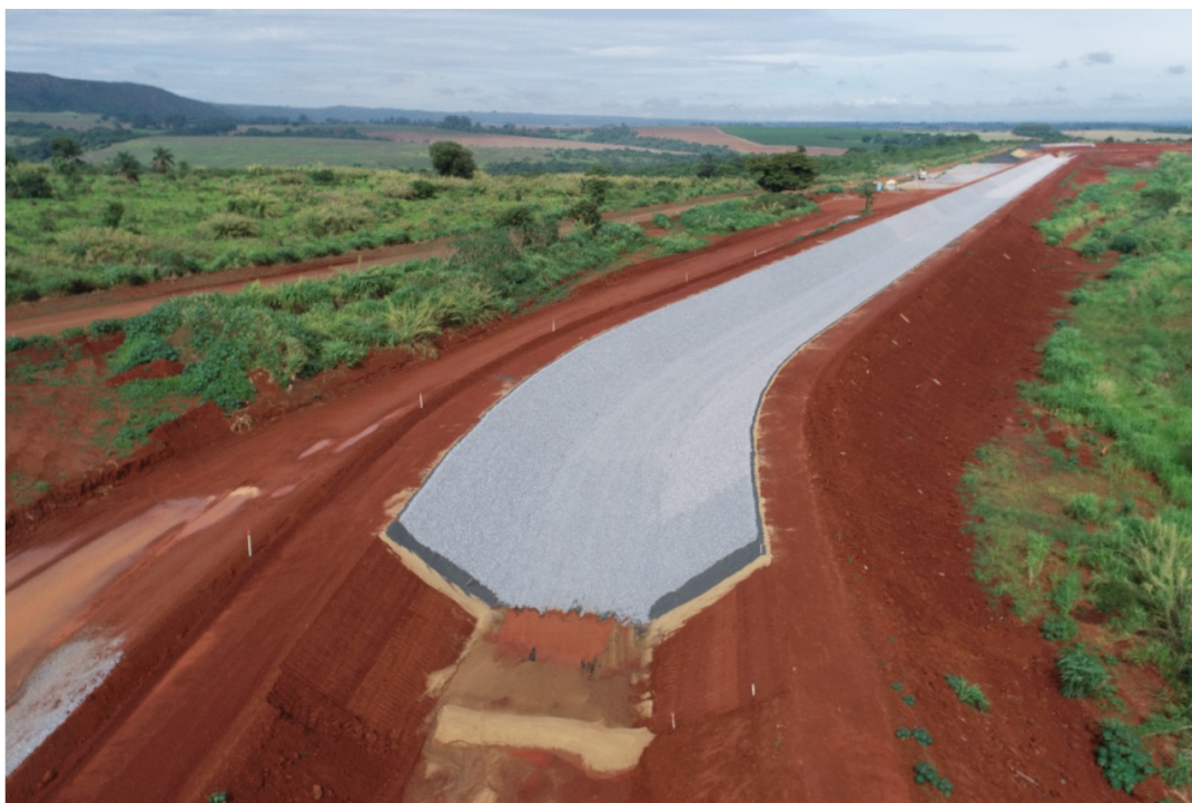
Figura 35 – Avanço da transição (Areia, brita 0 e brita 3) no canal periférico.
