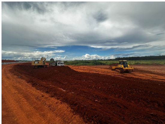
Figura 44 – Escavação e carregamento de argila na área de empréstimo para aterro
