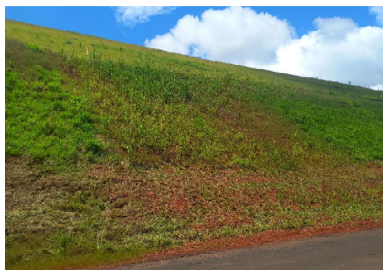
Figura 56 – Retirada das descidas d'água provisórias, reaterro compactado e plantio de hidrosseadura nos taludes.
