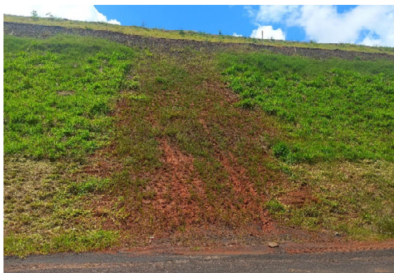
Figura 56 – Retirada das descidas d'água provisórias, reaterro compactado e plantio de hidrosseadura nos taludes.
