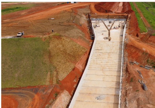
Figura 62 – Plantio de grama próximo ao modulo 65 e em taludes expostos.
