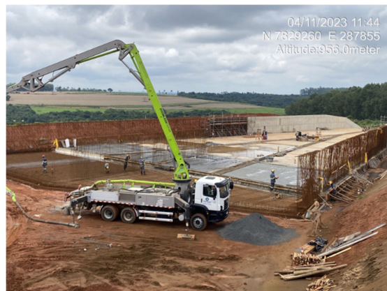
Figura 9 – Concreto aplicado no primeiro pano do piso do módulo 73 e concretagem do terceiro pano do piso do módulo 73.
