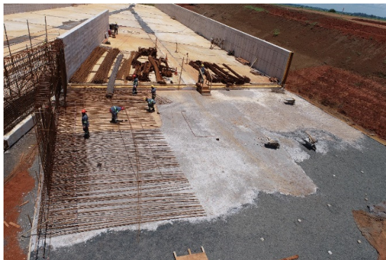
Figura 8 – Concreto magro aplicado e início de montagem de armação – Transição 2.
