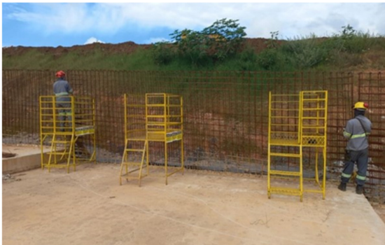
Figura 17 – Montagem de armação nas paredes – módulo 50. Montagem de armação em piso – módulo 18.
