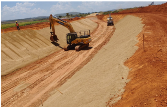
Figura 31 – Espalhamento e adensamento das transições (areia, brita 0 e brita 3).
