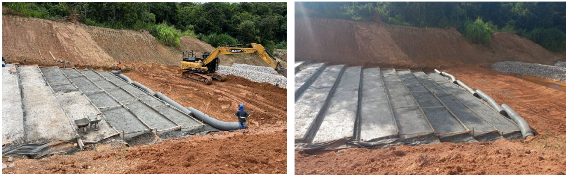
Figura 4 – Escavação de degraus e aplicação de concreto magro – módulos 14 e 15.
