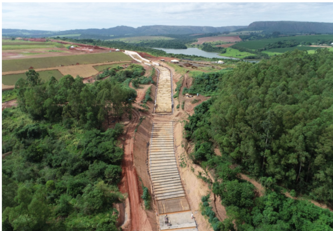
Figura 20 – Visão geral do canal rápido.
