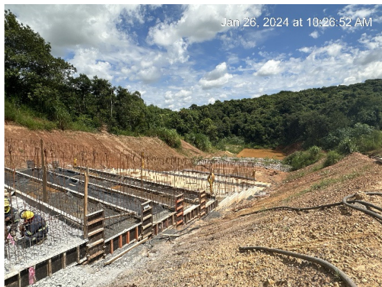
Figura 19 – Ferragem aplicada módulos 17 e cura úmida do concreto módulo 16.
