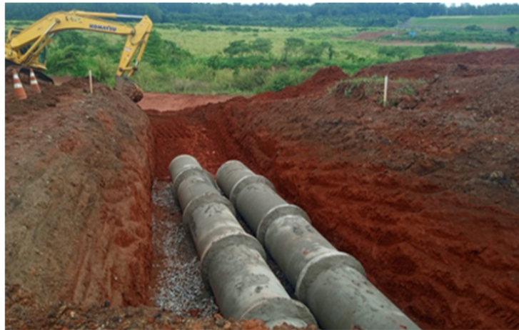
Figura 43 – Execução de corta rio para desvio do fluxo do extravasor da B1/B4
