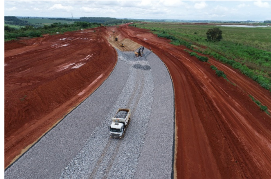
Figura 42 – Aplicação de enrocamento no piso.
