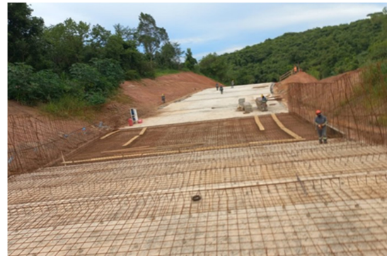
Figura 13 – Concretagem de parede módulo 74. Montagem de armação módulo 25.
