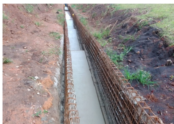
Figura 57 – Execução em andamento dos canais de drenagem ombreira direita e esquerda.
