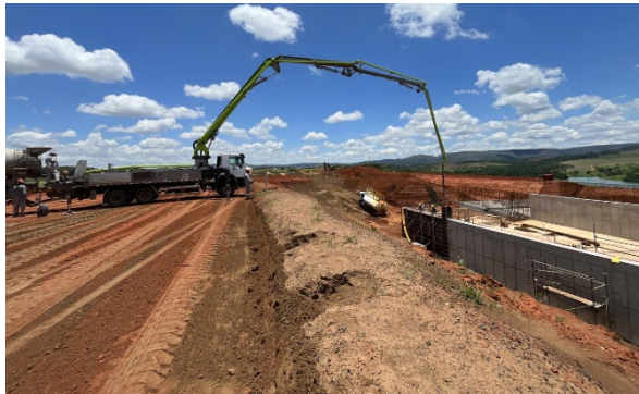
Figura 13 – Concretagem de parede módulo 74. Montagem de armação módulo 25.
