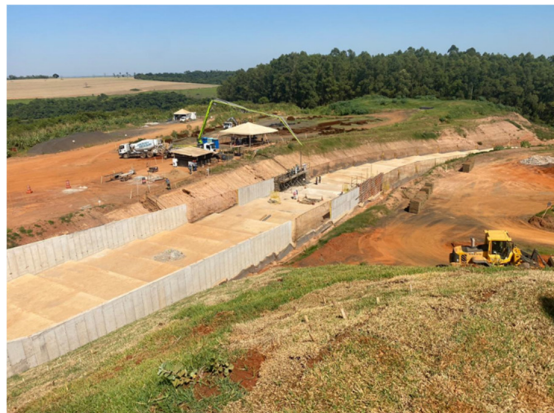
Figura 12 – Ferragem aplicada, instalação de forma para concretagem de paredes do módulo 59 e concretagem de parede no módulo 58.
