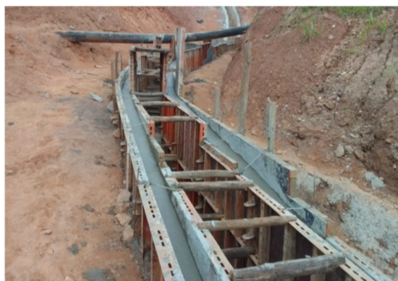
Figura 57 – Execução em andamento dos canais de drenagem ombreira direita e esquerda.
