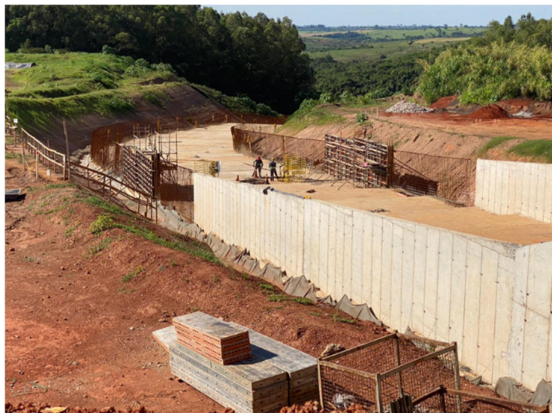
Figura 12 – Ferragem aplicada, instalação de forma para concretagem de paredes do módulo 59 e concretagem de parede no módulo 58.
