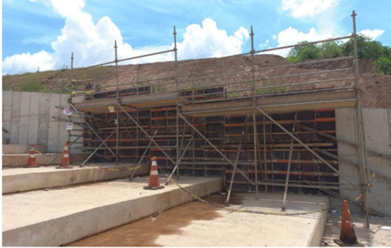
Figura 16 – Formas prontas para aplicação de concreto e concretagem no módulo 47.
