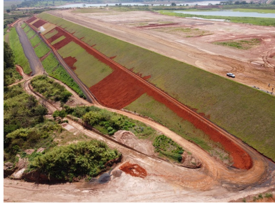
Figura 52 – Conclusão da atividade de regularização das bermas.
