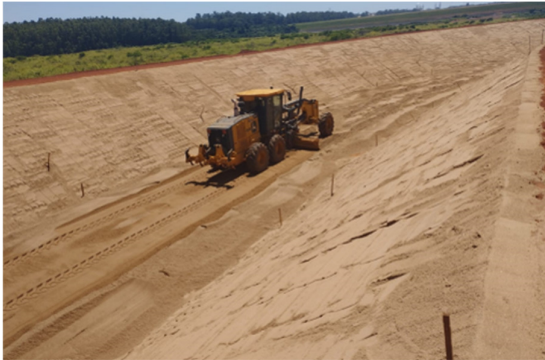
Figura 30 – Espalhamento e adensamento das transições (Areia, Brita 0 e Brita 3).
