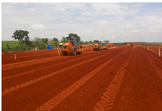
Figura 47 – Compactação de aterro a 95% PN.
