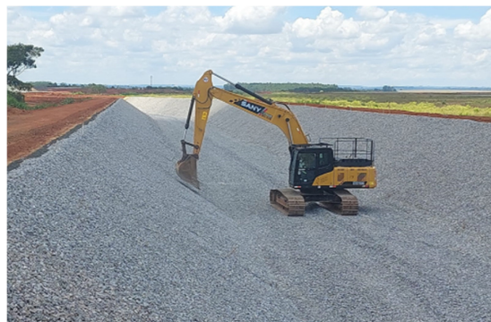
Figura 32 – Conformação de brita 0 e brita 3 nas paredes do canal.
