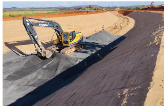
Figura 31 – Espalhamento e adensamento das transições (areia, brita 0 e brita 3).
