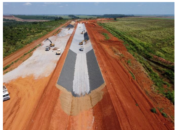
Figura 6.59 – lançamento de enrocamento no trecho do canal periférico.
