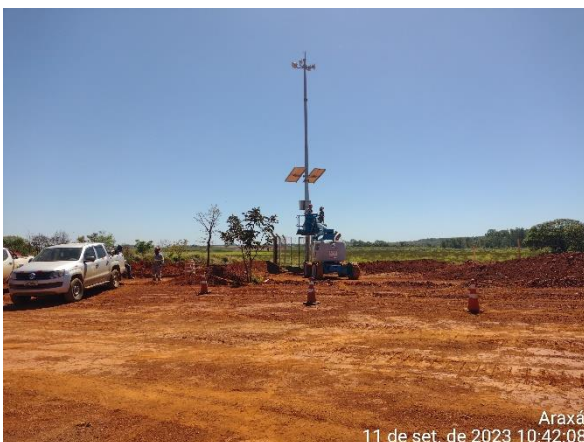
Figura 6.23 – remoção de interferência no trecho do canal periférico: relocação de antena repetidora do sistema de vídeo monitoramento das barragens do CMA.
