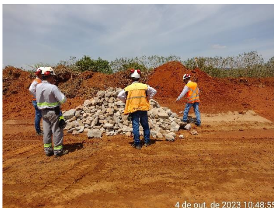
Figura 6.63 – inspeção visual de material granular realizada pela fiscalização e controle de qualidade da contratada.
