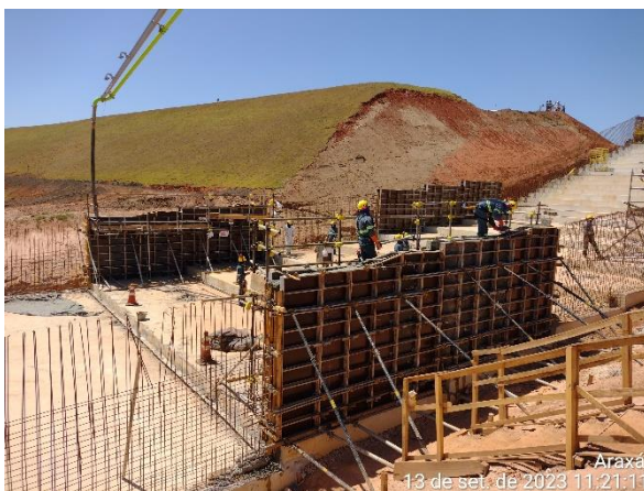
Figura 6.11 – concretagem da parede direita do módulo 63 e remoção de formas de paredes concretadas.
