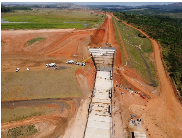
Figura 6.43 – concretagem do piso do módulo 66 (15/09/23) no trecho de transição.
