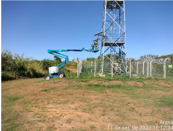
Figura 6.24 – remoção de interferência no trecho do canal periférico: relocação de antena repetidora do sistema de vídeo monitoramento das barragens do CMA.
