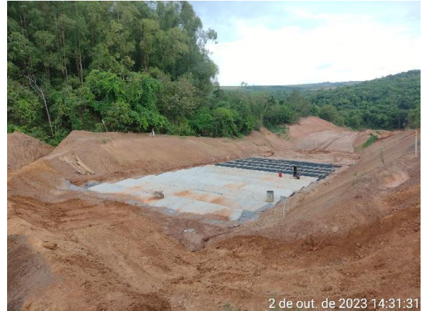
Figura 6.14 – frente de serviço no trecho a jusante da estaca 190: dreno de fundo e lançamento de concreto magro para suporte e sustentação das ferragens.
