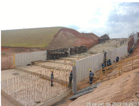
Figura 6.13 – avanço das paredes de concreto do canal rápido a partir do módulo 63.
