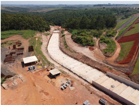
Figura 6.18 – avanços do canal rápido a partir do maciço em direção à estaca 190.
