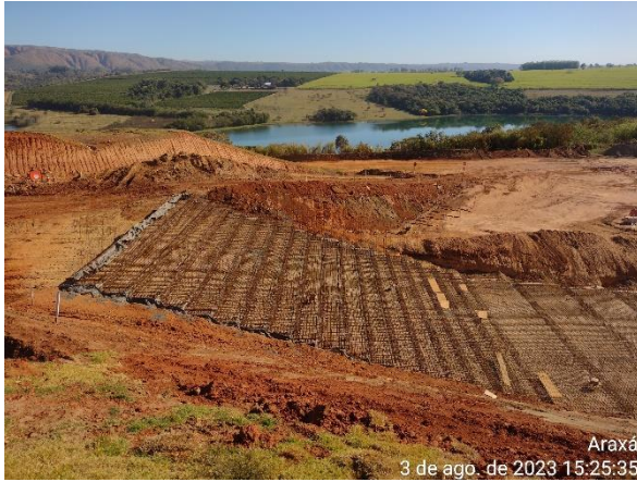
Figura 6.2 – lançamento e amarração de ferragens no trecho do maciço da barragem.
