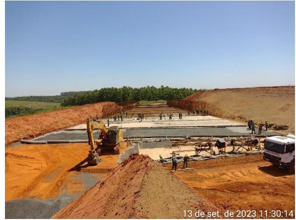
Figura 6.41 – instalação de dreno de fundo, lançamento de concreto magro e frente de serviço de ferragem.
