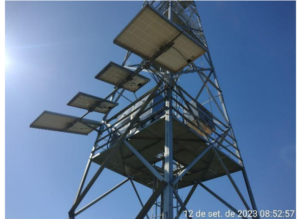
Figura 6.24 – remoção de interferência no trecho do canal periférico: relocação de antena repetidora do sistema de vídeo monitoramento das barragens do CMA.
