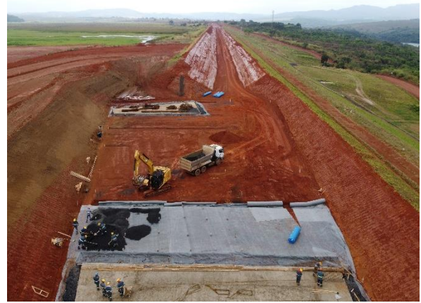
Figura 6.39 – preparação do trecho de transição para recebimento do concreto armado.
