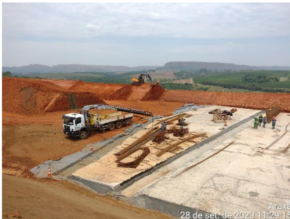
Figura 6.45 – avanço da ferragem sobre o trecho de transição.
