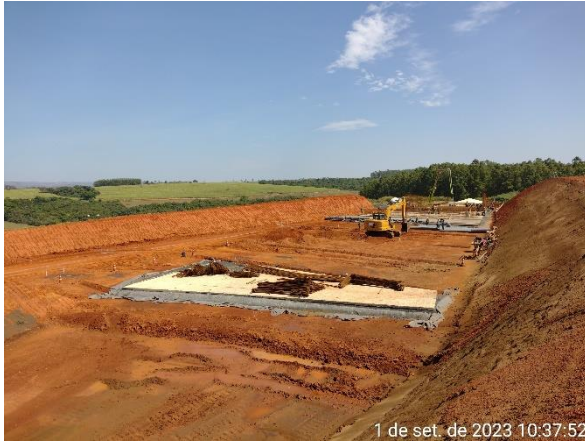
Figura 6.41 – instalação de dreno de fundo, lançamento de concreto magro e frente de serviço de ferragem.
