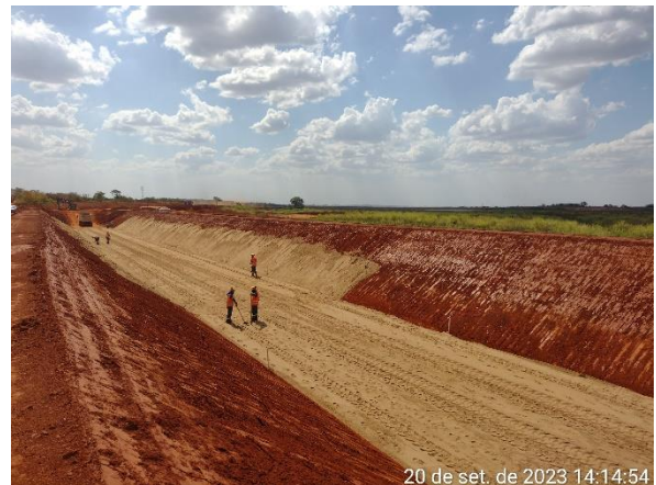
Figura 6.53 – início do lançamento de areia no trecho regularizado do canal periférico.
