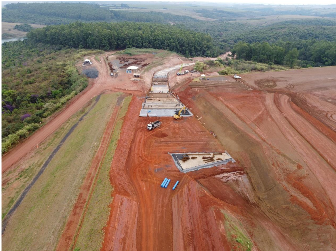
Figura 6.40 – avanço da ferragem sobre o trecho de transição.
