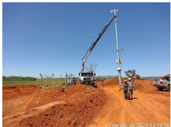
Figura 6.23 – remoção de interferência no trecho do canal periférico: relocação de antena repetidora do sistema de vídeo monitoramento das barragens do CMA.
