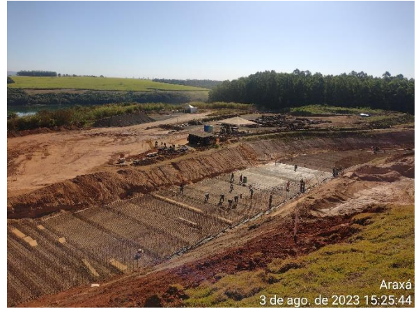
Figura 6.2 – lançamento e amarração de ferragens no trecho do maciço da barragem.
