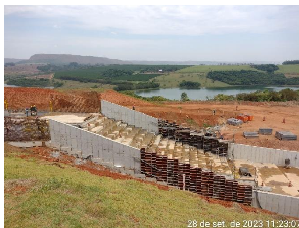
Figura 6.13 – avanço das paredes de concreto do canal rápido a partir do módulo 63.
