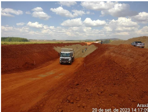
Figura 6.53 – início do lançamento de areia no trecho regularizado do canal periférico.
