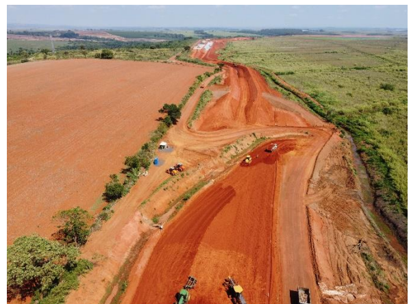
Figura 6.31 – avanço do aterro entre as estacas 43 e 22.
