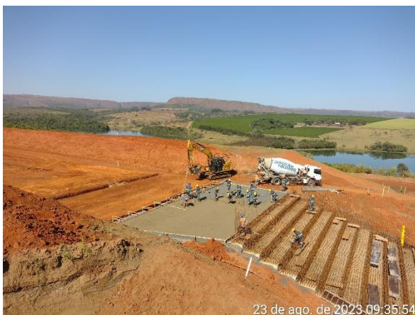
Figura 6.36 – lançamento de concreto magro no módulo 66 (final do trecho de transição e início do canal rápido).
