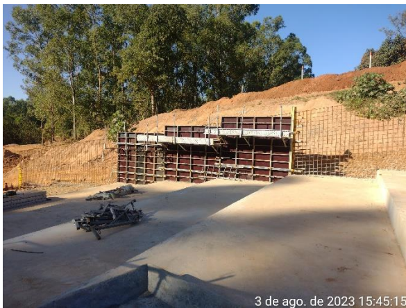
Figura 6.3 – instalação de forma para concretagem da parede do módulo 38 e avanço das ferragens em direção ao maciço da barragem.
