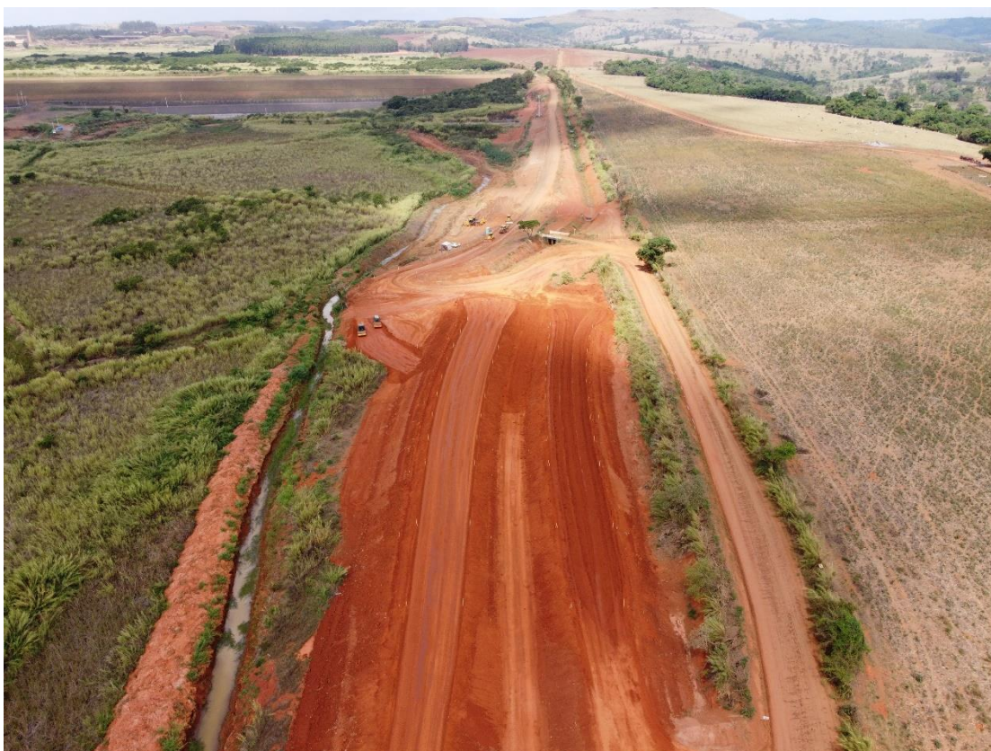
Figura 6.27 – avanço do aterro entre as estacas 50 e 43.
