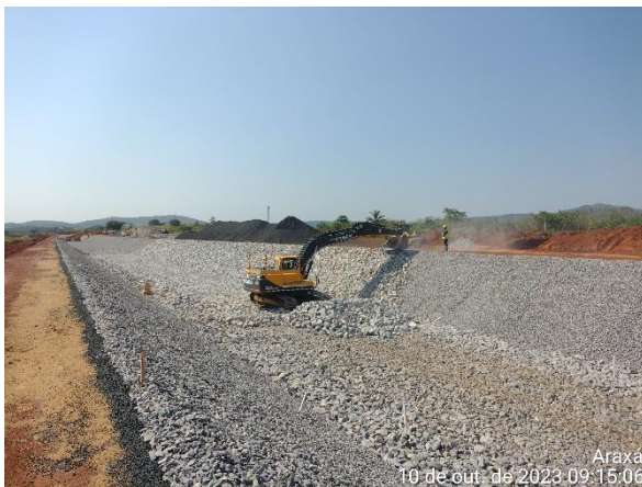
Figura 6.58 – lançamento de enrocamento no trecho do canal periférico.
