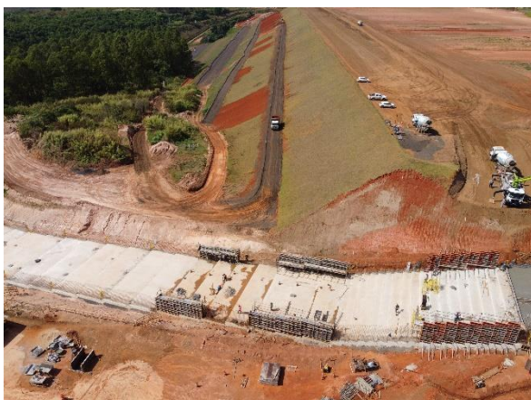
Figura 6.12 – avanço das paredes de concreto do canal rápido a partir do módulo 63.
