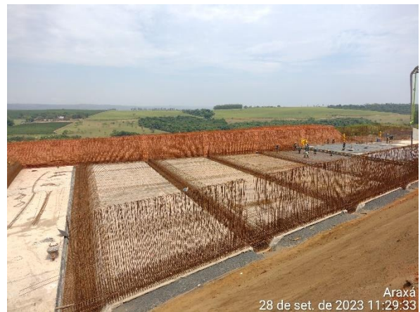
Figura 6.42 – avanço do concreto magro e ferragem no trecho de transição.
