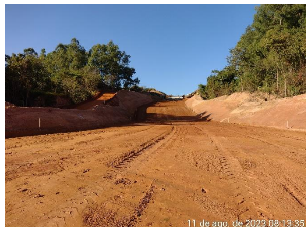
Figura 6.4 – regularização de corte realizado no trecho do canal rápido a jusante da estaca 190.
