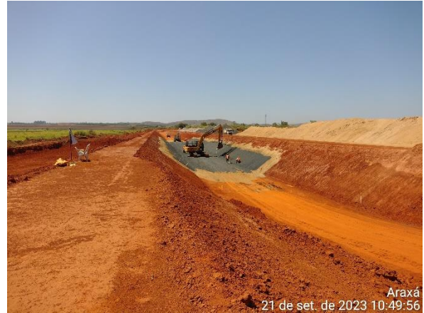
Figura 6.54 – lançamento de camada de brita 0 no trecho do canal periférico.
