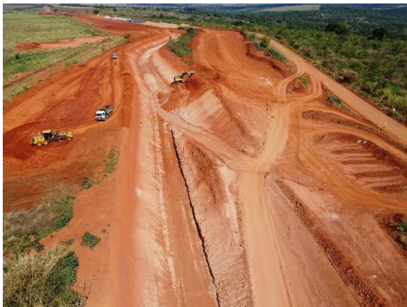
Figura 6.26 – regularização do trecho onde a interferência foi removida e avanço do aterro entre as estacas 50 e 43.
