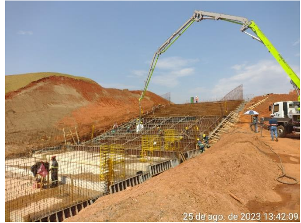
Figura 6.7 – preparação e concretagem do módulo 64 localizado no maciço da barragem.
