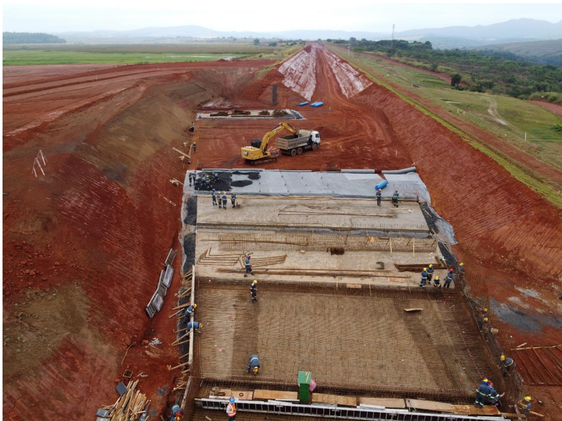
Figura 6.38 – avanço da ferragem sobre o trecho de transição.
