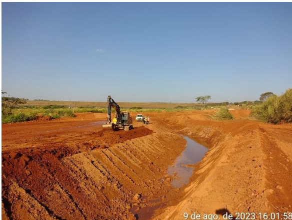
Figura 6.22 – surgência de água e uso de magnetita como suporte para avanço do aterro em argila.
