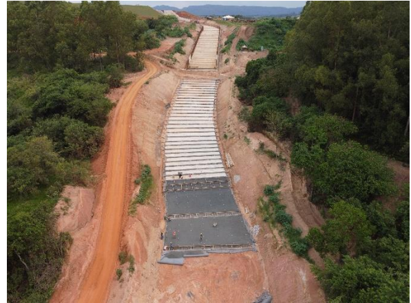
Figura 6.19 – avanços da instalação de dreno de fundo e concreto magro a partir da estaca 190 durante o mês de outubro.
