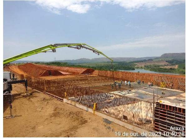
Figura 6.48 – avanço da ferragem sobre os módulos do trecho de transição e concretagem do módulo 71.
