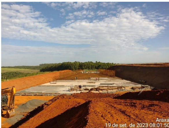
Figura 6.42 – avanço do concreto magro e ferragem no trecho de transição.
