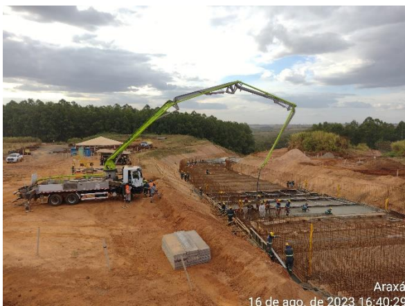
Figura 6.6 – concretagem do módulo 62 (16/08) e módulo 53 (17/08).
