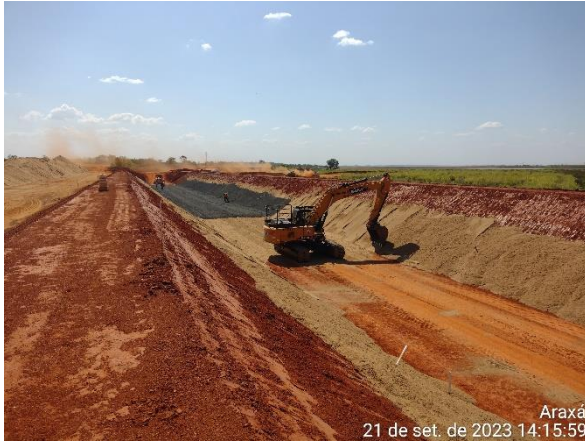
Figura 6.54 – lançamento de camada de brita 0 no trecho do canal periférico.
