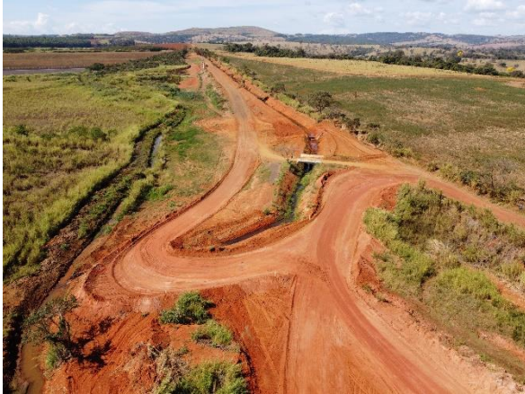
Figura 6.21 – avanço do aterro em argila no trecho entre as estacas 50 e 43.
