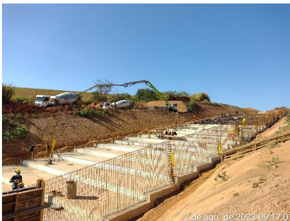
Figura 6.1 – avanços do concreto estrutural e das ferragens ao longo do canal rápido.
