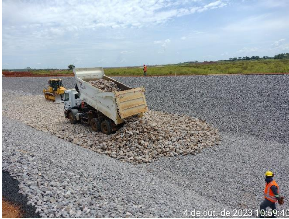
Figura 6.57 – lançamento de enrocamento no trecho do canal periférico.
