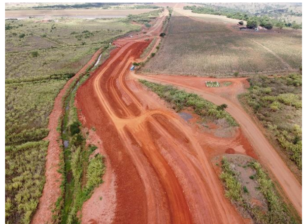
Figura 6.26 – regularização do trecho onde a interferência foi removida e avanço do aterro entre as estacas 50 e 43.
