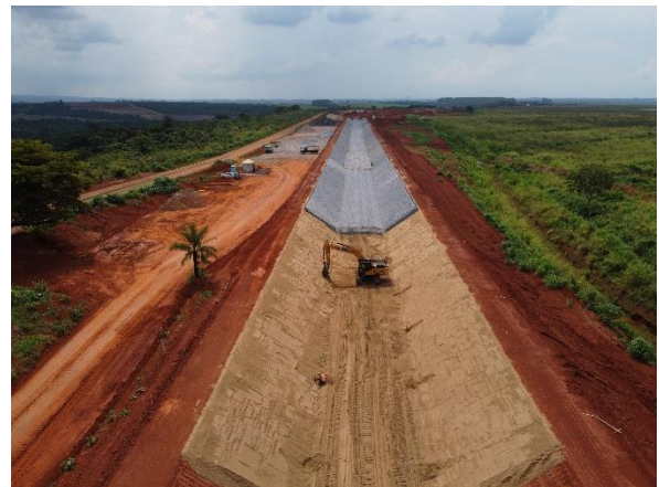
Figura 6.61 – lançamento de enrocamento no trecho do canal periférico.
