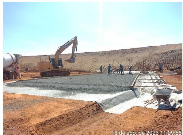
Figura 6.35 – início da instalação do dreno de fundo do canal no trecho de transição e lançamento de concreto magro.
