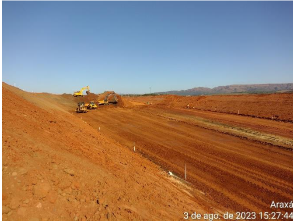
Figura 6.34 – preparação do trecho de transição entre os canais periférico, reservatório e rápido.
