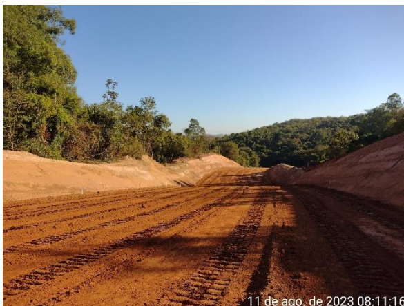
Figura 6.4 – regularização de corte realizado no trecho do canal rápido a jusante da estaca 190.
