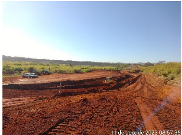
Figura 6.22 – surgência de água e uso de magnetita como suporte para avanço do aterro em argila.
