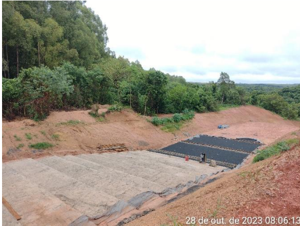
Figura 6.19 – avanços da instalação de dreno de fundo e concreto magro a partir da estaca 190 durante o mês de outubro.
