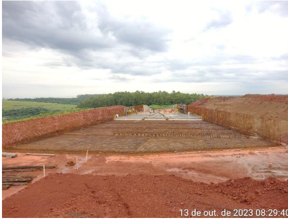
Figura 6.48 – avanço da ferragem sobre os módulos do trecho de transição e concretagem do módulo 71.
