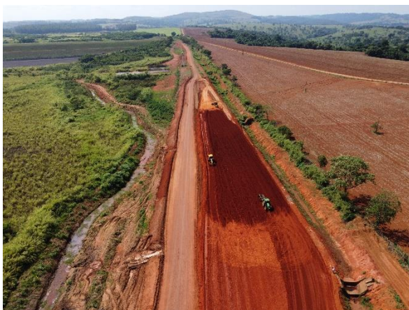
Figura 6.31 – avanço do aterro entre as estacas 43 e 22.
