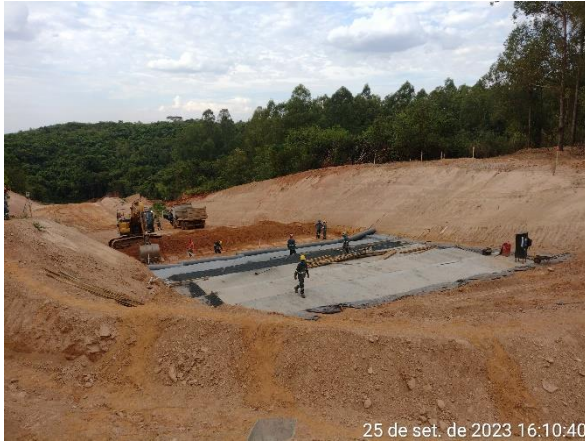
Figura 6.14 – frente de serviço no trecho a jusante da estaca 190: dreno de fundo e lançamento de concreto magro para suporte e sustentação das ferragens.
