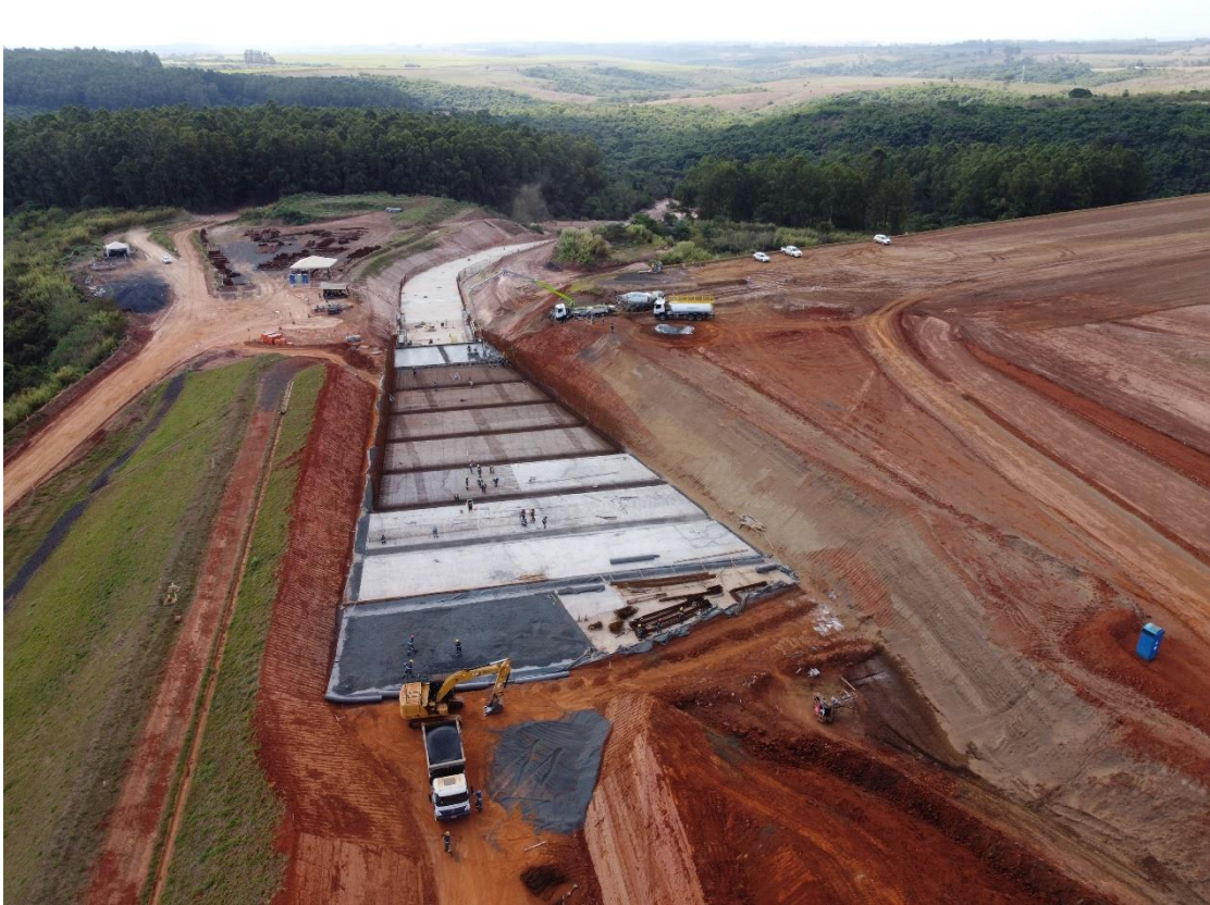
Figura 6.44 – concretagem do módulo 66.
