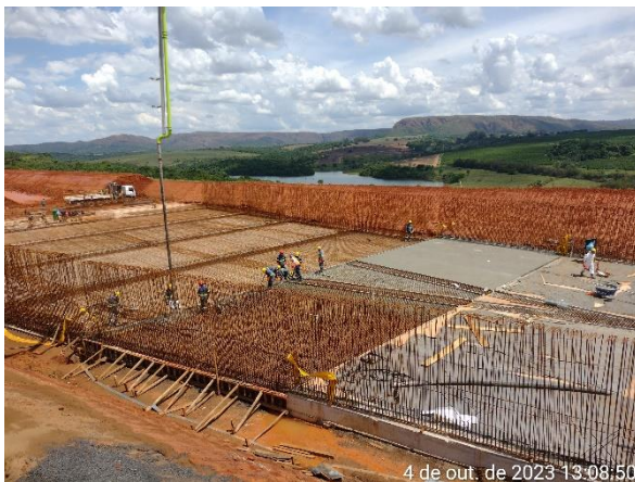
Figura 6.46 – concretagem do piso do módulo 69.
