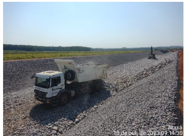
Figura 6.58 – lançamento de enrocamento no trecho do canal periférico.
