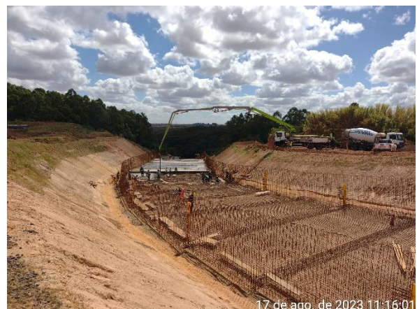
Figura 6.6 – concretagem do módulo 62 (16/08) e módulo 53 (17/08).
