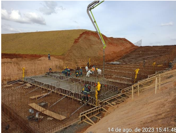
Figura 6.5 – concretagem do módulo 61.
