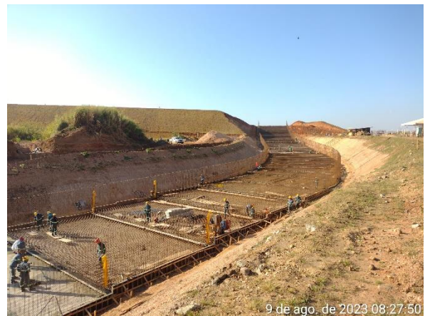
Figura 6.3 – instalação de forma para concretagem da parede do módulo 38 e avanço das ferragens em direção ao maciço da barragem.
