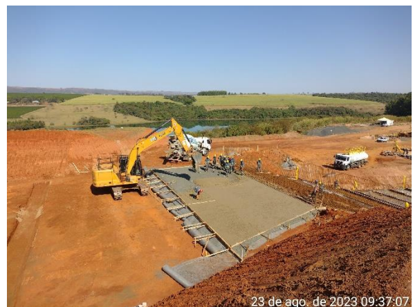
Figura 6.36 – lançamento de concreto magro no módulo 66 (final do trecho de transição e início do canal rápido).
