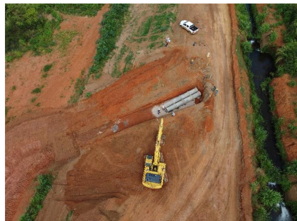
Figura 6.33 – avanço das escavações entre as estacas E135 e E171 – dique lateral barragem B5.
