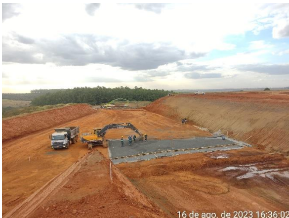
Figura 6.35 – início da instalação do dreno de fundo do canal no trecho de transição e lançamento de concreto magro.
