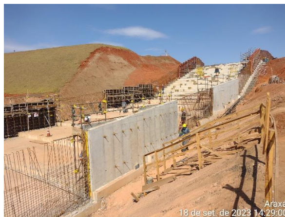
Figura 6.11 – concretagem da parede direita do módulo 63 e remoção de formas de paredes concretadas.
