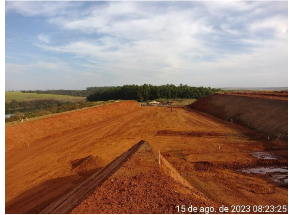
Figura 6.34 – preparação do trecho de transição entre os canais periférico, reservatório e rápido.
