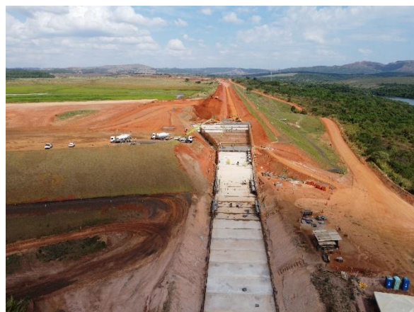
Figura 6.12 – avanço das paredes de concreto do canal rápido a partir do módulo 63.
