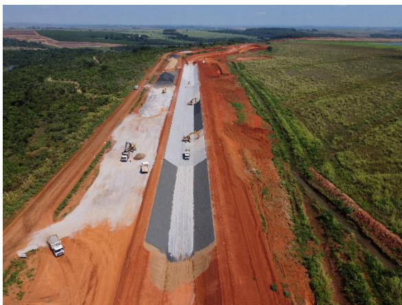
Figura 6.59 – lançamento de enrocamento no trecho do canal periférico.
