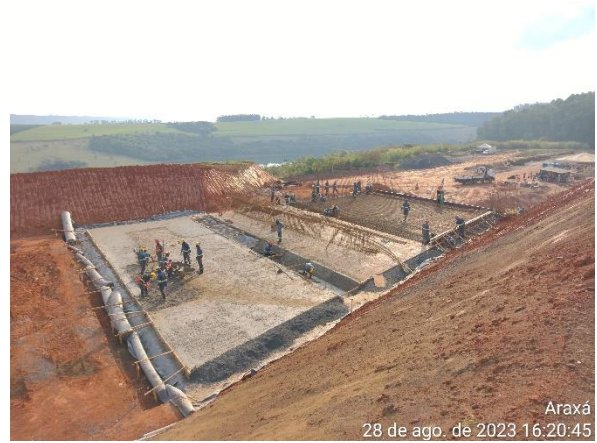
Figura 6.37 – lançamento de concreto magro no módulo 66 (final do trecho de transição e início do canal rápido).
