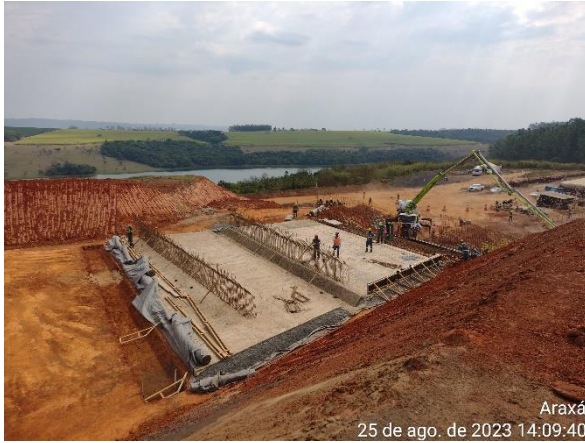
Figura 6.37 – lançamento de concreto magro no módulo 66 (final do trecho de transição e início do canal rápido).
