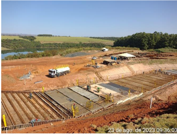
Figura 6.7 – preparação e concretagem do módulo 64 localizado no maciço da barragem.
