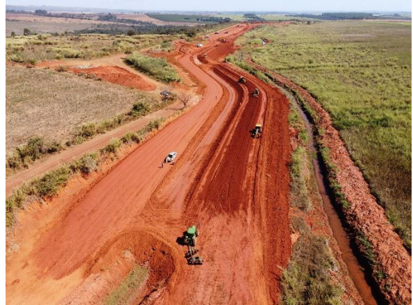
Figura 6.21 – avanço do aterro em argila no trecho entre as estacas 50 e 43.
