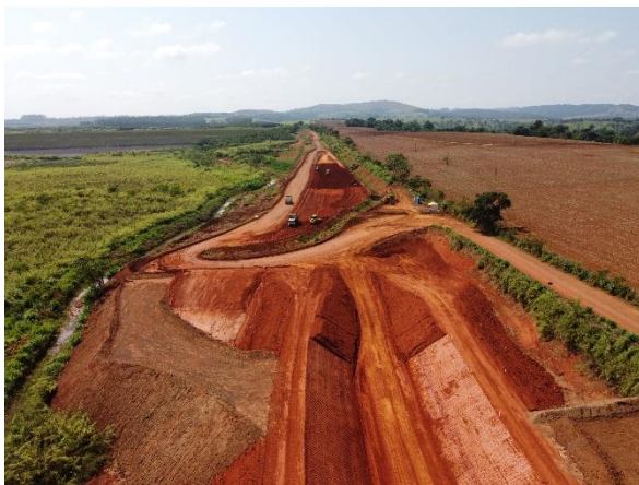
Figura 6.30 – avanço do aterro entre as estacas 43 e 22.
