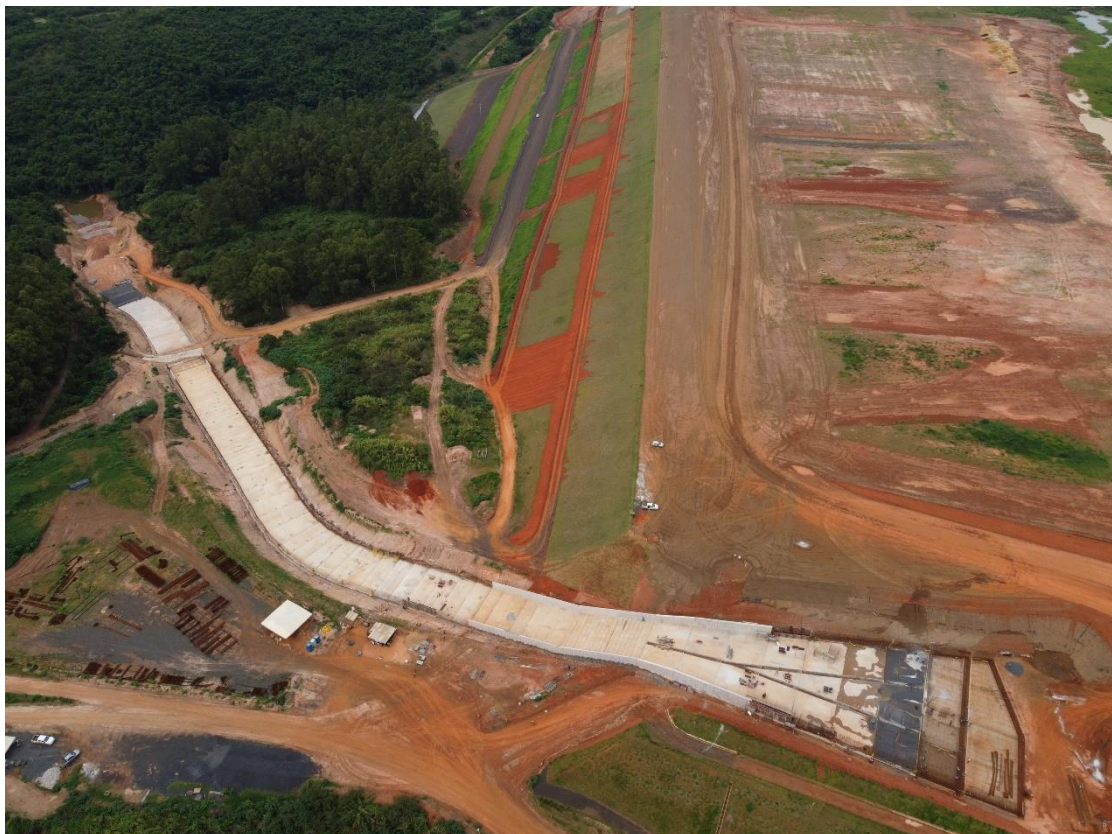
Figura 6.20 – trecho do canal rápido em concreto armado (incluindo trecho de transição).
