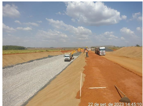
Figura 6.55 – lançamento de camada de brita 3 no trecho do canal periférico.
