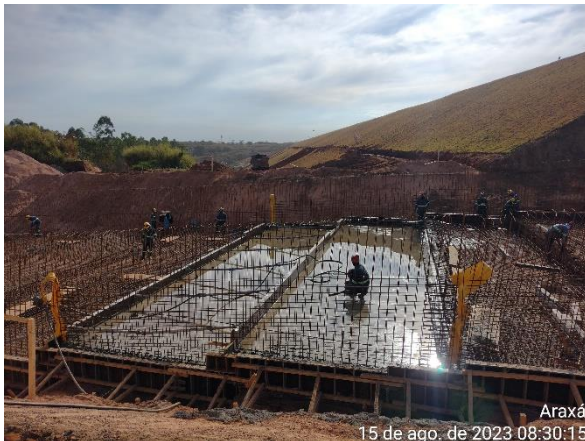
Figura 6.5 – processo de cura do concreto através do processo de molhagem dos pisos.
