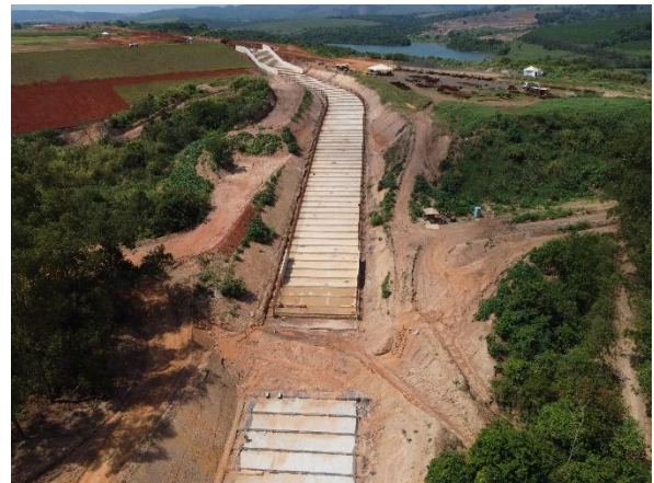
Figura 6.18 – avanços do canal rápido a partir do maciço em direção à estaca 190.
