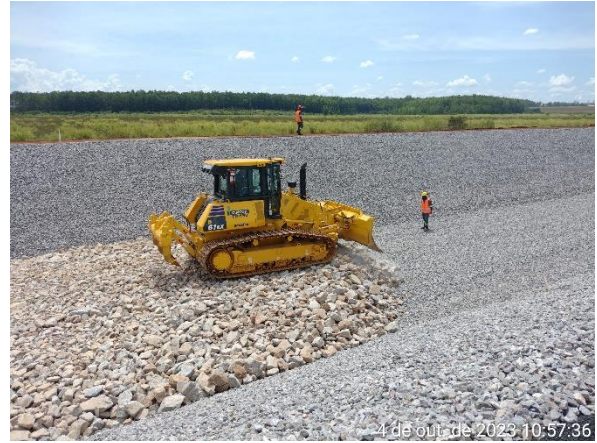
Figura 6.57 – lançamento de enrocamento no trecho do canal periférico.
