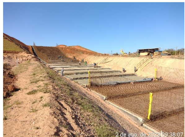
Figura 6.1 – avanços do concreto estrutural e das ferragens ao longo do canal rápido.
