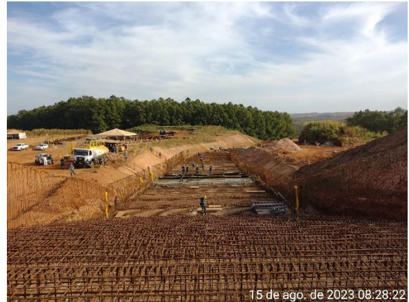
Figura 6.5 – concretagem do módulo 61.
