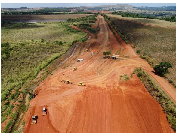
Figura 6.28 – avanço do aterro entre as estacas 50 e 43.
