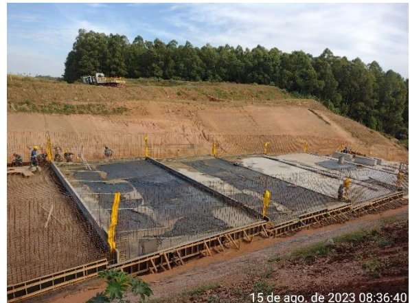
Figura 6.5 – processo de cura do concreto através do processo de molhagem dos pisos.
