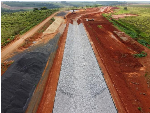
Figura 6.61 – lançamento de enrocamento no trecho do canal periférico.
