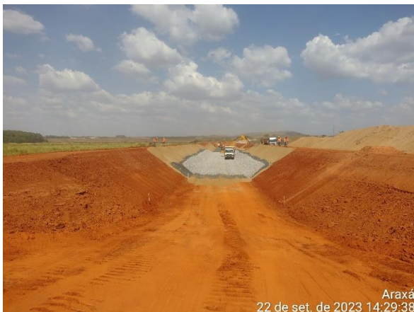
Figura 6.55 – lançamento de camada de brita 3 no trecho do canal periférico.
