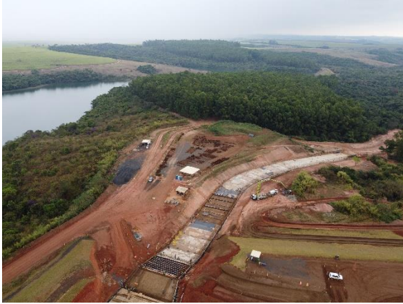
Figura 6.9 – avanço do canal rápido durante o mês de agosto.
