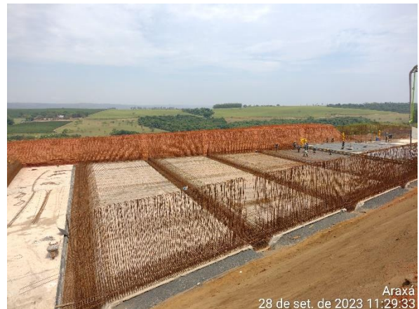
Figura 6.45 – avanço da ferragem sobre o trecho de transição.
