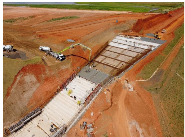
Figura 6.43 – concretagem do piso do módulo 66 (15/09/23) no trecho de transição.
