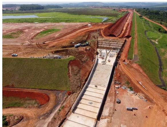
Figura 6.46 – concretagem do piso do módulo 69.
