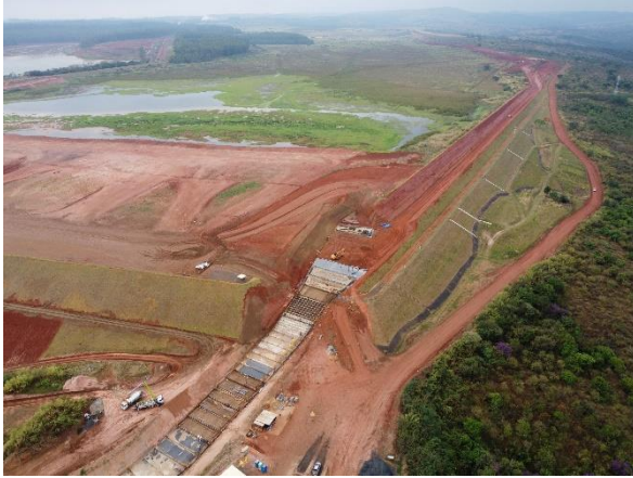
Figura 6.39 – preparação do trecho de transição para recebimento do concreto armado.
