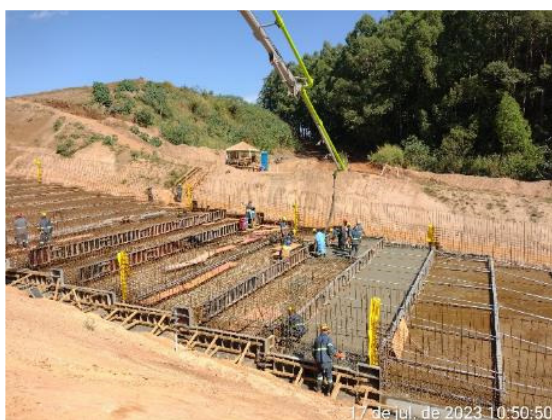
Figura 6.24 – Concretagem do piso do módulo 38.
