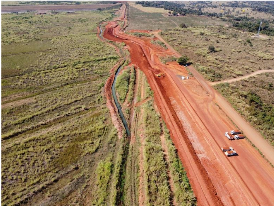
Figura 6.46 – avanço das escavações e aterro do canal periférico entre as estacas E43 e E101.
