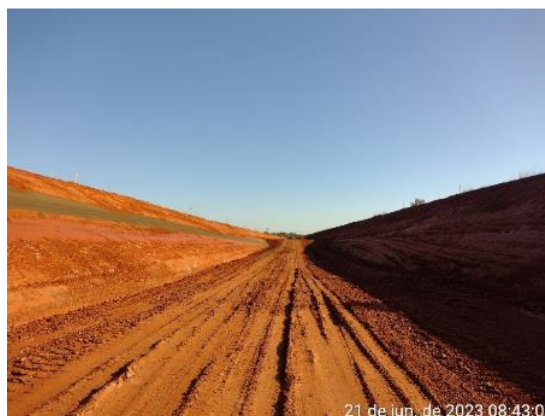
Figura 6.36 – avanço das escavações entre as estacas E135 e E171 – dique lateral barragem B5.
