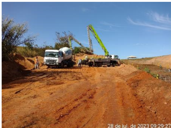
Figura 6.29 – Concretagem do piso do módulo 43.
