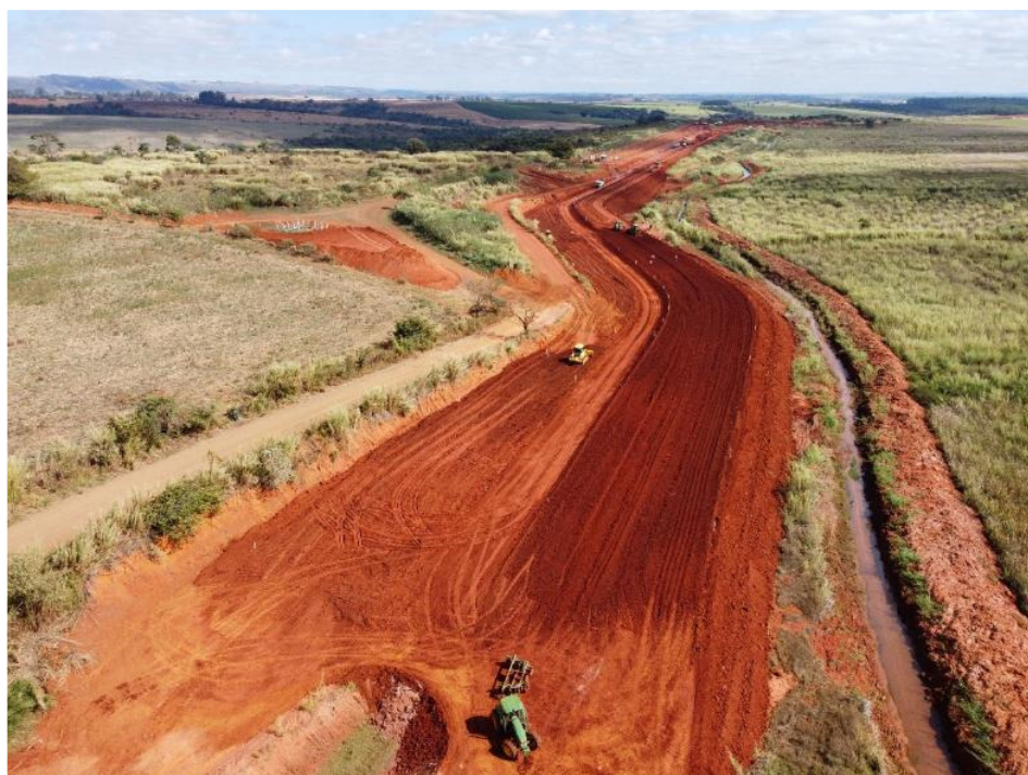
Figura 6.43 – avanço das escavações e aterro do canal periférico entre as estacas E43 e E101.
