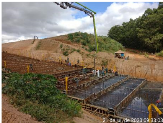
Figura 6.26 – Concretagem do piso do módulo 40.
