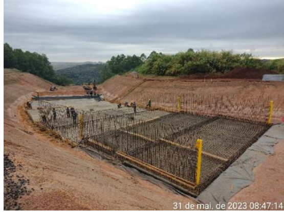
Figura 6.18 – frentes de ferragem e dreno de fundo – manta geotêxtil, brita #0 e magro fck 10 MPa.
