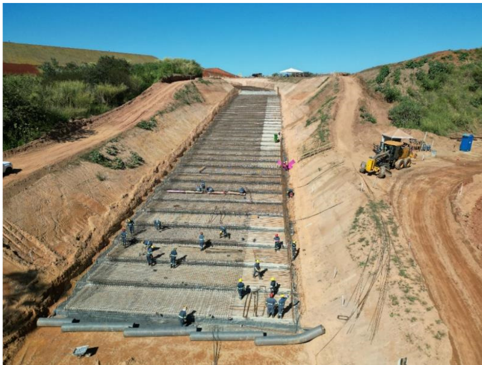
Figura 6.22 – instalação de ferragens no canal rápido, trecho liberado pela projetista.
