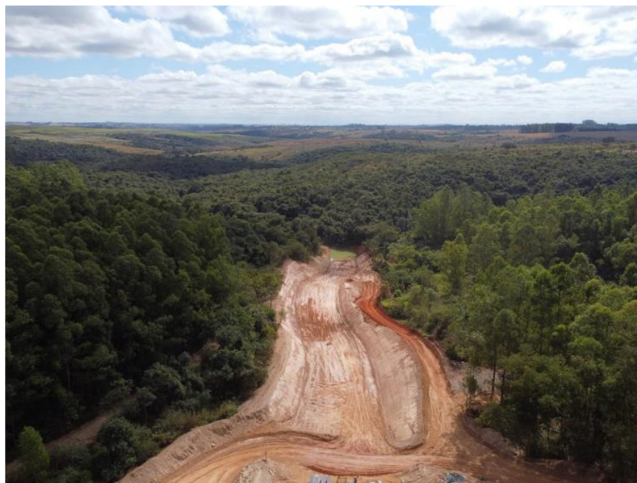
Figura 6.3 – conclusão da escavação no trecho mais a jusante do canal rápido.
