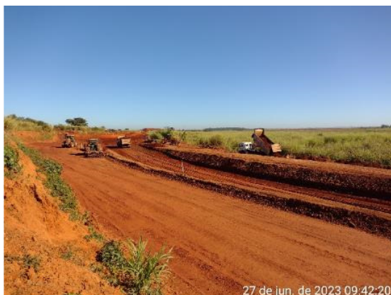
Figura 6.40 – avanço das escavações e aterro do canal periférico entre as estacas E43 e E101.
