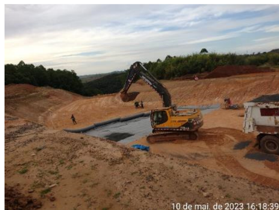
Figura 6.9 – instalação do dreno de fundo – geotêxtil brita #0.
