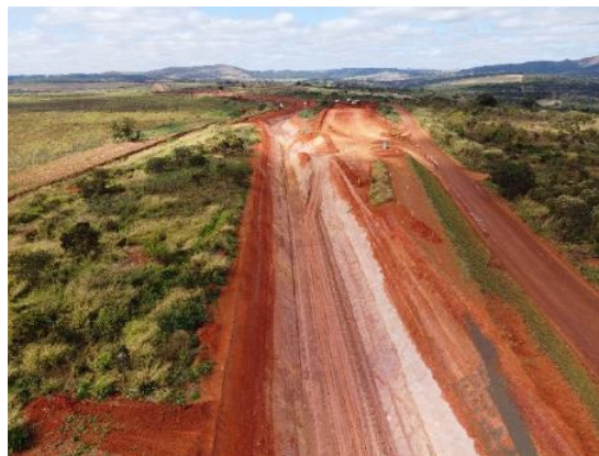
Figura 6.38 – avanço das escavações entre as estacas E101 e E135 – dique lateral barragem B5.
