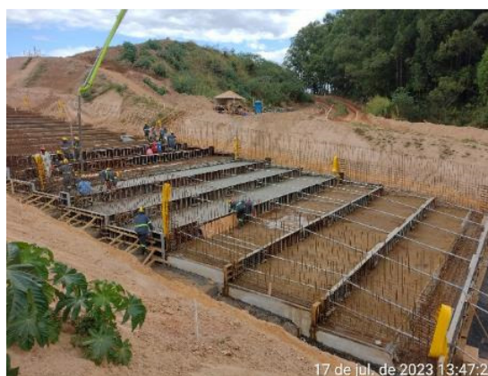
Figura 6.24 – Concretagem do piso do módulo 38.
