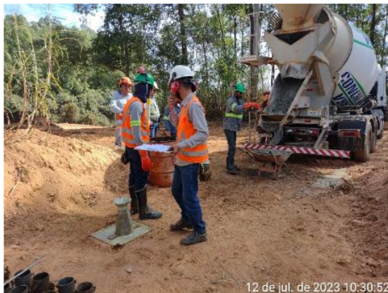
Figura 6.53 – coleta de amostras para ensaios de trabalhabilidade e resistência a compressão.
