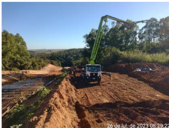
Figura 6.28 – Concretagem do piso do módulo 42 e montagem das formas de parede do módulo 38.
