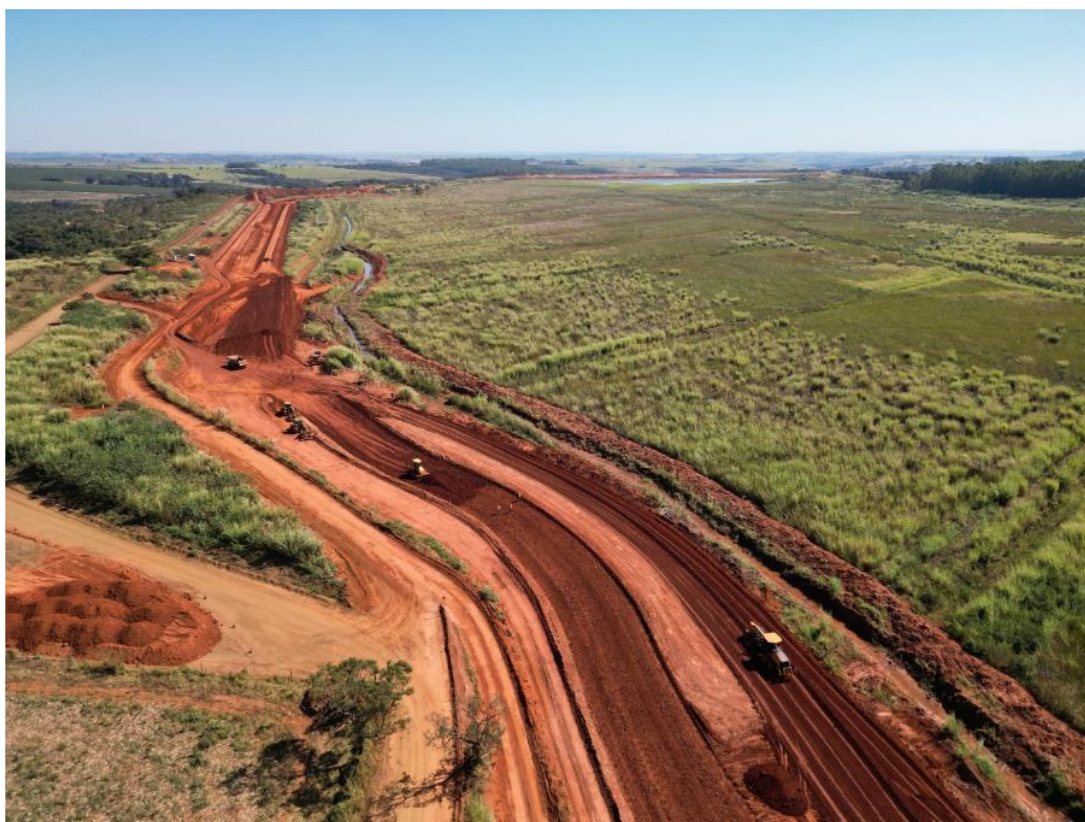
Figura 6.41 – avanço das escavações e aterro do canal periférico entre as estacas E43 e E101.
