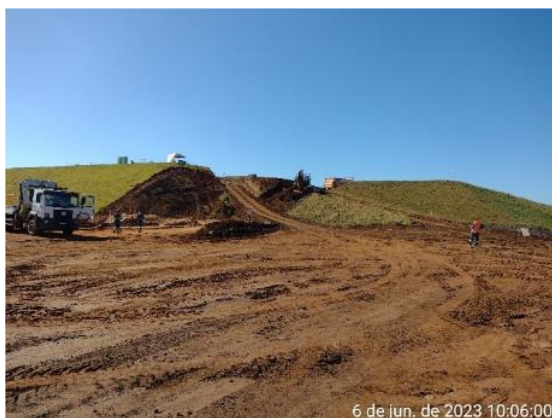
Figura 6.30 – início da escavação no maciço.
