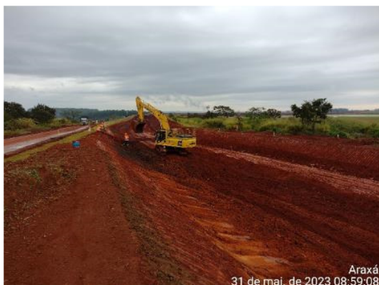
Figura 6.36 – avanço das escavações entre as estacas E135 e E171 – dique lateral barragem B5.
