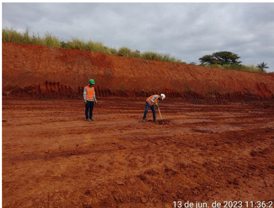
Figura 6.52 – Equipe de fiscalização de qualidade, cravação de cilindro.
