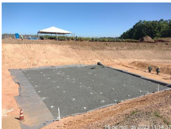
Figura 6.12 – instalação do dreno de fundo – preparação do trecho para recebimento de concreto magro 10 MPa.
