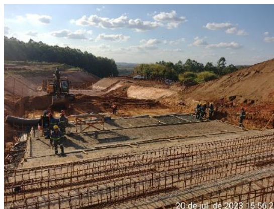
Figura 6.32 – Instalação de dreno de fundo e ferragem no maciço da B5.
