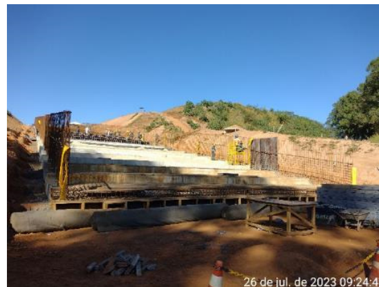
Figura 6.28 – Concretagem do piso do módulo 42 e montagem das formas de parede do módulo 38.
