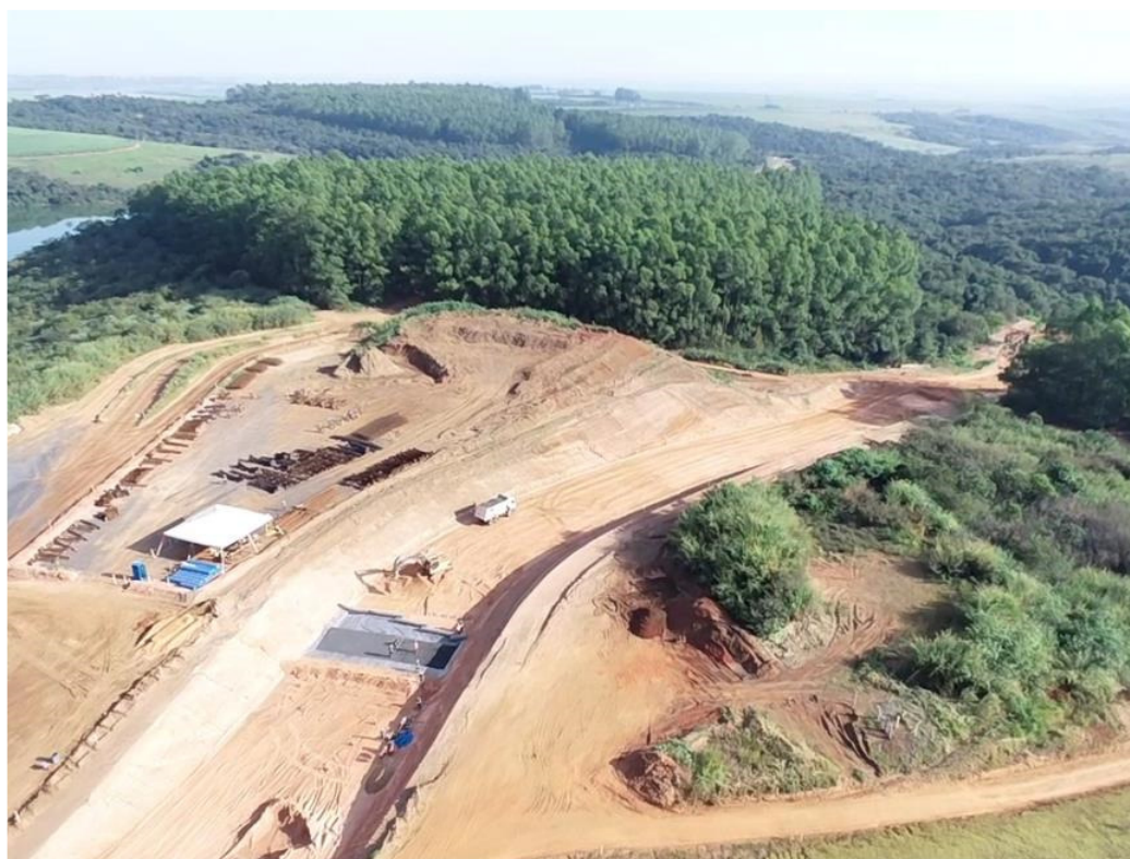
Figura 6.11 – instalação do dreno de fundo – geotêxtil brita #0.
