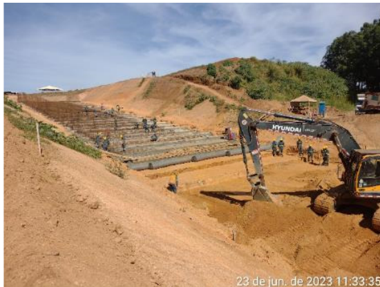
Figura 6.20 – frentes de ferragem e dreno de fundo – manta geotêxtil, brita #0 e magro fck 10 MPa.
