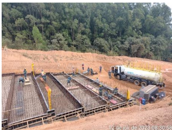
Figura 6.23 – Concretagem do piso do módulo 37.
