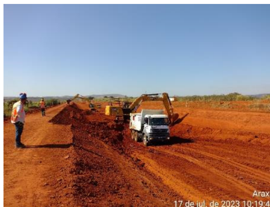
Figura 6.40 – avanço das escavações e aterro do canal periférico entre as estacas E43 e E101.
