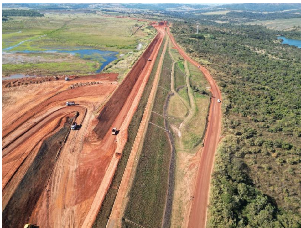
Figura 6.23 – Escavação do emboque.
