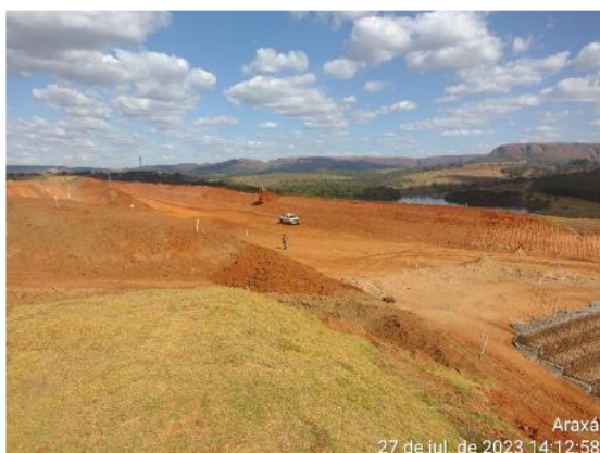
Figura 6.49 – preparação de trecho de transição para recebimento de dreno de fundo, magro, ferragem e concretagem.
