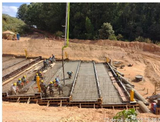
Figura 6.23 – Concretagem do piso do módulo 37.
