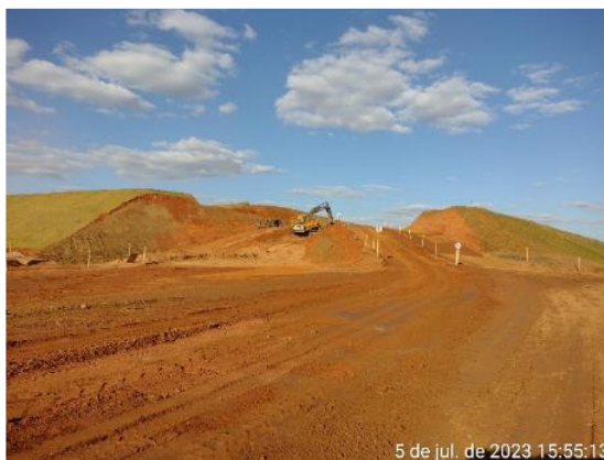
Figura 6.32 – Início da escavação dos degraus no maciço.
