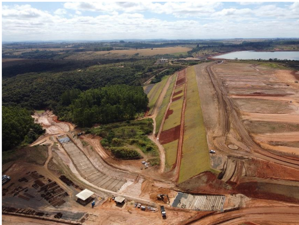
Figura 6.34 – Instalação do canal rápido no maciço da B5.
