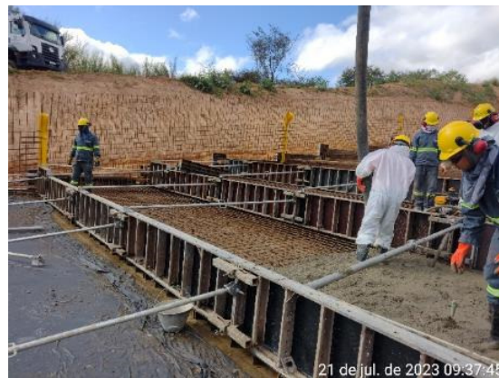
Figura 6.26 – Concretagem do piso do módulo 40.
