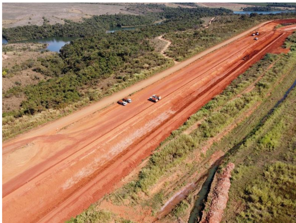
Figura 6.42 – avanço das escavações e aterro do canal periférico entre as estacas E43 e E101.
