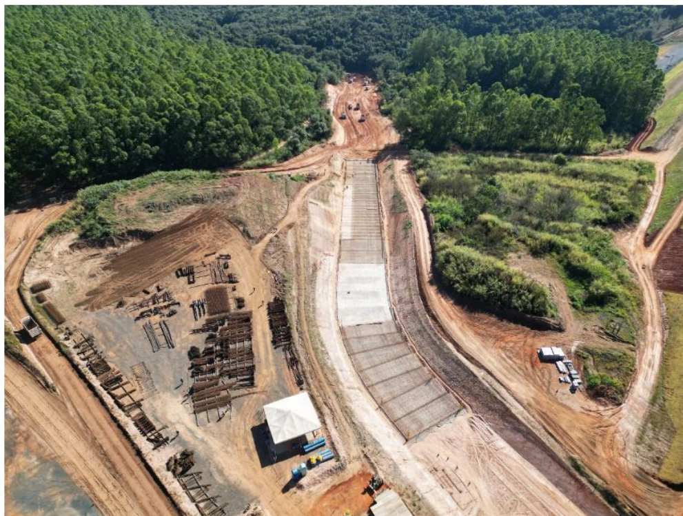
Figura 6.21 – instalação de ferragens no canal rápido, trecho liberado pela projetista.
