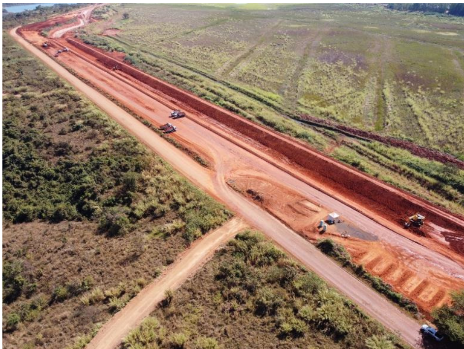
Figura 6.47 – avanço das escavações e aterro do canal periférico entre as estacas E43 e E101
