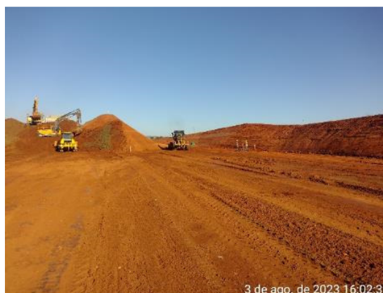
Figura 6.49 – preparação de trecho de transição para recebimento de dreno de fundo, magro, ferragem e concretagem.
