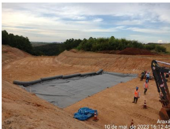
Figura 6.9 – instalação do dreno de fundo – geotêxtil brita #0.
