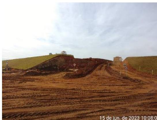
Figura 6.30 – início da escavação no maciço.
