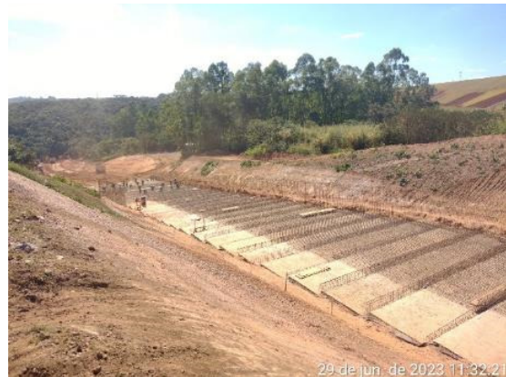
Figura 6.20 – frentes de ferragem e dreno de fundo – manta geotêxtil, brita #0 e magro fck 10 MPa.
