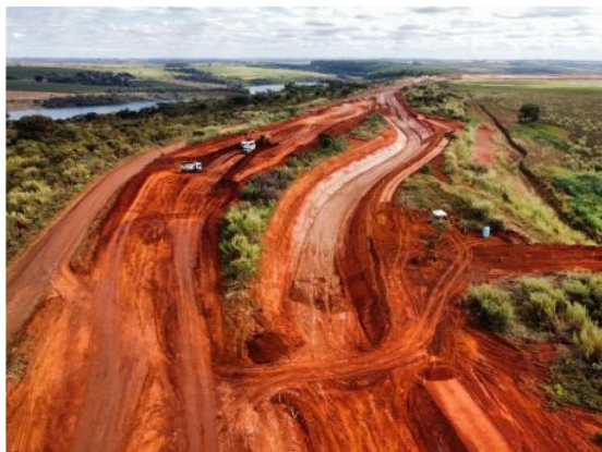
Figura 6.38 – avanço das escavações entre as estacas E101 e E135 – dique lateral barragem B5.
