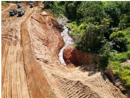
Figura 6.7 – Execução de acesso ao trecho mais a jusante do canal rápido – instalação de dreno trapezoidal em brita #2 e manta geotêxtil.
