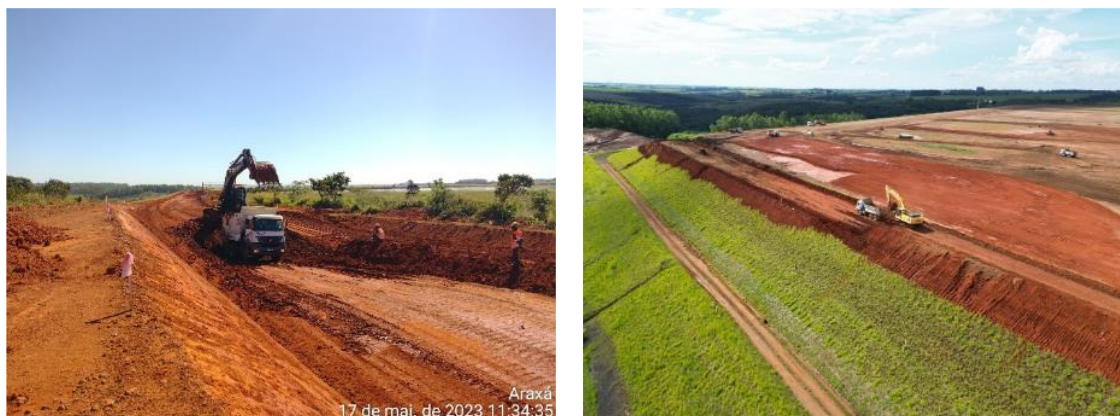
Figura 6.35 – avanço das escavações entre as estacas E135 e E171 – dique lateral barragem B5.
