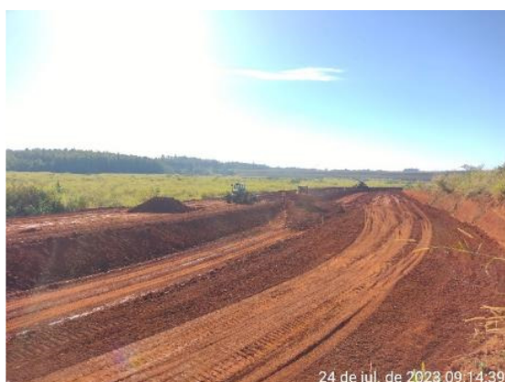
Figura 6.45 – avanço das escavações e aterro do canal periférico entre as estacas E43 e E101.
