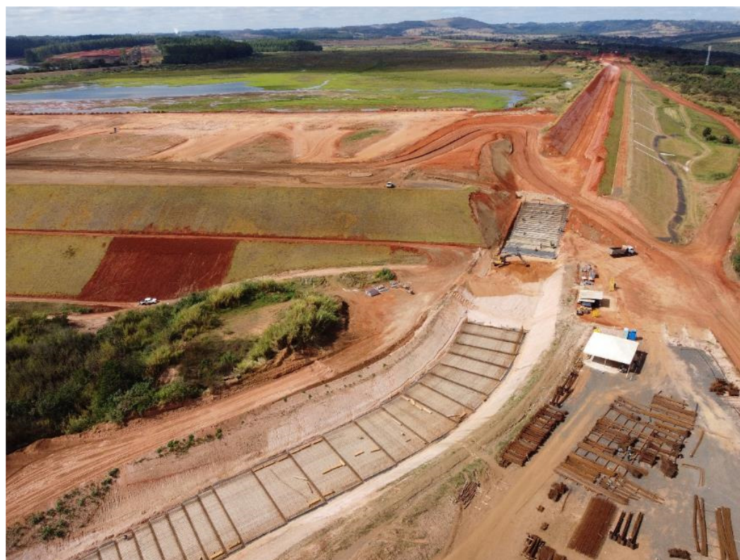
Figura 6.33 – Instalação do canal rápido no maciço da B5.
