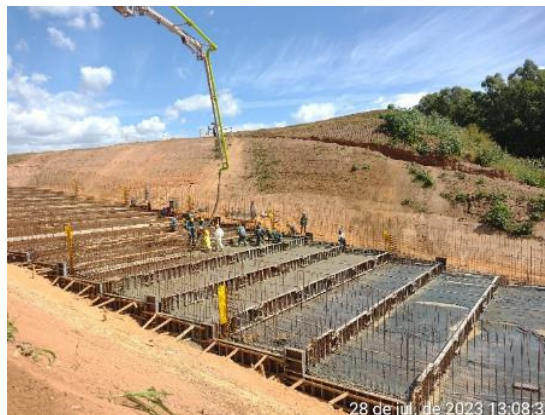
Figura 6.29 – Concretagem do piso do módulo 43.
