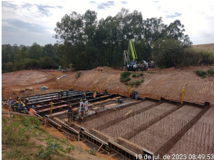
19 de jul. de 2023 08:49:53 Figura 6.25 – Concretagem do piso do módulo 39.
