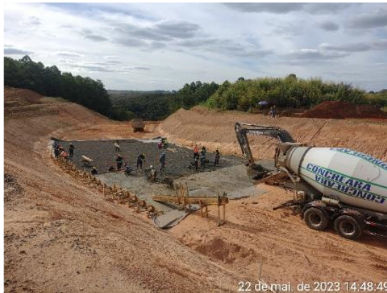
Figura 6.16 – aplicação de concreto magro (Fck 10 Mpa) para abertura de frente de instalação de ferragens.
