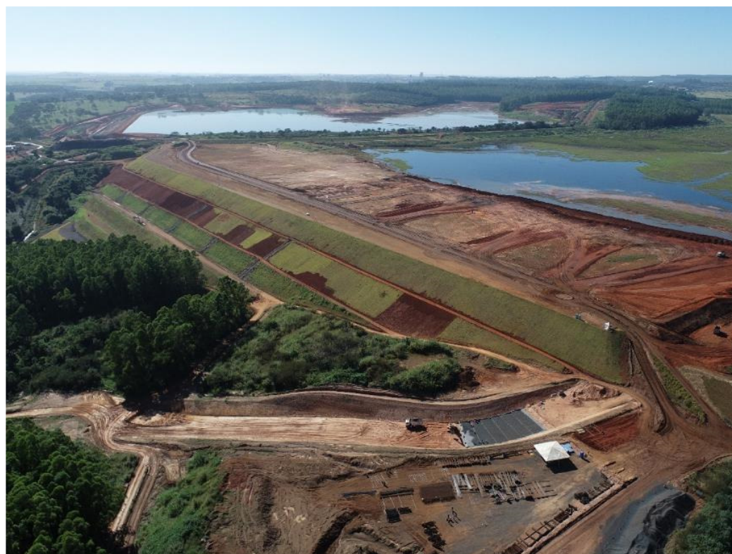
Figura 6.13 – avanço da instalação do dreno de fundo.
