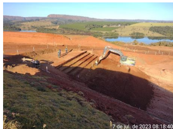
Figura 6.32 – Início da escavação dos degraus no maciço.
