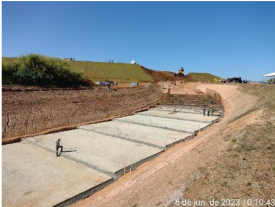
Figura 6.19 – frentes de ferragem e dreno de fundo – manta geotêxtil, brita #0 e magro fck 10 MPa.
