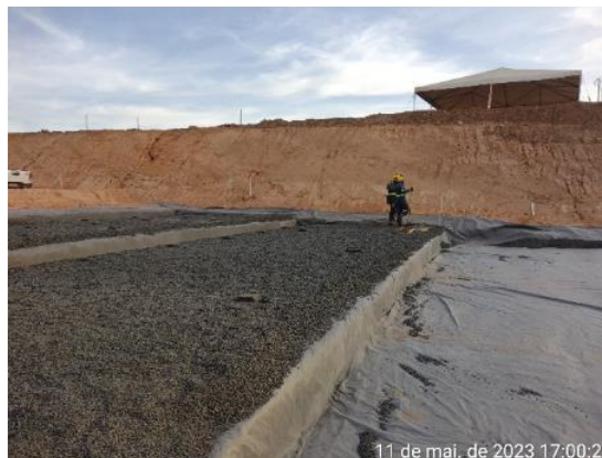
Figura 6.10 – instalação do dreno de fundo – geotêxtil brita #0.
