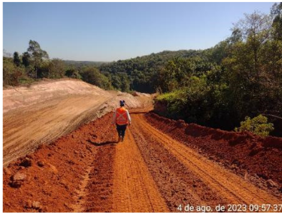
Figura 6.8 – Execução de forro em argila do acesso lateral ao trecho mais a jusante do canal rápido.
