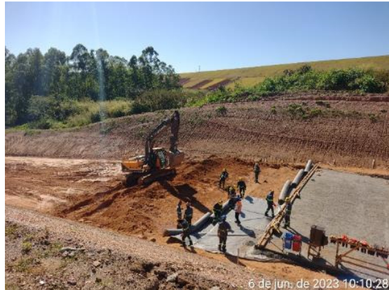
Figura 6.19 – frentes de ferragem e dreno de fundo – manta geotêxtil, brita #0 e magro fck 10 MPa.
