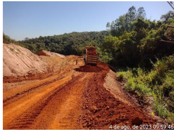
Figura 6.8 – Execução de forro em argila do acesso lateral ao trecho mais a jusante do canal rápido.
