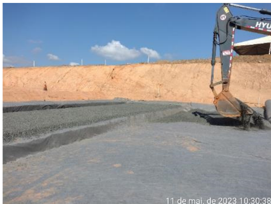
Figura 6.10 – instalação do dreno de fundo – geotêxtil brita #0.
