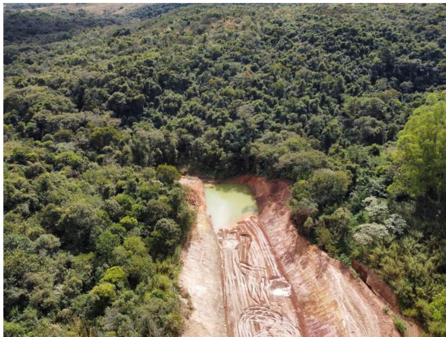
Figura 6.4 – conclusão da escavação no trecho mais a jusante do canal rápido.
