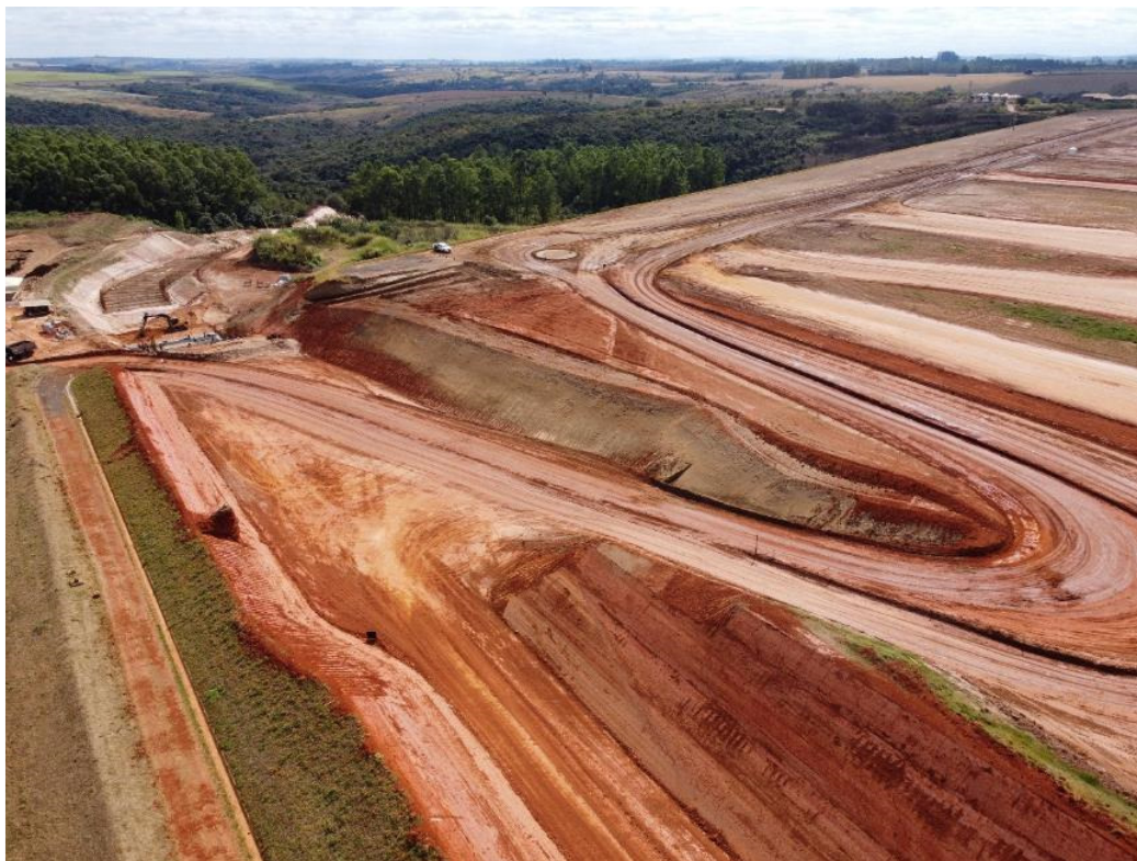
Figura 6.48 – escavação concluída no trecho de transição.
