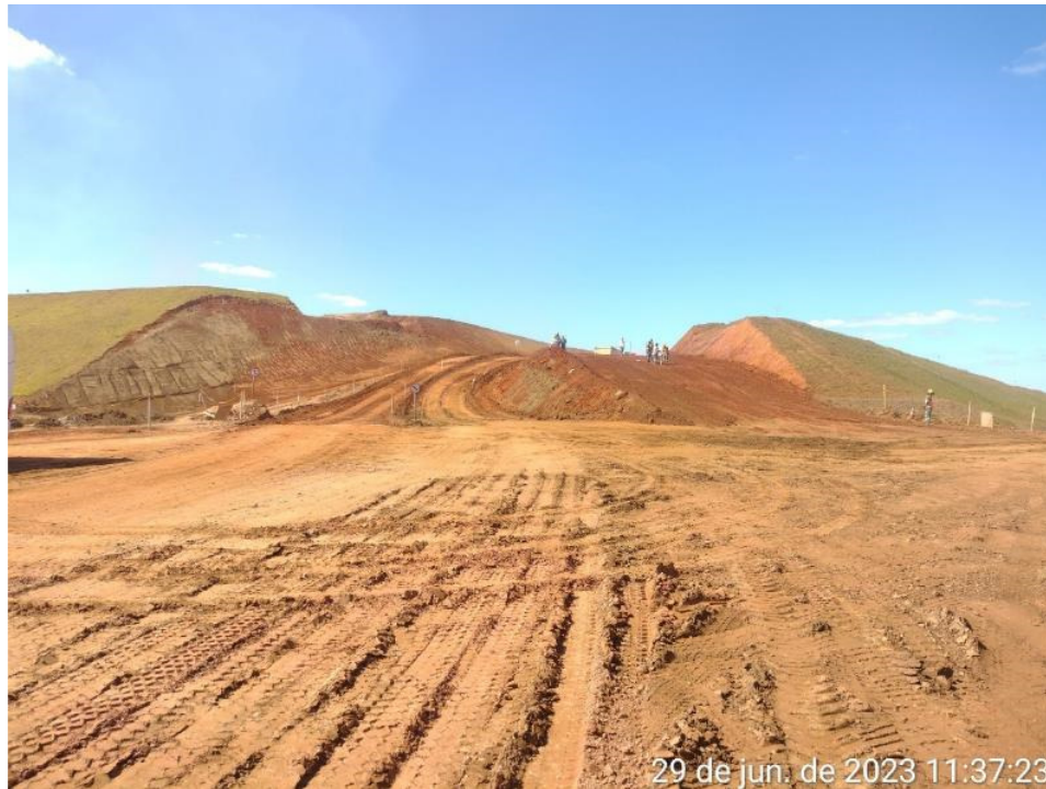
Figura 6.31 – Escavação do maciço para instalação do canal rápido.
