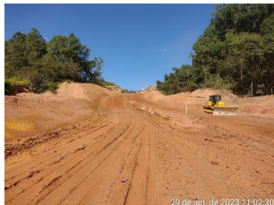
Figura 6.1 – retomada e avanço das escavações do canal rápido, sentido jusante.
