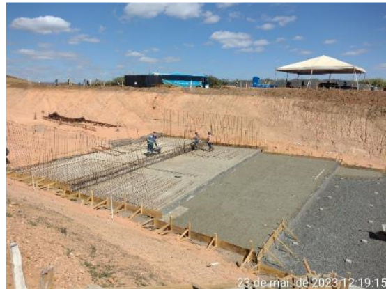
Figura 6.16 – aplicação de concreto magro (Fck 10 Mpa) para abertura de frente de instalação de ferragens.
