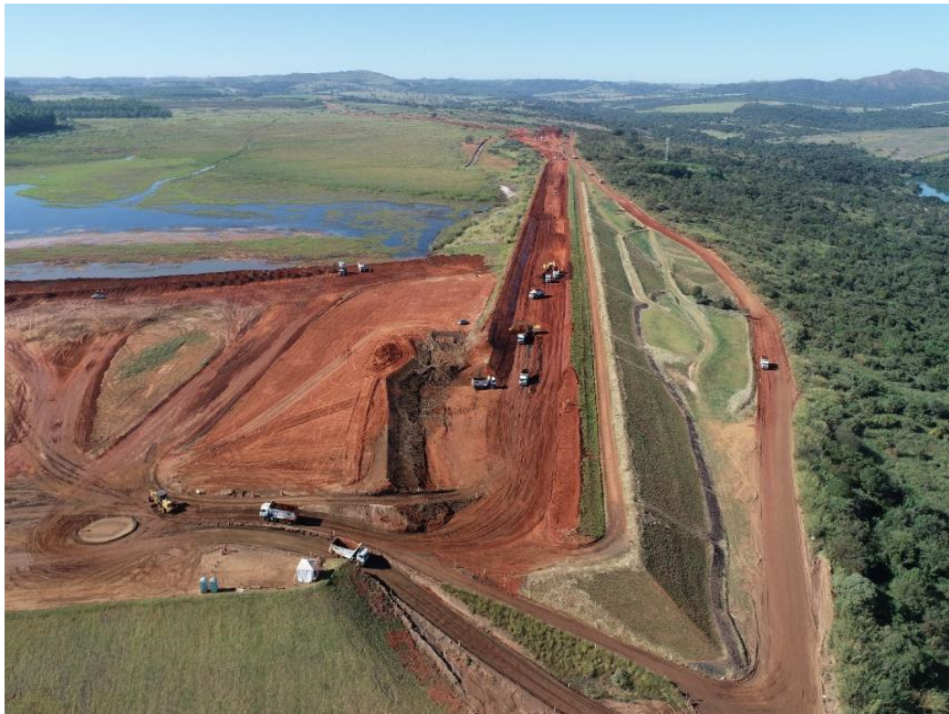
Figura 6.15 – Escavação do emboque – trecho transição entre os canais rápido, periférico e do reservatório.
