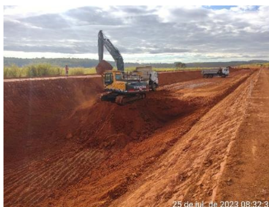
Figura 6.45 – avanço das escavações e aterro do canal periférico entre as estacas E43 e E101.
