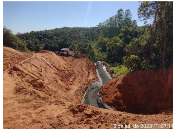
Figura 6.7 – Execução de acesso ao trecho mais a jusante do canal rápido – instalação de dreno trapezoidal em brita #2 e manta geotêxtil.
