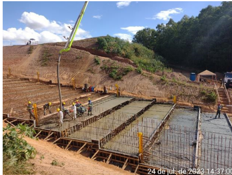
Figura 6.27 – Concretagem do piso do módulo 41.
