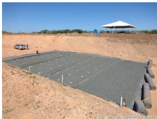
Figura 6.12 – instalação do dreno de fundo – preparação do trecho para recebimento de concreto magro 10 MPa.
