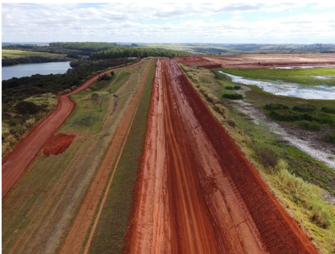
Figura 6.39 – conclusão das escavações no dique lateral barragem B5.
