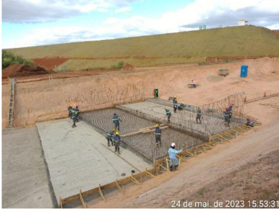
Figura 6.18 – frentes de ferragem e dreno de fundo – manta geotêxtil, brita #0 e magro fck 10 MPa.
