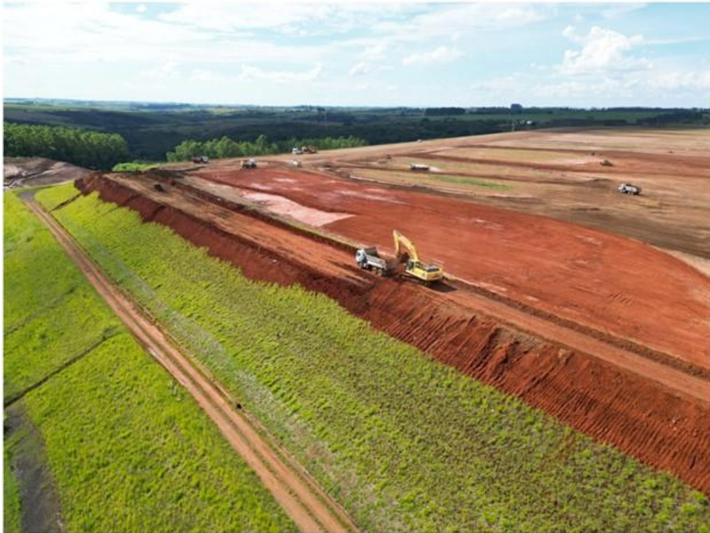
Figura 6.14 – Escavação na ombreira esquerda no trecho do canal periférico.
