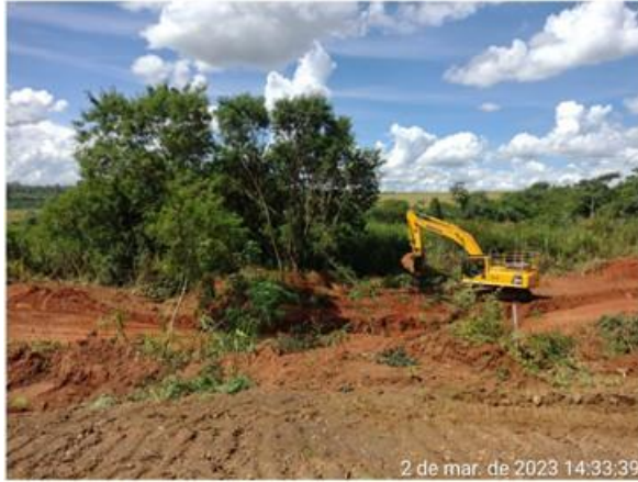
Figura 6.12 – Supressão e remoção de camada vegetal no trecho do canal periférico.
