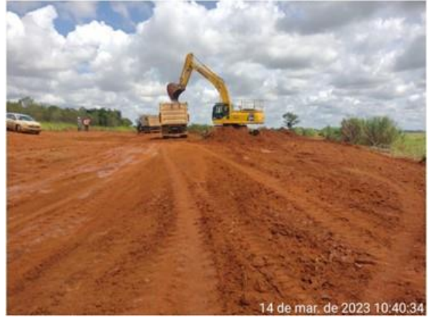
Figura 6.12 – Supressão e remoção de camada vegetal no trecho do canal periférico.
