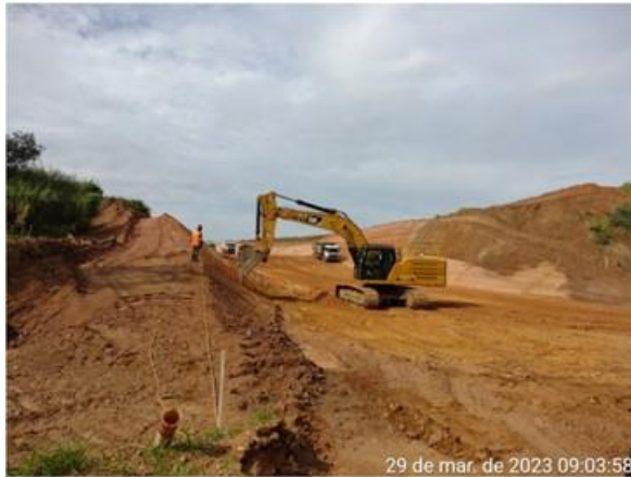
Figura 6.6 – Escavação do canal rápido em trecho entre as estacas E179 e E190.
