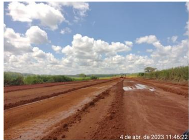
Figura 6.13 – Supressão e remoção de camada vegetal no trecho do canal periférico.
