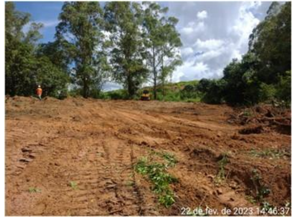
Figura 6.3 – Supressão vegetal e remoção de camada vegetal do trecho do canal rápido.
