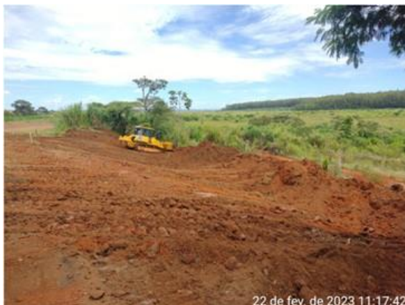
Figura 6.11 – Supressão e remoção de camada vegetal no trecho do canal periférico.
