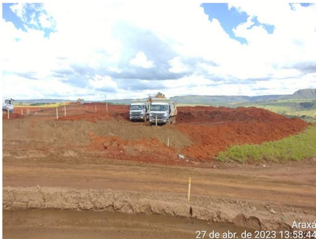
Figura 6.15 – Escavação no trecho de transição entre os canais periférico e rápido.
