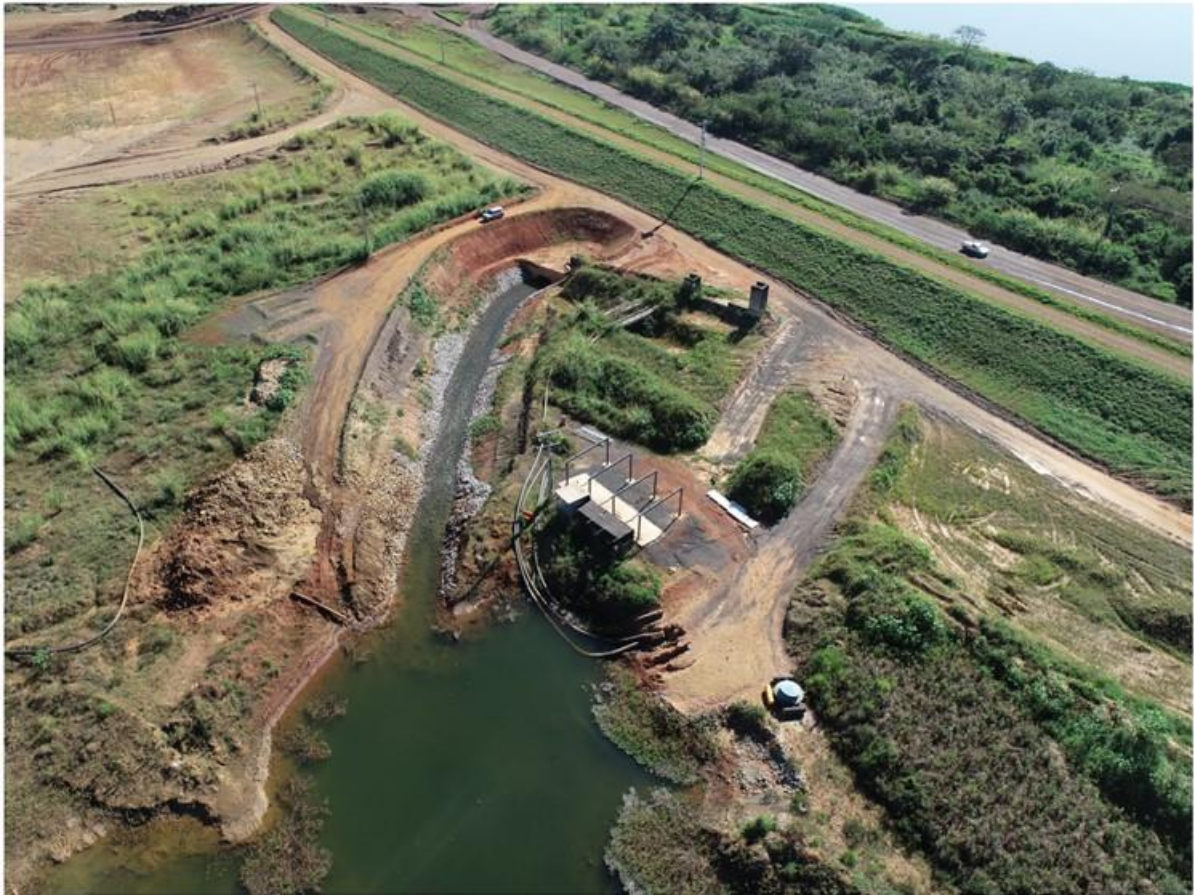
Figura 6.10 – canal de aproximação executado na ombreira direita pela construtora CIMCOP.
