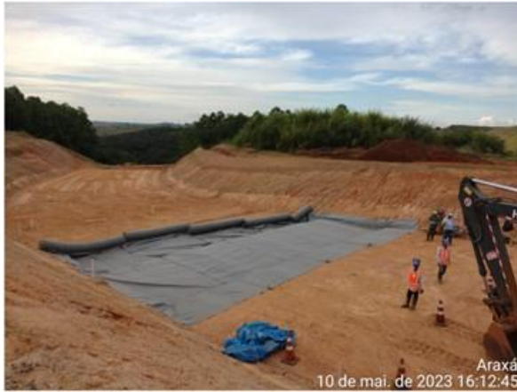
Figura 6.8 – Início da instalação do sistema drenante do canal rápido.
