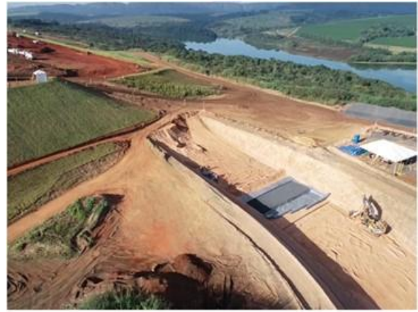
Figura 6.8 – Início da instalação do sistema drenante do canal rápido.
