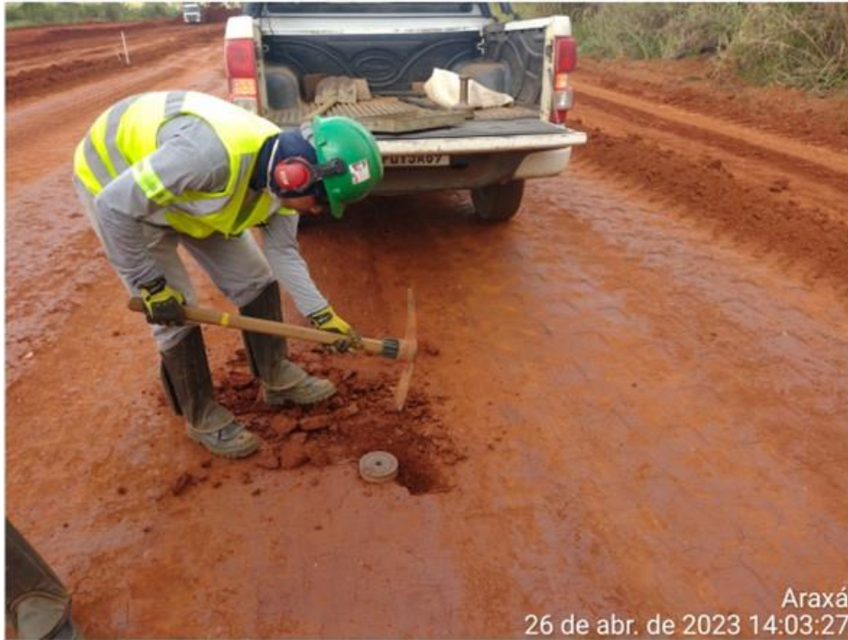
Figura 6.2.2 – Equipe de fiscalização de qualidade, cravação de cilindro.
