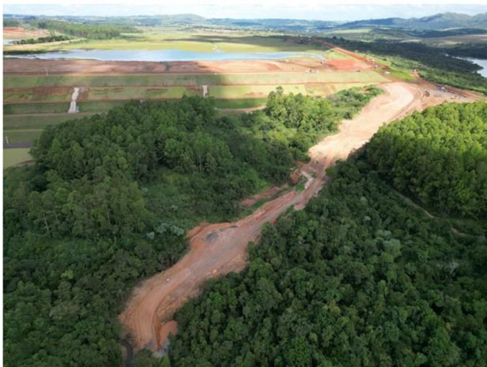
Figura 6.7 – Trecho do canal rápido e bacia de dissipação em processo de escavação.
