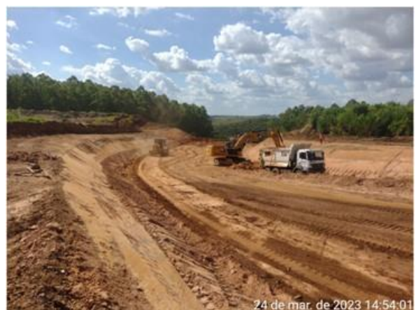
Figura 6.5 – Escavação do canal rápido em trecho entre as estacas E179 e E190.
