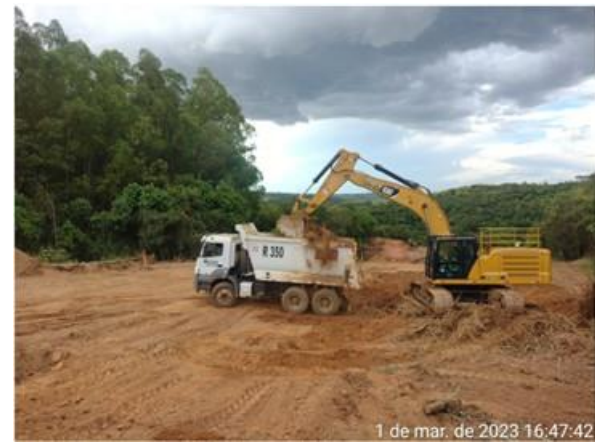
Figura 6.4 – Supressão vegetal e remoção de camada vegetal do trecho do canal rápido.
