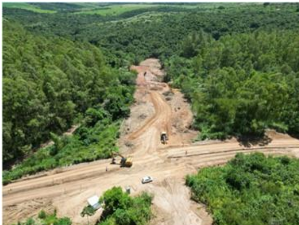
Figura 6.4 – Supressão vegetal e remoção de camada vegetal do trecho do canal rápido.
