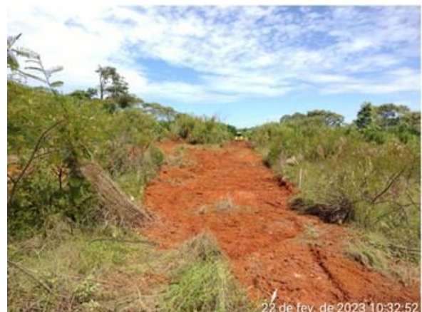
Figura 6.11 – Supressão e remoção de camada vegetal no trecho do canal periférico.
