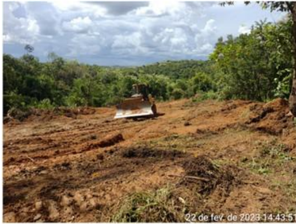
Figura 6.3 – Supressão vegetal e remoção de camada vegetal do trecho do canal rápido.
