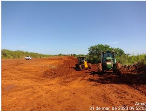
Figura 6.13 – Supressão e remoção de camada vegetal no trecho do canal periférico.
