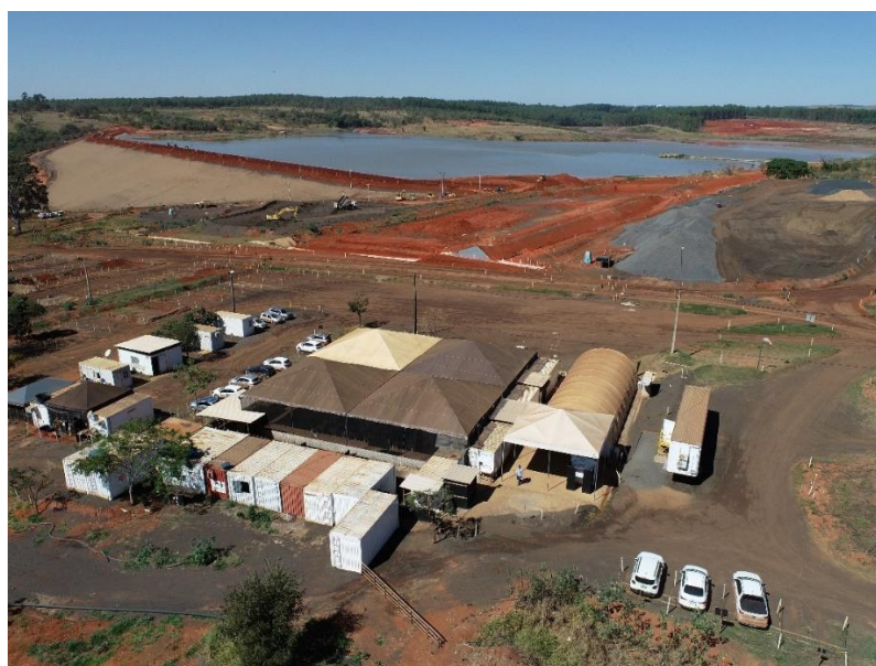
Figura 5.1.1 – Canteiro de obras Consórcio Nóbrega & Pavidez
