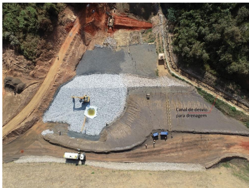
Figura 5.1.5 – Vista aérea da fundação da barragem B5
