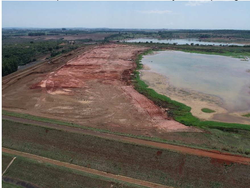
Figura 5.1.16 – Corte e regularização da praia da barragem b5 para elevação 964,50 m
