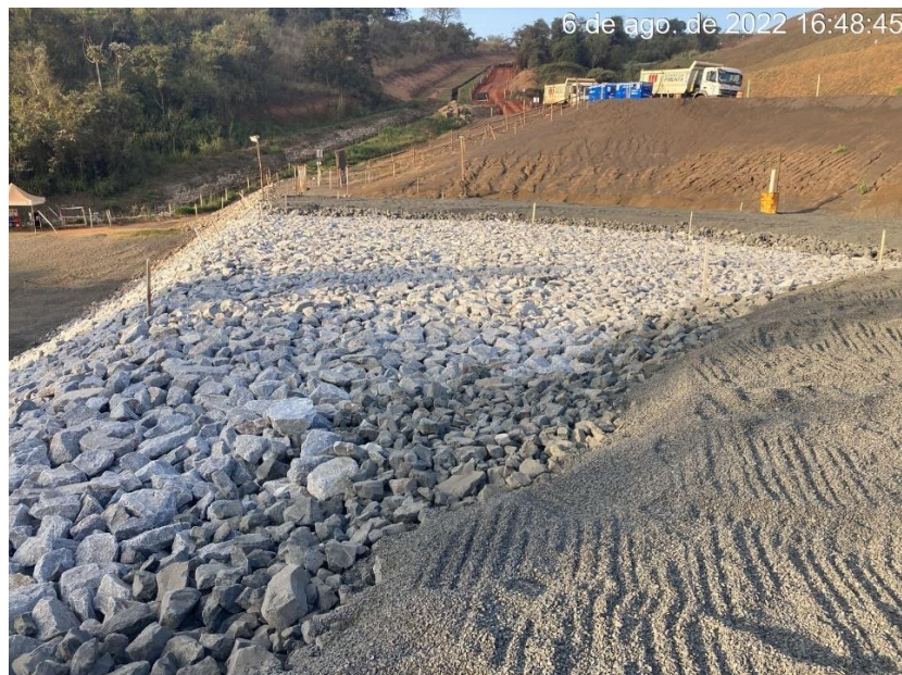
Figura 5.1.9 – Vista aérea da fundação da barragem B5
