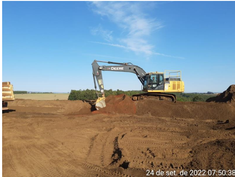
24 de set. de 2022 07:50:38 Figura 5.1.17 – Escavação do maciço da barragem b5 para elevação 964,50 m
