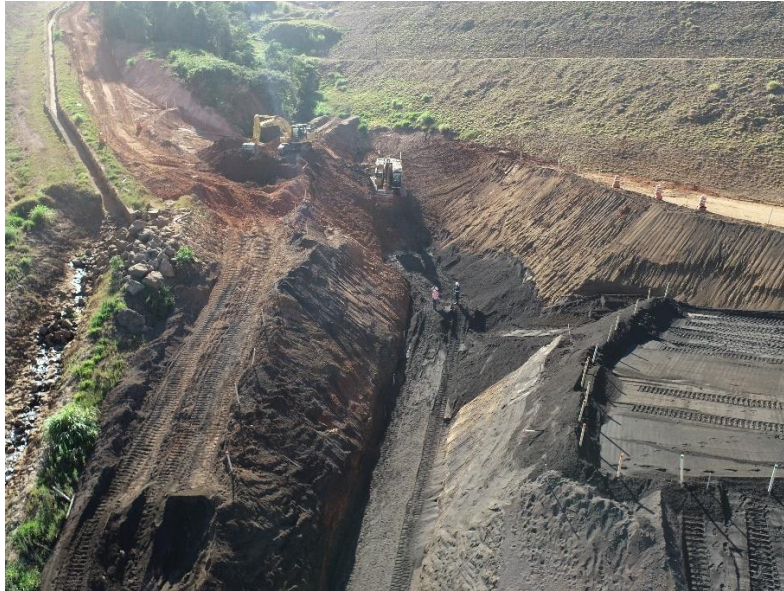
Figura 5.1.11 – Abertura de trincheira para remoção de solo mole encontrado na ombreira direita
