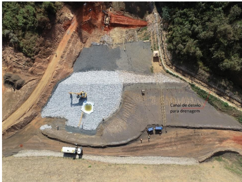
Figura 5.1.6 – Vista aérea da fundação da barragem B5
