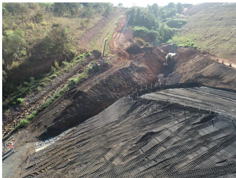
Figura 5.1.12 – Abertura de trincheira para remoção de solo mole encontrado na ombreira direita
