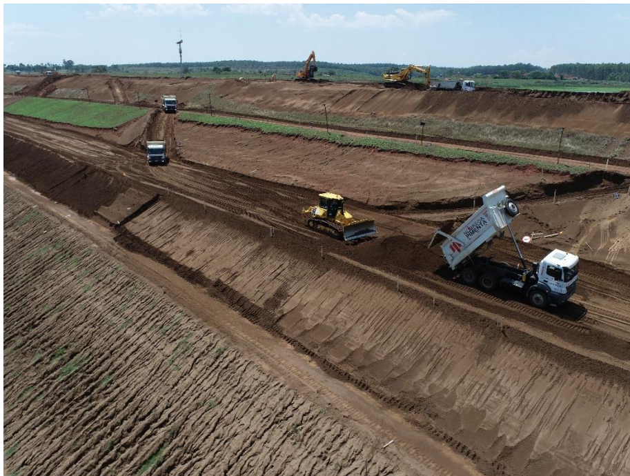
Figura 5.1.18 – Lançamento, espalhamento e compactação de rejeito
