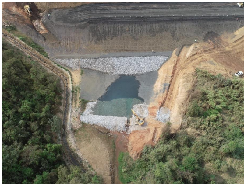
Figura 5.1.7 – Vista aérea da fundação da barragem B5
