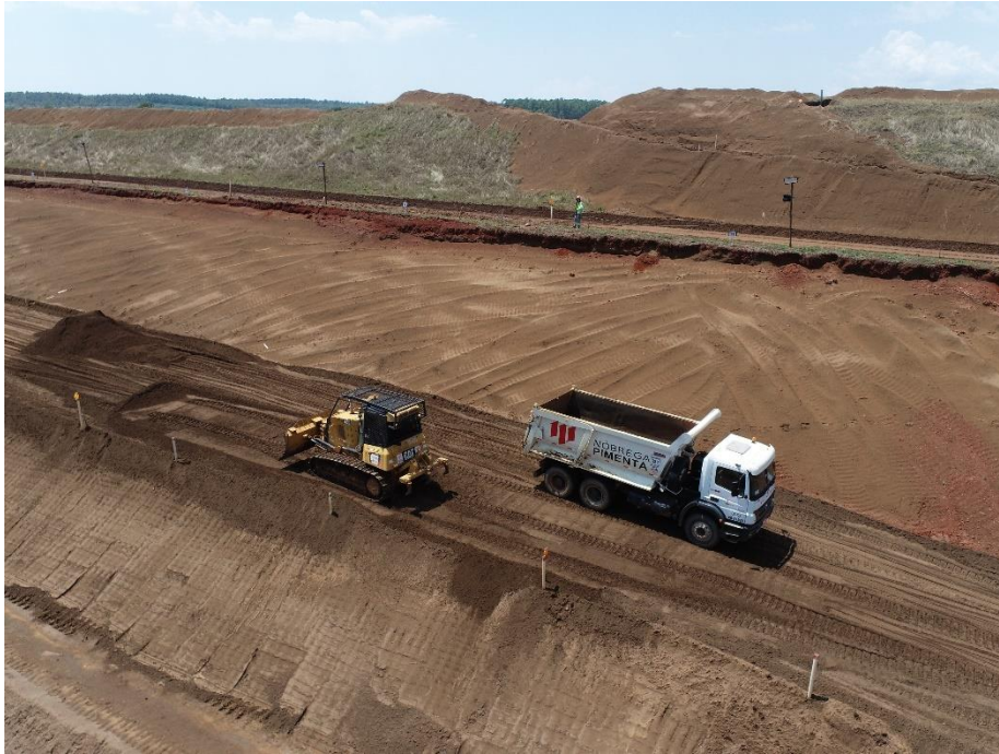
Figura 5.1.19 – Lançamento, espalhamento e compactação de rejeito
