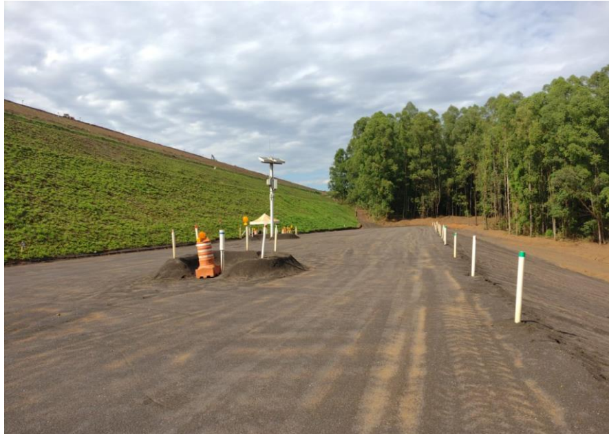
Figura 5.1.15 – Praça de aterro em rejeito de magnetita
