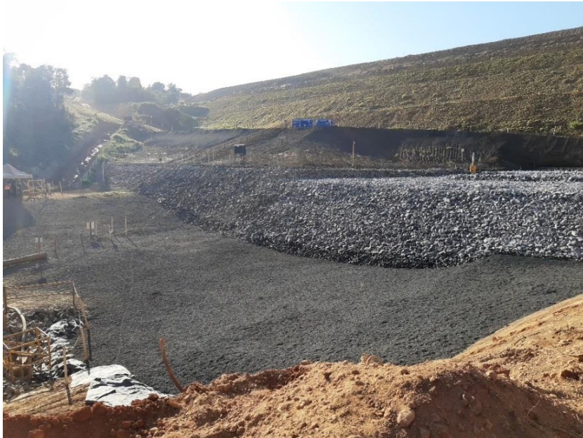
Figura 5.1.8 – Fundação da fundação da barragem B5
