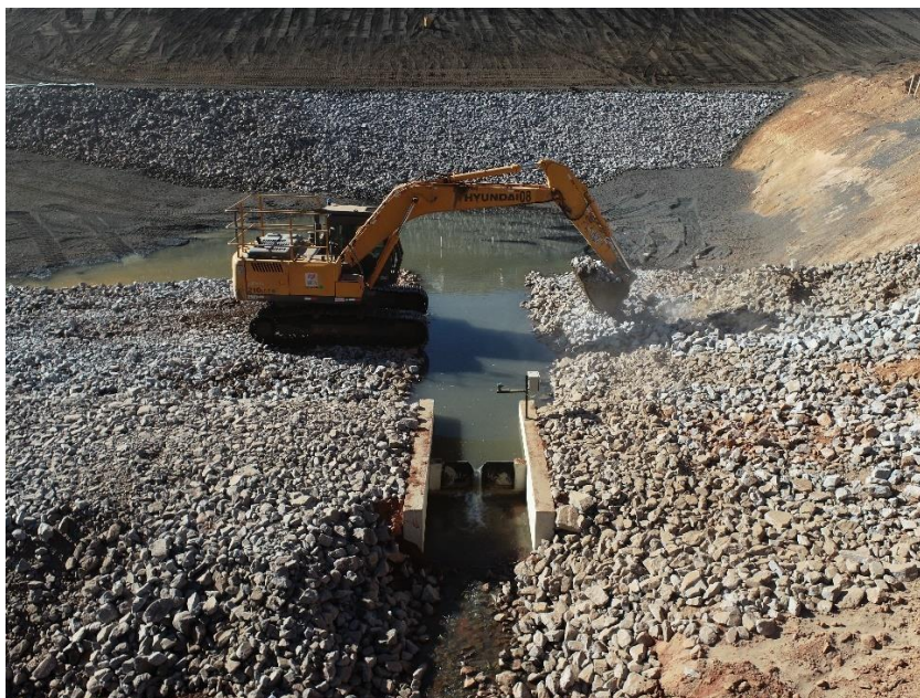
Figura 5.1.10 – Conclusão do medidor de vazão localizado no pé da barragem B5
