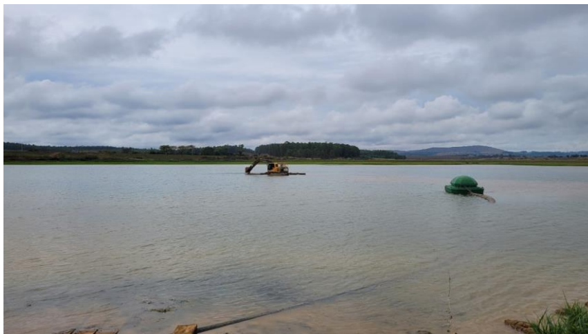
Figura 5.1.3 – Sistema de drenagem secundário do reservatório da barragem B5
