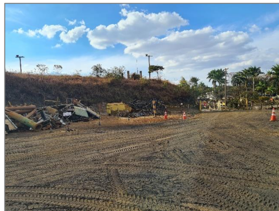
Foto 6.32 – Resíduos não perigosos armazenados em solo não pavimentado.
