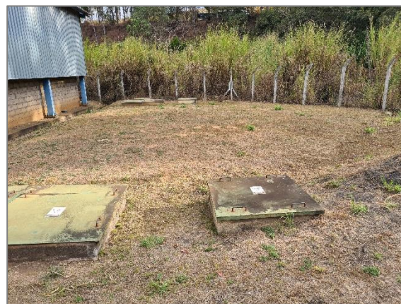
Foto 6.37 – Caixas de contenção.
