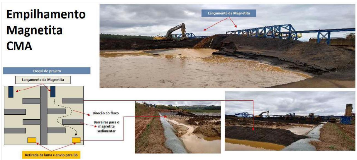
Figura 4.9 – Testes realizados com a magnetita do Complexo Minerquímico de Araxá (CMA).
