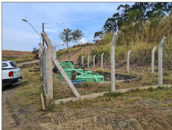
Foto 6.38 – Visão geral da ETE Central.
