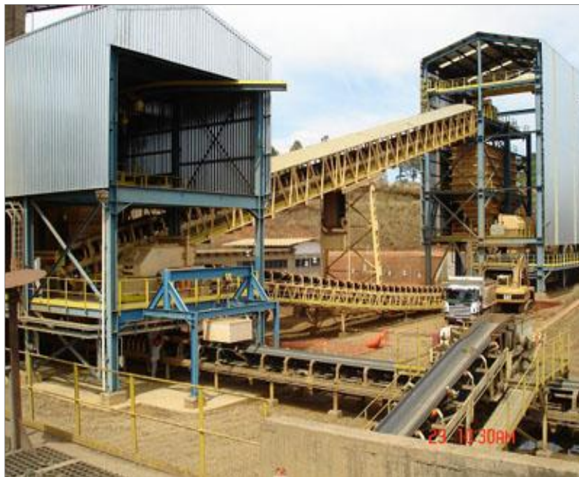
Foto 5.4 – Britagem secundária de minério do CMT.
