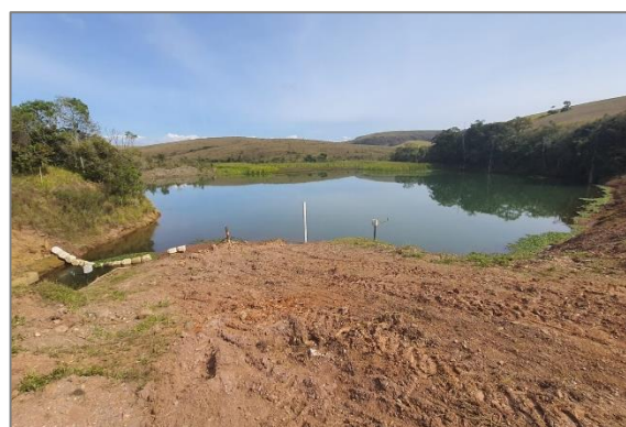
Foto 6.116 – Ponto 4, Barragem BA3.
