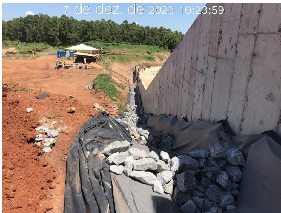
Figura 7.44 – Proteção dos drenos laterais do canal rápido (07/12/2023).
