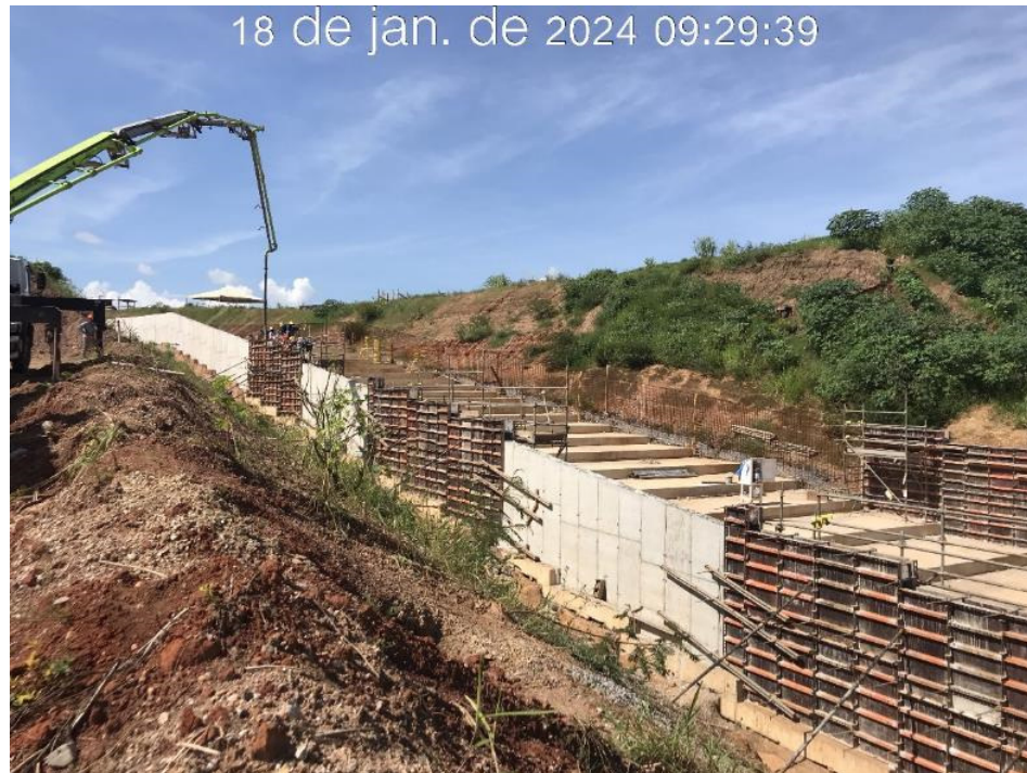
Figura 7.24 Concretagem das paredes do canal rápido, entre os módulos 40 e 44, com vista para montante (18/01/2024).
