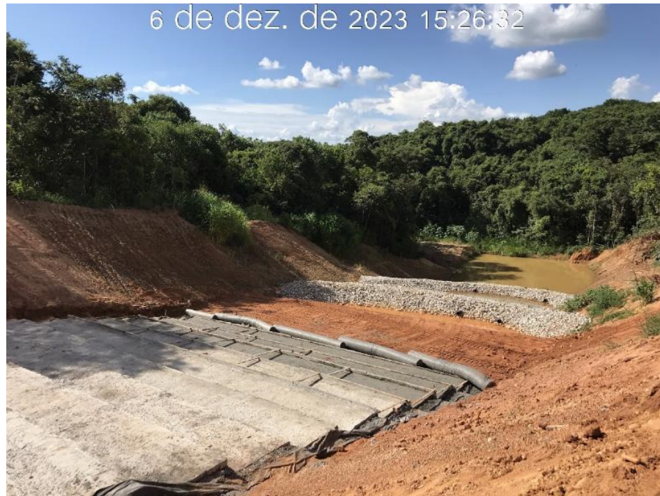
Figura 7.40 – Aplicação de concreto magro até a região da bacia de dissipação (06/12/2023).
