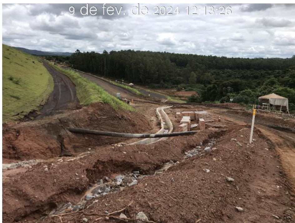
Figura 7.38 – Vista para jusante do canal de drenagem superficial da ombreira direita (09/02/2024).
