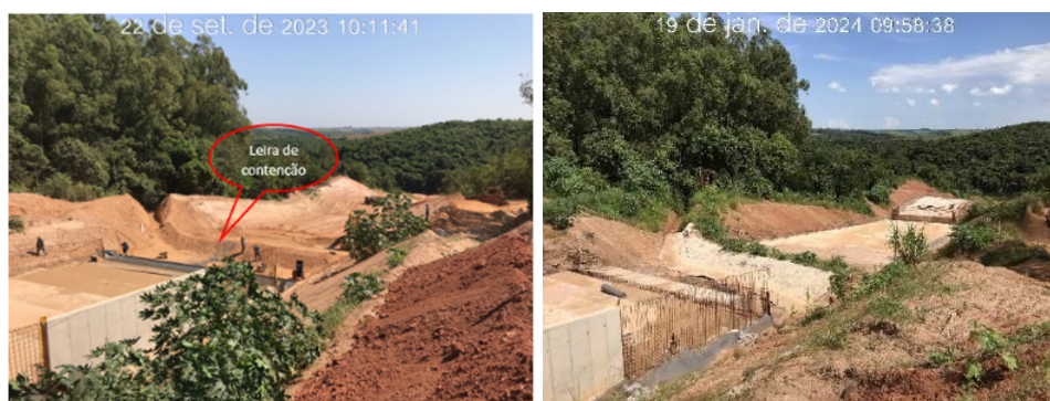
Figura 7.45 – Proteção da leira de contenção com concreto estrutural, executada no módulo 36 do canal periférico (19/01/2024).
