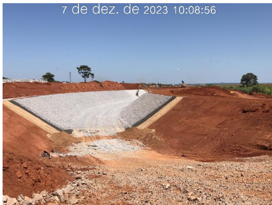
Figura 7.11 – Aplicação das transições 1, 2 e 3 no canal periférico, entre as estacas 105 e 115, com vista para jusante (07/12/2023).
