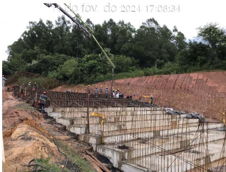
Figura 7.31 – Concretagem do módulo 19 do canal rápido, com vista para montante (14/02/2024).
