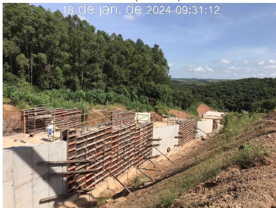
Figura 7.25 – Concretagem das paredes do canal rápido, entre os módulos 40 e 44, com vista para jusante (18/01/2024).
