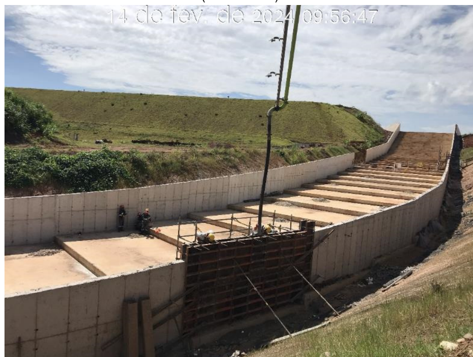
Figura 7.29 – Vista para montante do canal rápido, com detalhe da concretagem do módulo 53 (14/02/2024).
