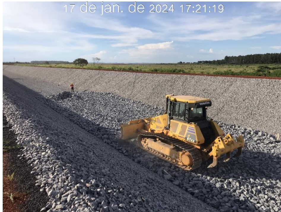
Figura 7.12 – Aplicação da camada de proteção (enrocamento) no canal periférico, na região da estaca 70 (17/01/2024).
