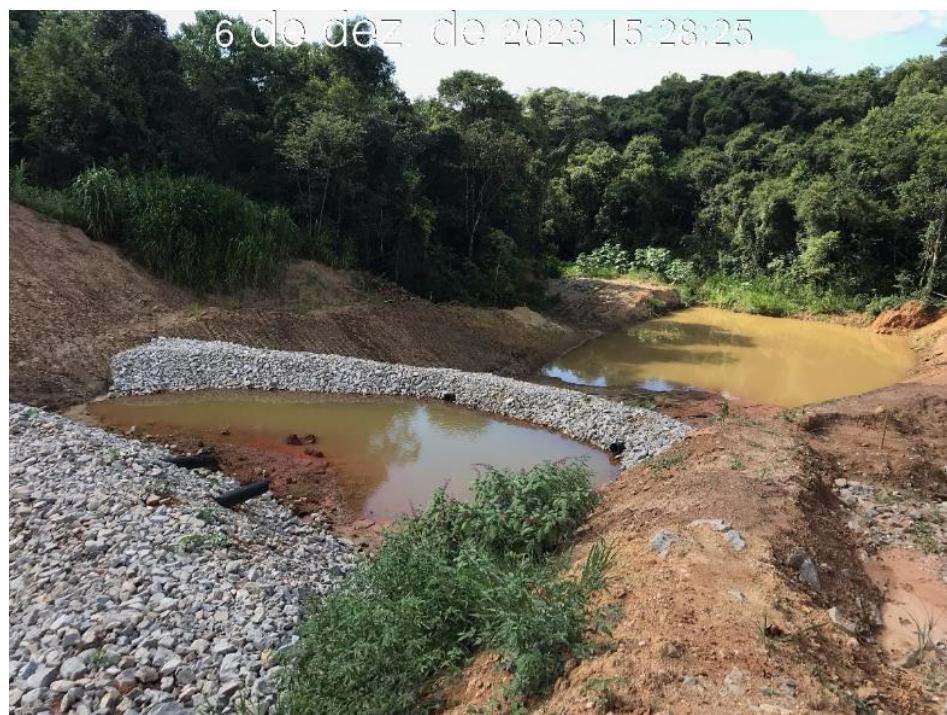
Figura 7.41 – Proteção da bacia de dissipação com diques em enrocamento (06/12/2023).
