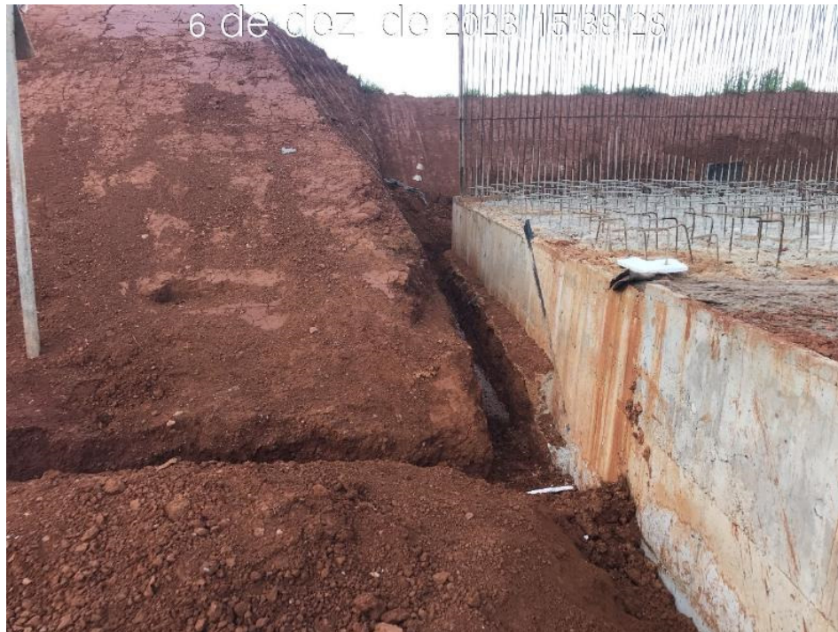
Figura 7.42 – Execução de valas de drenagem provisórias, na interligação do canal periférico com o canal rápido (06/12/2023).
