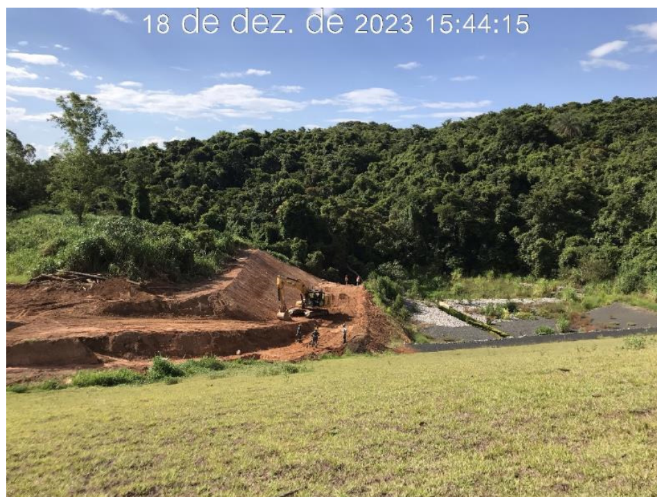
Figura 7.36 – Vista para jusante do canal superficial da ombreira esquerda (18/12/2023).
