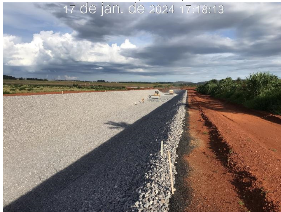
Figura 7.13 – Vista para montante do canal periférico, com detalhe da aplicação da camada de proteção (enrocamento), entre as estacas 60 e 80 (17/01/2024).
