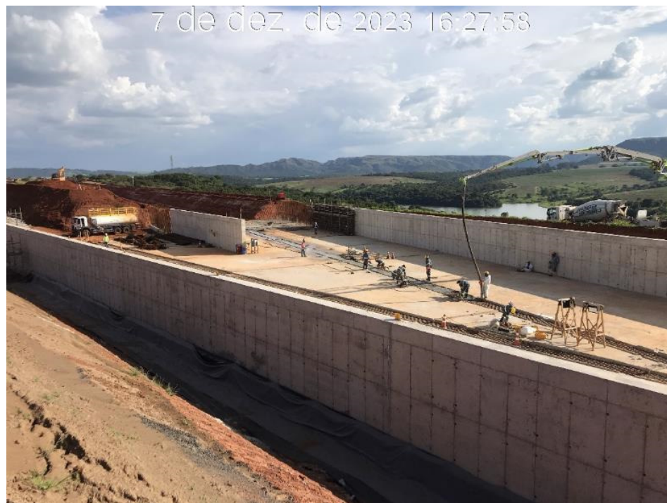
Figura 7.21 – Concretagem das juntas de dilatação do canal rápido, com vista para montante (07/12/2023).
