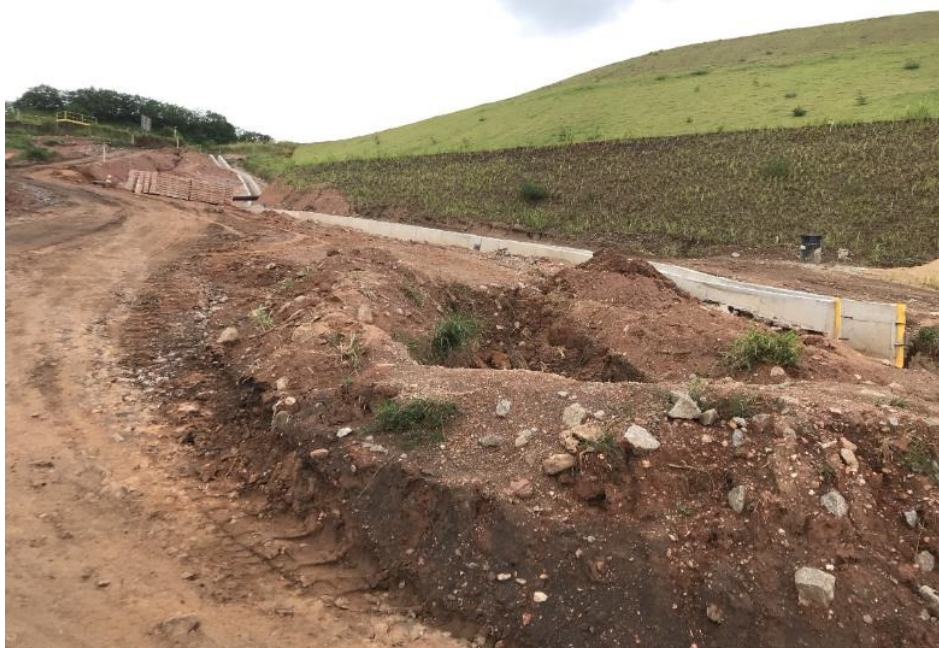
Figura 7.39 – Vista para montante do canal de drenagem superficial da ombreira direita (09/02/2024).
