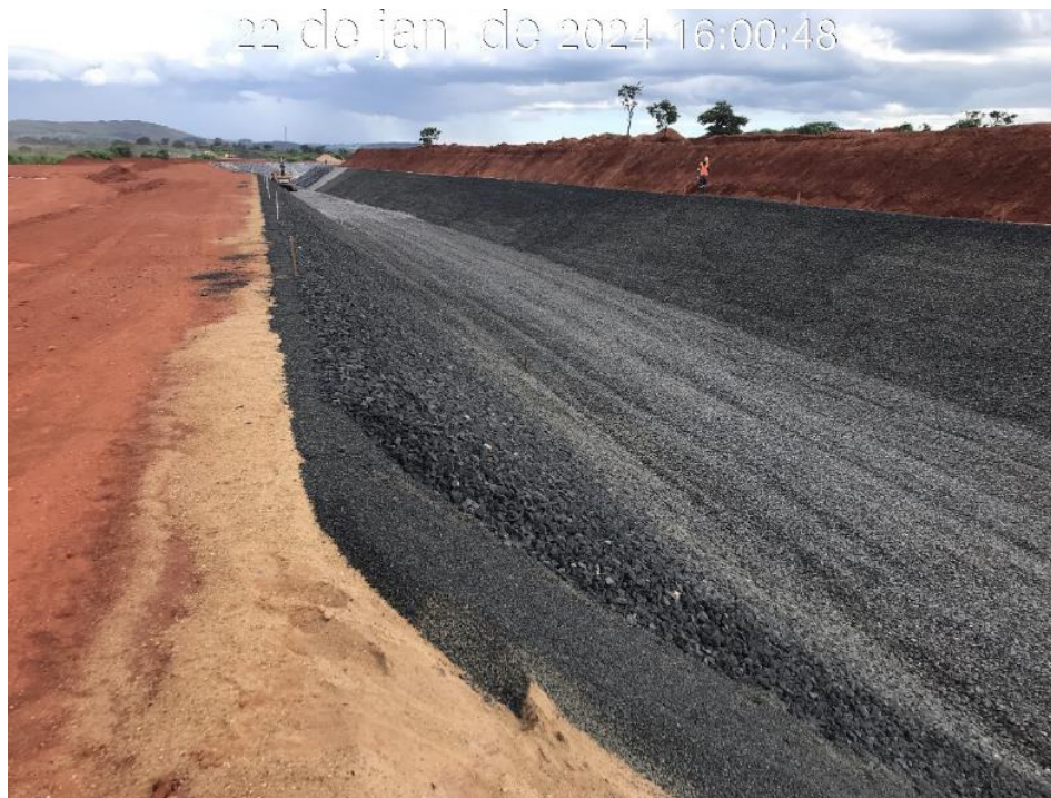
Figura 7.14 – Aplicação das transições 1, 2 e 3 no canal periférico, entre as estacas 115 e 1124, com vista para montante (22/01/2024).
