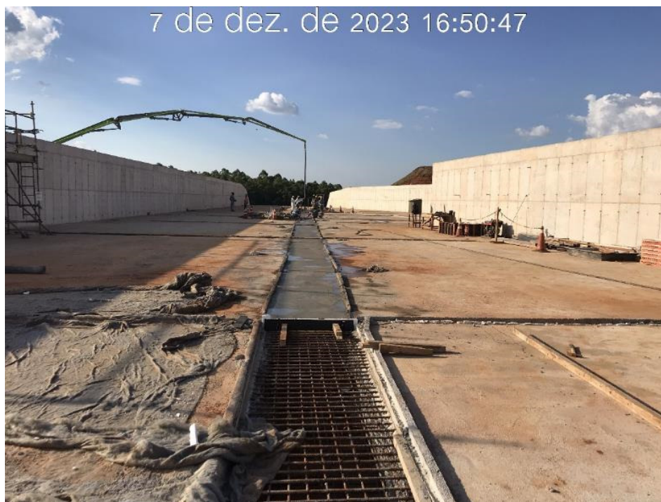
Figura 7.22 – Detalhe da concretagem das juntas de dilatação do canal rápido (07/12/2023).
