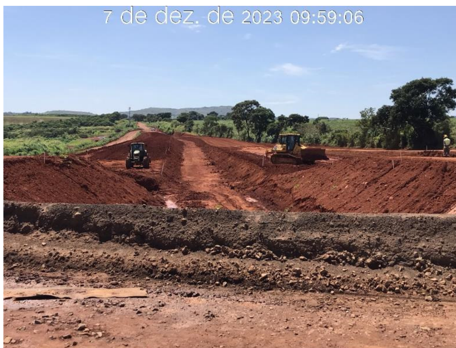
Figura 7.3 – Aplicação de material argiloso na camada de aterro do canal periférico, entre as estacas 22 e 43, com vista para montante (07/12/2023).
