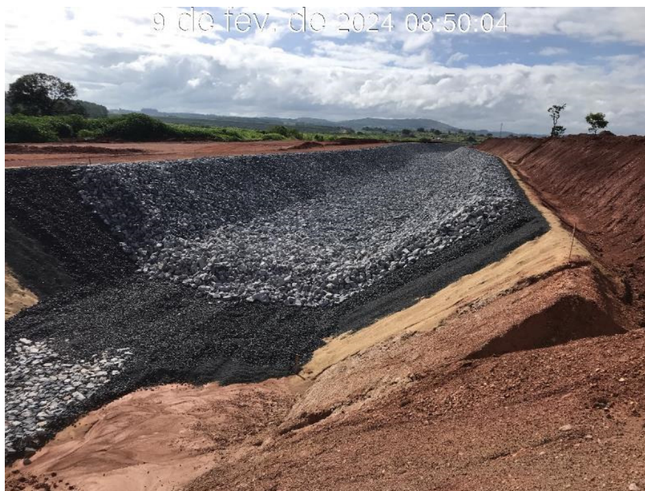
Figura 7.16 – Vista para montante do canal periférico, entre as estacas 115 e 124 (09/02/2024).
