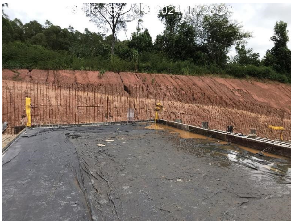
Figura 7.32 – Concretagem do módulo 20 do canal rápido (19/02/2024).
