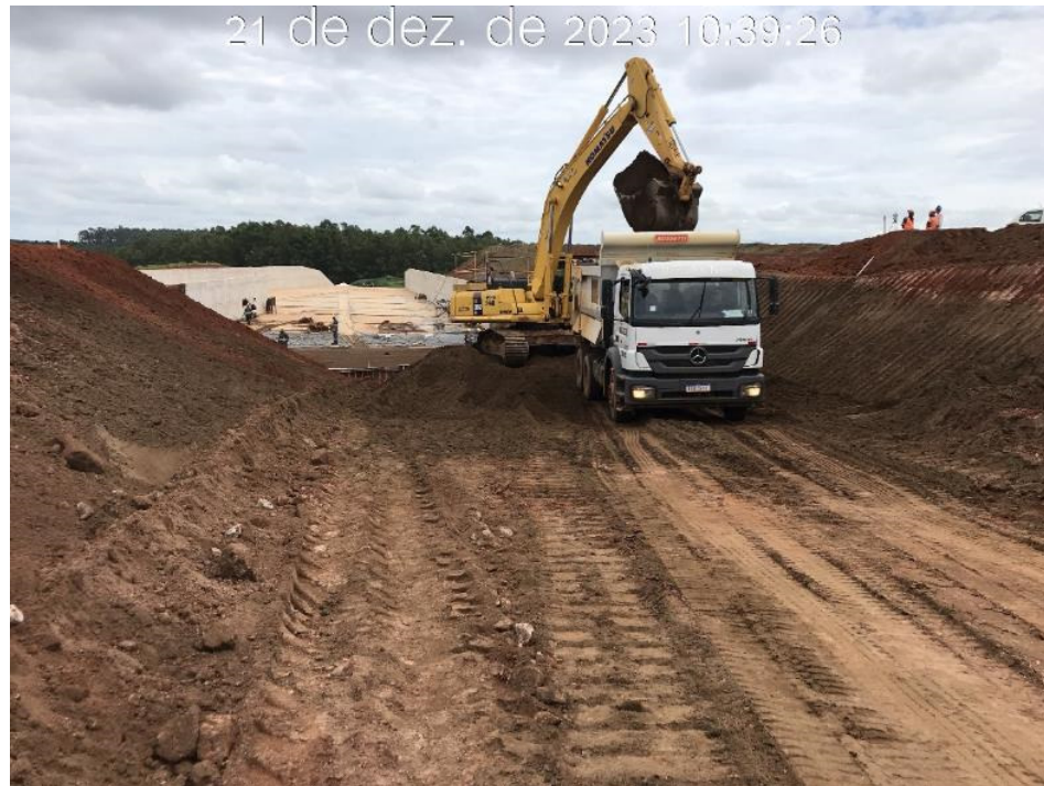
Figura 7.19 – Adequação do canal do reservatório para execução da transição 2 (21/12/2023).
