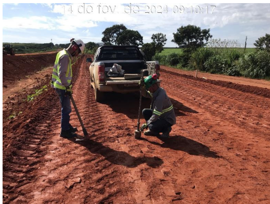
Figura 7.7 – Realização do teste de compactação pelo método de Hilf , na camada de aterro do canal periférico, na região da estaca 41 (14/02/2024).
