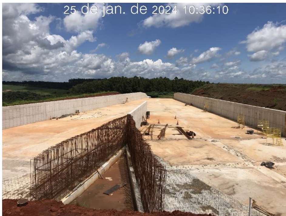
Figura 7.26 – Vista para jusante do canal rápido (25/01/2024).
