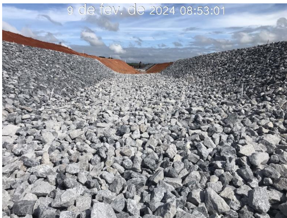
Figura 7.17 – Detalhe da camada de proteção (enrocamento), na região da estaca 121, com vista para jusante (09/02/2024).
