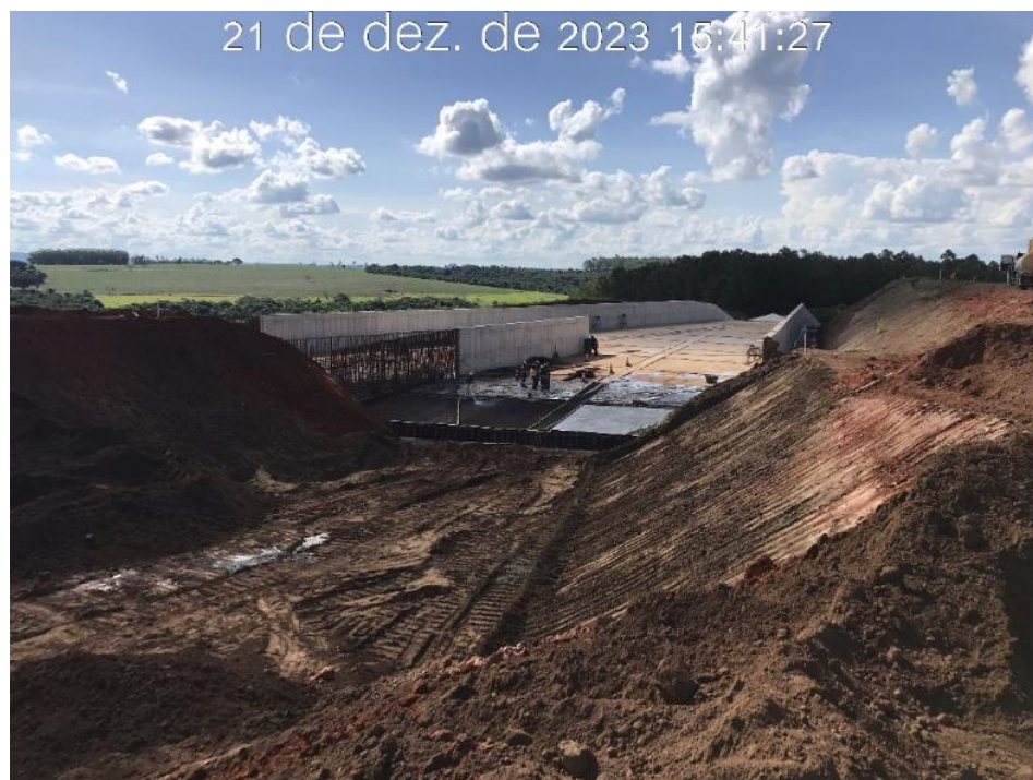
Figura 7.20 – Concretagem do piso da transição 2 com o canal do reservatório (21/12/2023).
