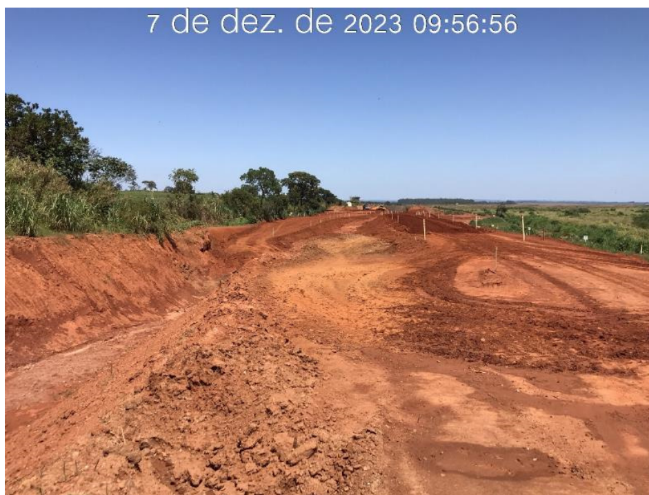
Figura 7.2 – Início do canal periférico na região da estaca 22, com vista para jusante (07/12/2023)
