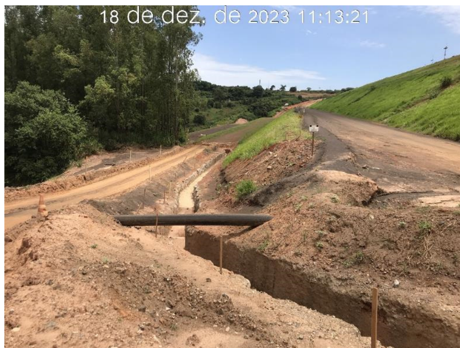
Figura 7.34 – Escavação do canal de drenagem superficial da ombreira esquerda (18/12/2023).
