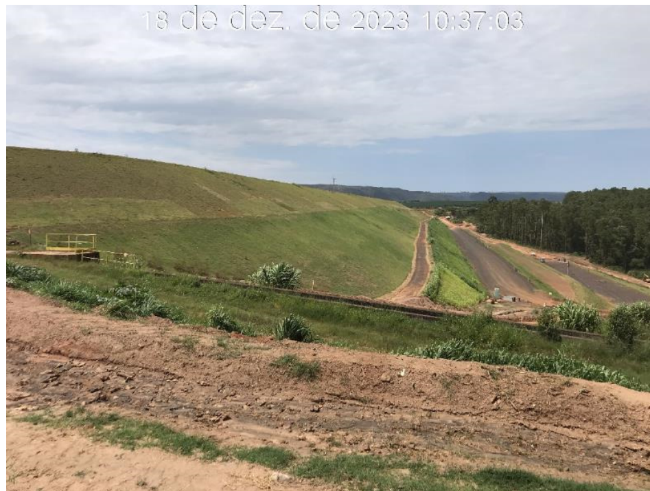
Figura 7.33 – Vista de jusante da barragem B5, após finalização do plantio de grama em placa (18/12/2023).
