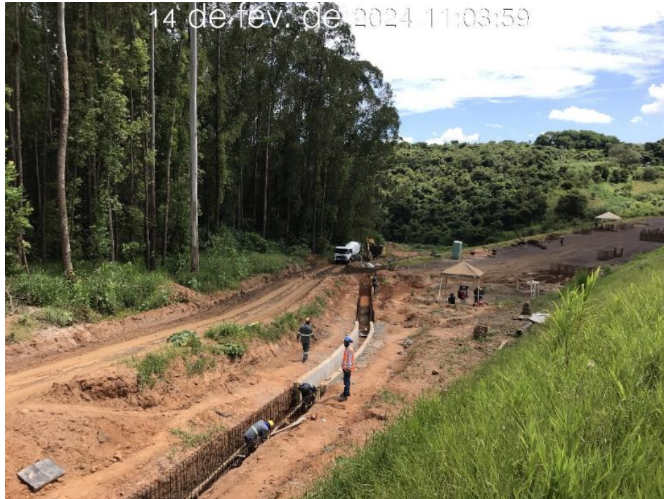
Figura 7.37 – Concretagem do módulo 20 do canal de drenagem superficial da ombreira esquerda, com vista para jusante (14/02/2024).
