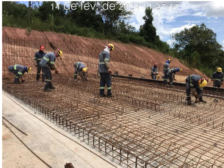
Figura 7.30 – Montagem da armação do módulo 20 do canal rápido (14/02/2024).
