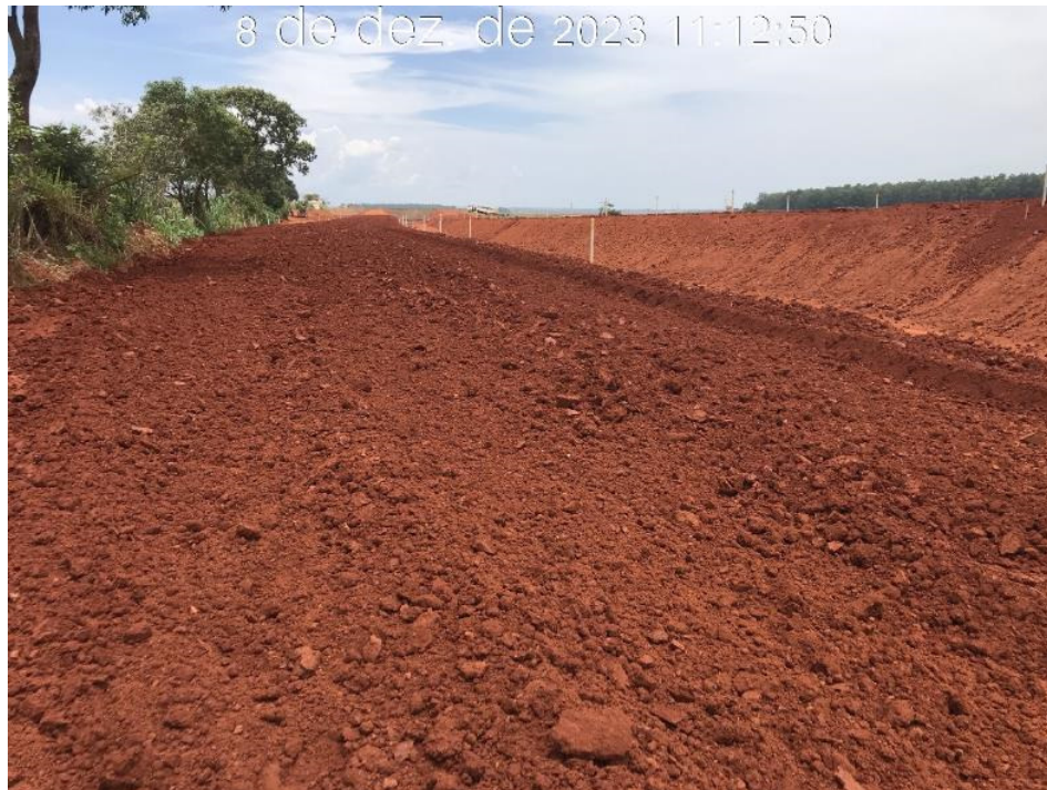
Figura 7.4 – Tratamento do material argiloso aplicado na camada de aterro do canal periférico, na região da estaca 30 (08/12/2023).
