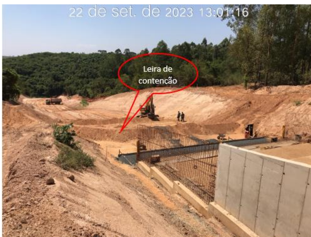
Figura 7.39 – Execução de uma leira na região do módulo 35, para contenção e desvio do escoamento de água superficial (22/09/2023).
