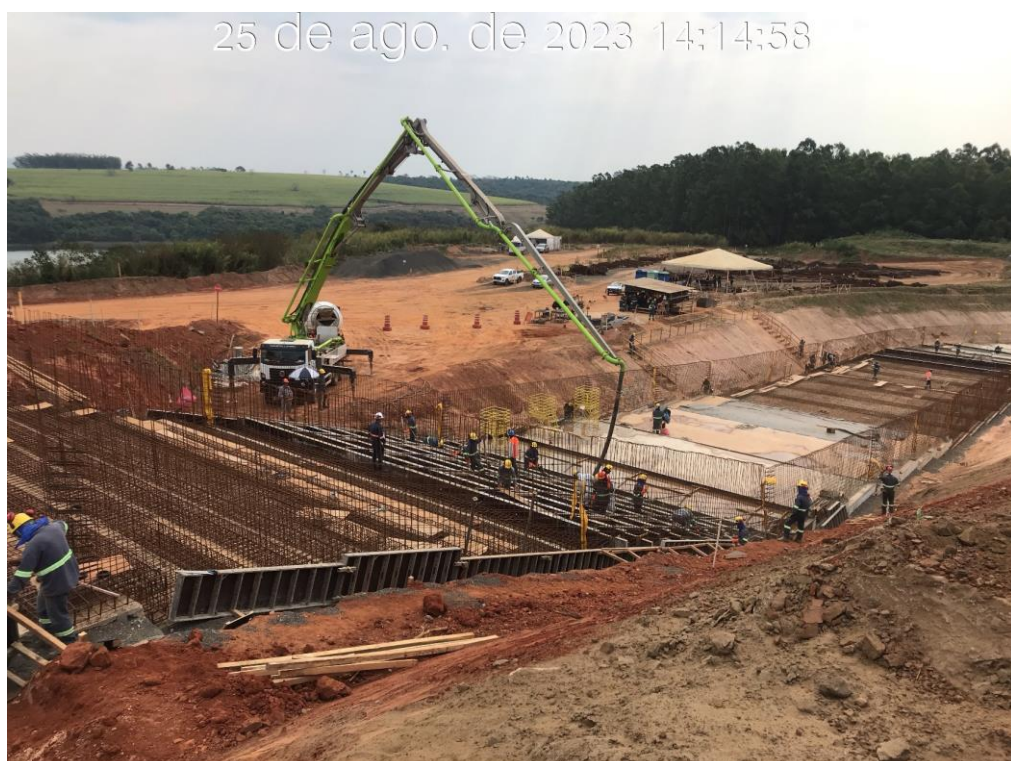
Figura 7.20 – Concretagem do piso do módulo 64 do canal rápido (25/08/2023).
