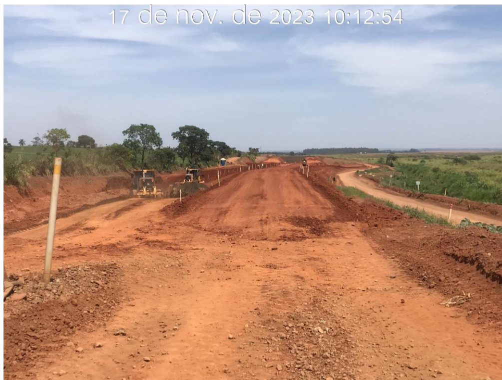
Figura 7.6 – Aplicação do material argiloso nas camadas de aterro do canal periférico, entre as estacas 22 e 43, com vista para jusante (17/11/2023).
