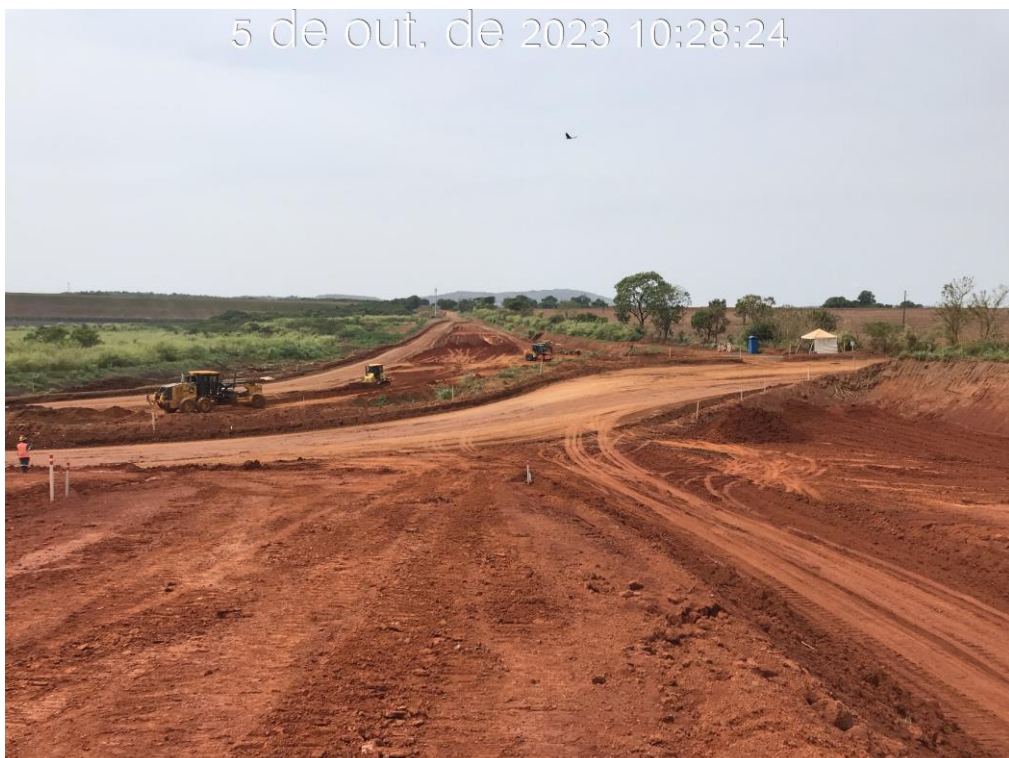
Figura 7.5 – Aplicação do material argiloso nas camadas de aterro do canal periférico, entre as estacas 22 e 43, com vista para montante (05/10/2023).
