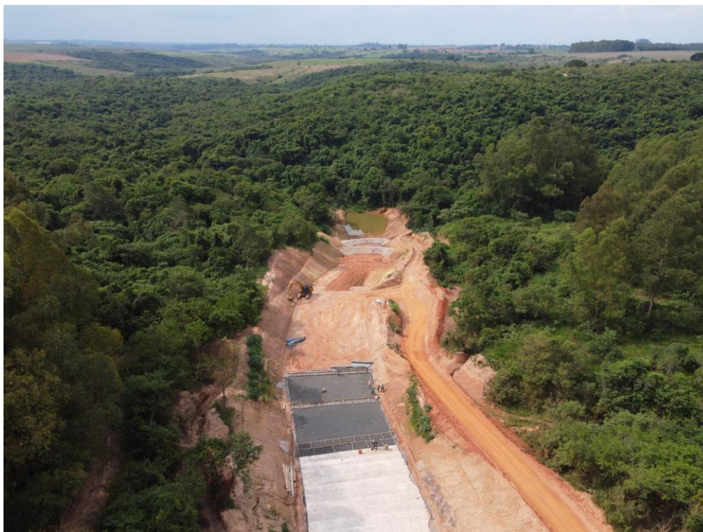
Figura 7.30 – Panorama do canal rápido, com vista para jusante (27/10/2023).
