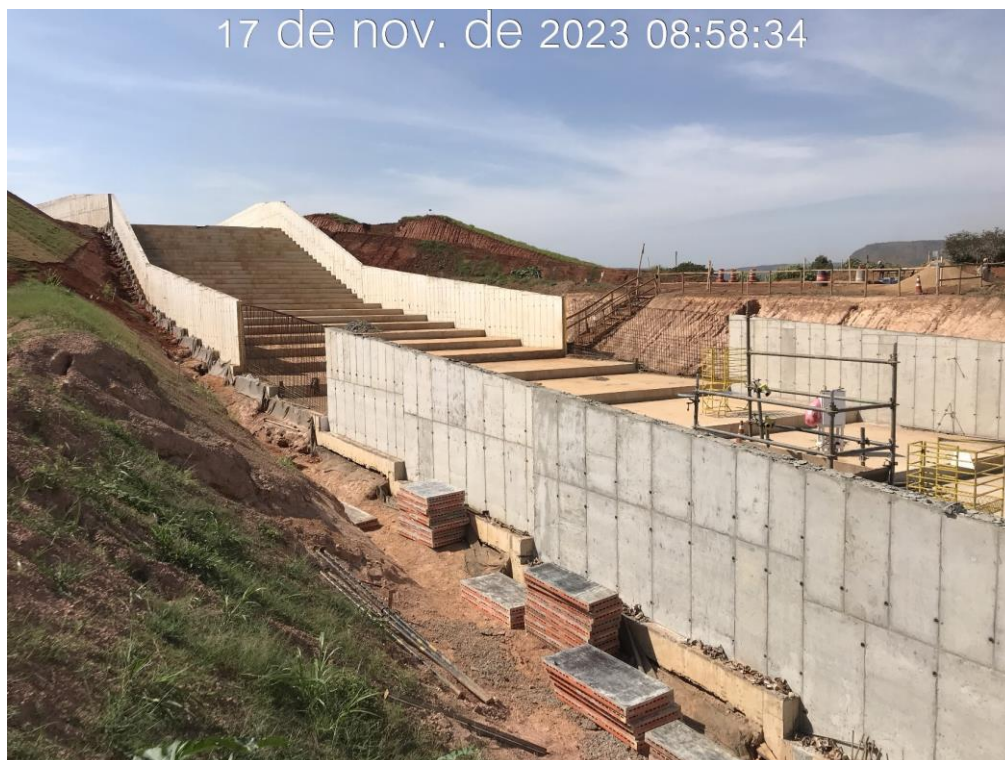
Figura 7.25 – Vista do canal rápido, após concretagem das paredes entre os módulos 58 e 65 (17/11/2023).
