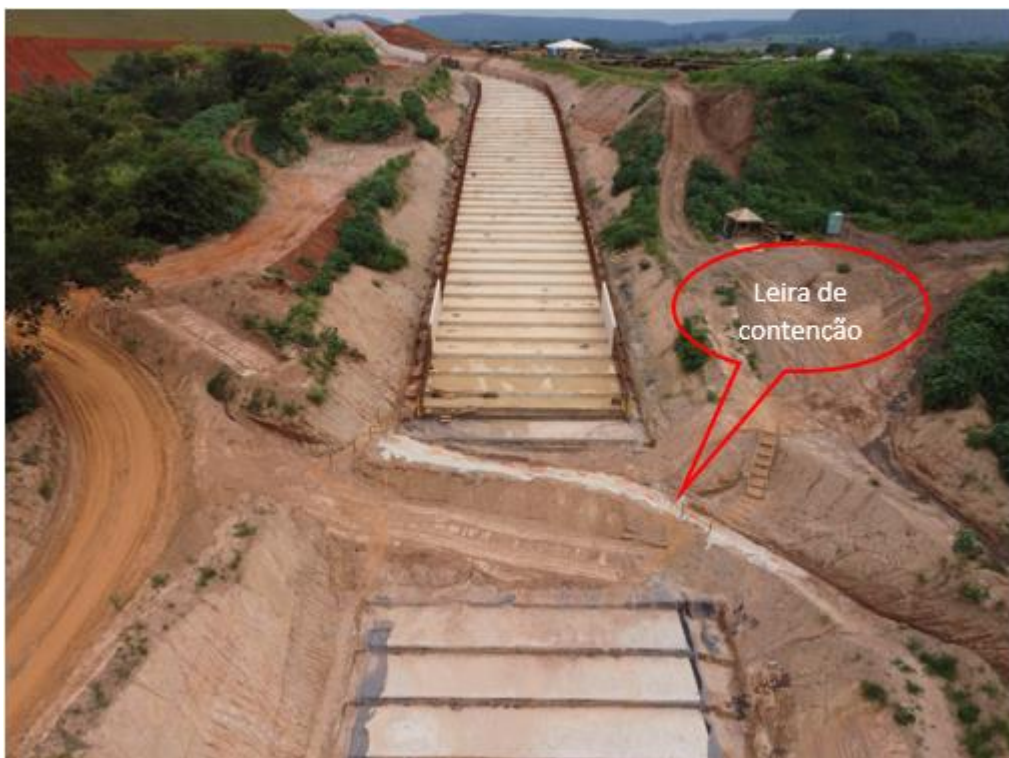
Figura 7.47 – Vista panorâmica do canal rápido, com detalhe da leira de contenção (27/10/2023).
