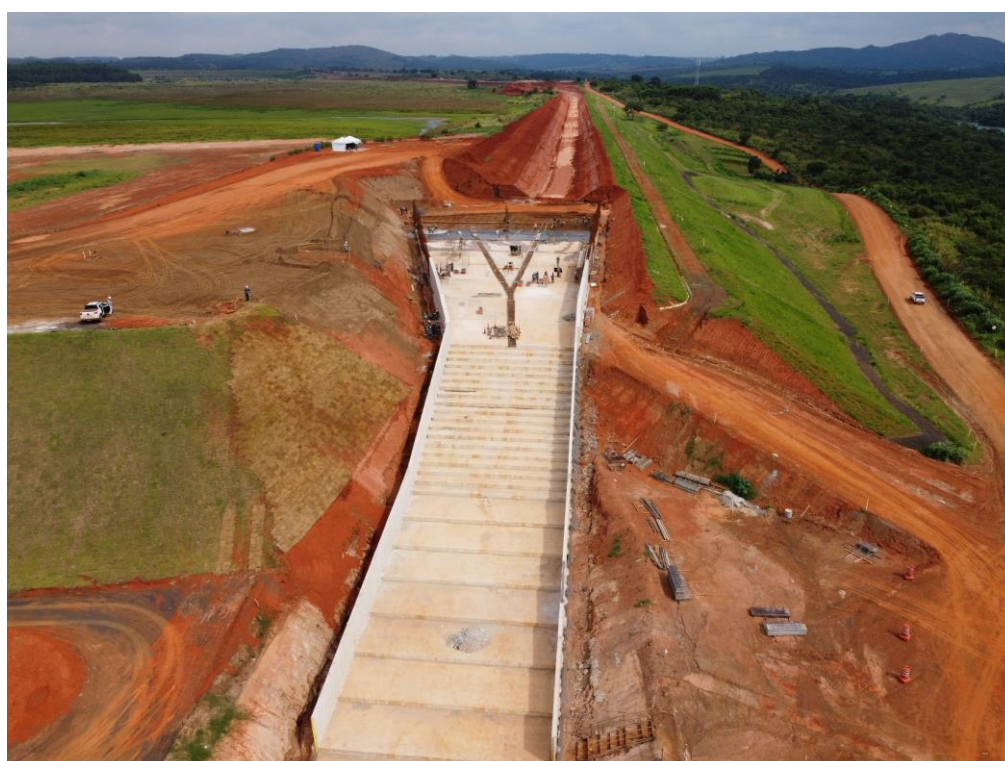
Figura 7.26 – Panorama do canal rápido, com vista para montante (27/10/2023).
