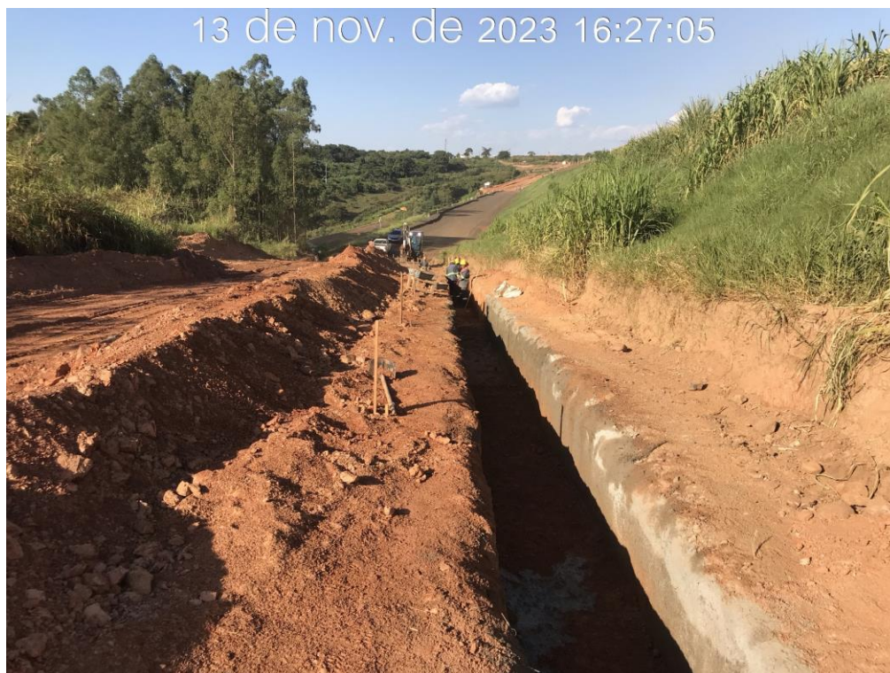
Figura 7.44 – Execução do canal de drenagem superficial da ombreira esquerda (13/11/2023).
