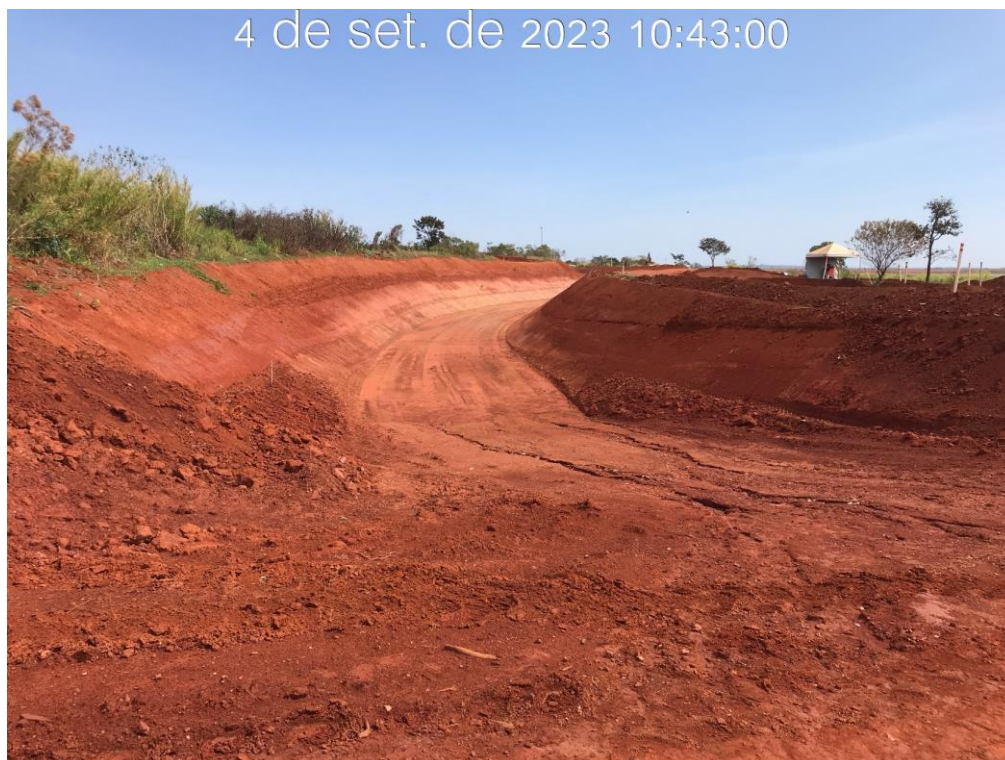
Figura 7.2 – Escavação do canal periférico na estaca 103, com vista para jusante (04/09/2023).
