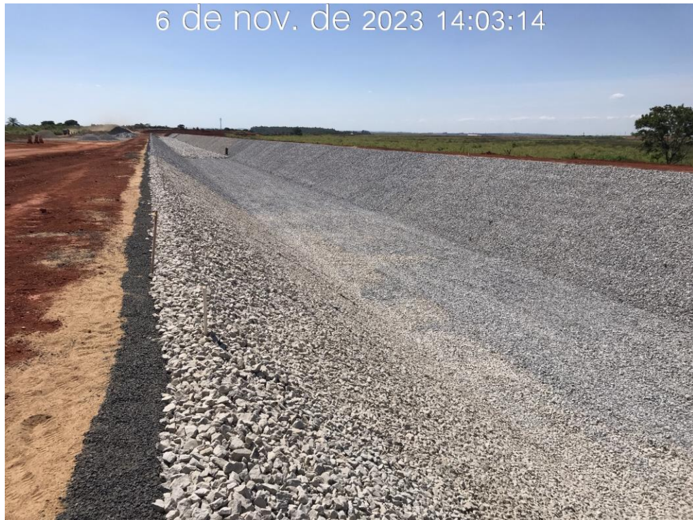
Figura 7.11 – Vista do canal periférico entre as estacas 77 e 101, com detalhe da transição 3 (brita 3) (06/11/20230).
