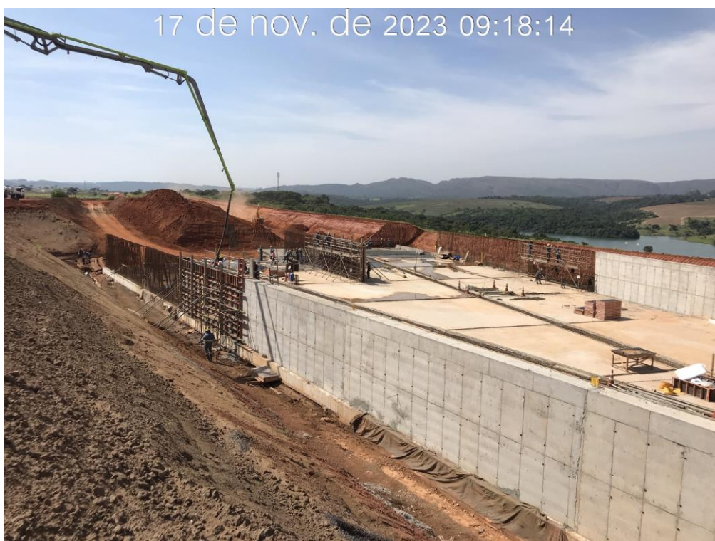
Figura 7.17 – Vista do canal do reservatório, com detalhe da concretagem da parede direita do módulo 71 (17/11/2023).
