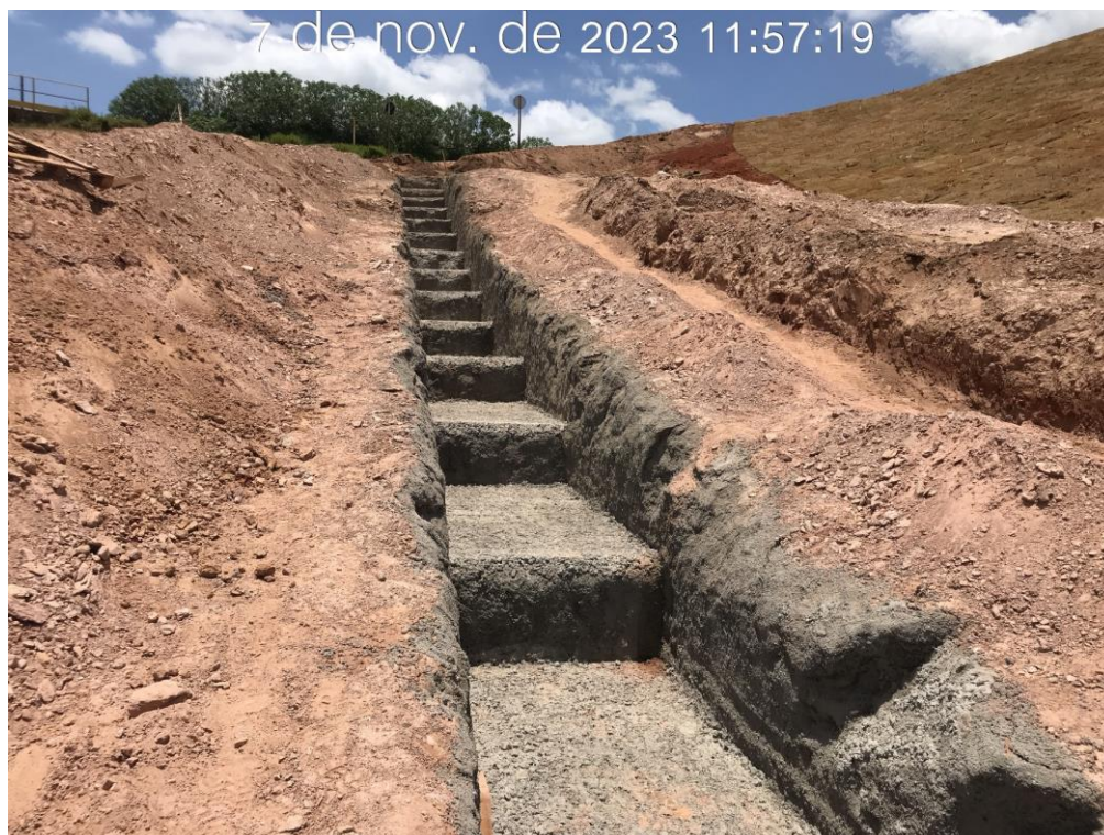
Figura 7.35 – Detalhe do canal de drenagem superficial da ombreira direita (07/11/2023).
