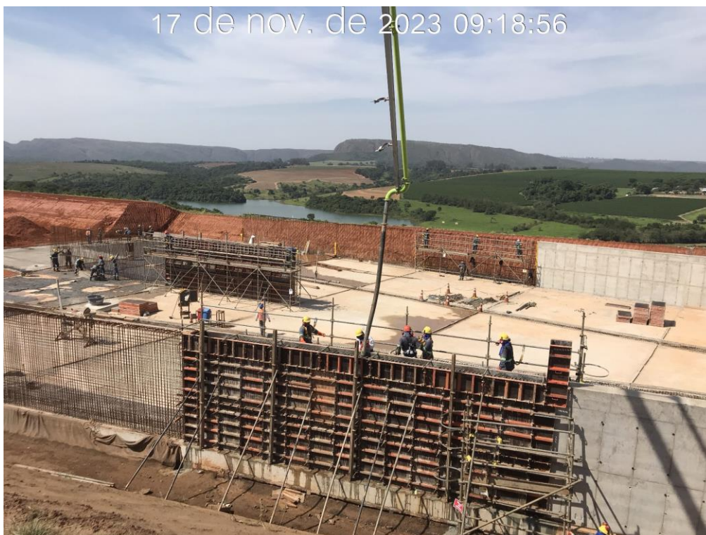
Figura 7.16 – Concretagem das paredes dos módulos 71 e 73 do canal periférico (17/11/2023).
