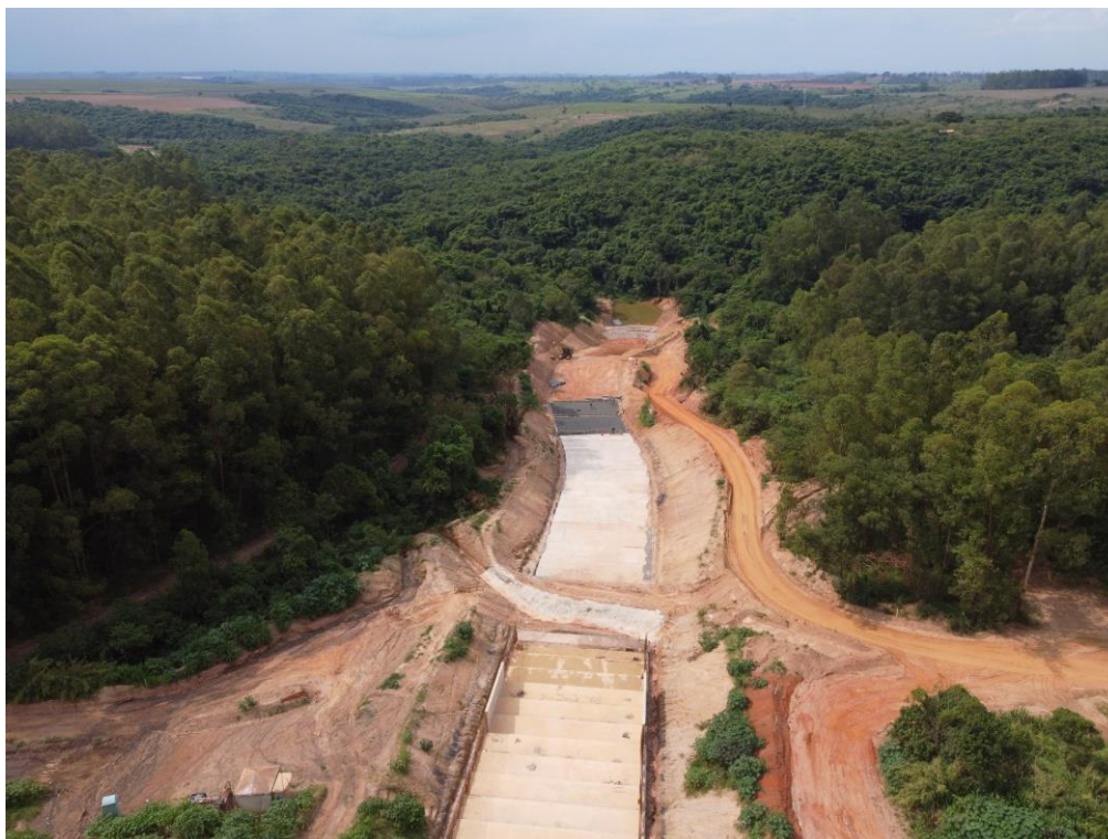
Figura 7.48 – Panorama do canal periférico, com vista para jusante (27/10/2023).
