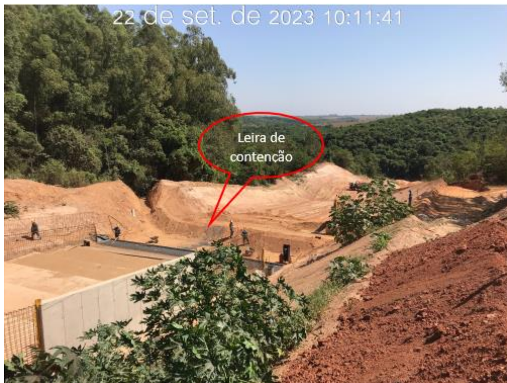
Figura 7.40 – Detalhe da leira de contenção executada na estaca 35, com vista para jusante (22/09/2023).
