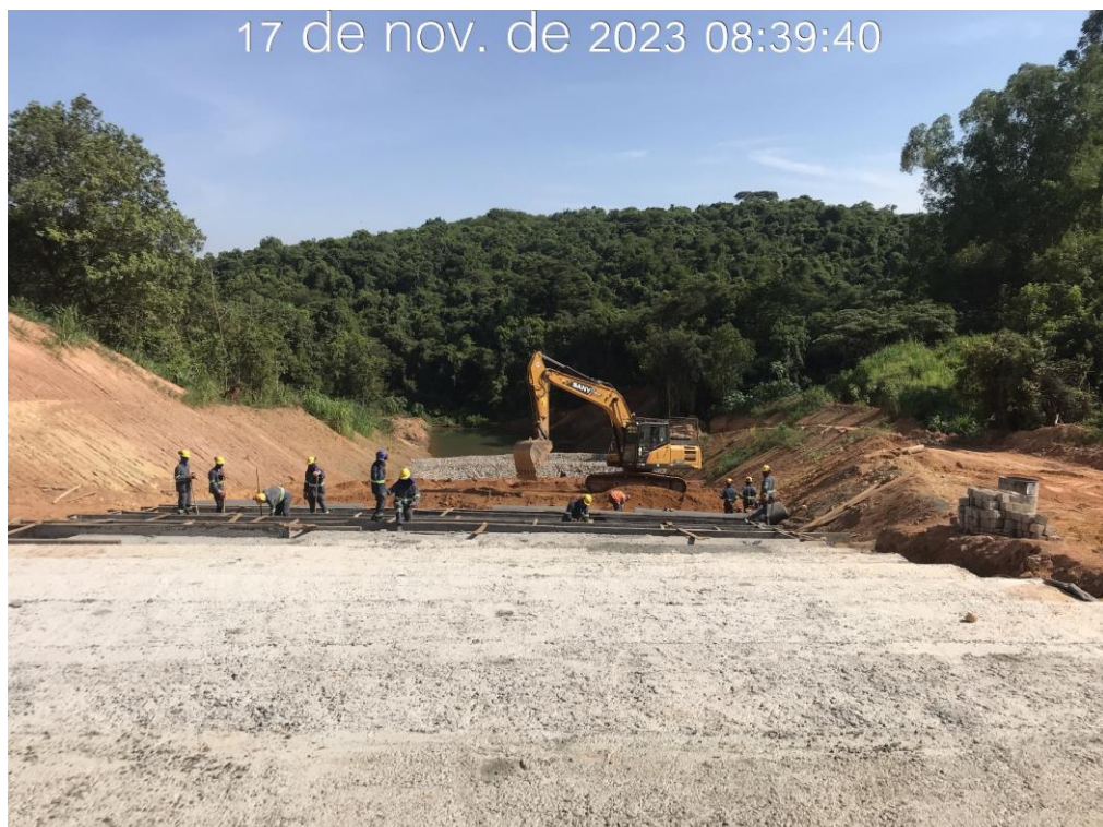
Figura 7.29 – Regularização e aplicação de brita 0 no módulo 16 do canal rápido, com vista para jusante (17/11/2023).
