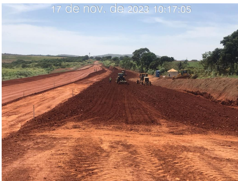
Figura 7.7 – Detalhe da execução do aterro do canal periférico, na região da estaca 40, com vista para montante (17/11/2023).
