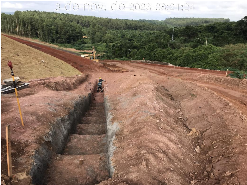
Figura 7.42 – Execução do canal de drenagem superficial da ombreira direita (03/11/2023).
