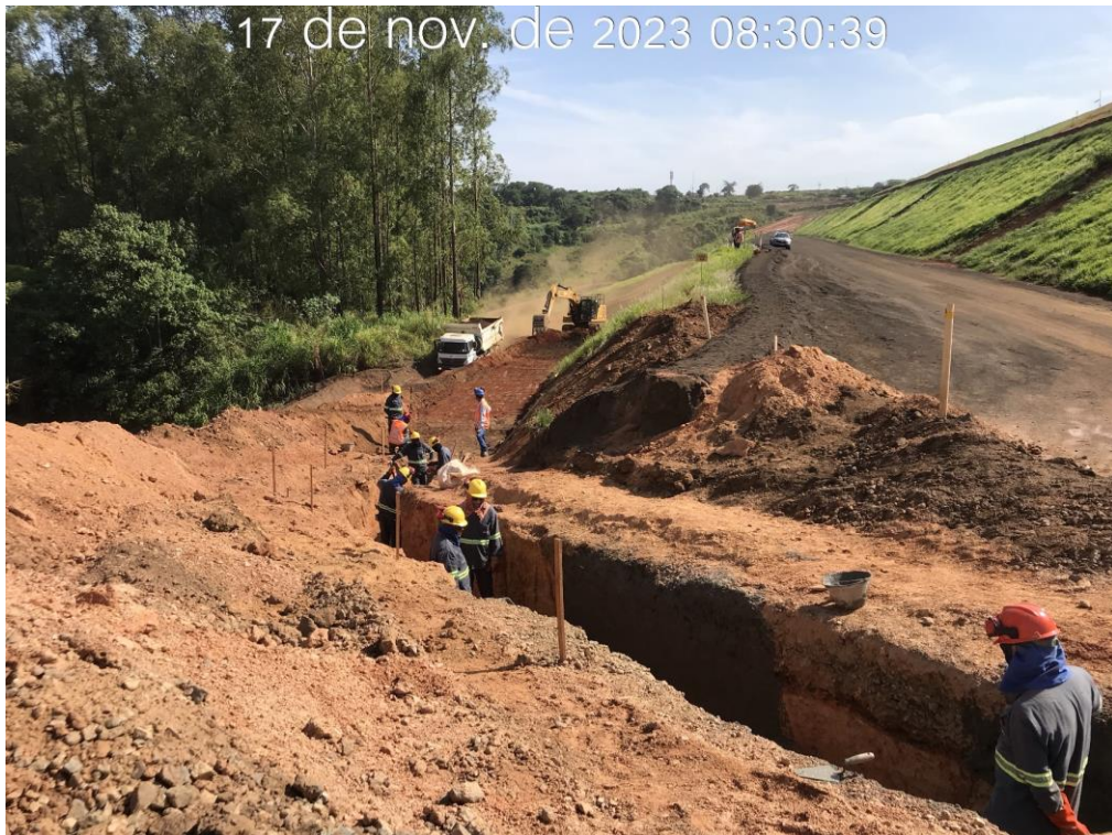
Figura 7.37 – Escavação do canal de drenagem superficial na ombreira esquerda, com vista para ombreira direita (17/11/2023).
