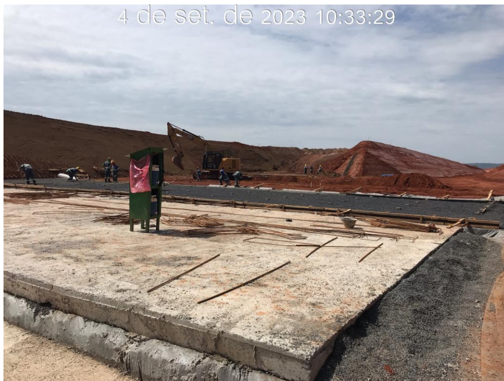
Figura 7.14 – Execução da regularização e aplicação do dreno de fundo no módulo 73 e 74 do canal do reservatório (04/09/2023).
