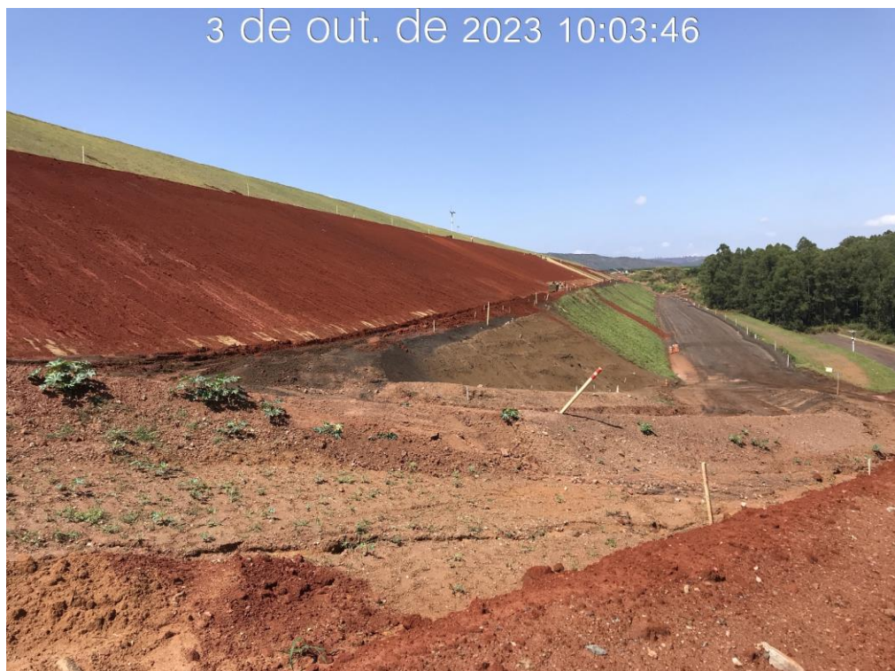
Figura 7.32 – Detalhe da regularização do talude entre as elevações 940,00m e 952,50m, após aplicação da camada argilosa (03/10/2023).
