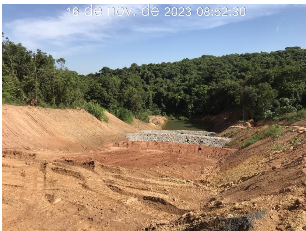
Figura 7.45 – Execução de diques de contenção na região da bacia de dissipação (16/11/2023).
