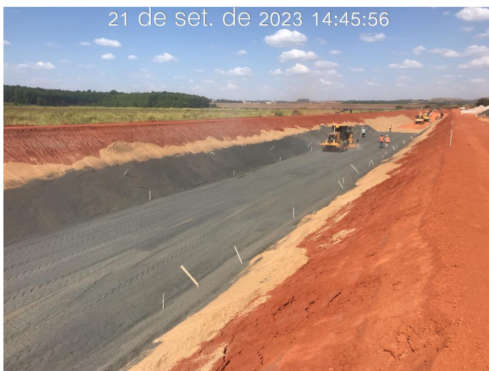
Figura 7.10 – Aplicação da transição 2 (brita 0) entre as estacas 77 e 101 do canal periférico, com vista para montante (21/09/2023).
