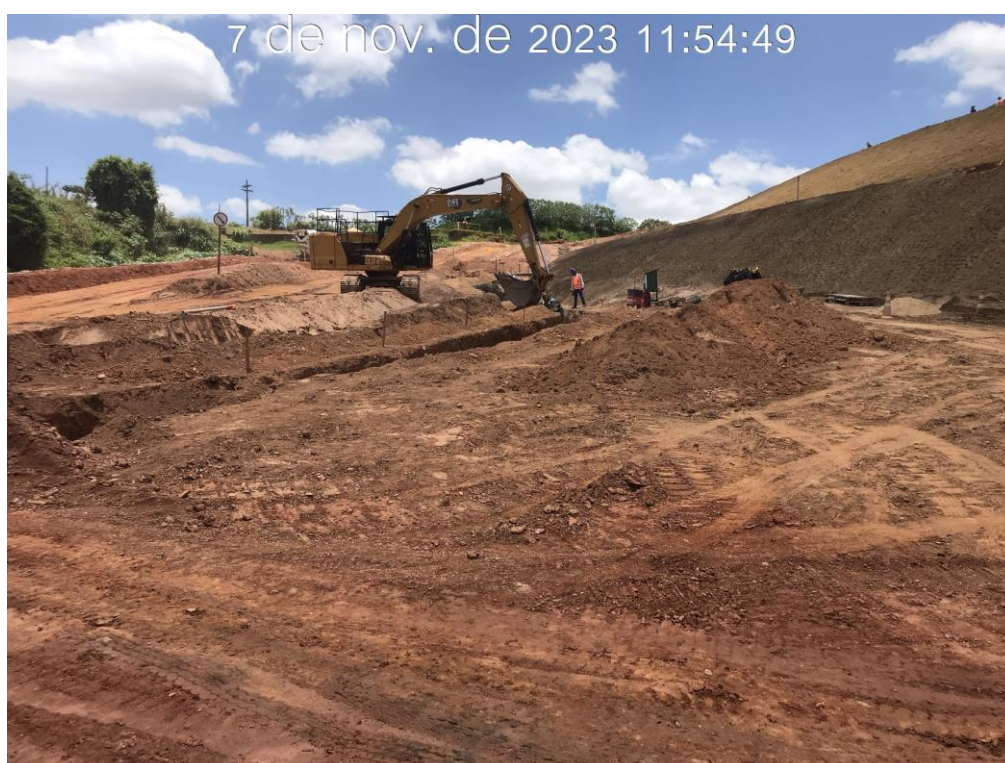
Figura 7.34 – Escavação do canal de drenagem superficial na ombreira direita (07/11/2023).
