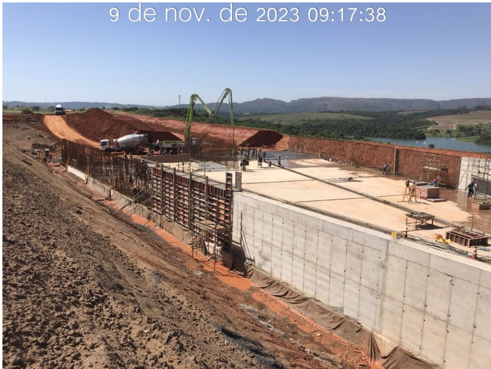
Figura 7.23 – Concretagem do piso 74 do canal rápido, com vista para montante (09/11/2023).
