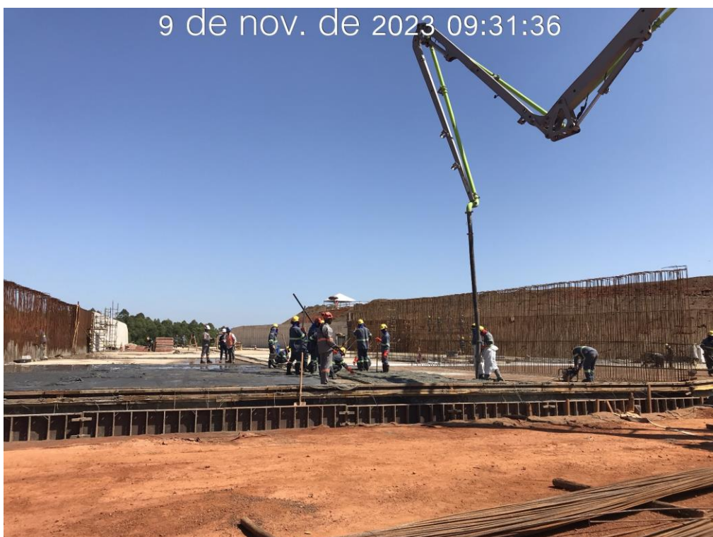
Figura 7.24 – Detalhe da concretagem do piso do módulo 74 do canal rápido (09/11/2023).
