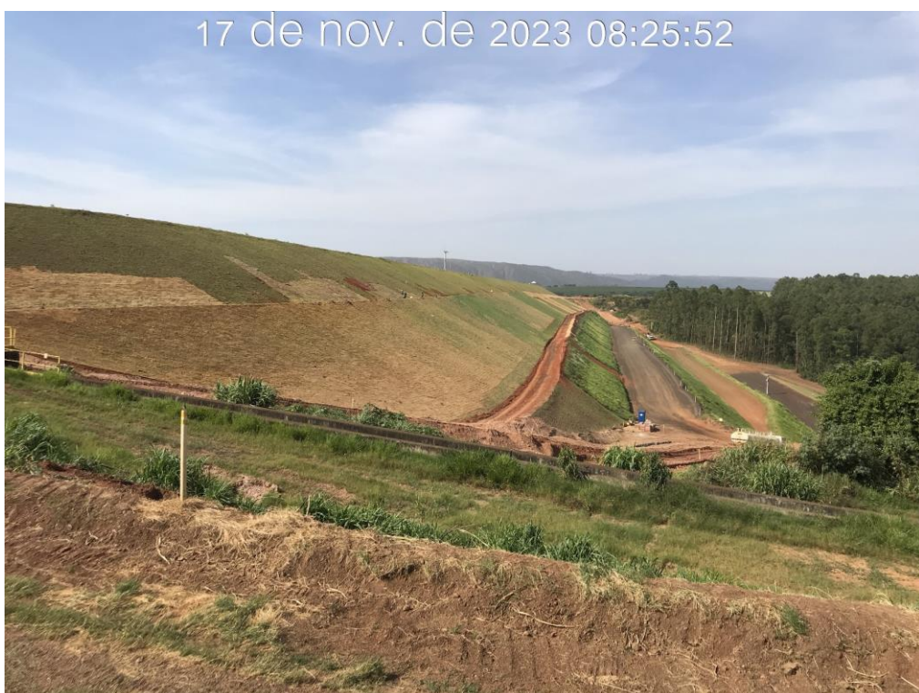
Figura 7.38 – Término do plantio de grama em placa, com vista para ombreira esquerda (17/11/2023).
