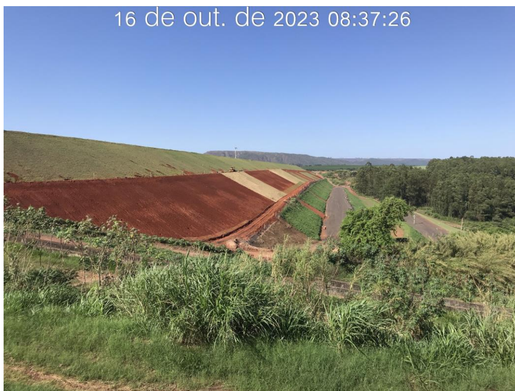
Figura 7.33 – – Aplicação da grama em placa no talude entre as elevações 940,00 e 962,50m, com vista para ombreira esquerda (16/10/2023)
