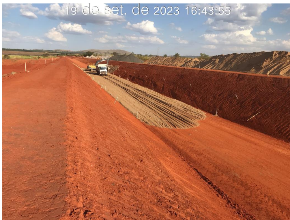
Figura 7.9 – Início da execução do revestimento do canal periférico, entre as estacas 77 e 101, com detalhe da aplicação da transição 1 (areia) (19/09/2023).
