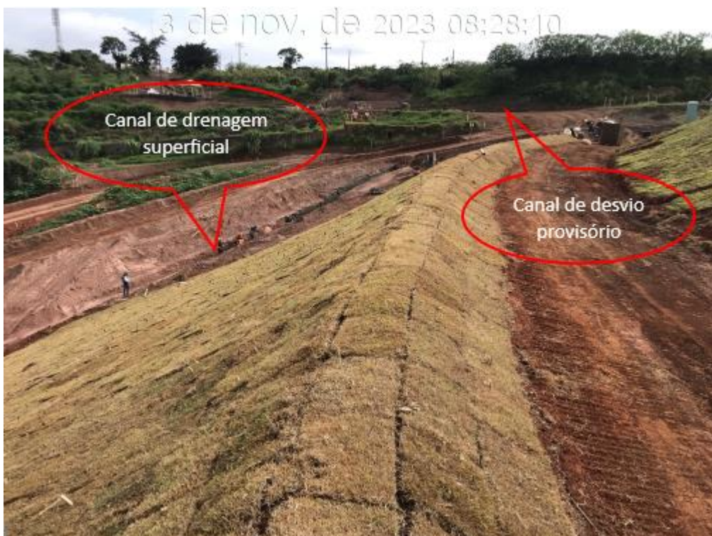
Figura 7.43 – Detalhe dos canais de drenagem superficial da ombreira direita (03/11/2023).
