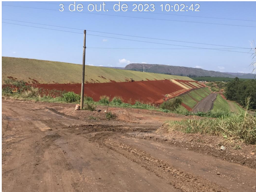
Figura 7.31 – Regularização da berma na elevação 952,50m, e do talude entre as elevações 940,00m e 952,50m, com vista para ombreira esquerda (03/10/2023).
