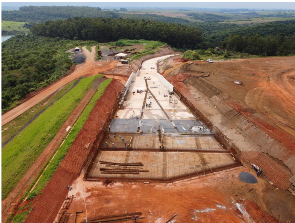
Figura 7.18 – Panorama do canal do reservatório, com vista para jusante (27/10/2023).
