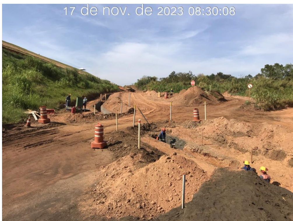
Figura 7.36 – Escavação do canal de drenagem superficial na ombreira esquerda (17/11/2023).
