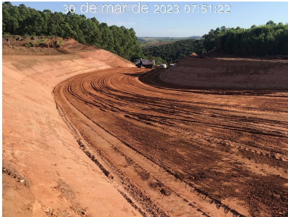
Figura 7.56 – Detalhe do canal rápido, com vista para jusante (30/03/2023).
