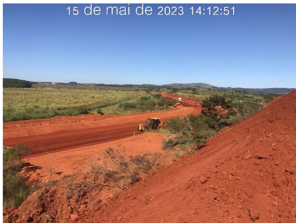
Figura 7.40 – Panorama do canal periférico, com detalhe da escavação na região da estaca 110, com vista para jusante (15/05/2023).
