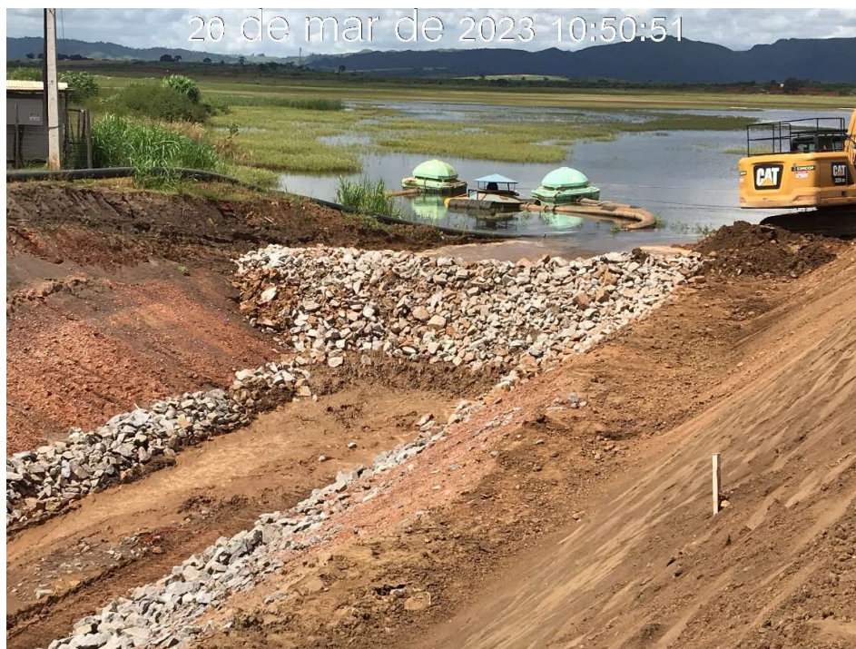
Figura 7.13 – Liberação do fluxo de água para o canal de aproximação (20/03/2023).
