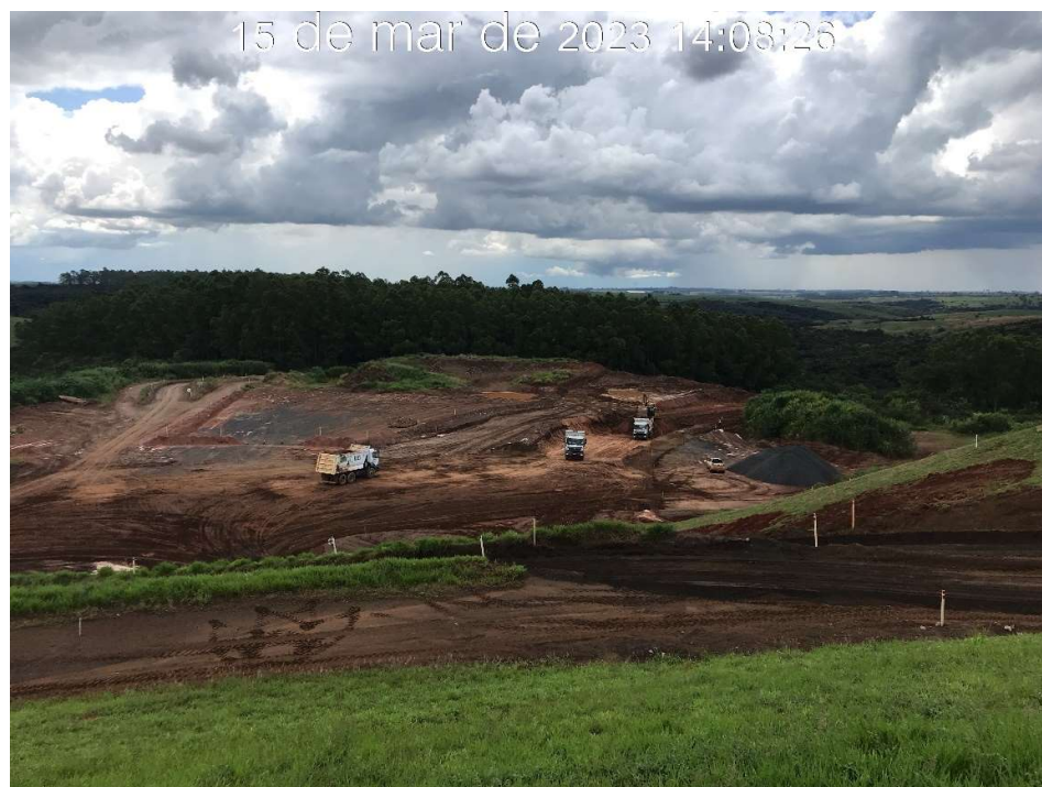
Figura 7.53 – Vista da escavação do canal rápido na estaca 180 (15/03/2023).
