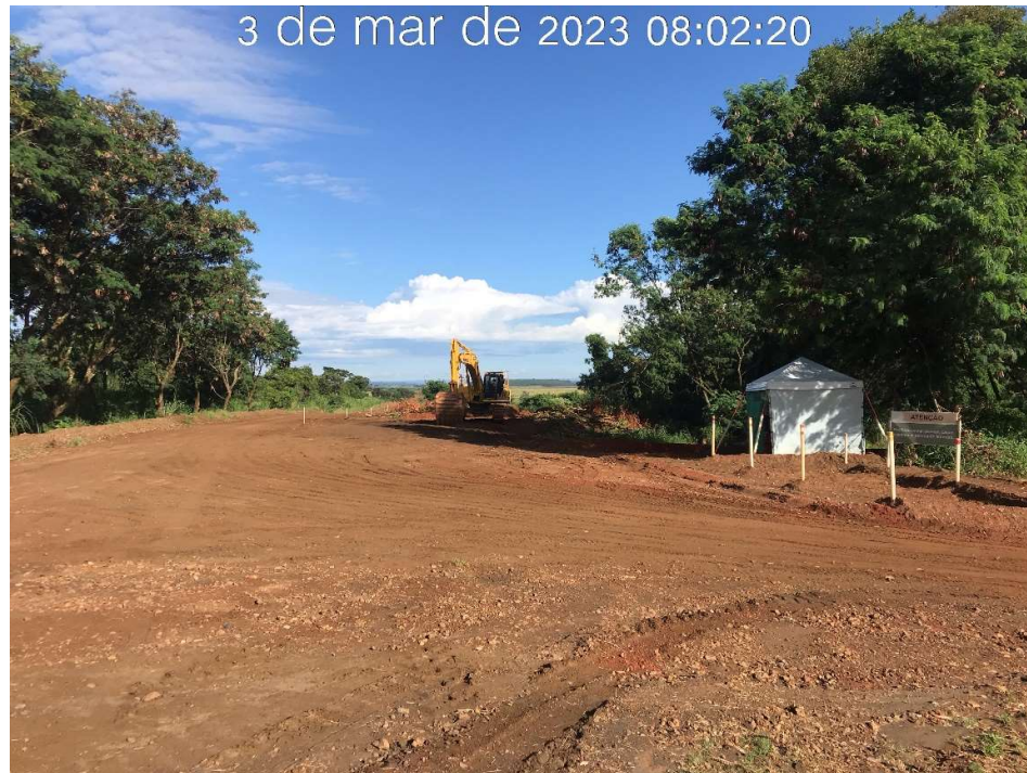
Figura 7.24 – Supressão vegetal no canal periférico, na estaca 01 (03/03/2023).
