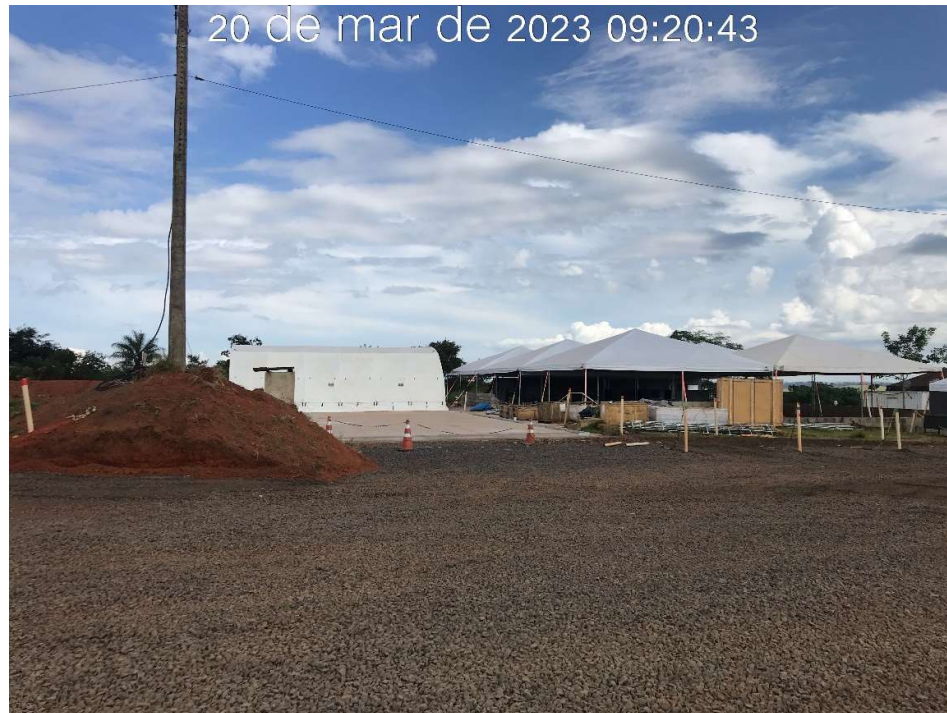
Figura 7.4 – Instalação do refeitório e vestiários (20/03/2023).
