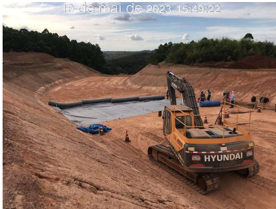
Figura 7.61 – Início da aplicação da manta geotêxtil na estaca 180, no módulo 57, com vista para jusante (10/05/2023).
