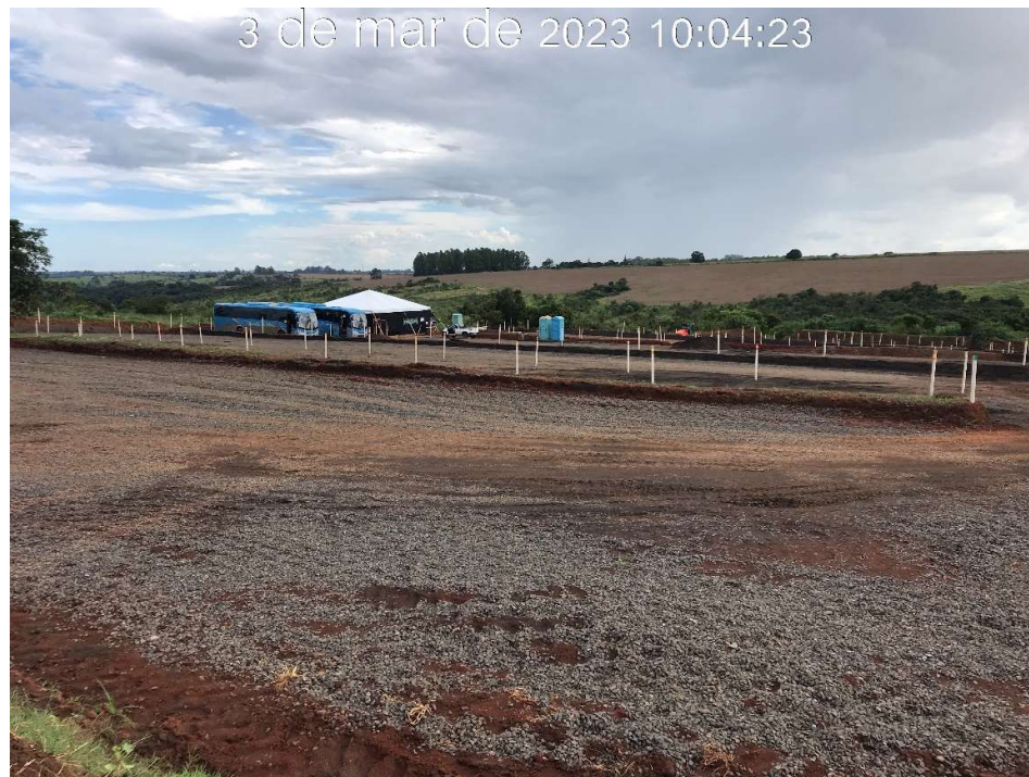
Figura 7.2 – Pátio de máquinas e equipamentos (03/03/2023).
