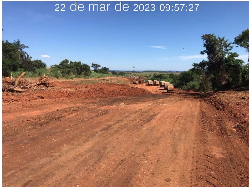
Figura 7.30 – Término da supressão vegetal, entre as estacas 06 a 20 (22/03/2023).
