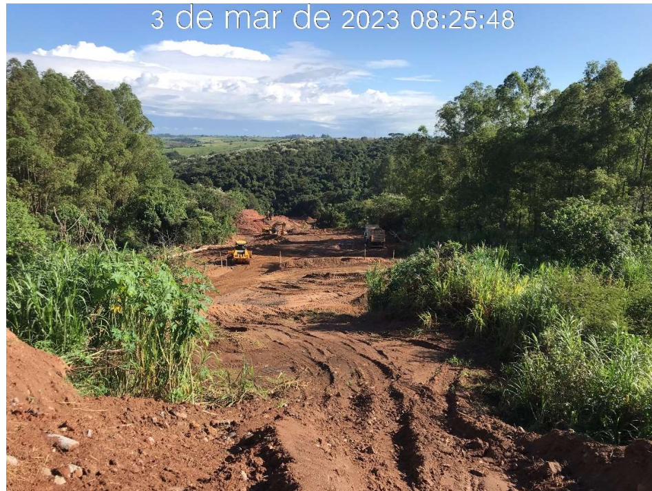
Figura 7.49 – Panorama da supressão vegetal do canal rápido, com vista para jusante (03/03/2023).
