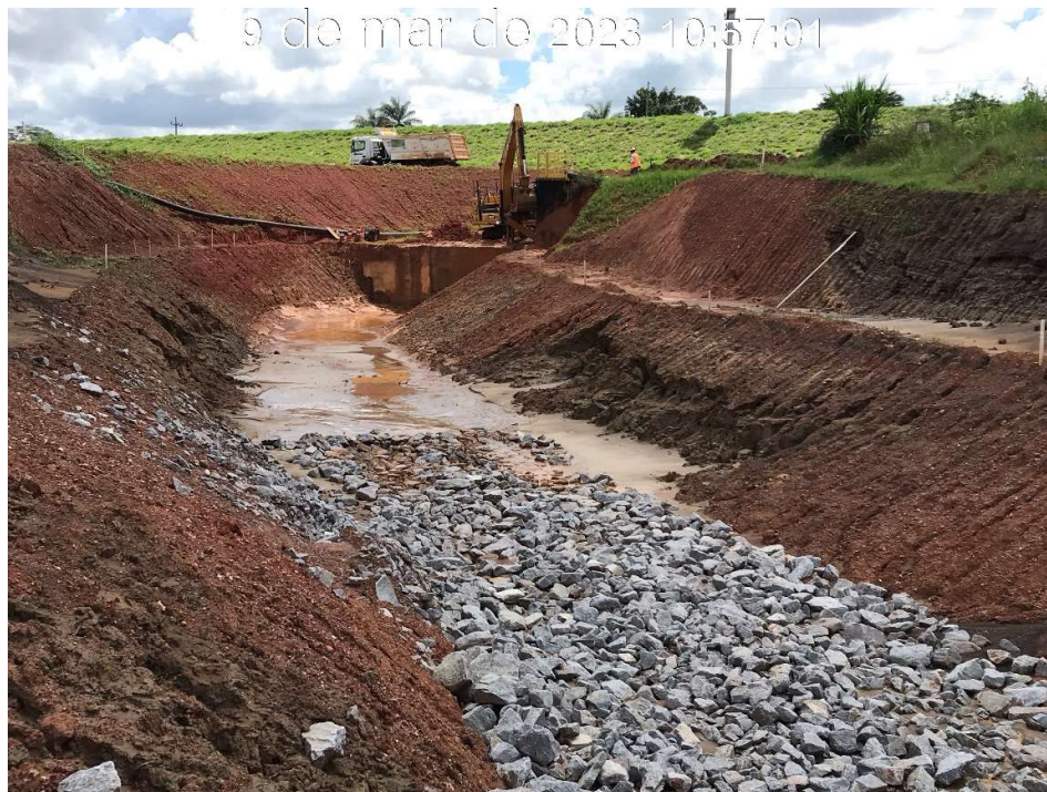
Figura 7.9 – Aplicação do enrocamento na base do canal de aproximação (09/03/2023).
