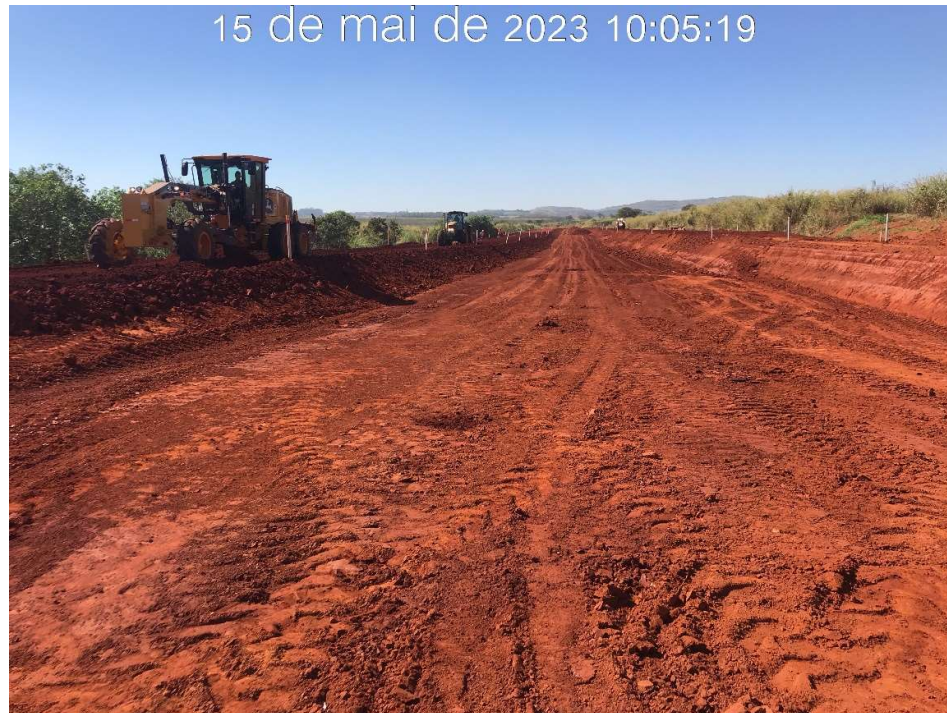
Figura 7.35 – Aplicação de material argiloso no aterro do canal periférico, na estaca 100, com vista para montante (15/05/2023).
