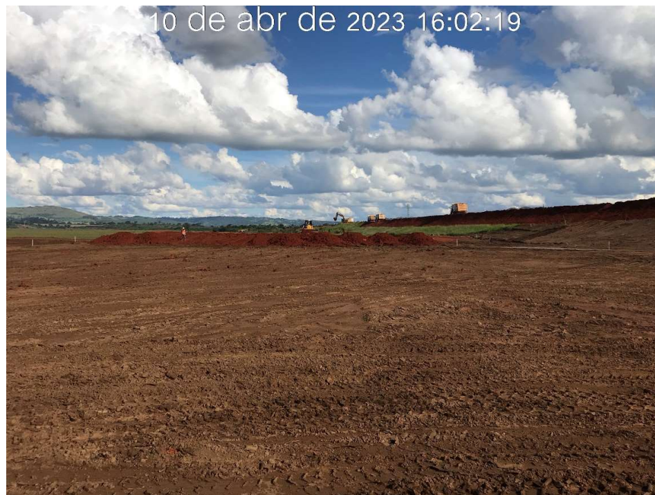
Figura 7.19 – Início da execução do septo argiloso, na ombreira esquerda (10/04/2023).
