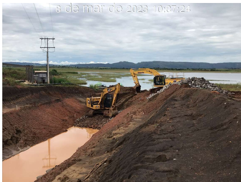
Figura 7.8 – Término da escavação do canal de aproximação com vista para o reservatório (08/03/2023).
