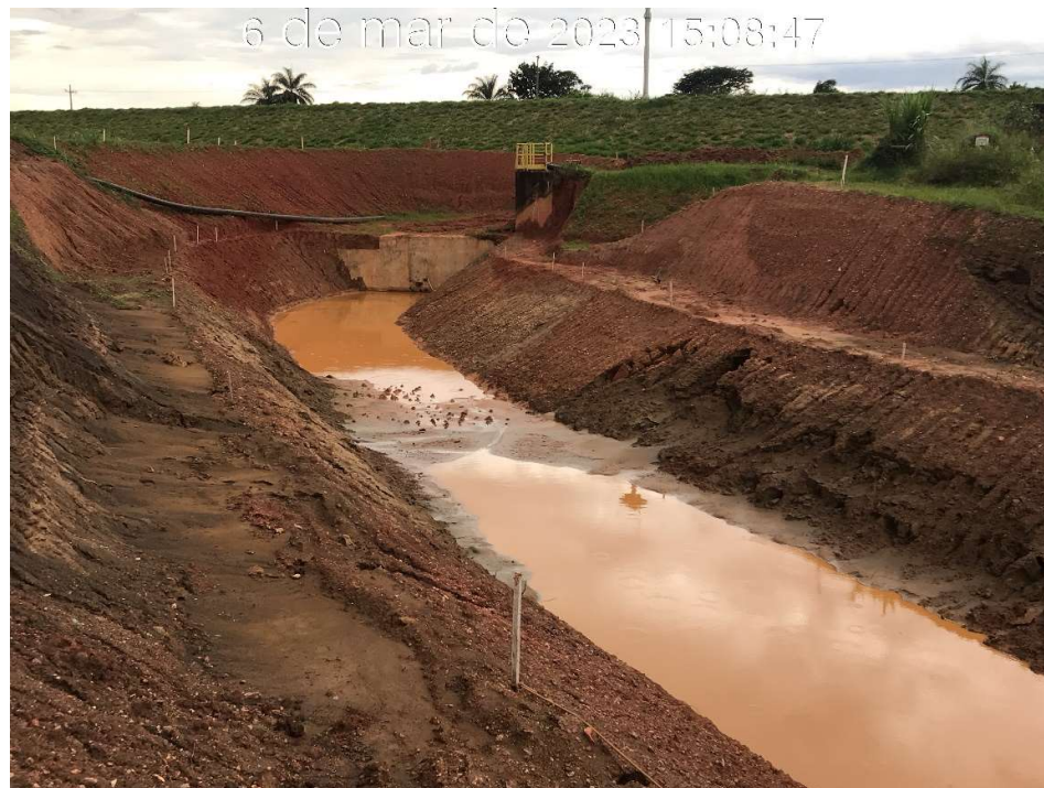
Figura 7.7 – Término da escavação do canal de aproximação (06/03/2023).
