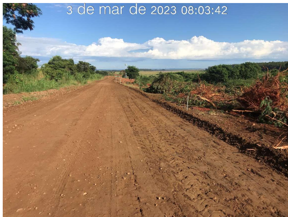
Figura 7.25 – Supressão vegetal no canal periférico, na estaca 06 e 20 (03/03/2023).
