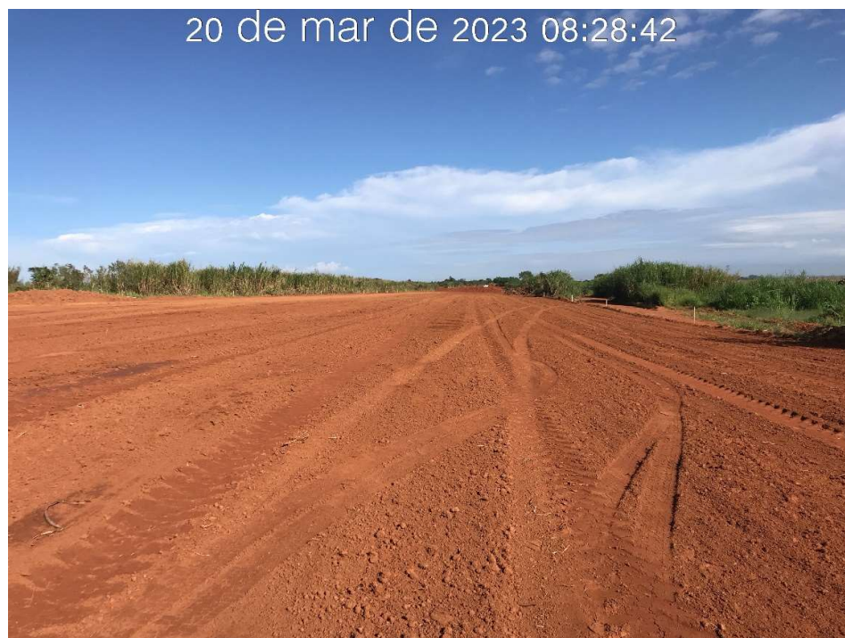
Figura 7.31 – Término da supressão vegetal, entre as estacas 74 a 104 (20/03/2023).
