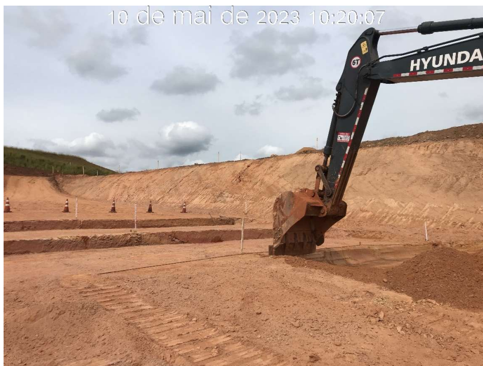
Figura 7.60 – Escavação dos degraus do canal rápido no módulo 56 (10/05/2023).
