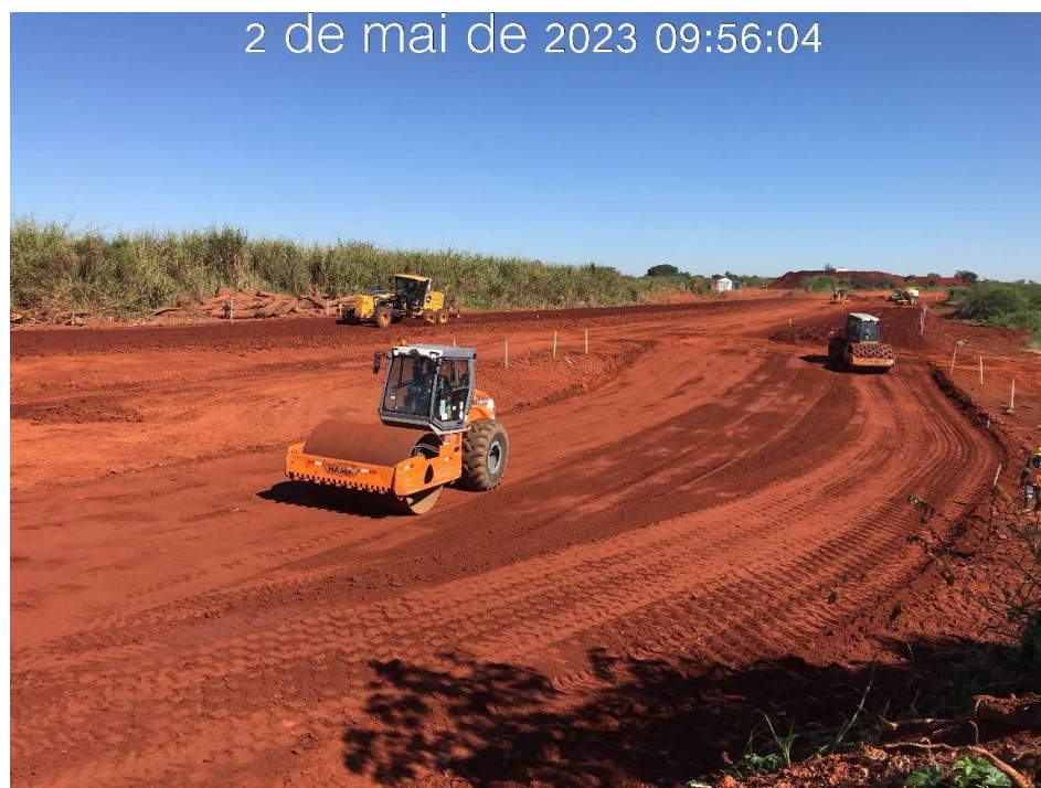
Figura 7.33 – Aplicação de material argiloso no aterro do canal periférico, na estaca 93, com vista para jusante (02/05/2023).
