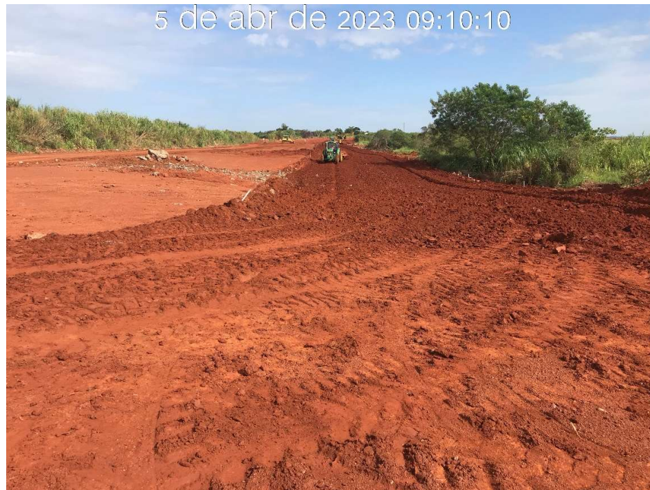
Figura 7.32 – Início da regularização e aterro do canal periférico, na região da estaca 93, com vista para jusante (05/04/2023).
