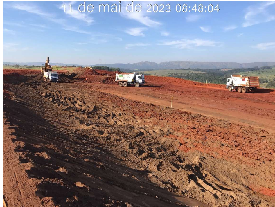
Figura 7.44 – Escavação do canal periférico, com vista para montante (11/05/2023).
