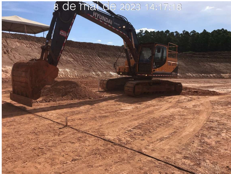
Figura 7.59 – Início da escavação dos degraus do canal rápido na estaca 180, módulo 57 (08/05/2023).
