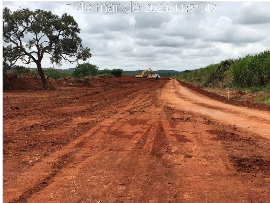
Figura 7.28 – Supressão vegetal na região da estaca 100 (17/03/2023).
