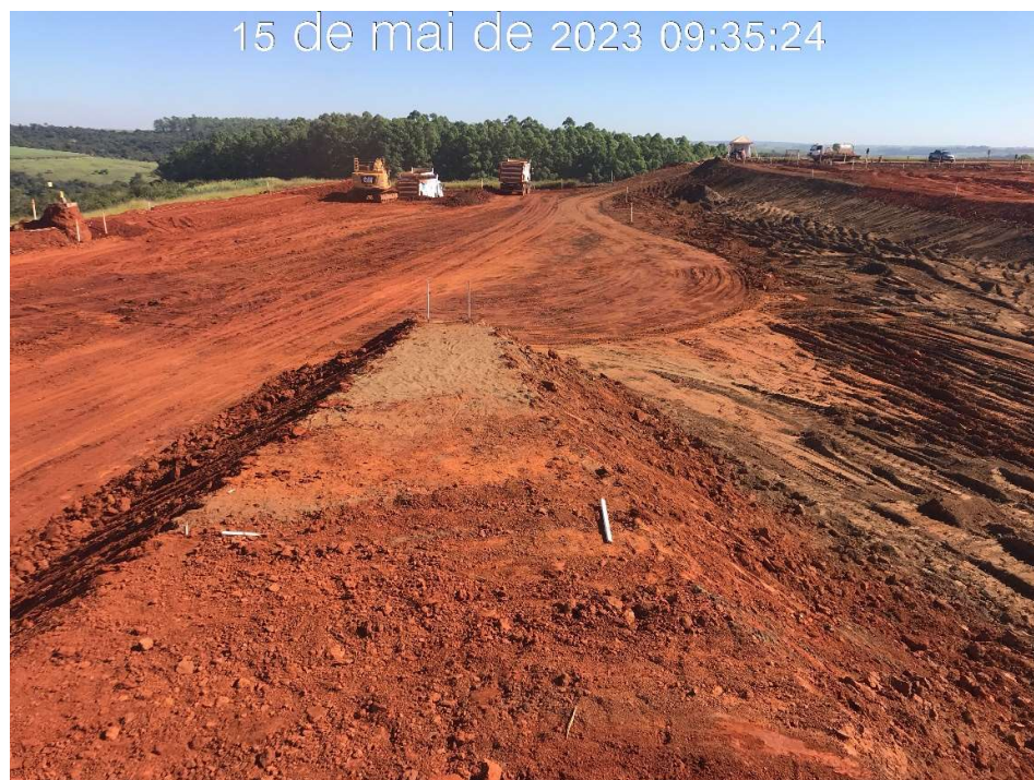
Figura 7.45 – Transição do Canal do Reservatório para o Canal Rápido (15/05/2023).
