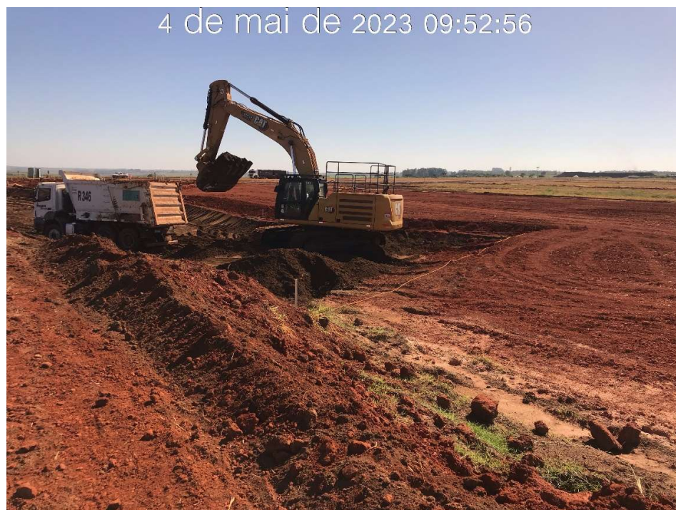
Figura 7.43 – Escavação do canal periférico, com vista para a praia (04/05/2023).
