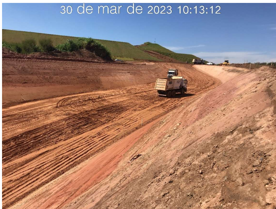
Figura 7.57 – Detalhe do canal rápido, com vista para montante (30/03/2023).
