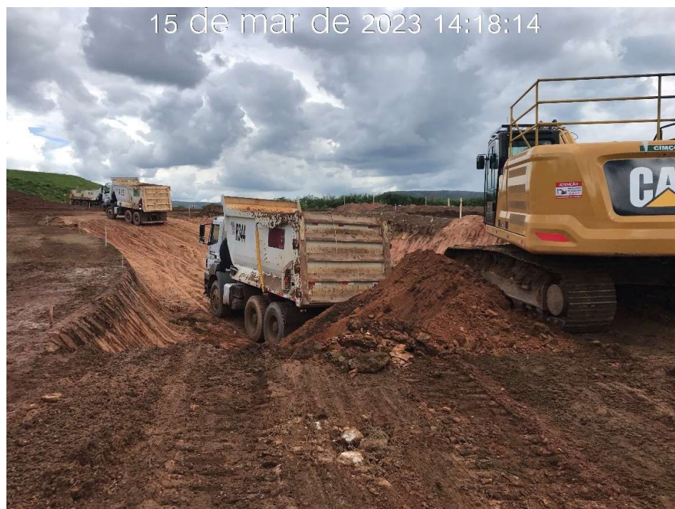
Figura 7.55 – Escavação do canal rápido na estaca 185, com vista para montante (15/03/2023).
