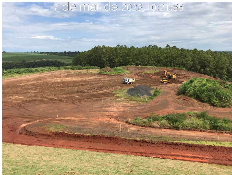
Figura 7.52 – Início das escavações do canal rápido na região da estaca 185 (07/03/2023).
