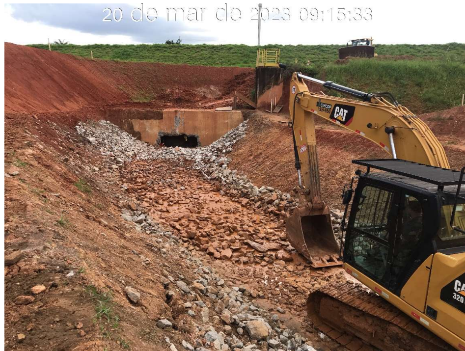
Figura 7.11 – Finalização do canal de aproximação (20/03/2023).
