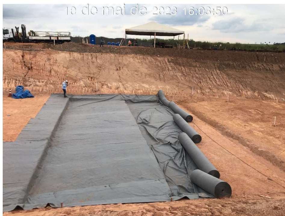
Figura 7.62 – Detalhe da aplicação da manta geotêxtil na estaca 180, no módulo 57 (10/05/2023).
