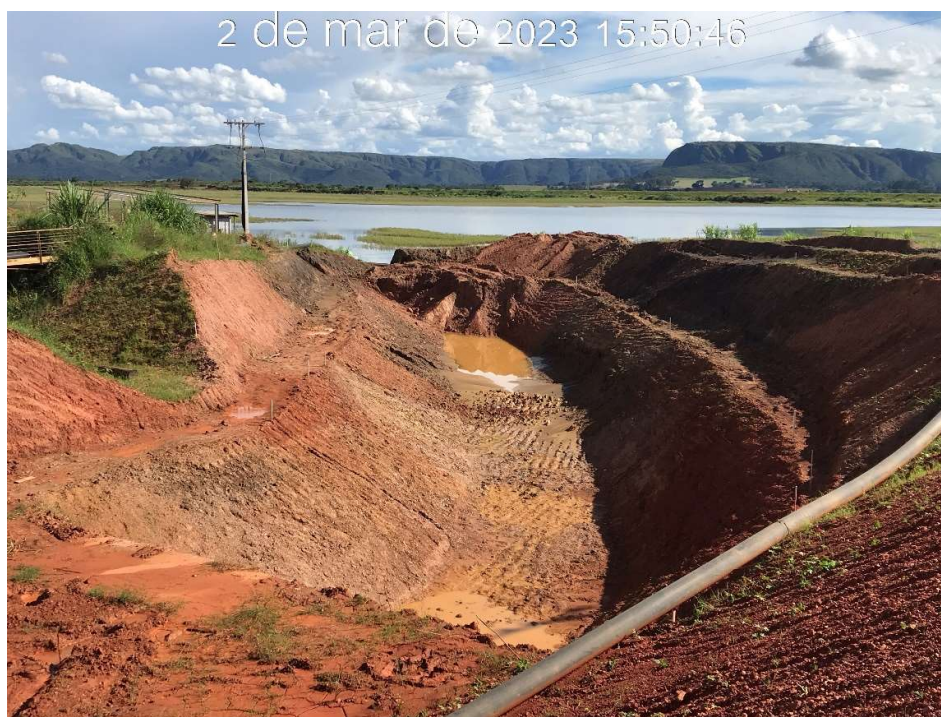
Figura 7.6 – Escavação do canal de aproximação (02/03/2023).
