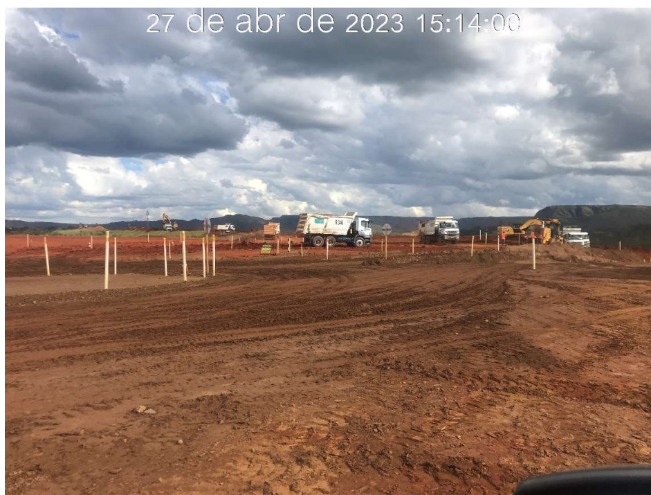
Figura 7.41 – Início das escavações do canal periférico na ombreira esquerda (27/04/2023).
