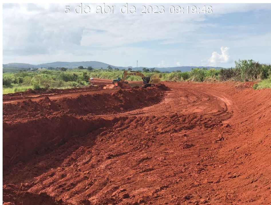
Figura 7.38 – Escavação do canal periférico entre as estacas 104 a 112 (05/04/2023).
