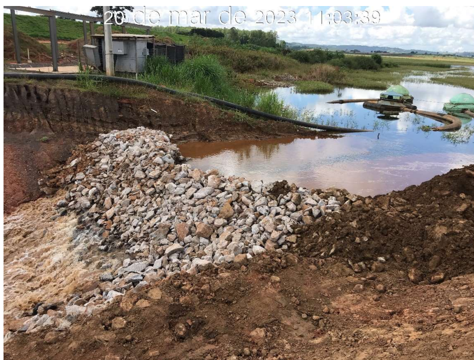
Figura 7.14 – Dique de enrocamento para proteção do reservatório, após liberação do fluxo de água (20/03/2023).
