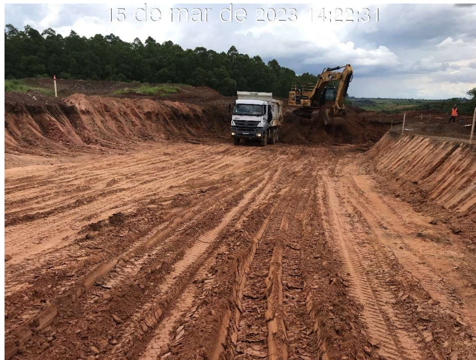
Figura 7.54 – Escavação do canal rápido na estaca 185, com vista para jusante (15/03/2023).
