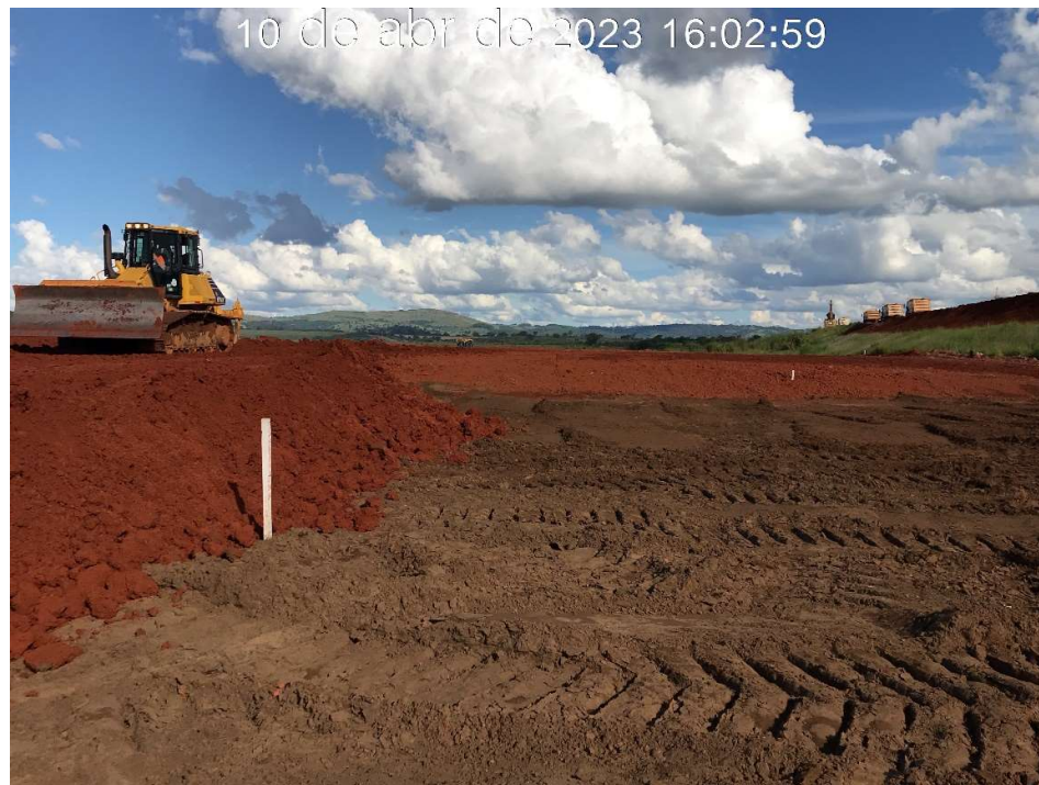
Figura 7.20 – Execução do septo argiloso (10/04/2023).
