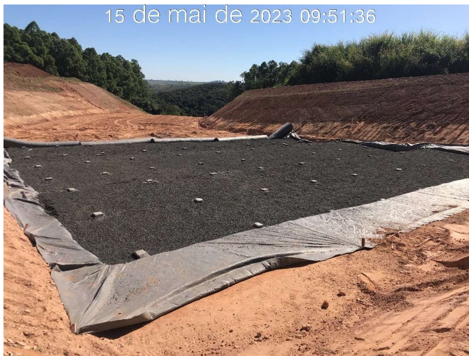
Figura 7.63 – Início da aplicação da brita 0 como camada drenante da base do canal rápido nos módulos 56 e 57 (15/05/2023).
