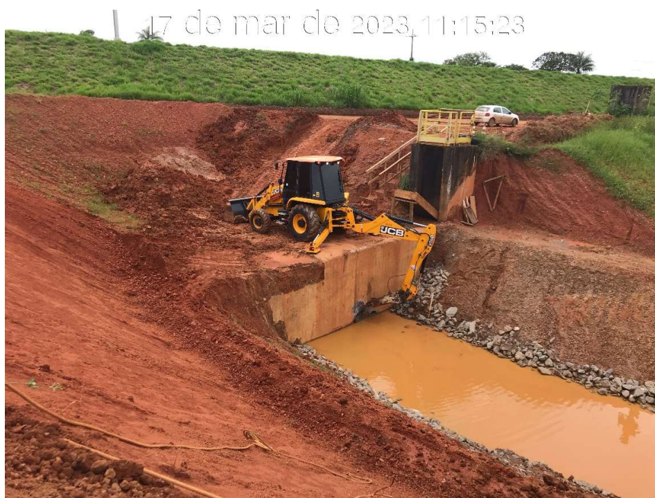
Figura 7.10 – Abertura da galeria existente, para interligação do canal de aproximação (17/03/2023).
