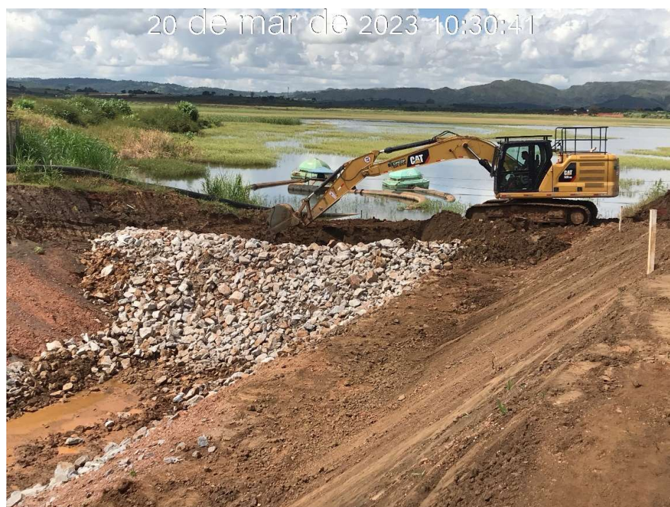
Figura 7.12 – Interligação do reservatório com o canal de aproximação (20/03/2023).
