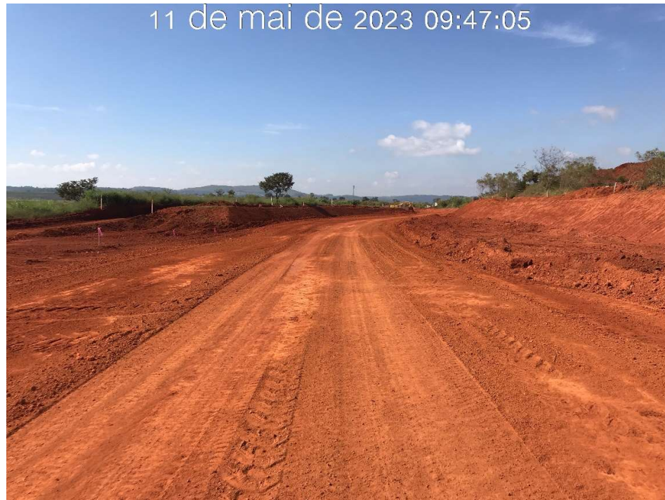
Figura 7.39 – Escavação do canal periférico na região da estaca 120, com vista para jusante (11/05/2023)
