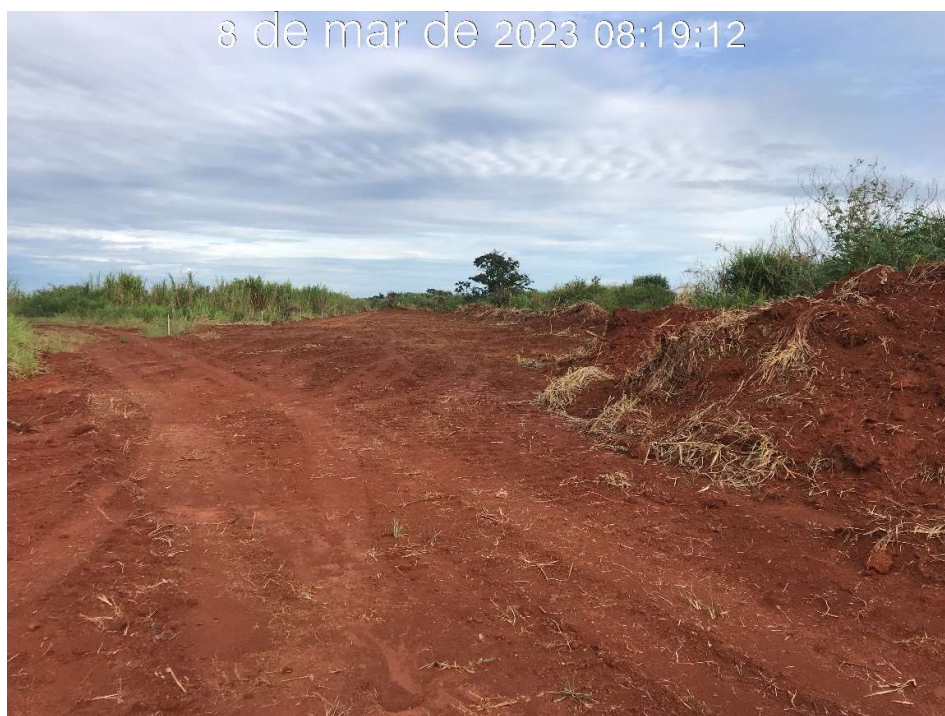
Figura 7.27 – Supressão vegetal no canal periférico na estaca 76, com vista para jusante (08/03/2023).
