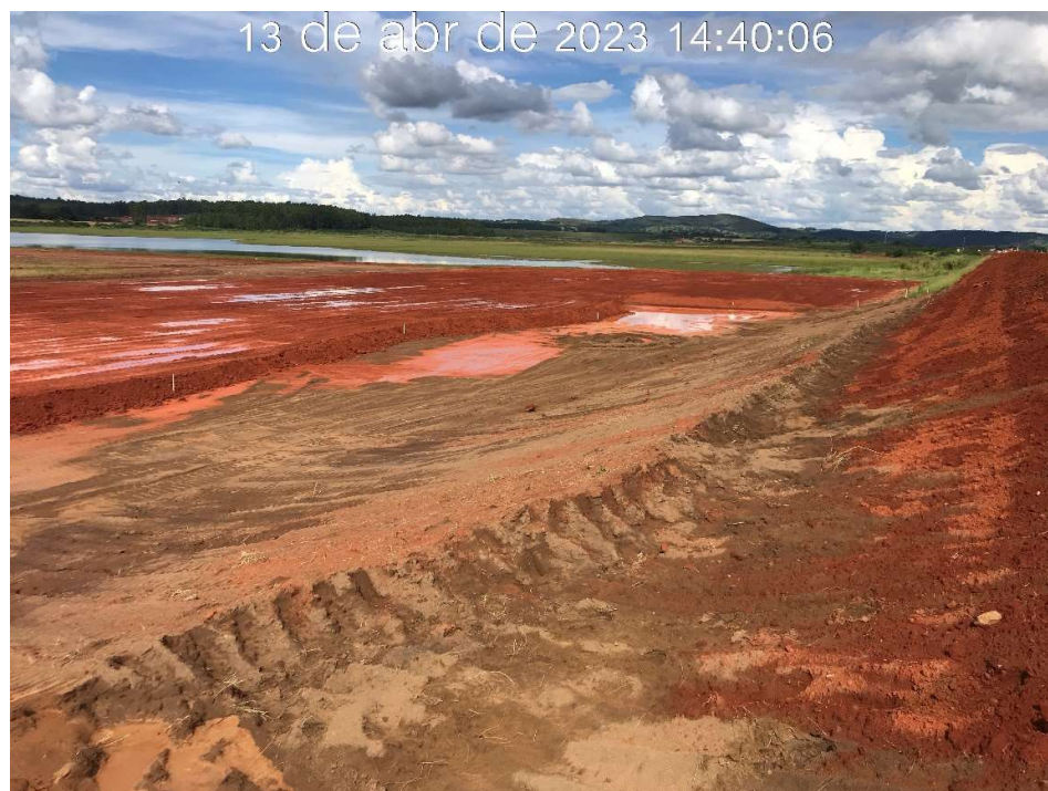
Figura 7.21 – Vista geral do septo argiloso (13/04/2023).
