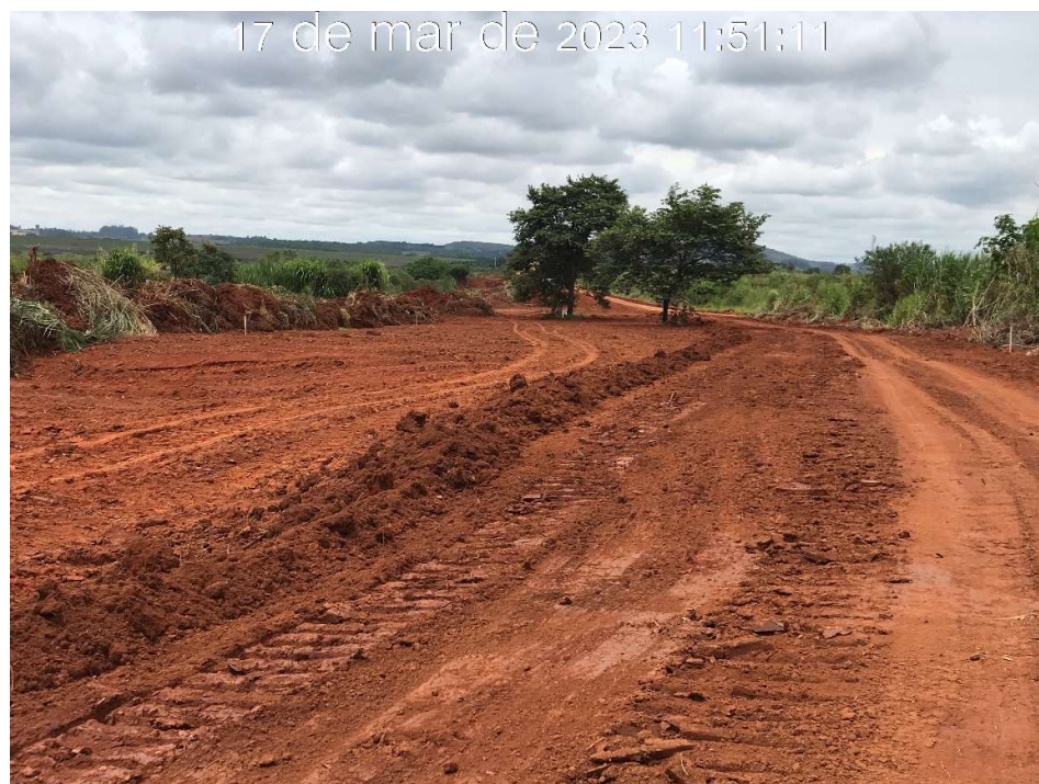
Figura 7.29 – Supressão vegetal na região da estaca 110 (17/03/2023).
