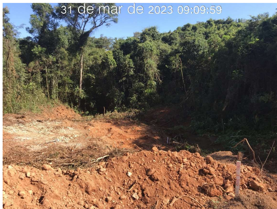
Figura 7.50 – Supressão vegetal da área a ser implantada a bacia de dissipação, estaca 205 (31/03/2023).
