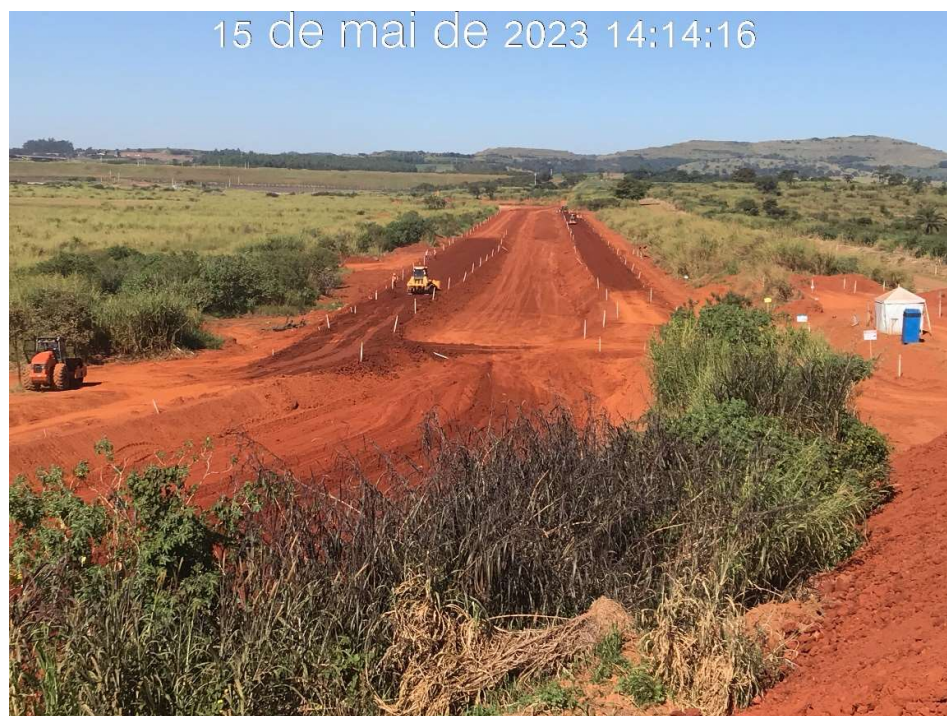
Figura 7.36 – Panorama do canal periférico na região das estacas 74 a 104, com vista para jusante (15/05/2023).
