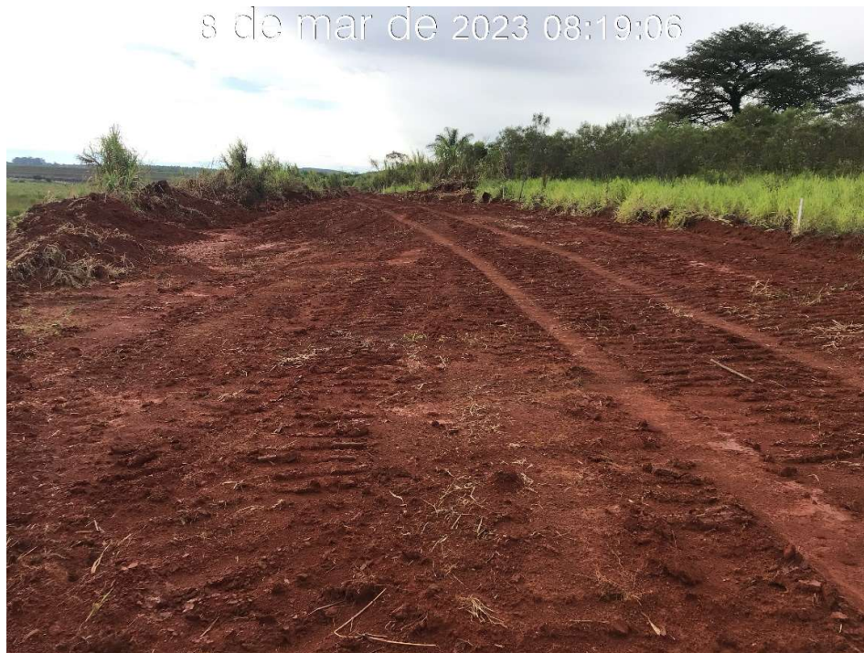
Figura 7.26 – Supressão vegetal no canal periférico na estaca 74, com vista para montante (08/03/2023).
