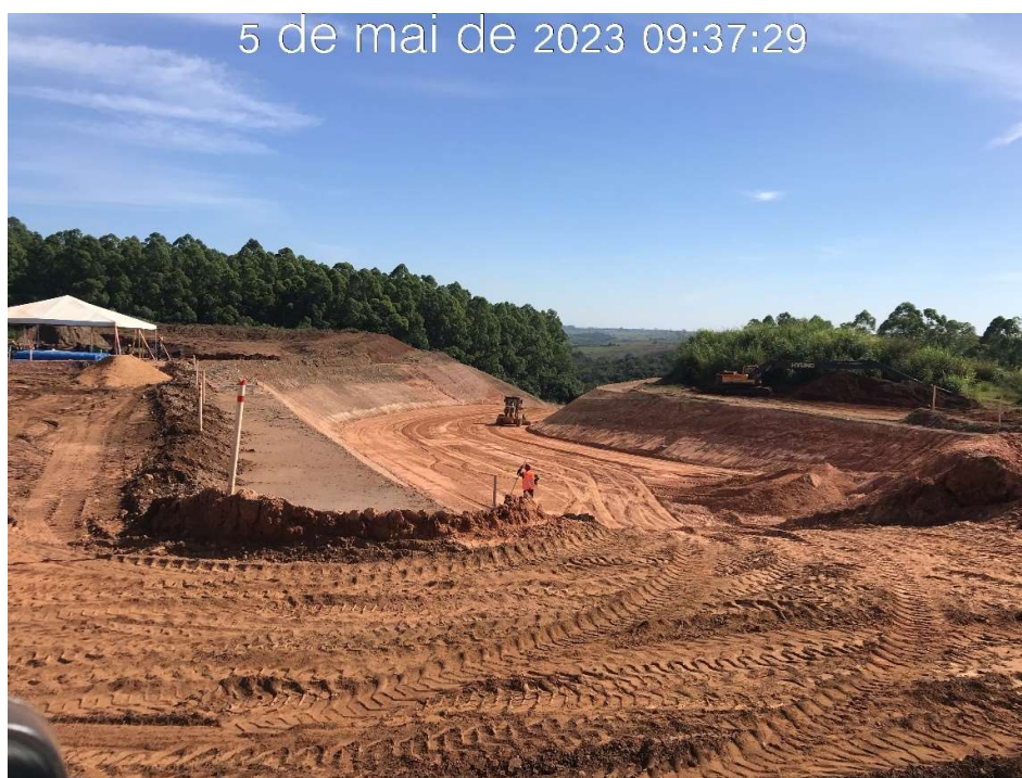
Figura 7.58 – Vista do canal rápido após regularização da fundação (05/05/2023).
