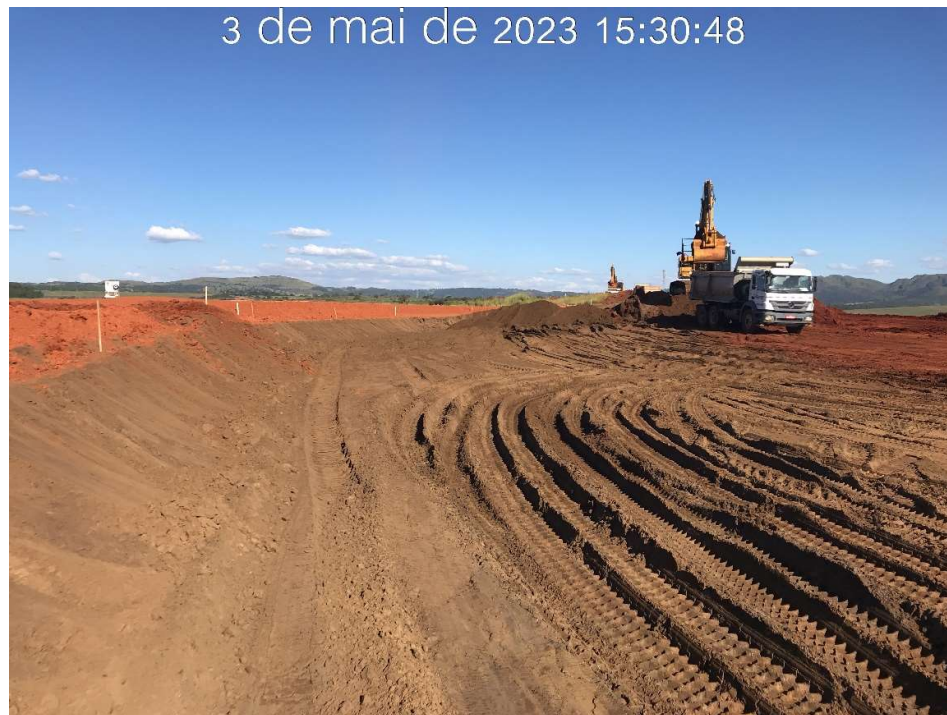
Figura 7.42 – Escavação do canal periférico, com vista para montante (03/05/2023).
