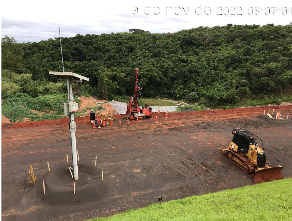
Figura 7.36 – Perfuração do INA01, localizado acima do dreno de fundo da Barragem B5 (03/11/2022).
