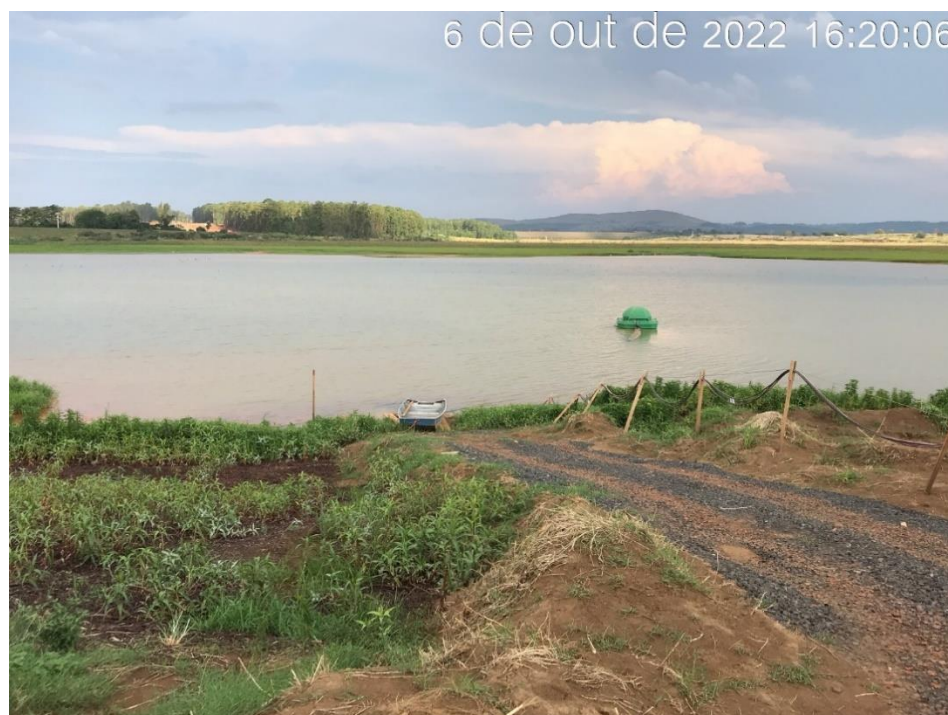
Figura 7.7 - Instalação da bomba de recalque localizada no leito do reservatório (06/10/2022).
