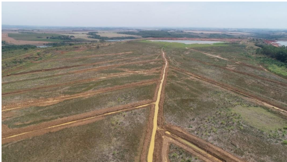
Figura 7.11 - Construção da drenagem espinha de peixe no reservatório da Barragem B5 (03/11/2022).
