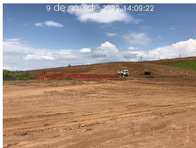
Figura 7.32 - Aplicação do rejeito Underflow no talude da elevação 952,50 m na ombreira esquerda (15/09/2022 e 09/11/2022), respectivamente.
