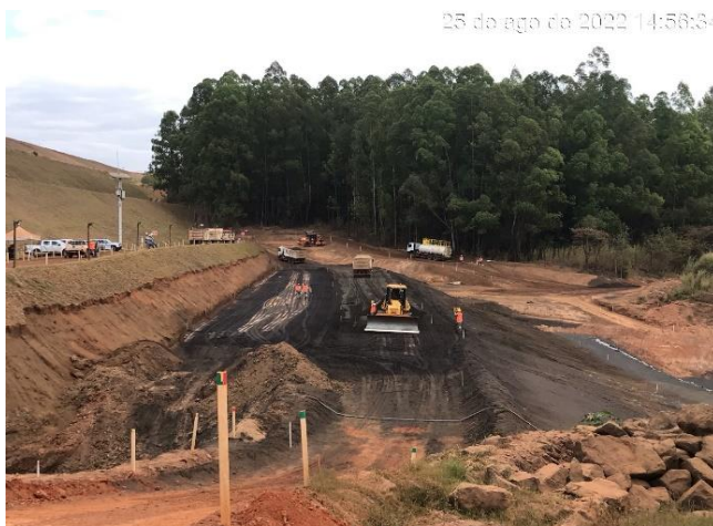
Figura 7.21 - Reforço de pé com ênfase do antes e depois, vista para a ombreira esquerda, 25/08/2022 e 09/11/2022, respectivamente.
