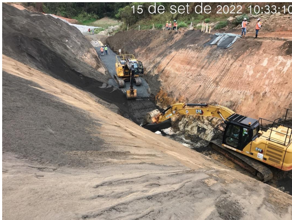
Figura 7.16 - Execução do dreno da ombreira direita do reforço de pé (15/09/2022).
