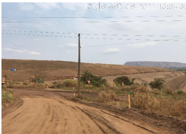
Figura 7.31 - Aplicação do rejeito Underflow no talude da elevação 952,50 m na ombreira direita (15/09/2022 e 08/11/2022), respectivamente.
