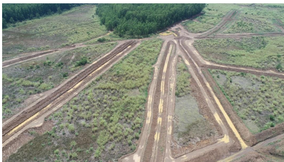
Figura 7.10 - Construção da drenagem espinha de peixe no reservatório da Barragem B5 (03/11/2022).
