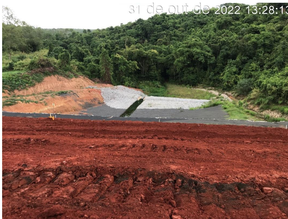
Figura 7.26 - Região do medidor de vazão MV 01 (31/10/2022).
