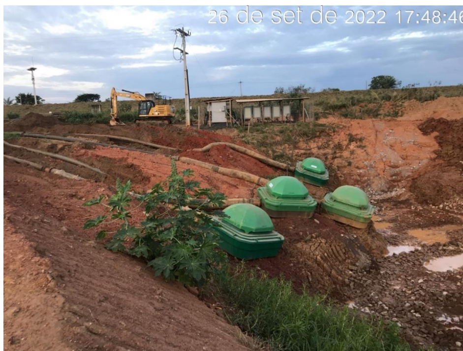
Figura 7.6 - Adequação do calado do Sump de bombeamento (26/09/2022).
