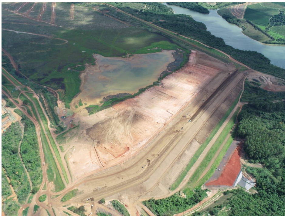
Figura 7.13 - Vista área da Barragem B5 (03/11/2022).
