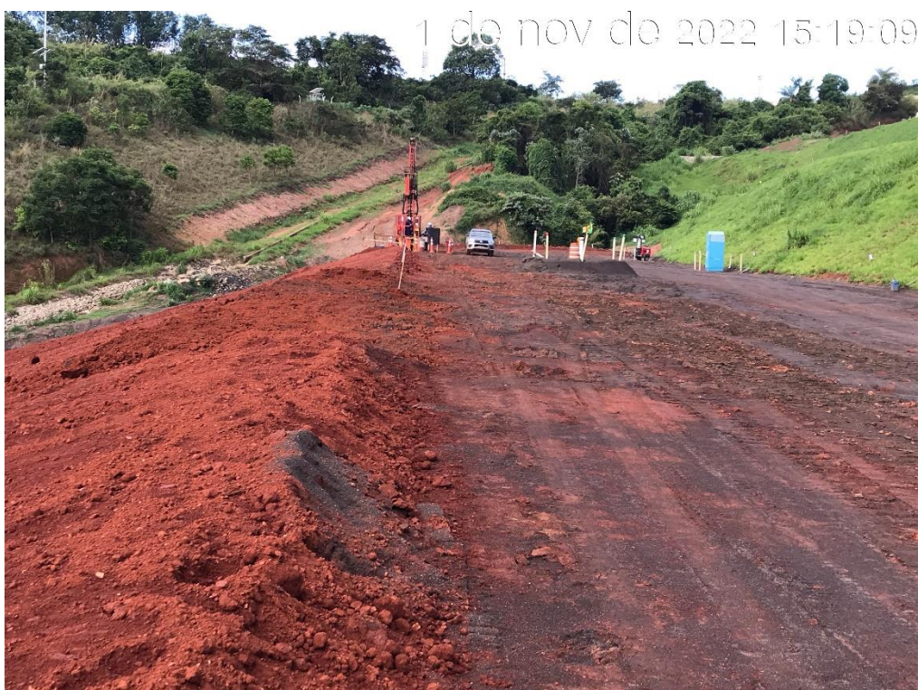
Figura 7.34 – Perfuração do INA02 localizado na ombreira direita do reforço de fundação (01/11/2022).
