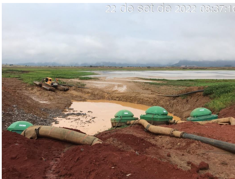
Figura 7.5 - Adequação do calado de bombeamento realizado por escavadeira anfíbia (22/09/2022).
