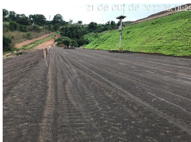
Figura 7.22 - Reforço de pé com ênfase do antes e depois, vista para a ombreira direita, 25/08/2022 e 21/10/2022, respectivamente.
