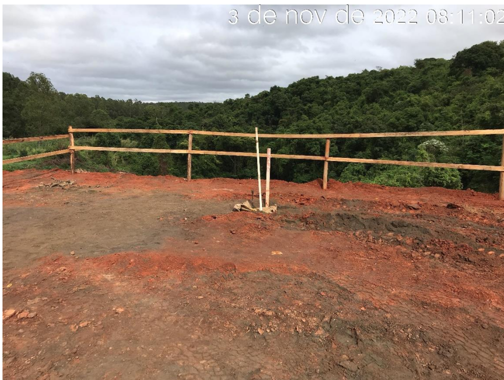
Figura 7.35 – Instalação do INA02, localizado na ombreira direita do reforço de fundação (03/11/2022).
