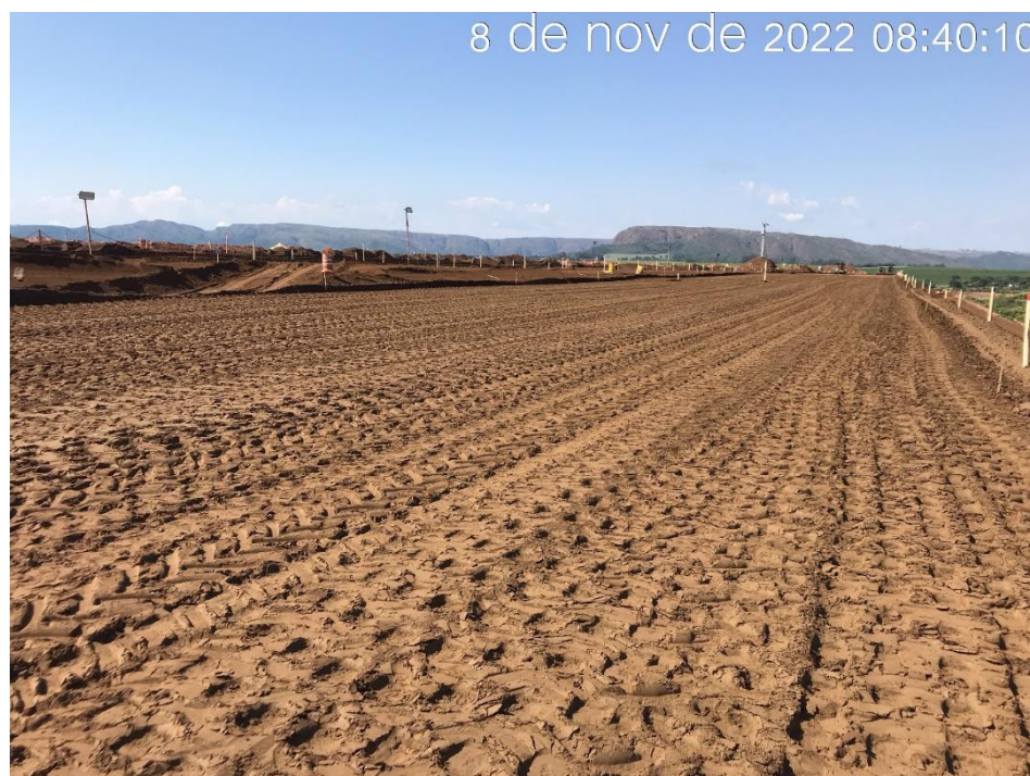
Figura 7.29 - Aplicação do material de rejeito Underflow para regularização do alteamento para linha de centro, elevação 952,50m (08/11/2022).
