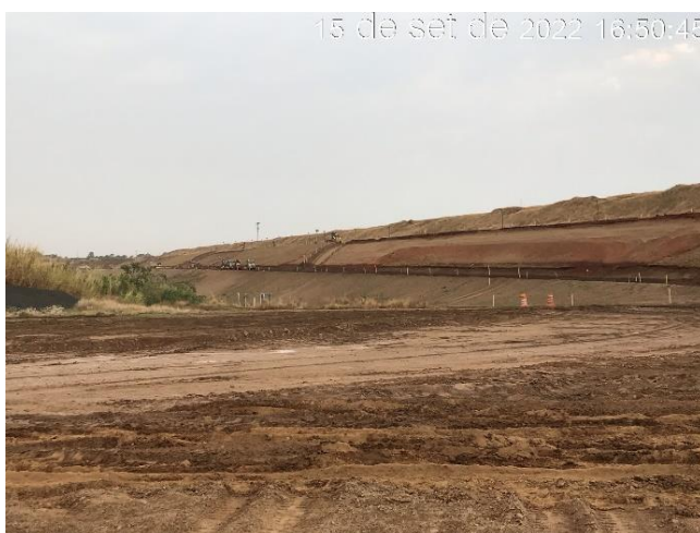
Figura 7.32 - Aplicação do rejeito Underflow no talude da elevação 952,50 m na ombreira esquerda (15/09/2022 e 09/11/2022), respectivamente.
