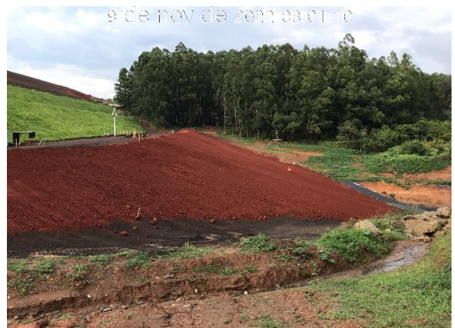
Figura 7.21 - Reforço de pé com ênfase do antes e depois, vista para a ombreira esquerda, 25/08/2022 e 09/11/2022, respectivamente.
