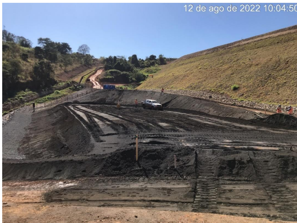
Figura 7.15 - Aplicação do material de rejeito de magnetita no reforço de pé (12/08/2022).
