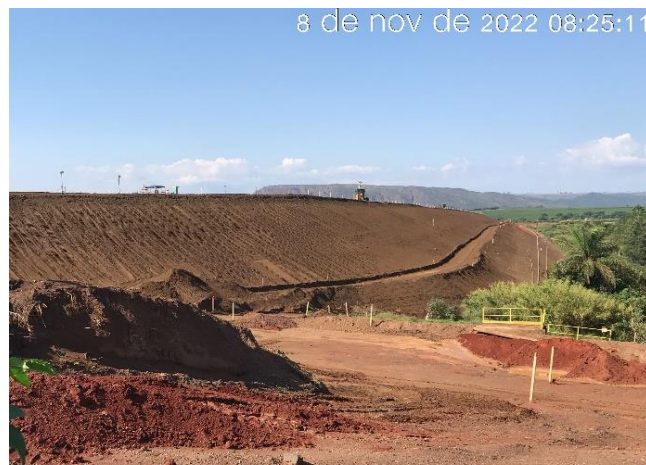
Figura 7.31 - Aplicação do rejeito Underflow no talude da elevação 952,50 m na ombreira direita (15/09/2022 e 08/11/2022), respectivamente.
