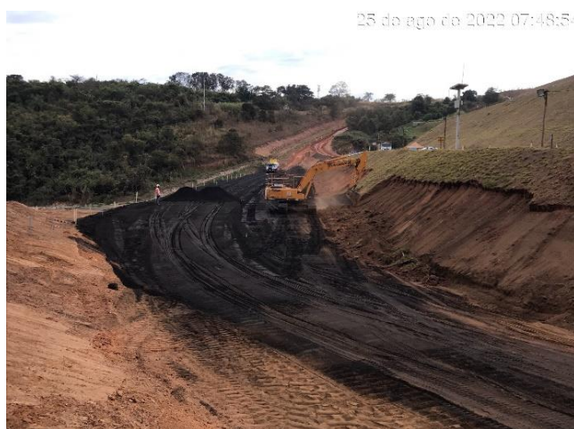
Figura 7.22 - Reforço de pé com ênfase do antes e depois, vista para a ombreira direita, 25/08/2022 e 21/10/2022, respectivamente.
