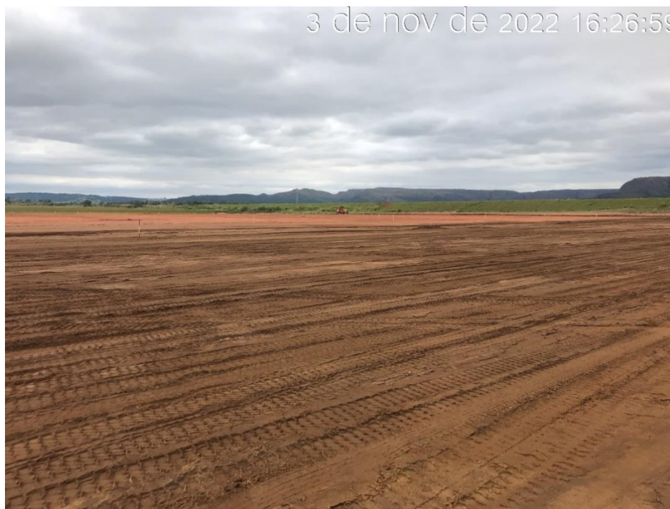
Figura 7.4 - Regularização da praia na elevação 964,50 m (03/11/2022).
