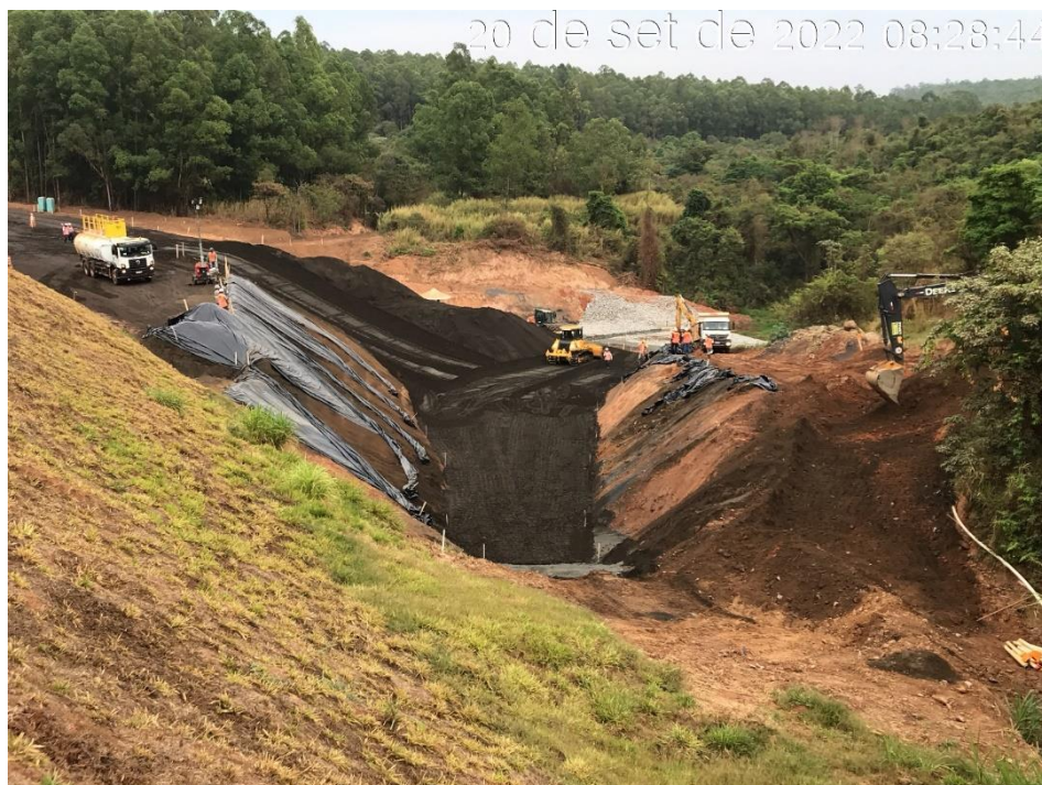
Figura 7.17 - Execução do dreno da ombreira direita do reforço de pé (20/09/2022).
