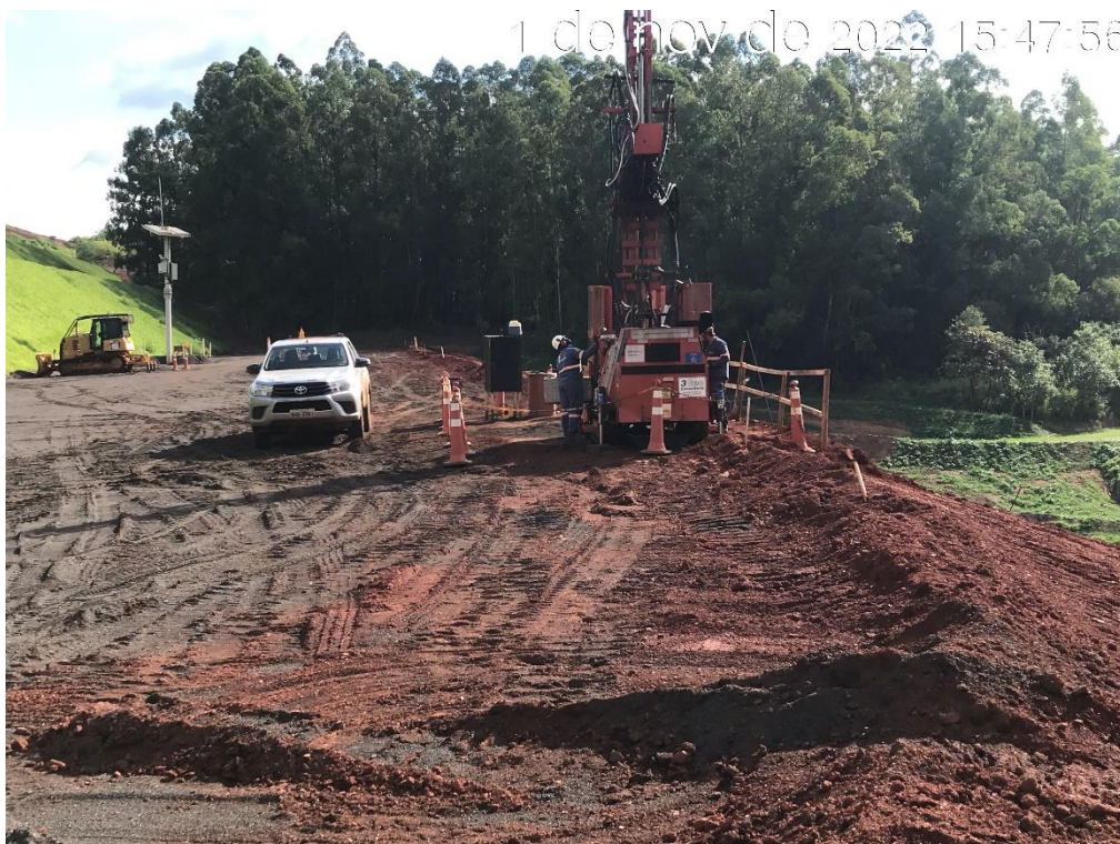
Figura 7.33 – Perfuração do INA02 localizado na ombreira direita do reforço de fundação (01/11/2022).
