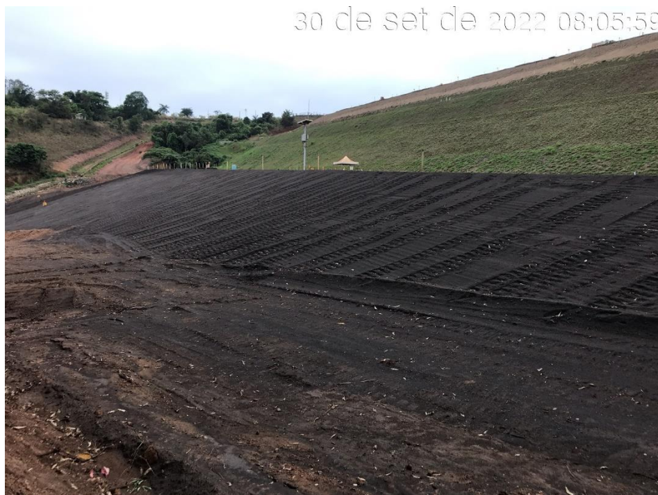
Figura 7.19 - Término da aplicação do material de rejeito de magnetita no reforço de pé, na ombreira esquerda (30/09/2022).
