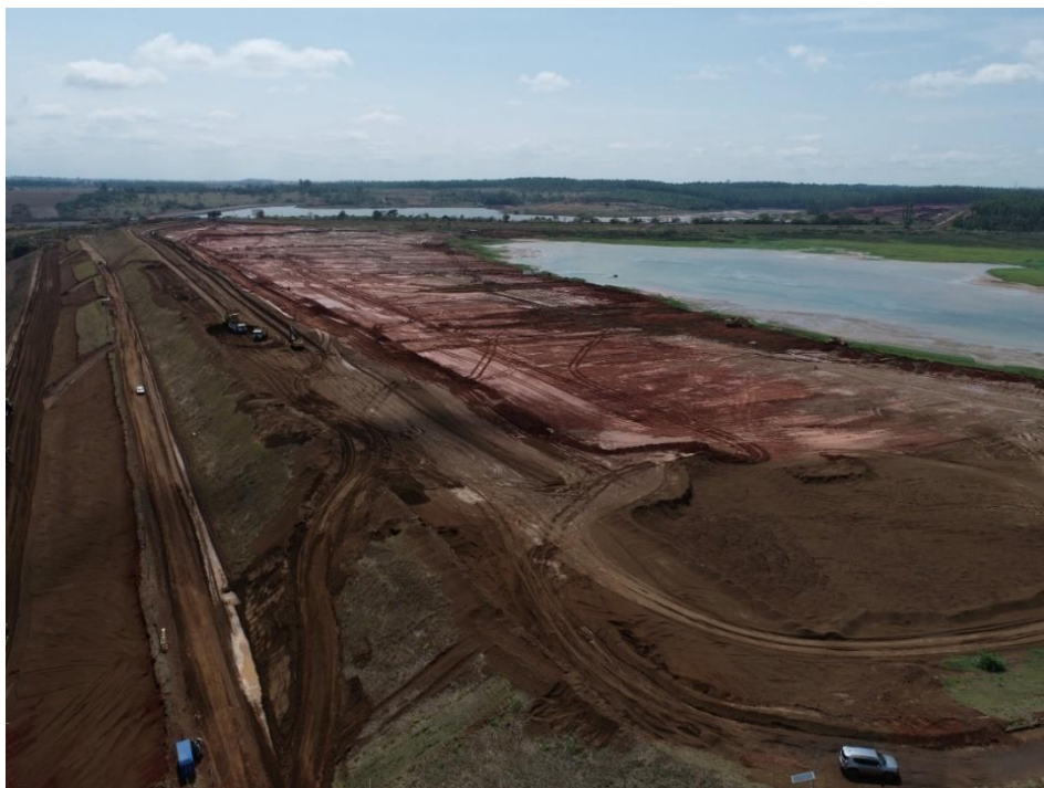
Figura 7.3 – Vista aérea da praia da Barragem B5, com ênfase na regularização da elevação 964,50 m (03/11/2022).
