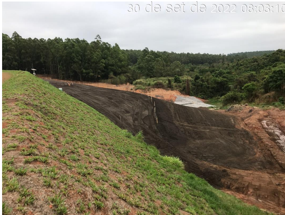
Figura 7.18 - Término da aplicação do material de rejeito de magnetita no reforço de pé, na ombreira direita (30/09/2022).
