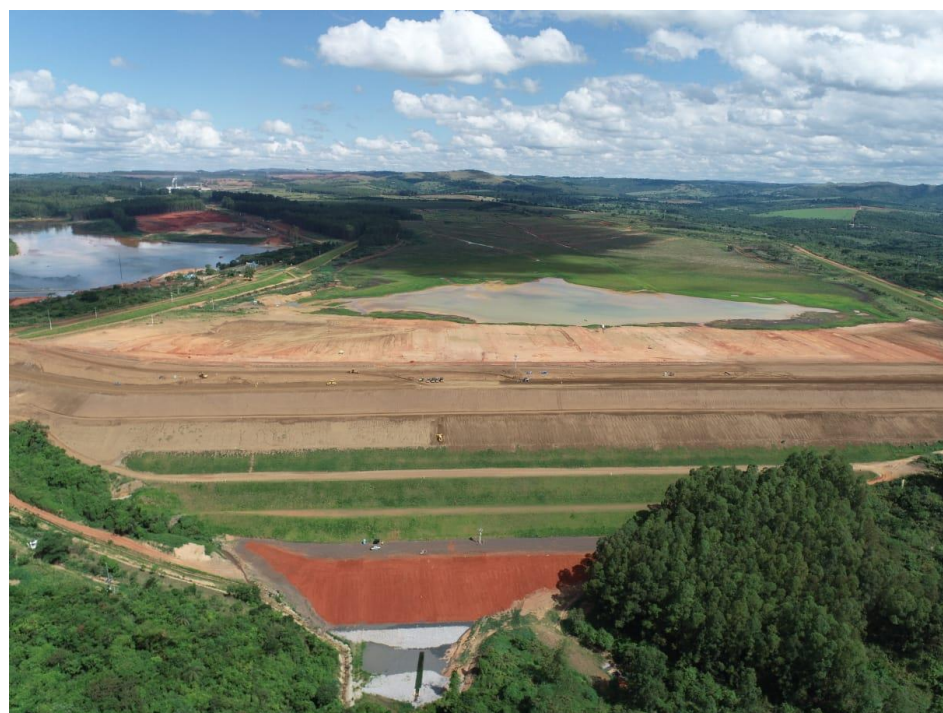
Figura 7.23 - Vista área da Barragem B5 (03/11/2022).
