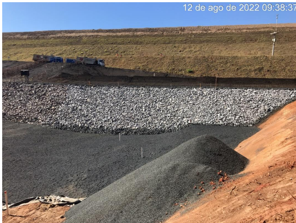
Figura 7.14 - Aplicação do material de rejeito de magnetita no reforço de pé (12/08/2022).
