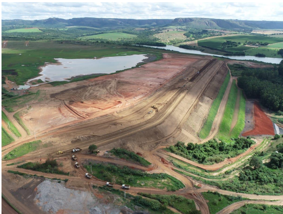
Figura 7.2 - Vista aérea da praia da Barragem B5, com ênfase na regularização da elevação 964,50 m (03/11/2022).
