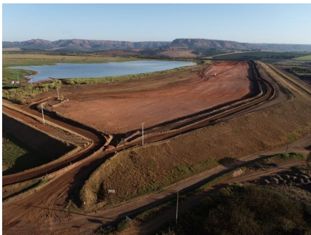
Figura 7.2 - Vista aérea da praia da Barragem B5, situação final após recomposição da escavação com material siltoso, com detalhe da ombreira direita (26/06/2022).
