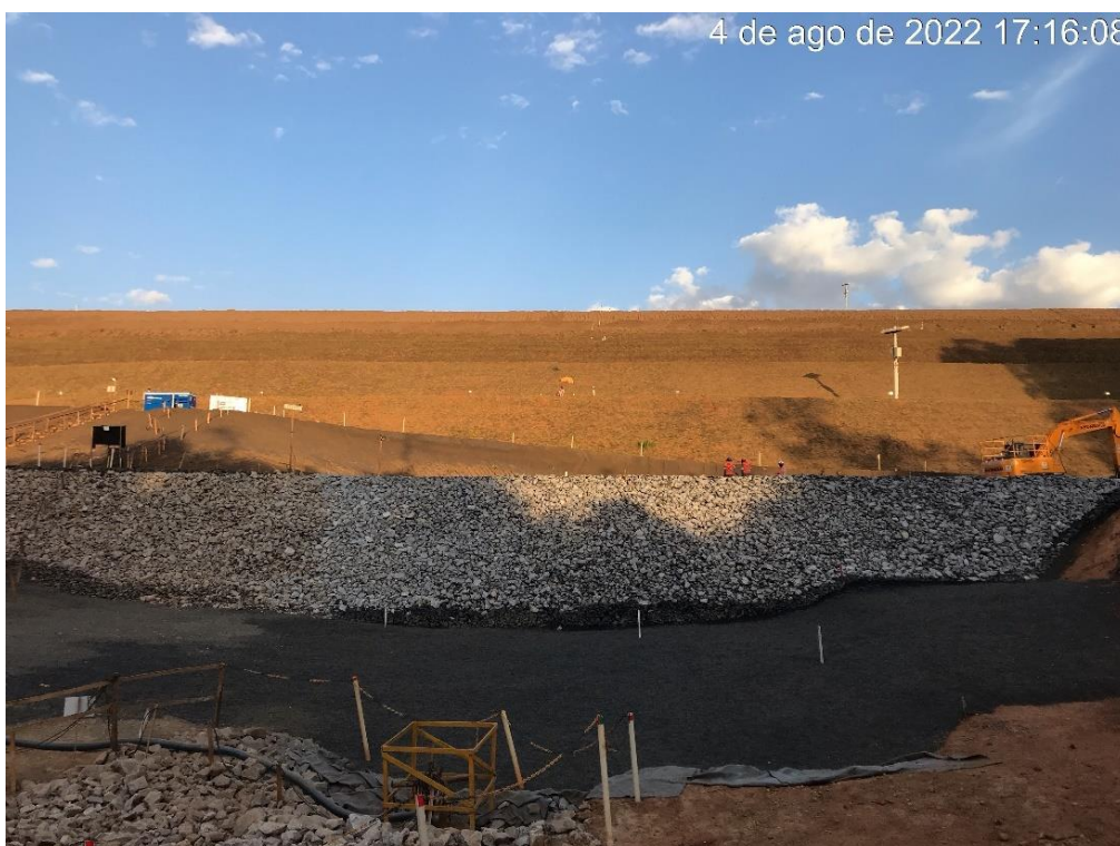
Figura 7.12 - Aplicação do enrocamento do reforço da Barragem B5, até elevação 900,00m (04/08/2022).
