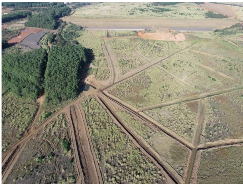
Figura 7.8 - Construção da drenagem espinha de peixe no reservatório da Barragem B5 (28/07/2022).
