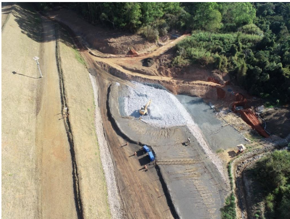
Figura 7.11 - Vista aérea do reforço de fundação da Barragem B5 (28/07/2022).
