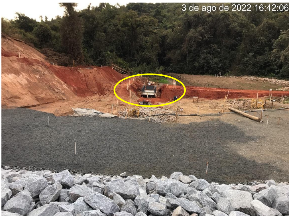
Figura 7.15 - Execução do aterro para conformação e instalação do medidor de vazão MV 01 (03/08/2022).
