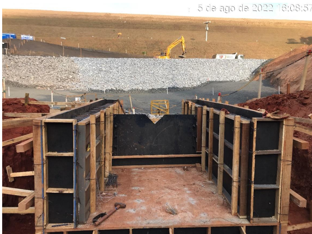
Figura 7.16 - Execução do medidor de vazão MV 01 (05/08/2022).
