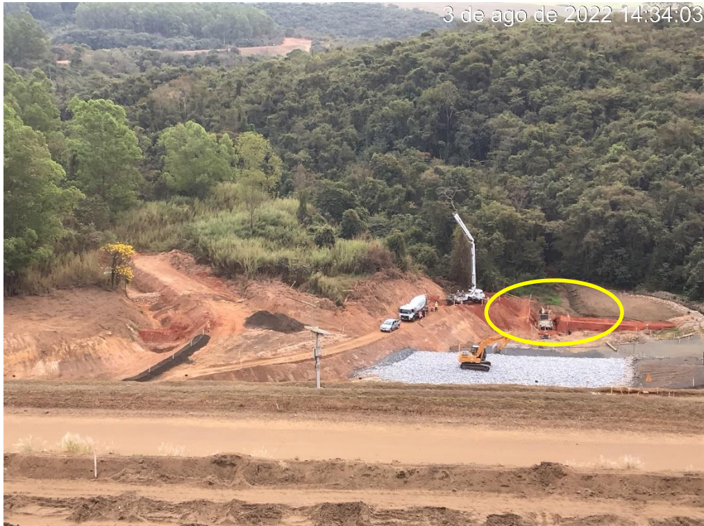
Figura 7.14 - Execução do aterro para conformação do medidor de vazão MV 01 (03/08/2022).
