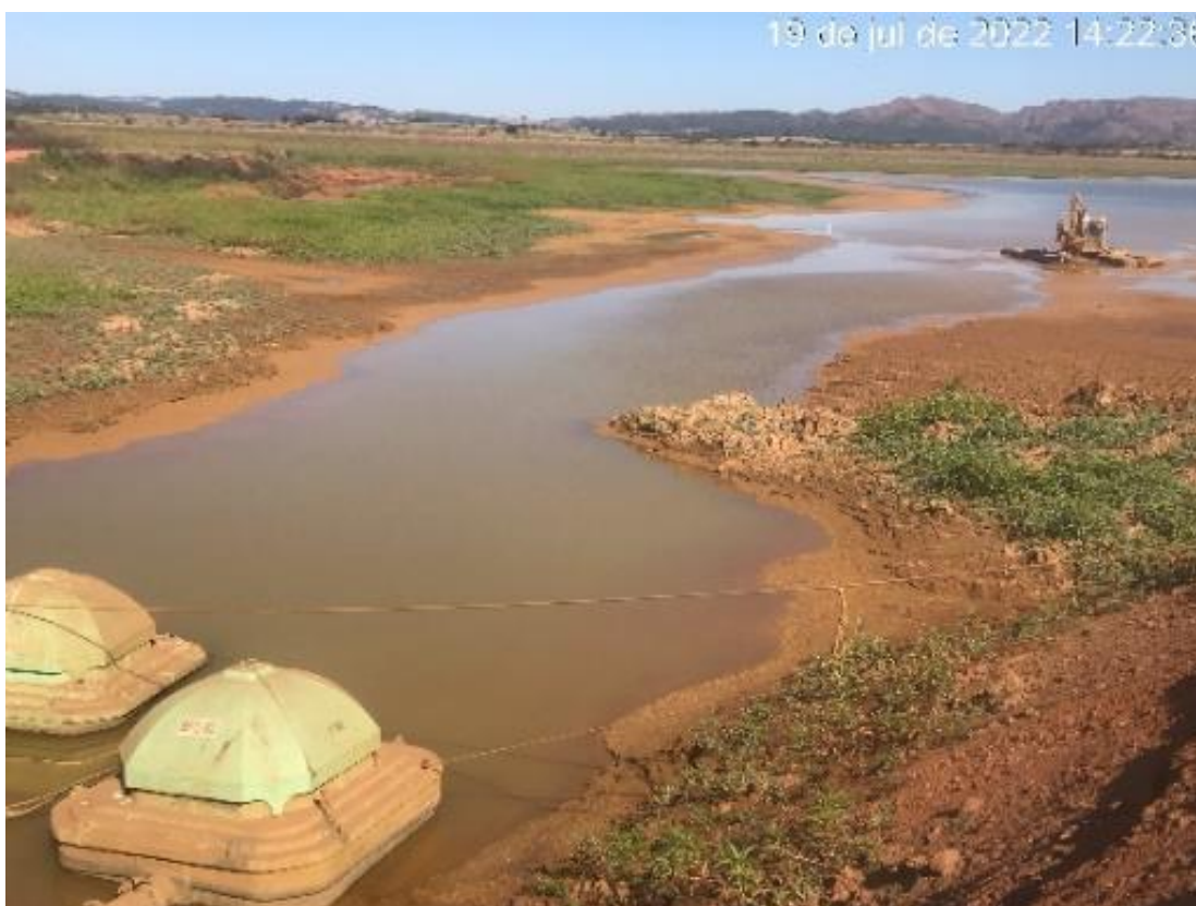
Figura 7.5 - Adequação do calado de bombeamento realizado por escavadeira anfíbia (19/07/2022).
