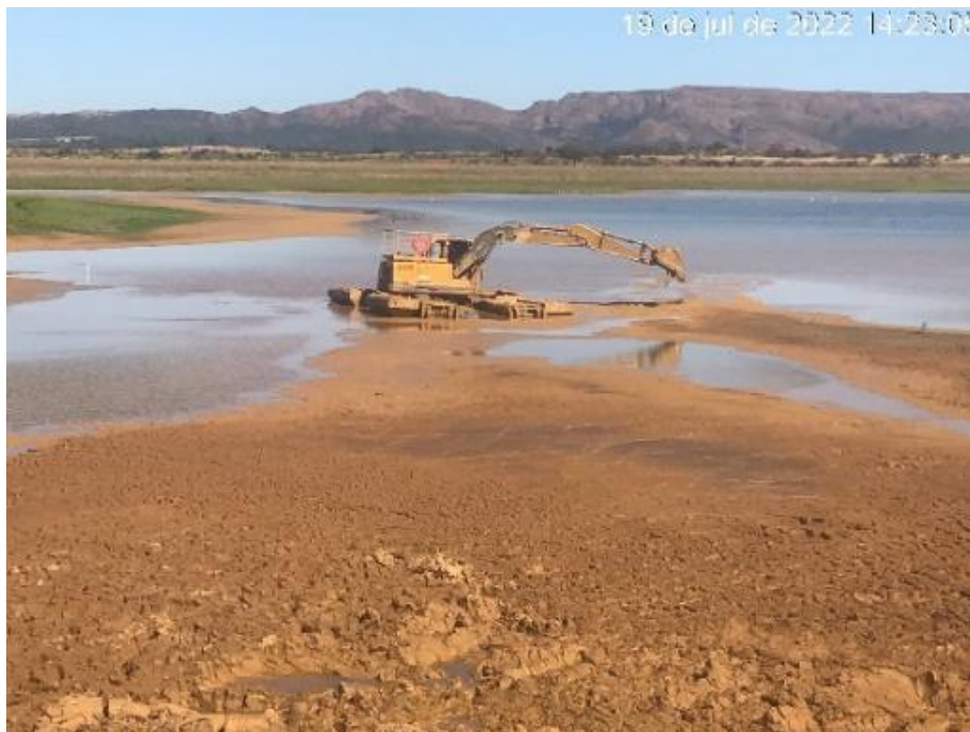
Figura 7.6 - Adequação do calado de bombeamento realizado por escavadeira anfíbia (19/07/2022).
