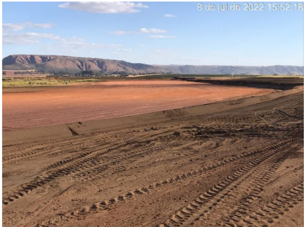
Figura 7.3 – Situação final após escavação de underflow da praia da Barragem B5 e recomposição em material siltoso (08/07/2022).
