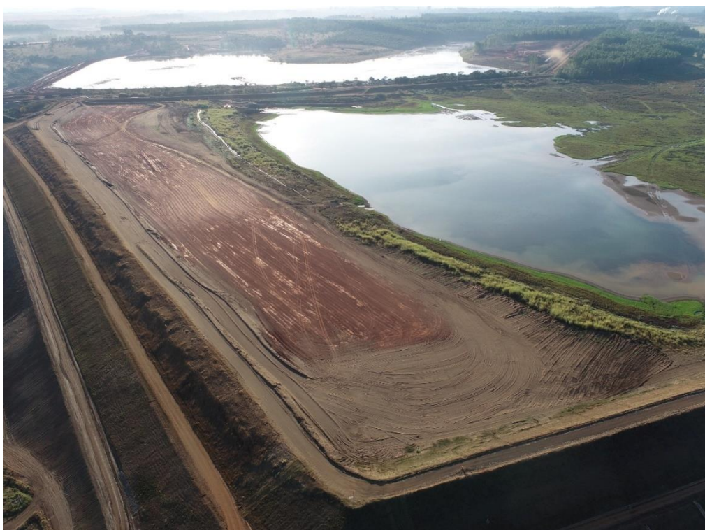
Figura 7.4 - Vista aérea da praia da Barragem B5, situação final após recomposição da escavação com material siltoso, com detalhe da ombreira esquerda (28/07/2022).
