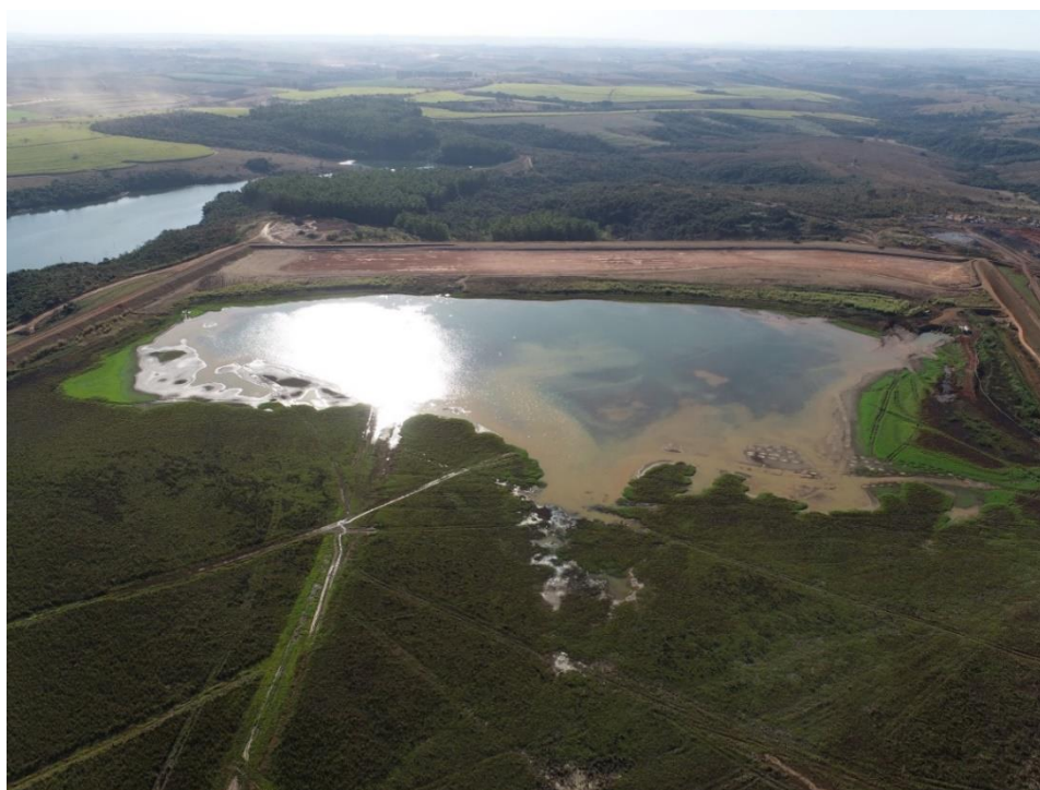
Figura 7.9 - Construção da drenagem espinha de peixe no reservatório da Barragem B5 (28/07/2022).
