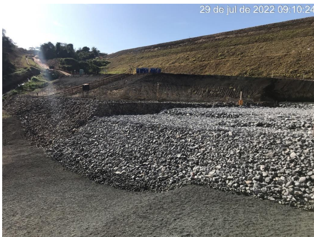
Figura 7.10 - Aplicação do enrocamento do reforço da Barragem B5. (29/07/2022).
