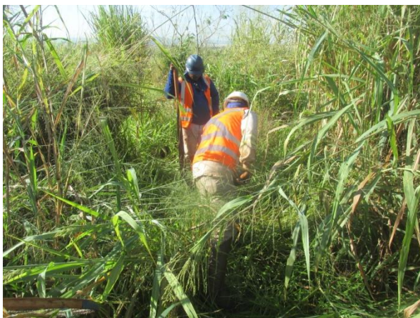
Figura 1: Limpeza da área em que foi aberto o PT-01.
