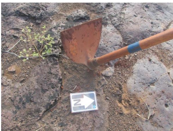
Figura 5: Implantação do PT-131 em lajedo.
