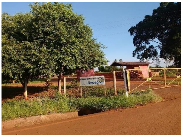
Figura 10: Aterro sanitário na estrada de acesso ao bairro Baixa - Distrito Industrial III.
