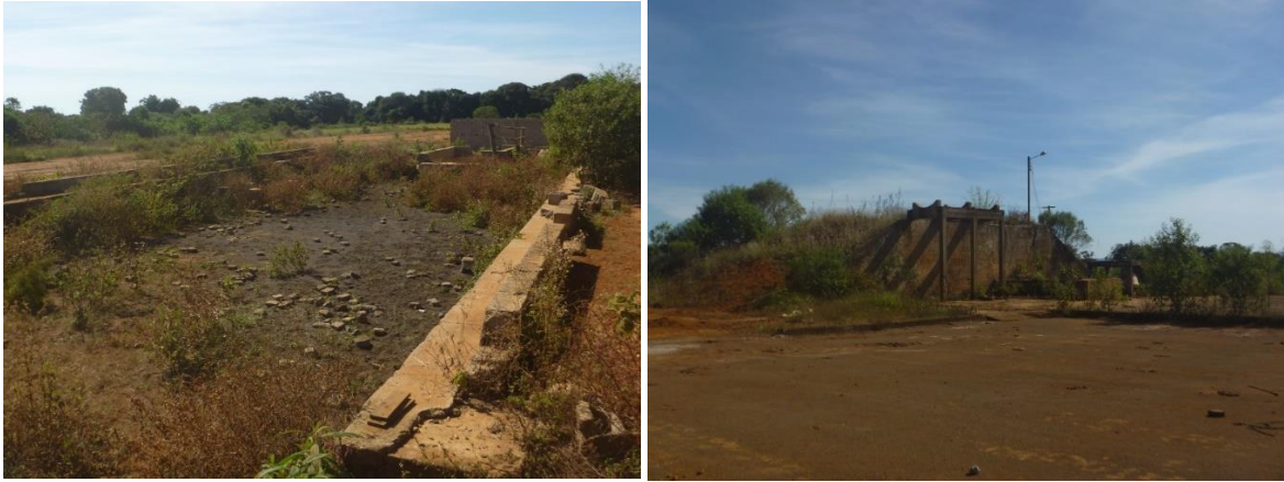
Fig. 88 e Fig. 89. Estrutura edificada abandonada próxima ao PT ALP2_7_27 (Fotos: Jaqueline Belletti).
