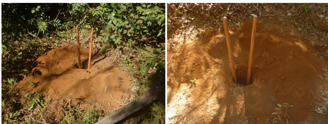
Fig. 26 e Fig. 27. Poços-teste com 1,2m de profundidade finalizados: à esquerda, PT ALP1_16 e à direita ALP1_25 (Fotos: Jaqueline Belletti).
