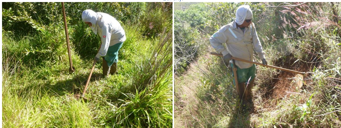
Fig. 134 e Fig. 135. Limpeza inicial da superfície. À esquerda, PT DE10_5_5, e à direita, PT DE10_6_7 (Fotos: José Moacyr Zem).
