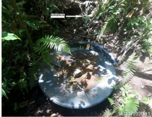
Foto 6.47: Captação por gravidade na surgência (CMT-NA-63).
