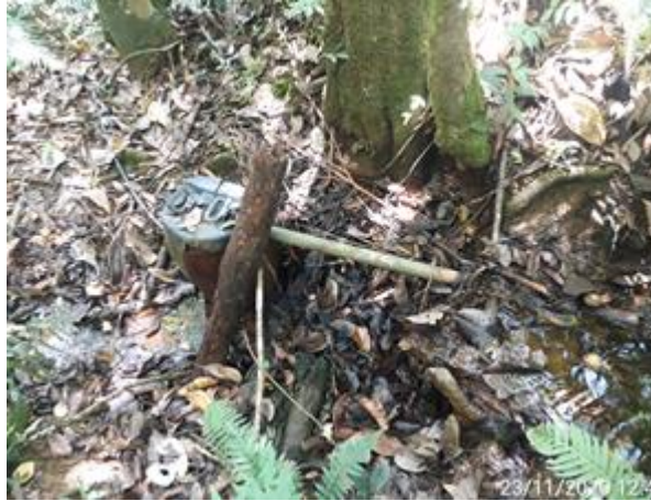
Foto 6.31: Captação por gravidade à jusante da surgência CMT-NA-34.
