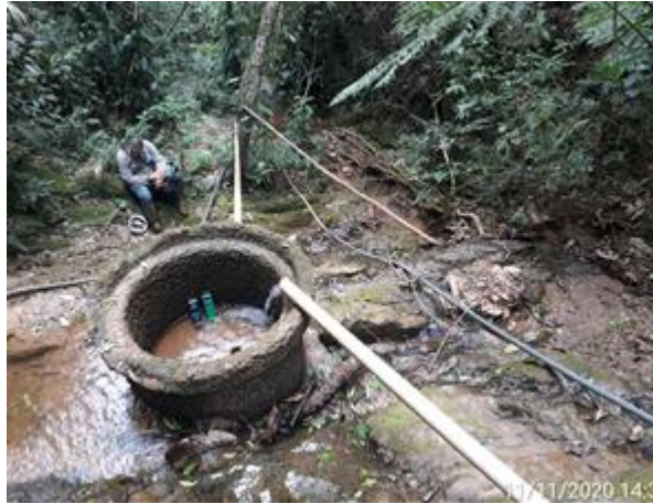
Foto 7.17: Captação em drenagem fio d'água por queda natural (CMT-US-14).
