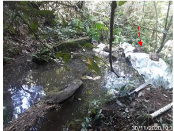
Foto 6.8: Estrutura para represar água (CMT-NA-49).
