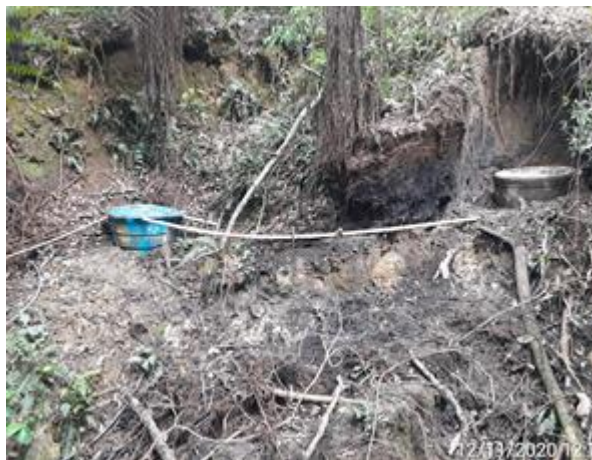
Foto 7.13: Surgência com concreto para proteção (CMT-US-20).
