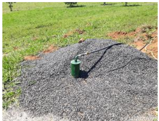
Foto 7.8: Poço tubular profundo – 45 metros (CMT-US-04).
