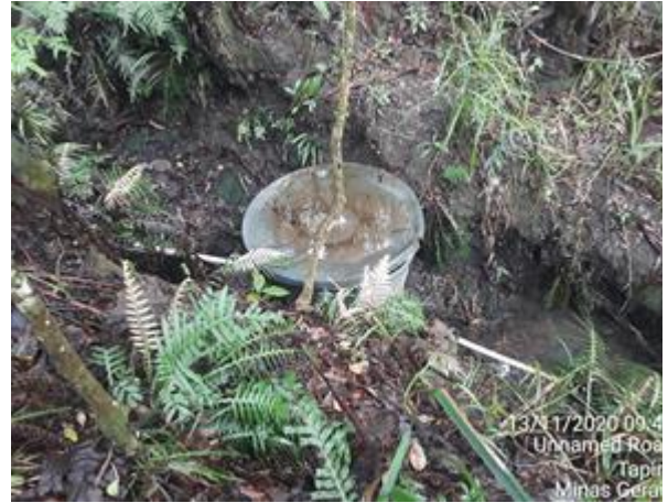
Foto 7.18: Captação em drenagem fio d'água por queda natural (CMT-US-18).
