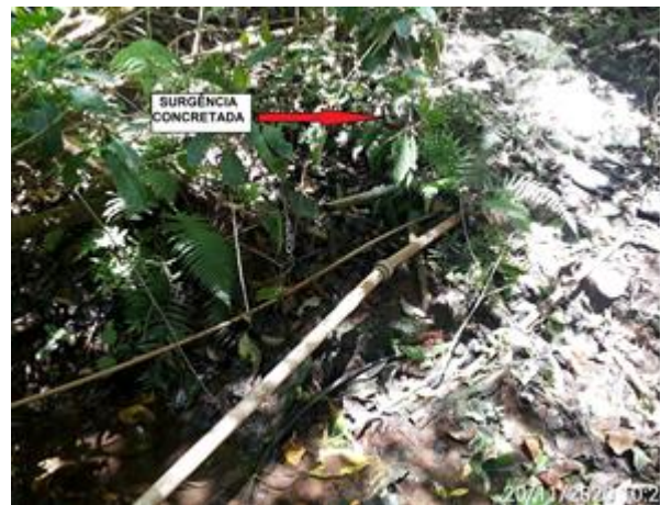
Foto 7.14: Captação por queda natural (CMT-US-24).
