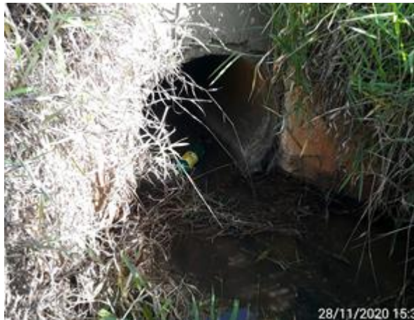
Foto 6.17: Estrutura de concreto de água proveniente da mina (CMT-PC-19).
