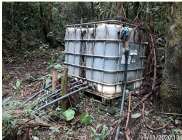
Foto 6.37: Ponto de captação de água para comunidade do Assentamento (CMT-PC-20).
