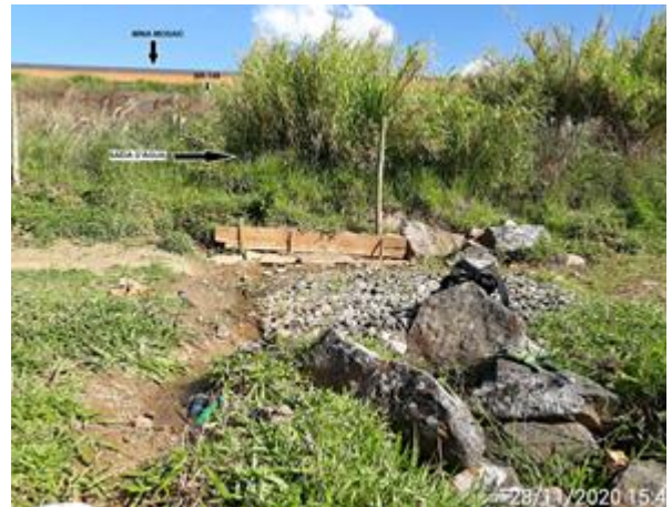
Foto 6.18: Visão para montante do ponto (CMT-PC-19).
