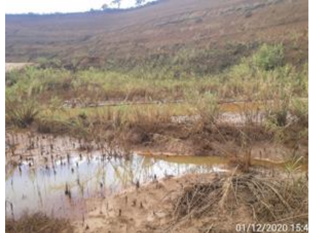
Foto 6.88: Surgência em solo silto argiloso (CMT-NA-69).
