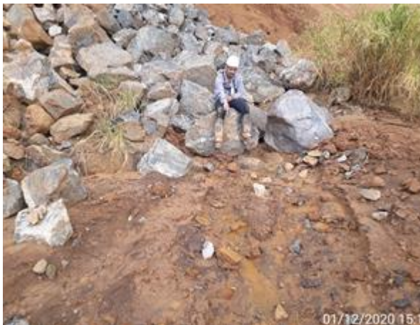
Foto 6.89: Matacões de rocha para conter fluxo superficial (CMT-NA-69).
