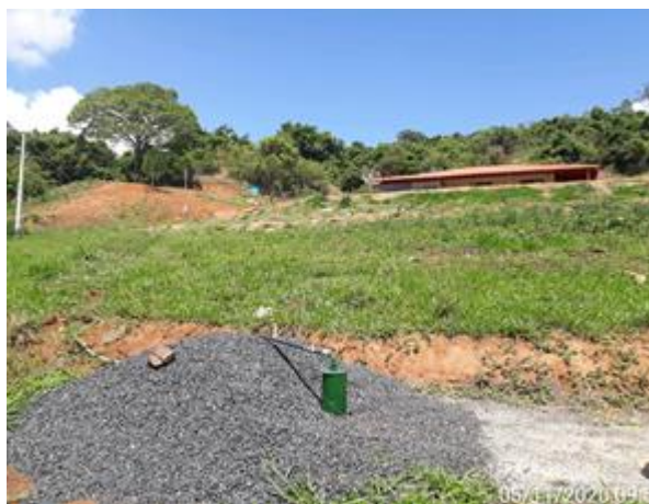
Foto 7.7: Poço tubular profundo – 45 metros (CMT-US-04).
