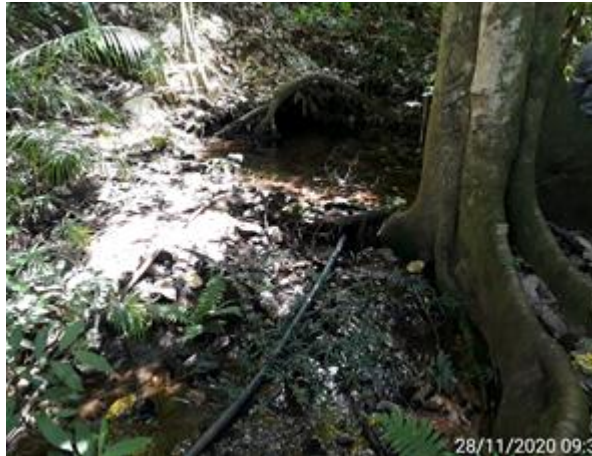
Foto 6.7: Captação por adutora de 1” (CMT-NA-29).
