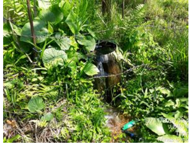
Foto 6.48: Captação por bombeamento à jusante da surgência (NA-09).
