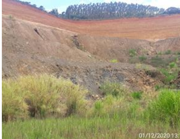
Foto 6.95: Escoamento de água pela face do talude (CMT-PC-23).
