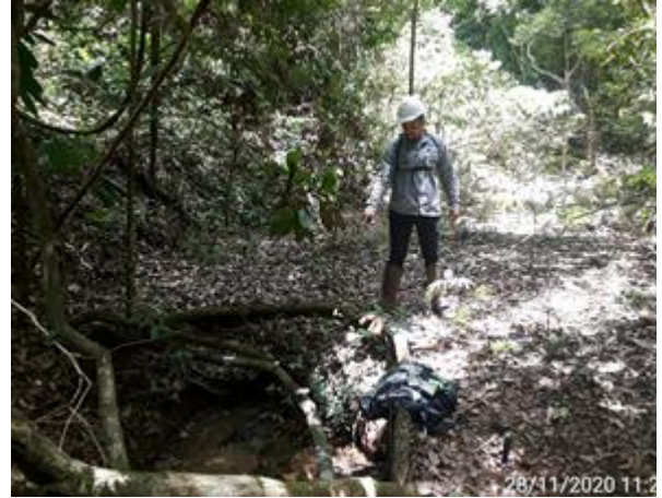
Foto 6.12: Surgência a jusante do ponto de reposição (CMT-NA-28/CMT-NA-67).
