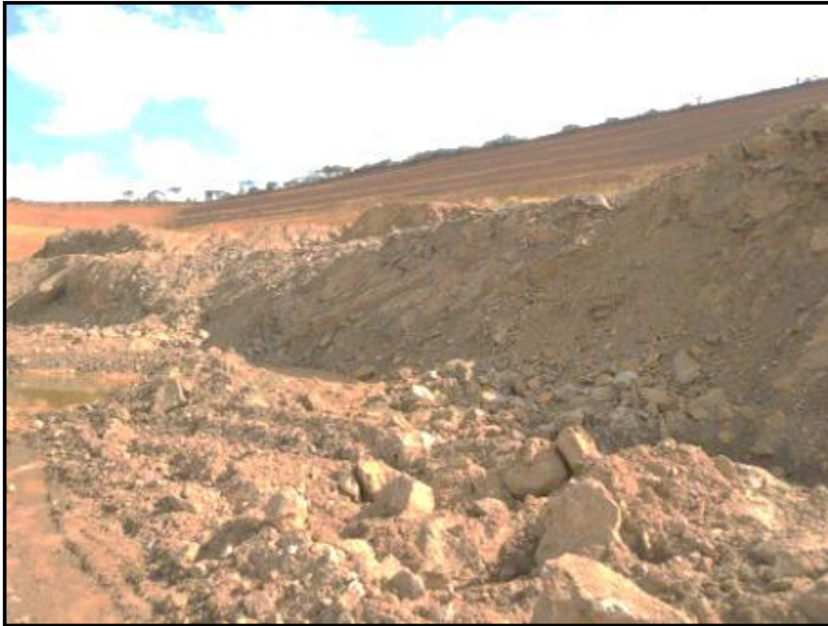
FOTO 5.2 – Vista do fundo da cava onde é possível observar o corpo rochoso bem fraturado. Nesta área não foi observado nenhum tipo de dissolução na rocha. Juntamente com carbonatito, ocorrem outras rochas e minerais, com destaque para magnetita. Observar ao fundo talude da cava com mais de 60 metros de manto de intemperismo sobre o pacote de rochas intemperizadas.
