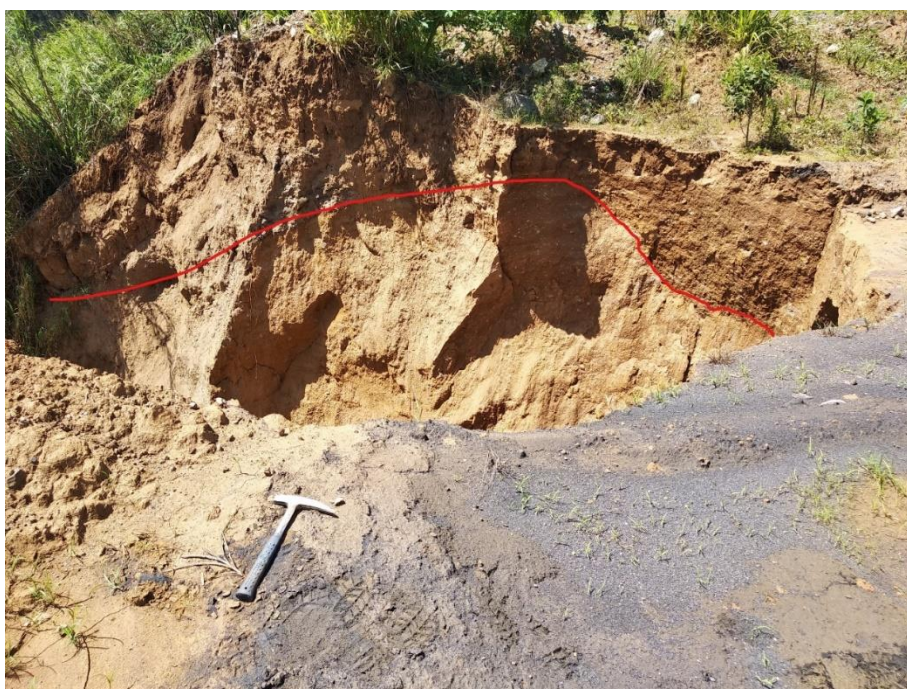
Figura 8.9 - Erosão em talude exibindo o contato entre colúvio e solo residual. O contato está destacado com o traçado em vermelho.
