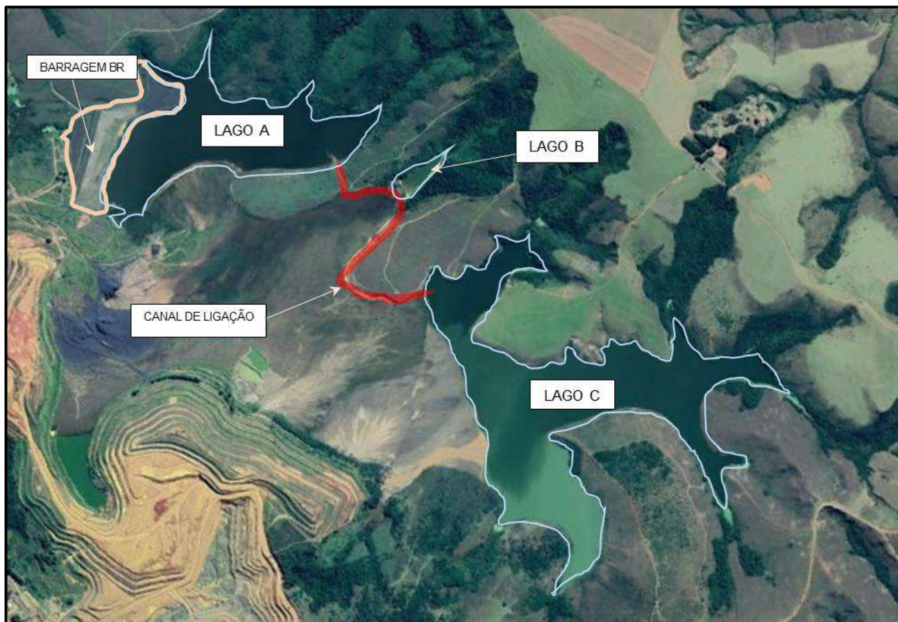
Figura 3-7 – Lagos pertencentes a estrutura da barragem BR (Fonte: Google Maps - Modificado).
