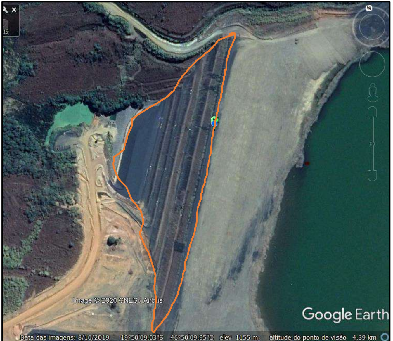
Figura 3-6 – Barragem BR, estrutura pertencente ao CMT (Fonte: Google Maps, 2019).
