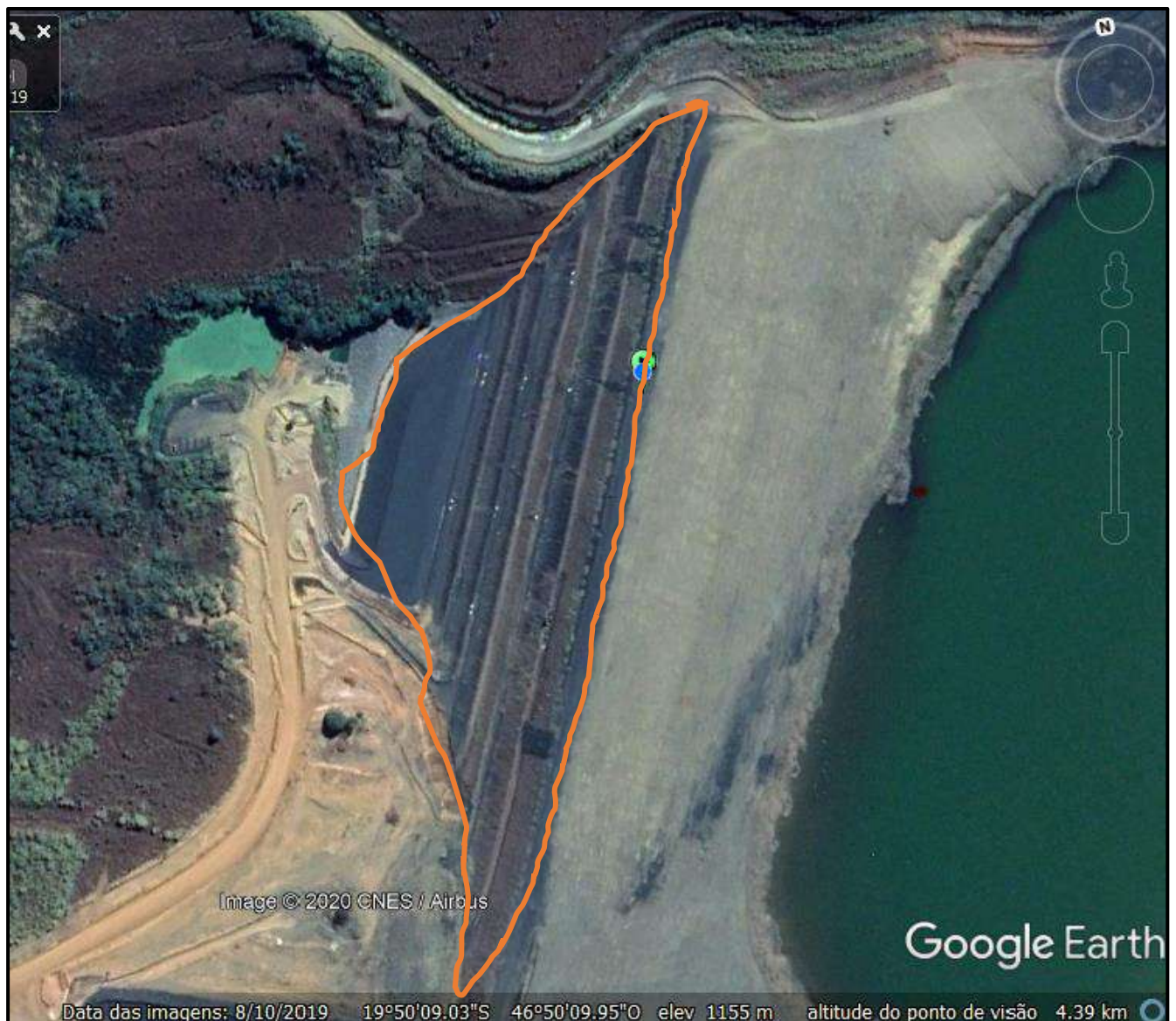
Figura 4.6 – Barragem BR, estrutura pertencente ao CMT (Fonte: Google Maps, 2019).
